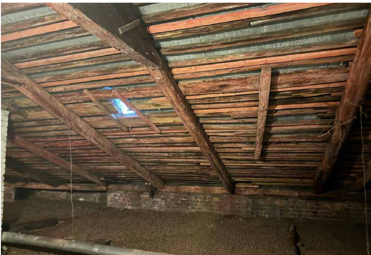
Фото 21. Интерьер чердачного помещения объекта культурного наследия.
