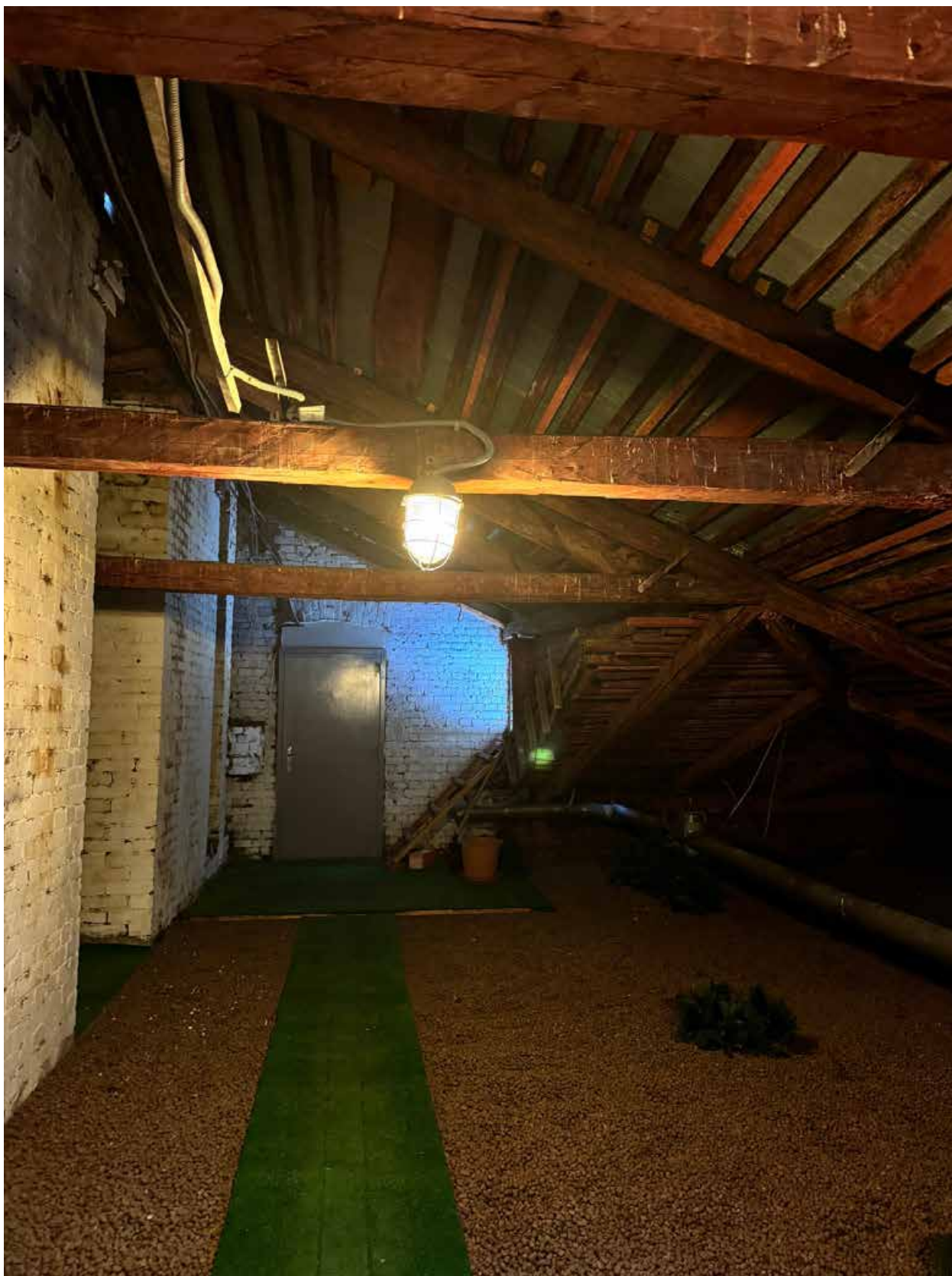
Фото 26. Интерьер чердачного помещения объекта культурного наследия.
