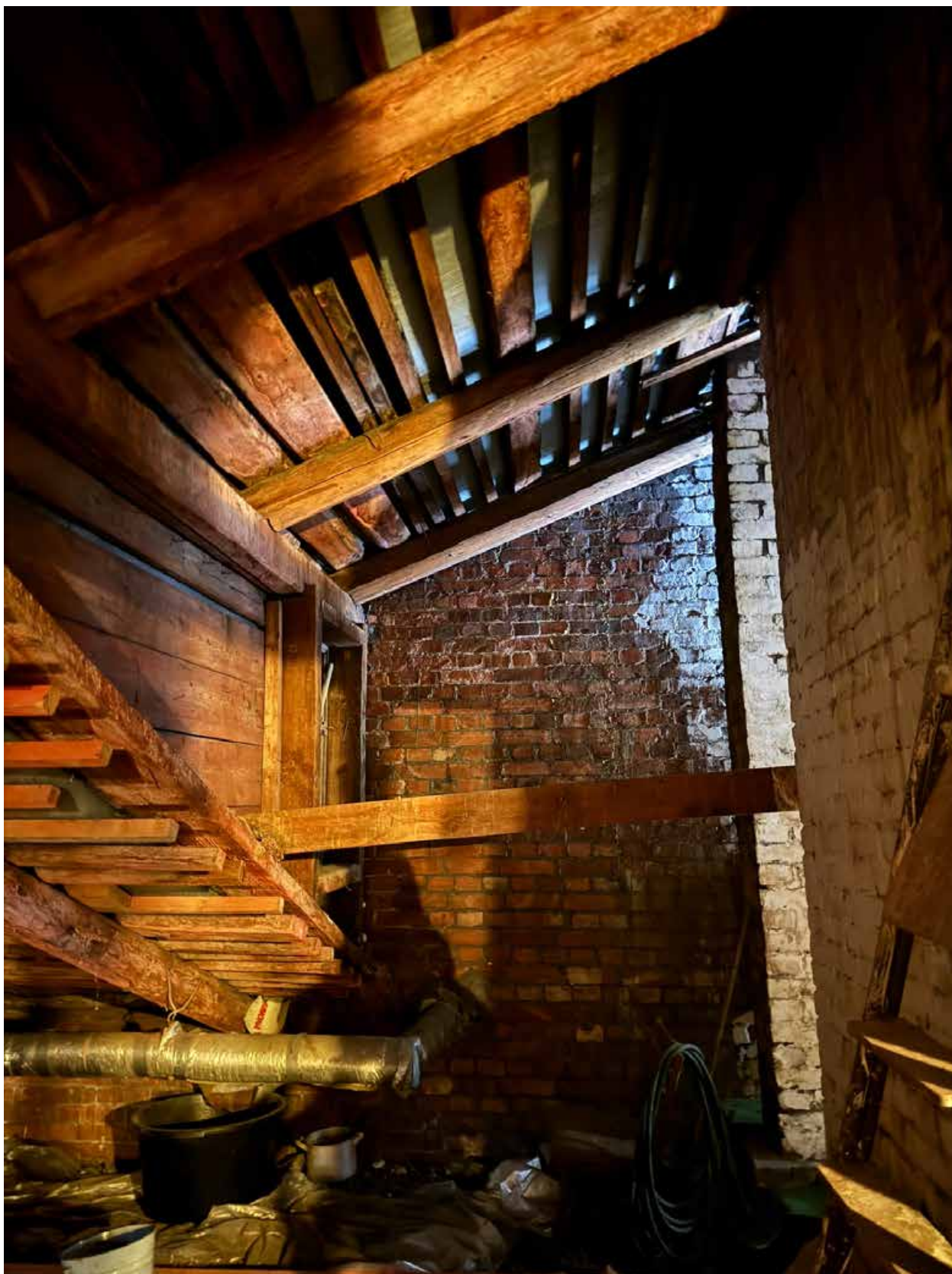
Фото 28. Интерьер чердачного помещения объекта культурного наследия.
