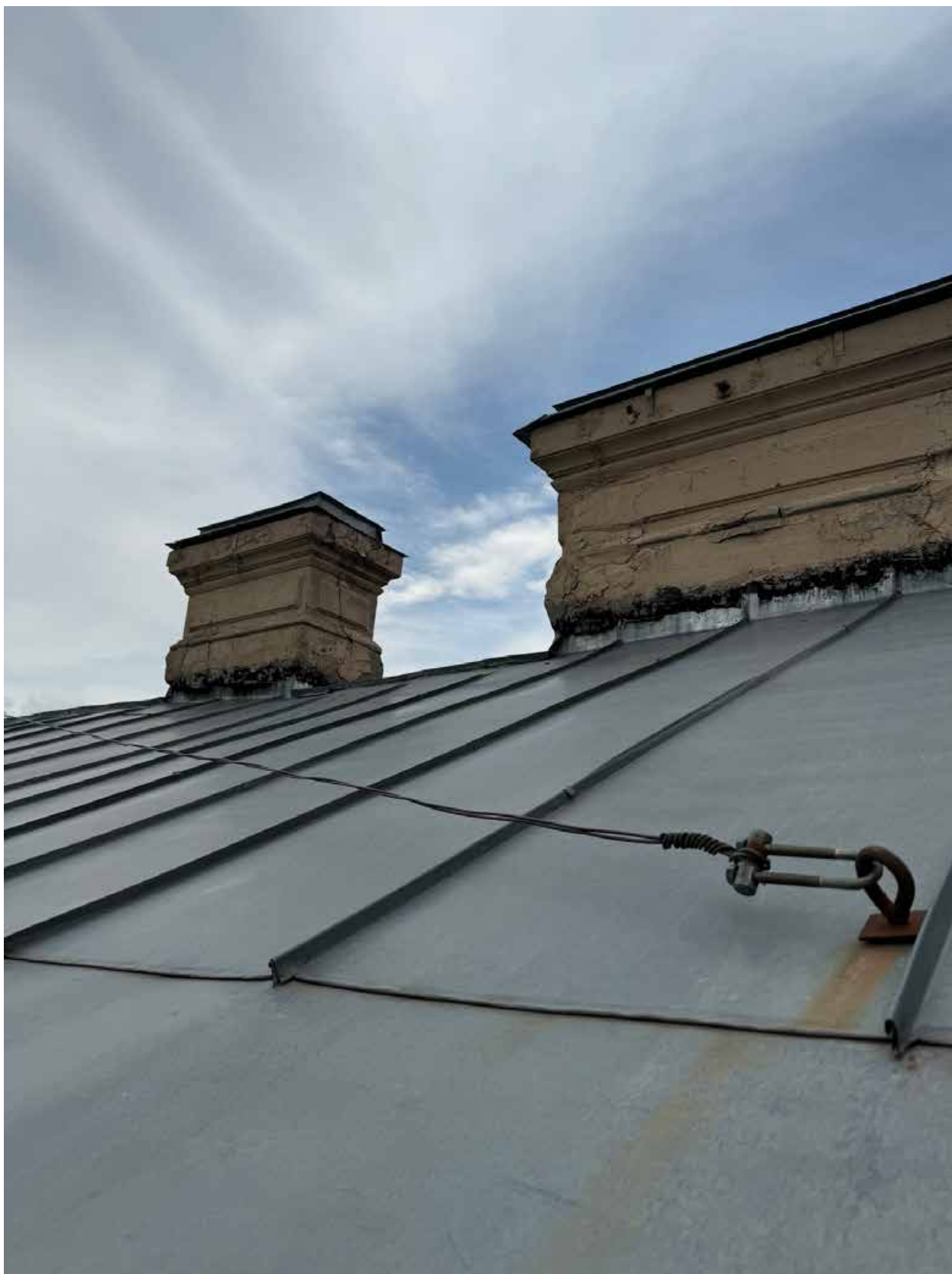
Фото 32. Фрагмент крыши объекта культурного наследия.
