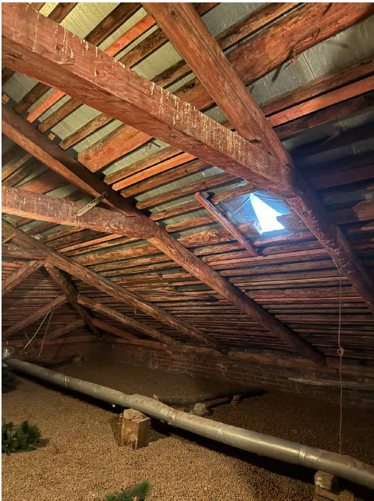
Фото 27. Интерьер чердачного помещения объекта культурного наследия.
