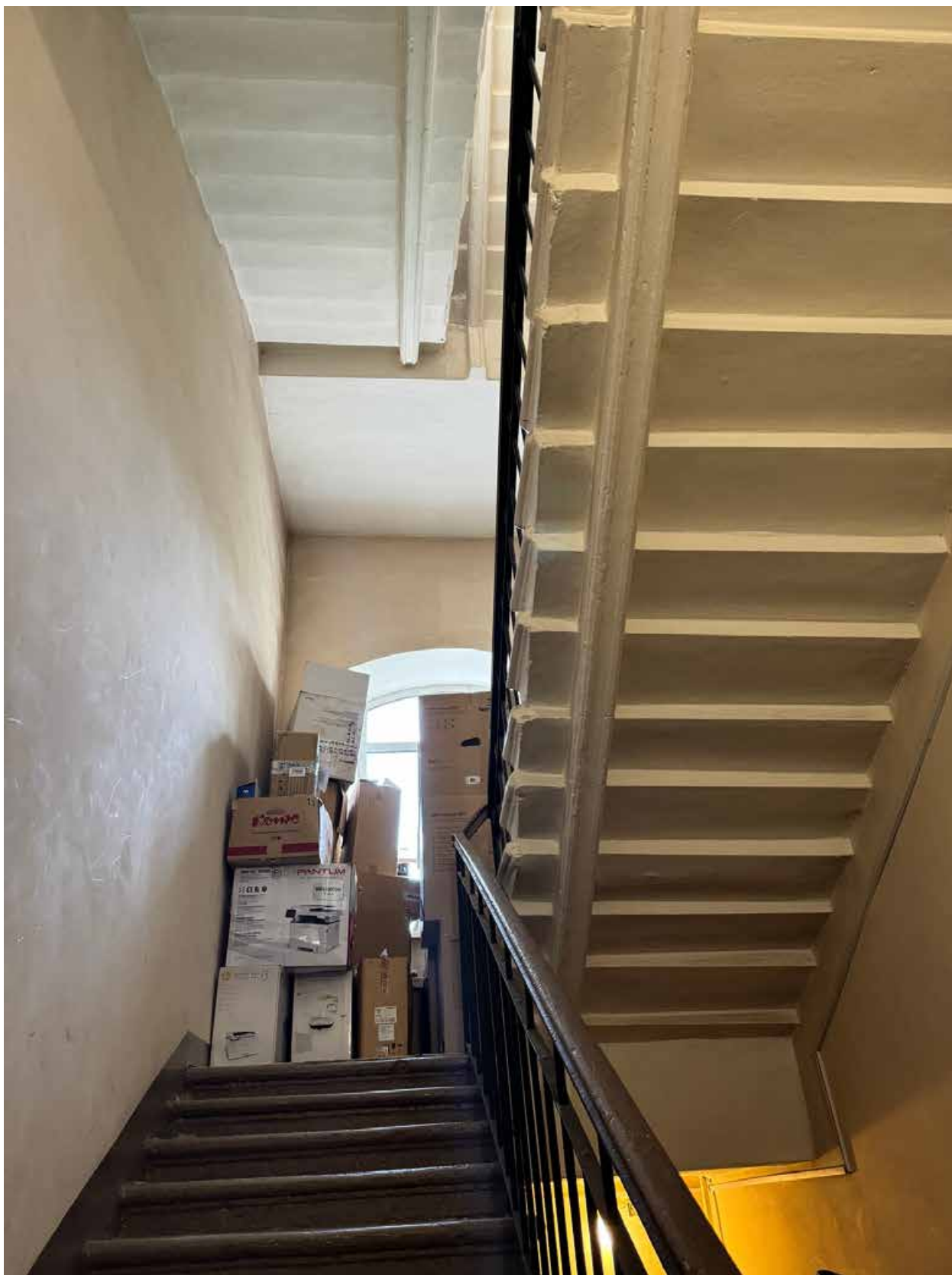
Фото 11. Интерьер лестницы, ведущей к чердачным помещениям объекта культурного наследия.
