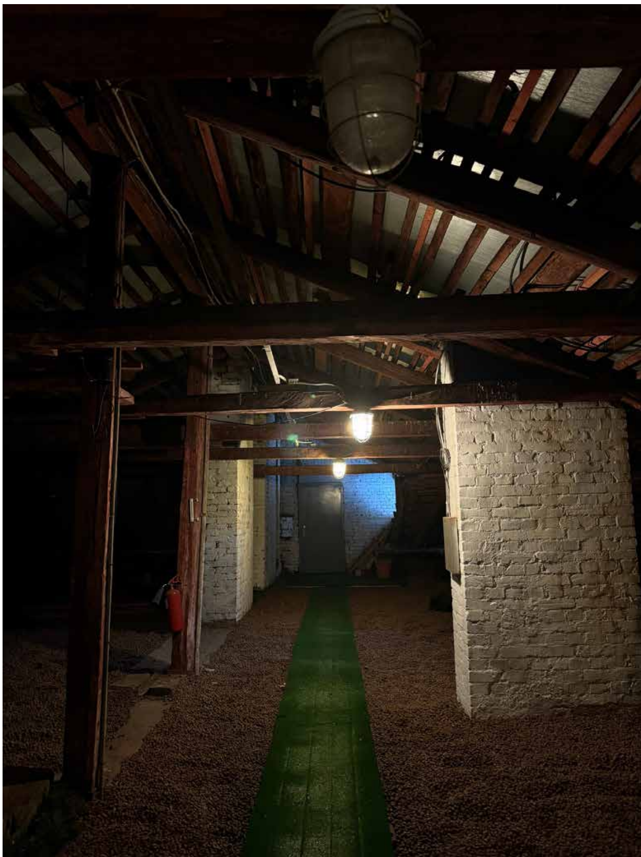
Фото 23. Интерьер чердачного помещения объекта культурного наследия.
