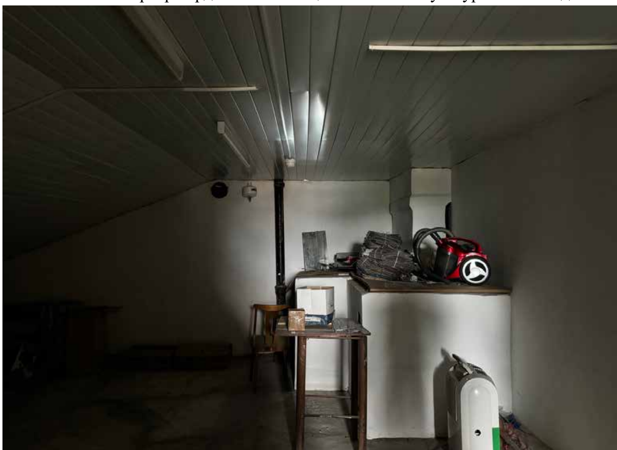
Фото 17. Интерьер чердачного помещения объекта культурного наследия.
