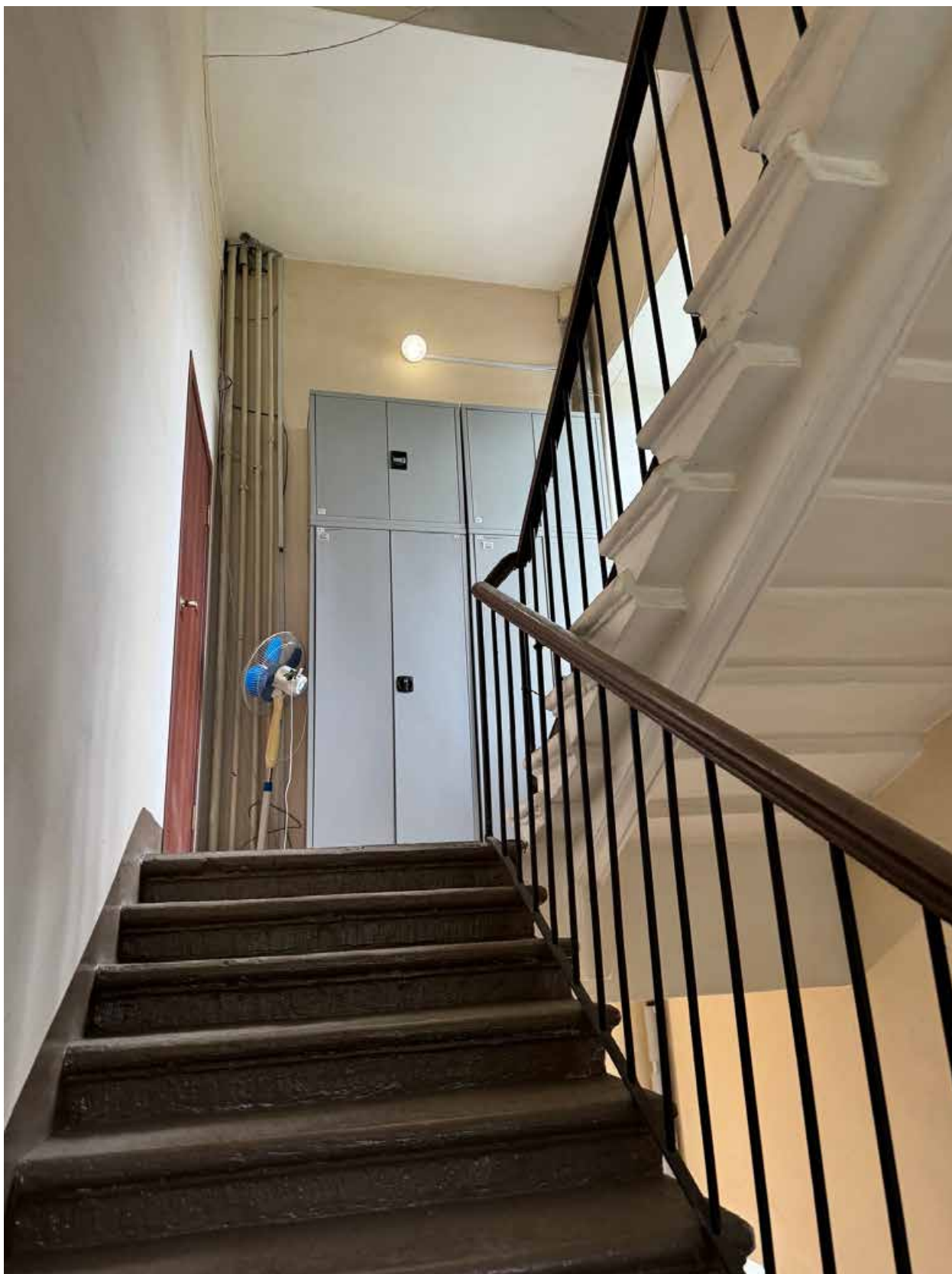
Фото 13. Интерьер лестницы, ведущей к чердачным помещениям объекта культурного наследия.
