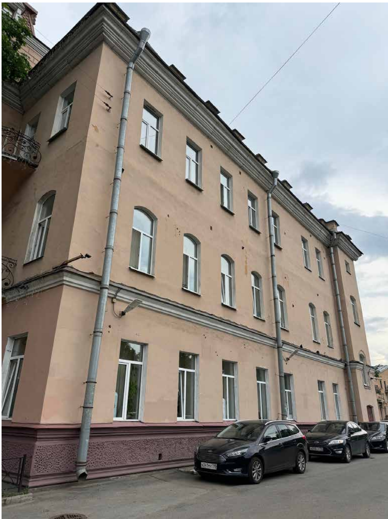
Фото 4. Общий вид восточного фасада объекта культурного наследия.
