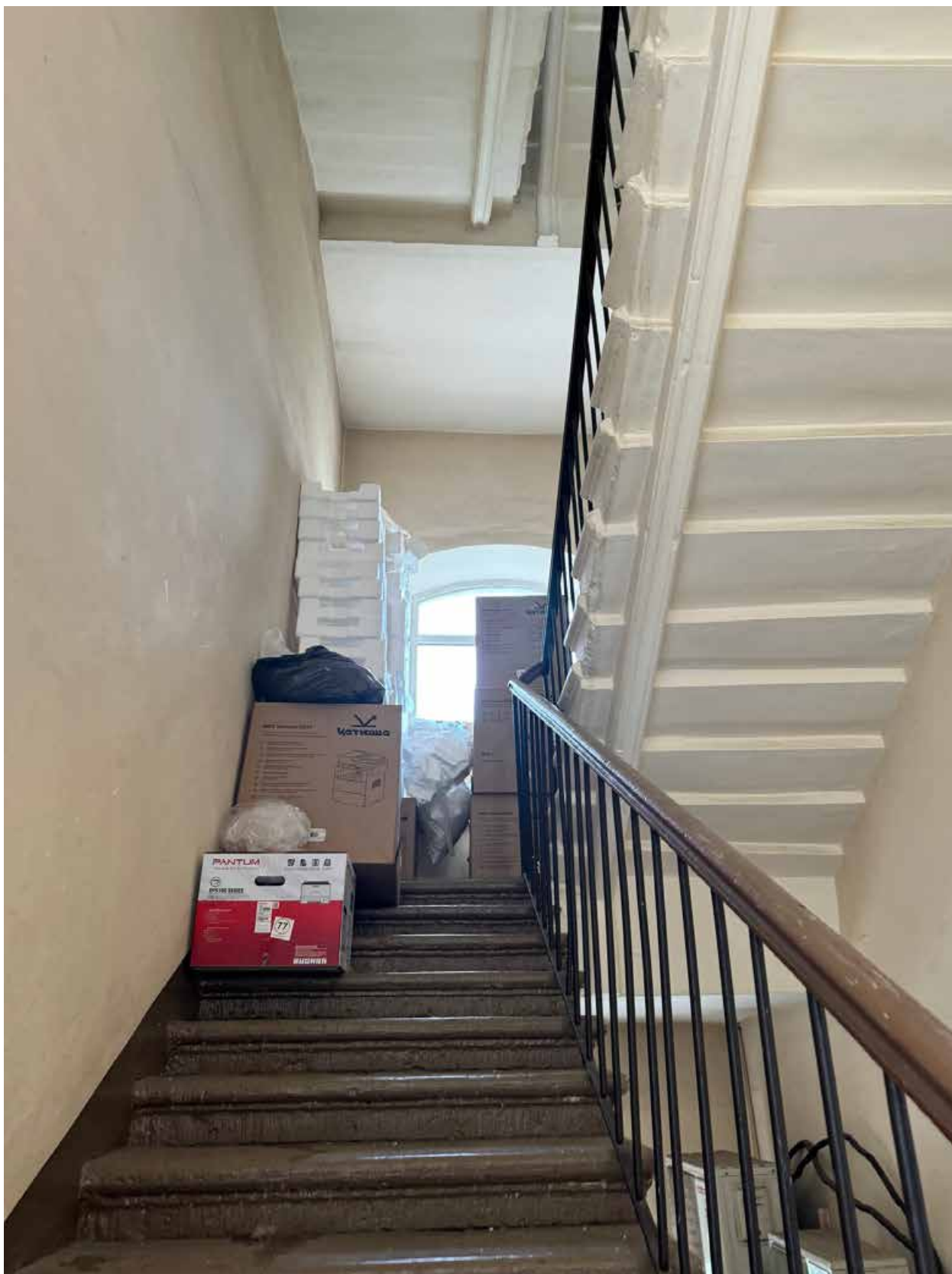
Фото 12. Интерьер лестницы, ведущей к чердачным помещениям объекта культурного наследия.
