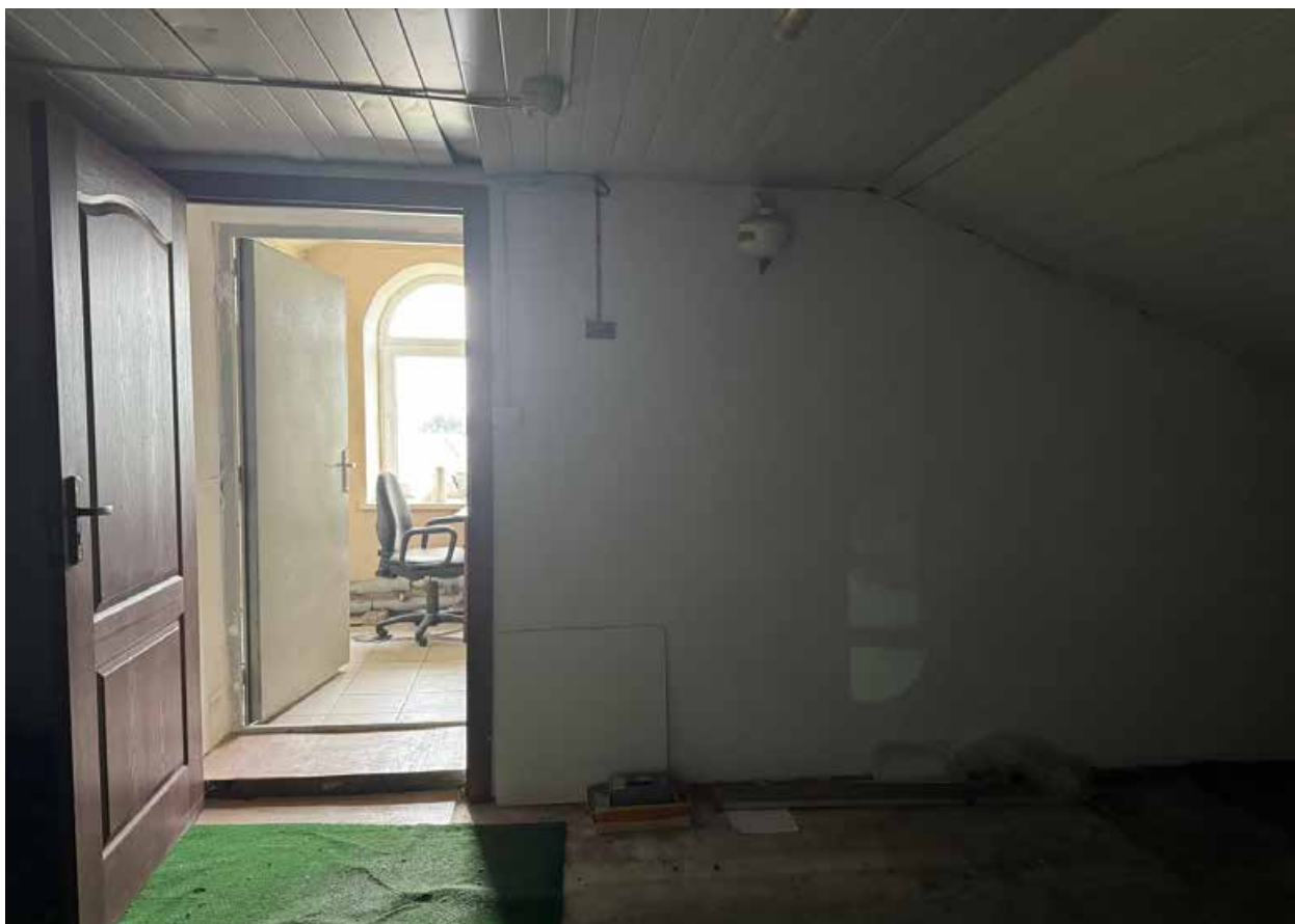
Фото 19. Интерьер чердачного помещения объекта культурного наследия.
