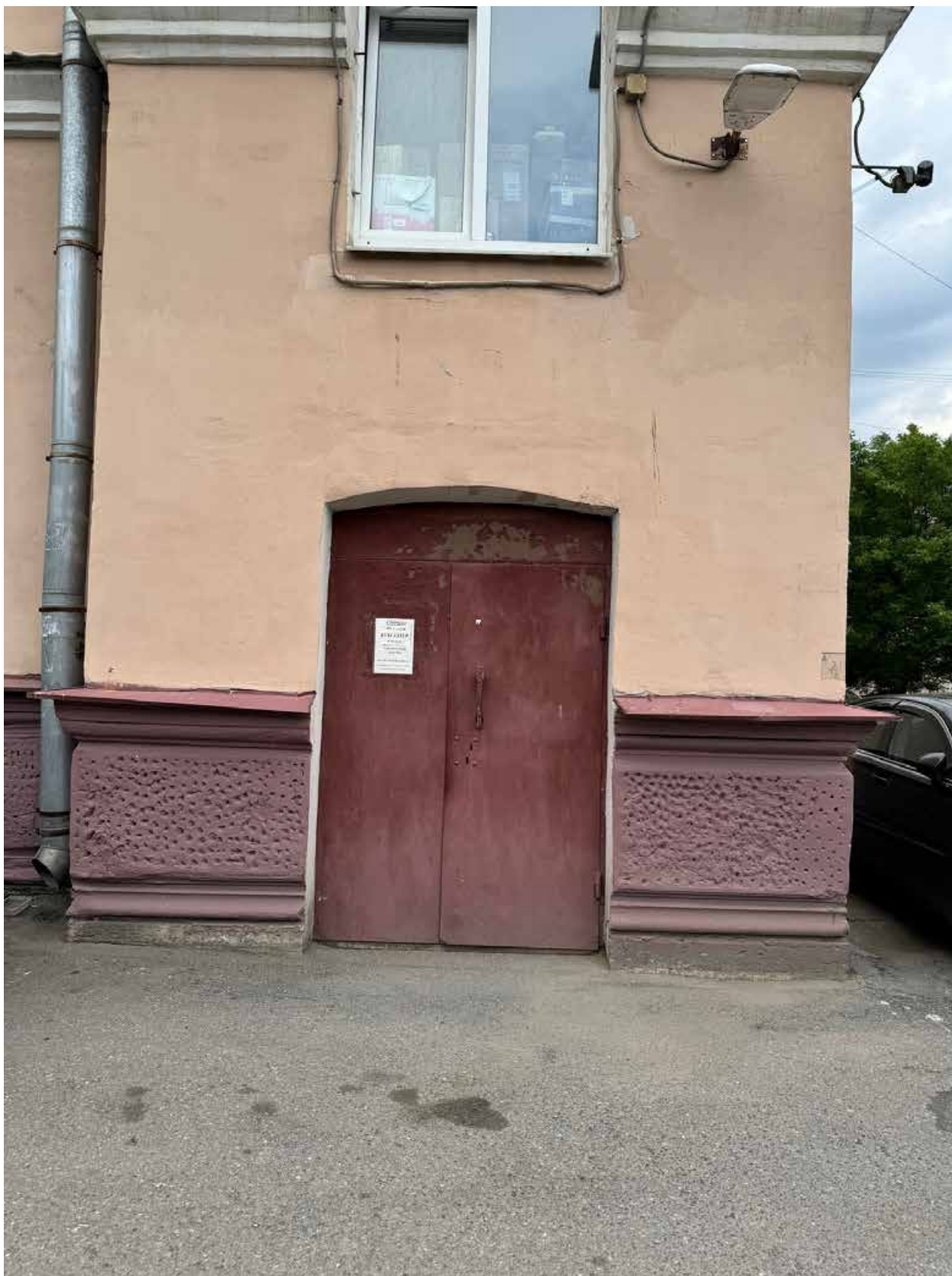
Фото 6. Фрагмент восточного фасада объекта культурного наследия.
