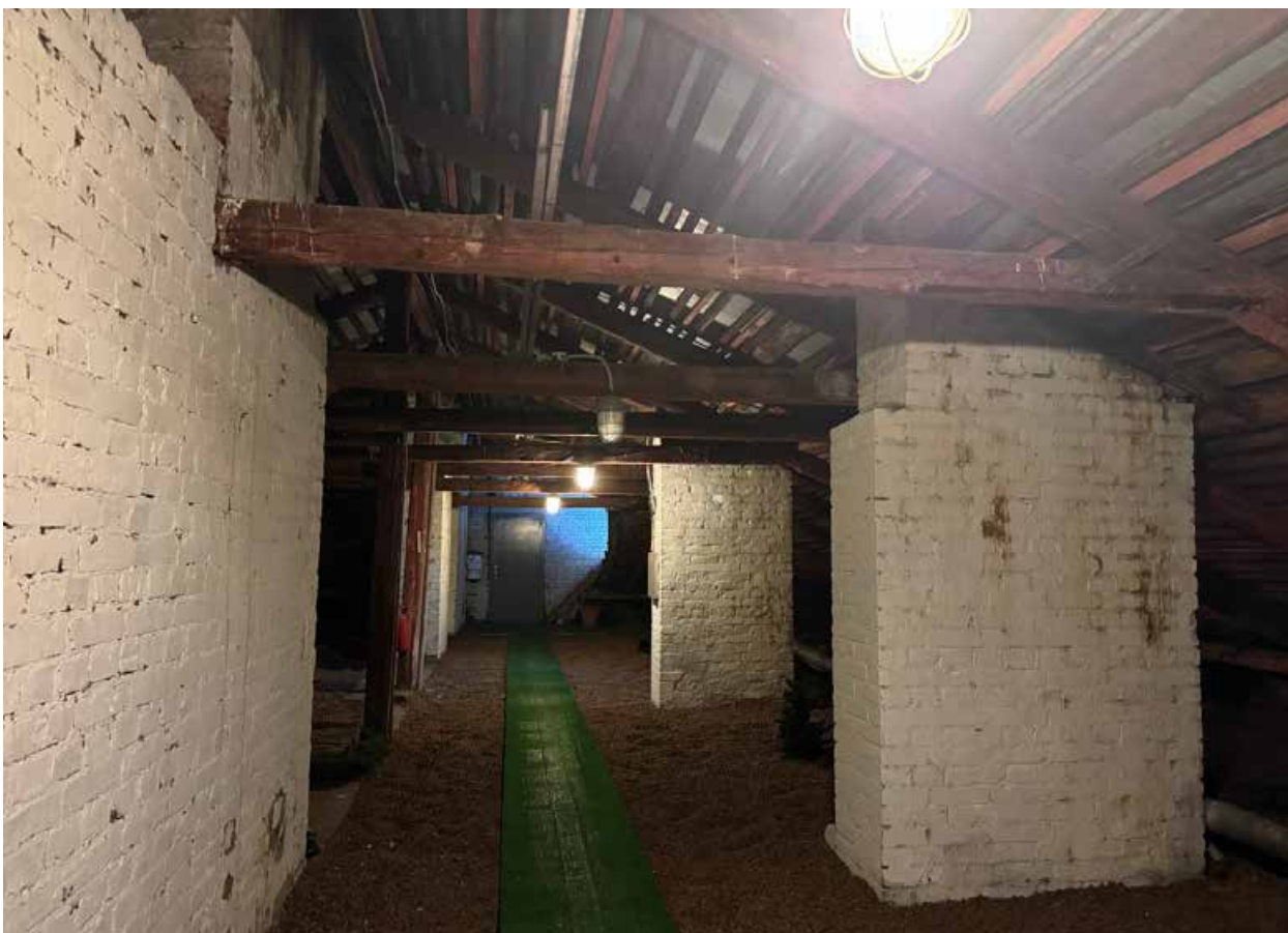
Фото 20. Интерьер чердачного помещения объекта культурного наследия.
