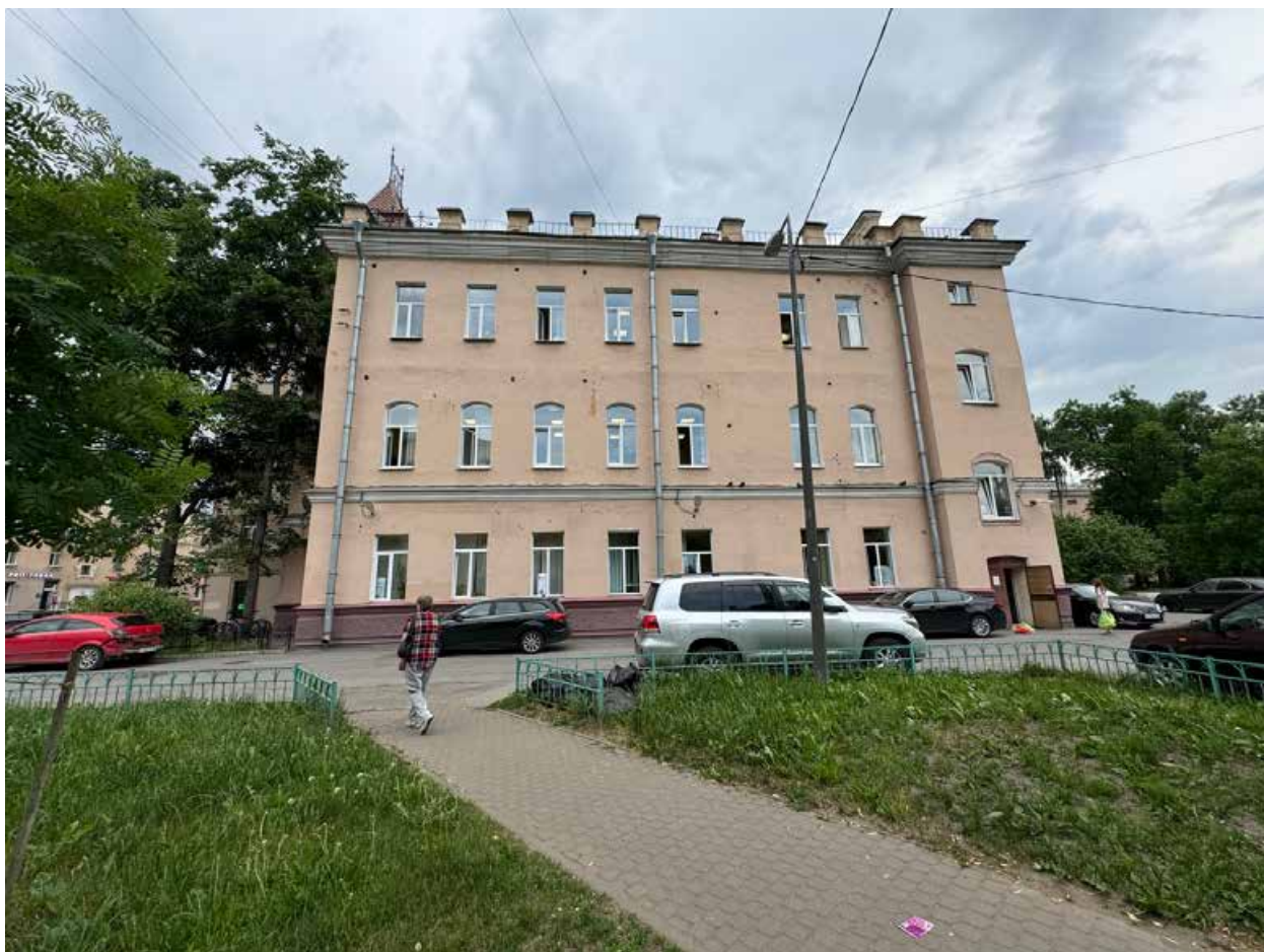
Фото 5. Общий вид восточного фасада объекта культурного наследия.
