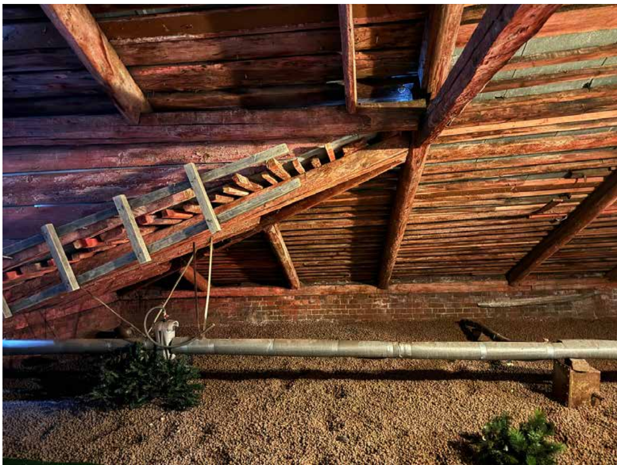
Фото 29. Интерьер чердачного помещения объекта культурного наследия.
