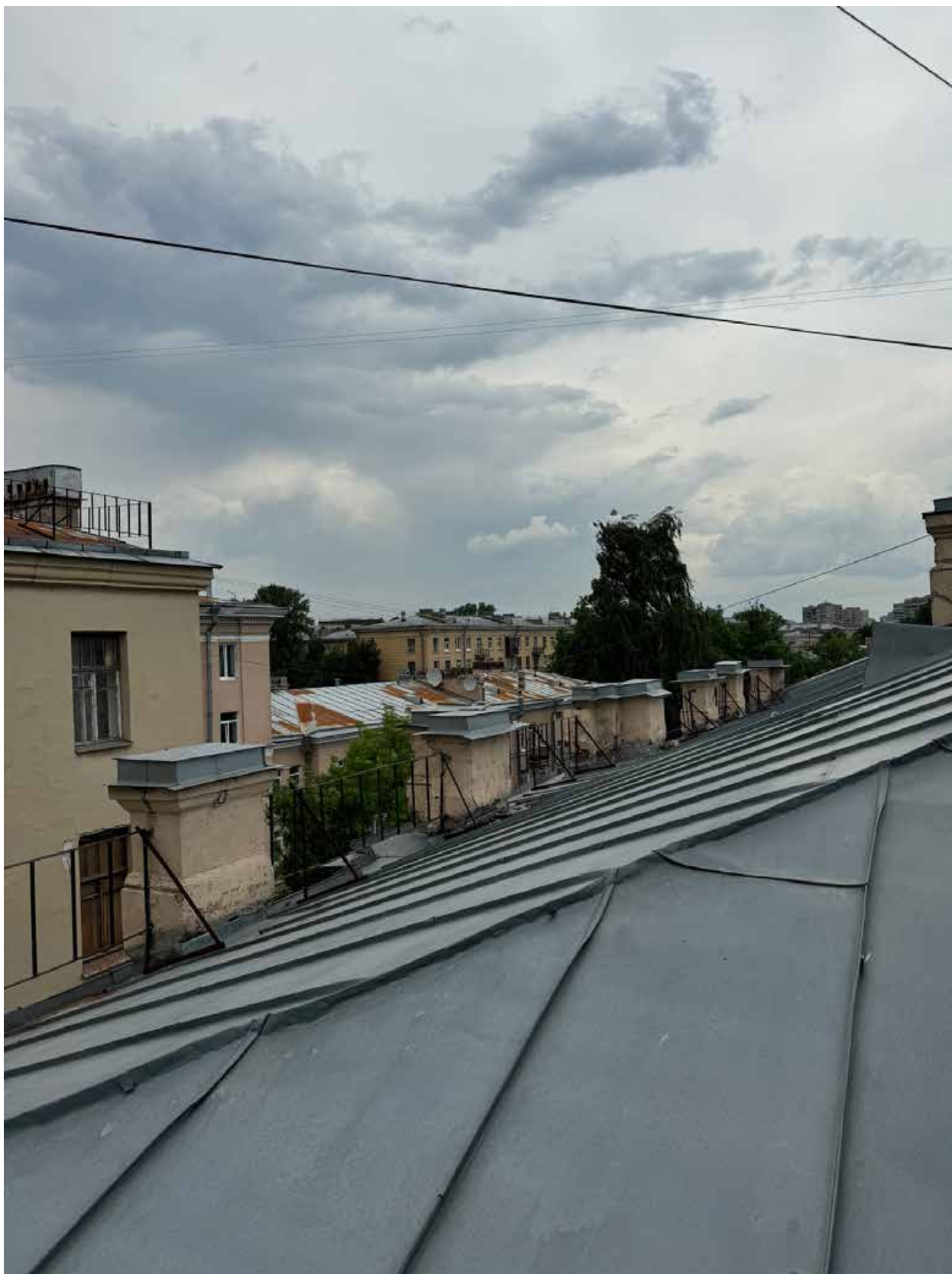
Фото 34. Фрагмент крыши объекта культурного наследия.
