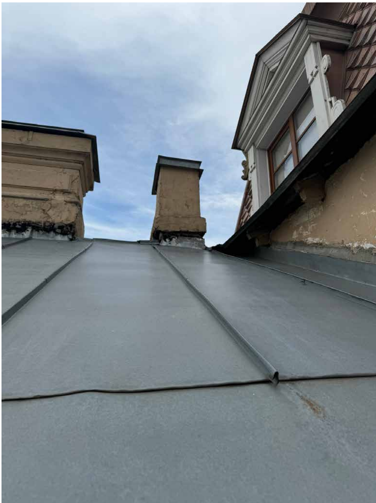
Фото 33. Фрагмент крыши объекта культурного наследия.
