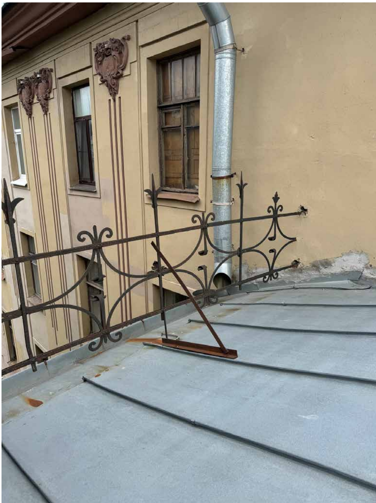
Фото 35. Фрагмент ограждения крыши объекта культурного наследия.
