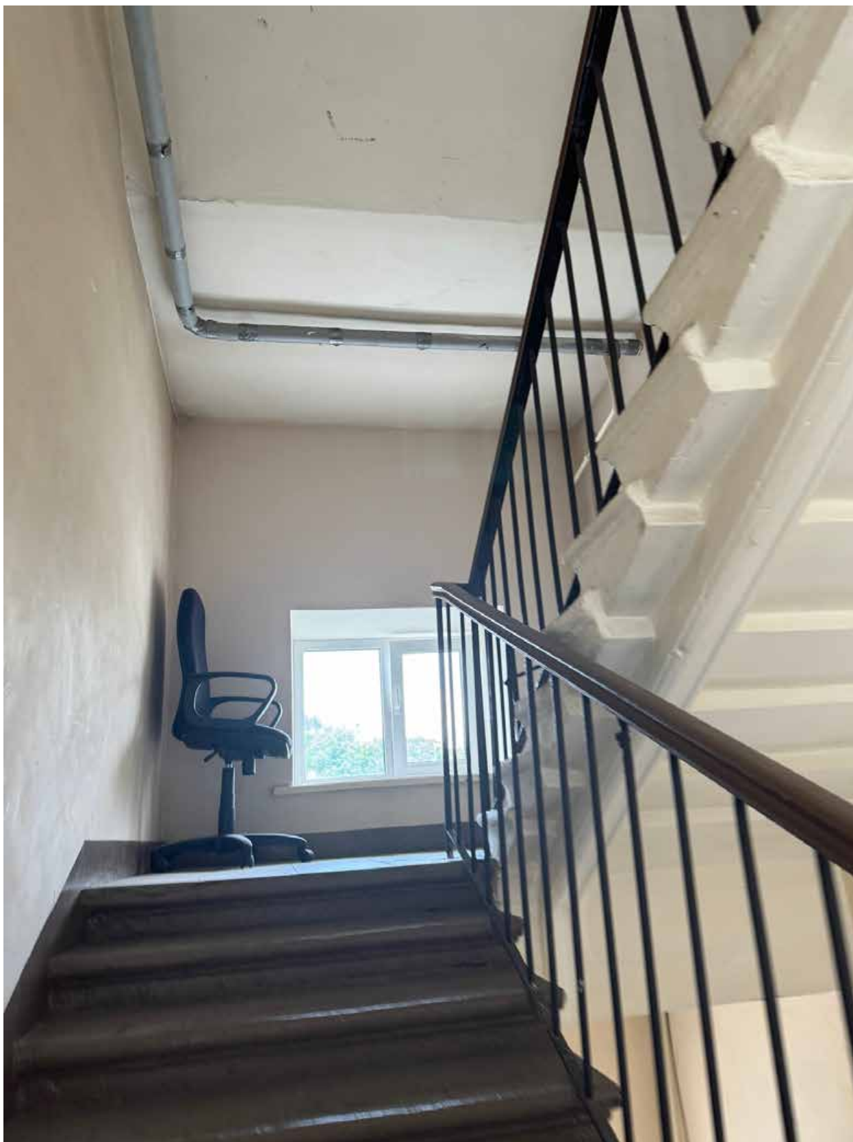
Фото 14. Интерьер лестницы, ведущей к чердачным помещениям объекта культурного наследия.
