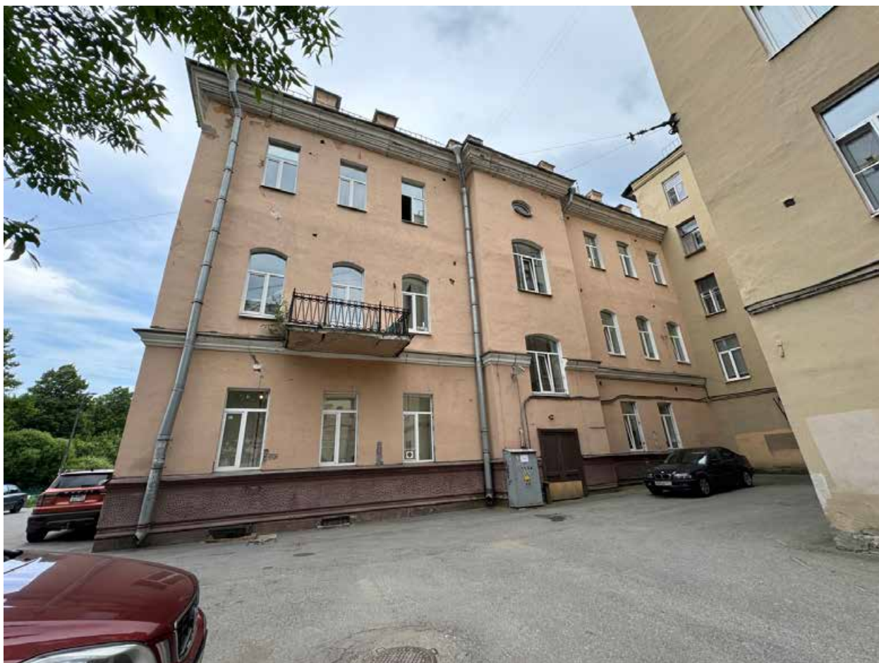
Фото 8. Общий вид западного фасада объекта культурного наследия.
