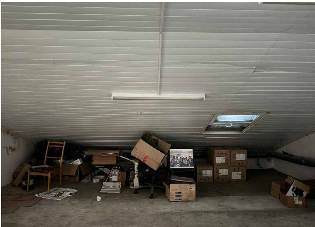
Фото 18. Интерьер чердачного помещения объекта культурного наследия.
