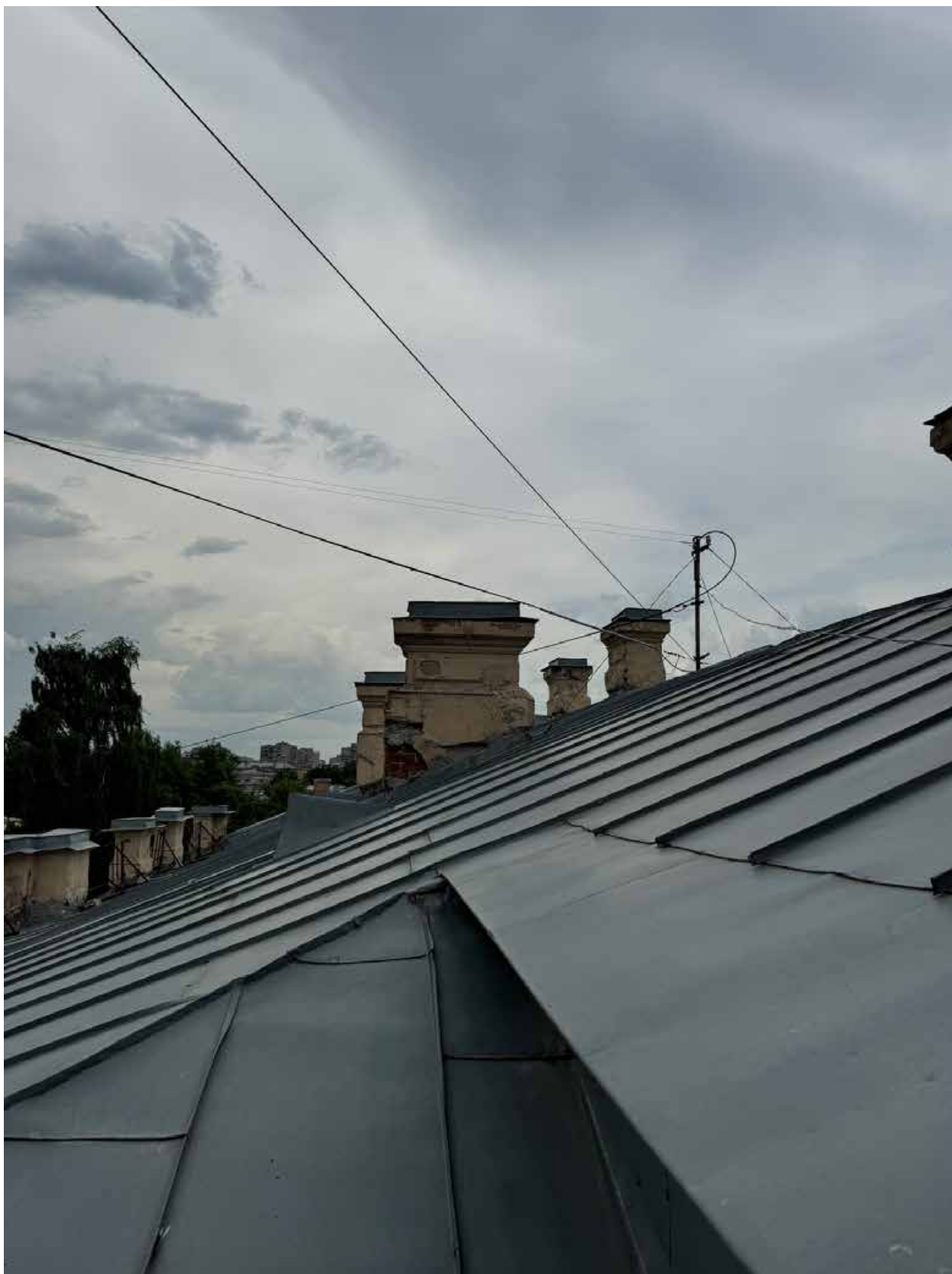
Фото 31. Фрагмент крыши объекта культурного наследия.
