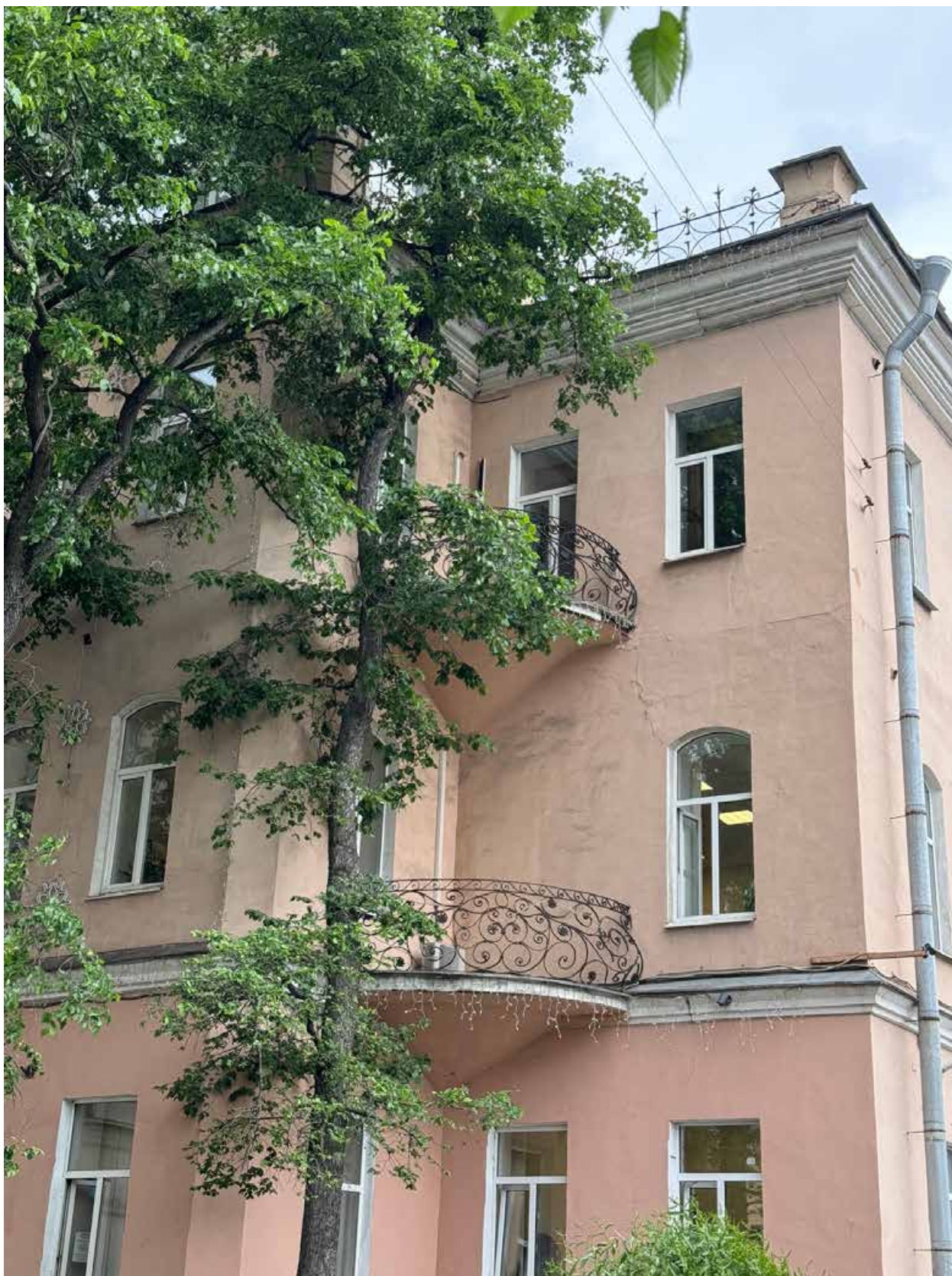
Фото 3. Фрагмент лицевого южного фасада по Большой Пороховской улице объекта культурного наследия.
