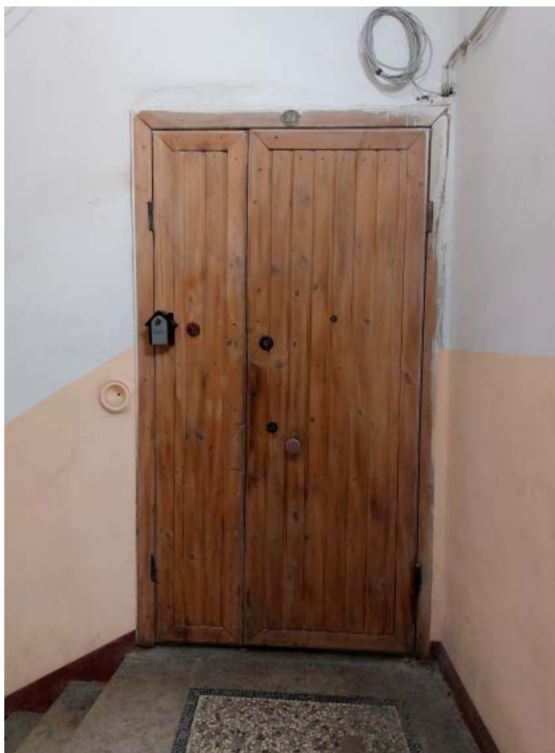
4. Входная дверь кв. №24 в уровне 2-го этажа объекта культурного наследия федерального значения «Дом, где жили: в 1877-1916 гг. - композитор Направник Э.Ф., в 1882-1908 гг. - композитор Стравинский И.Ф., в 1946-1982 гг. - геолог Наливкин Д.В.», расположенного по адресу: г. Санкт-Петербург, улица Глинки 3-5-7, литера А. 10.07.2022
