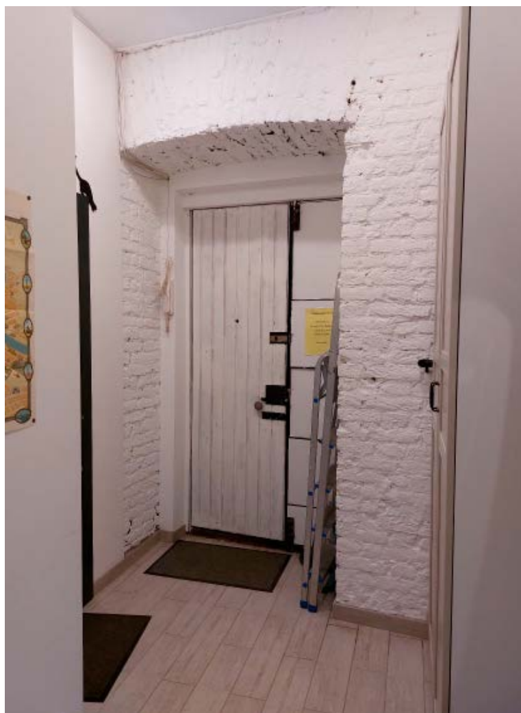
5. Входная дверь кв. №24 в уровне 2-го этажа объекта культурного наследия федерального значения «Дом, где жили: в 1877-1916 гг. - композитор Направник Э.Ф., в 1882-1908 гг. - композитор Стравинский И.Ф., в 1946-1982 гг. - геолог Наливкин Д.В.», расположенного по адресу: г. Санкт-Петербург, улица Глинки 3-5-7, литера А. 10.07.2022
