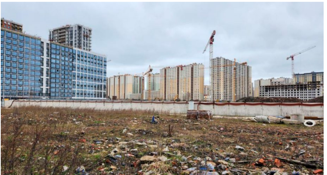
5. Вид от выявленного объекта культурного наследия «Производственное здание с дымовой трубой Киновиевского ультрамаринового завода Г.И. Вега», расположенного по адресу: г. Санкт-Петербург, Октябрьская наб., д. 38, литера АН, на зону производства работ. 22.04.2024
