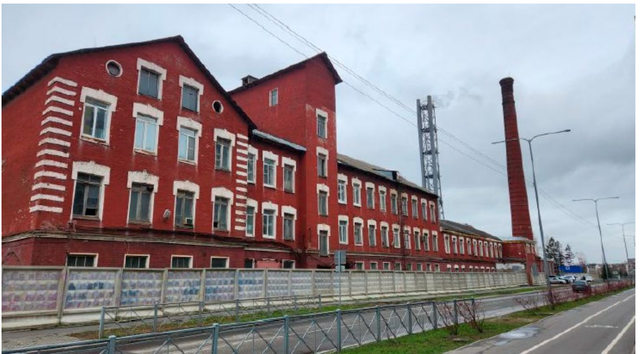
1. Вид на юго-западный фасад выявленного объекта культурного наследия «Производственное здание с дымовой трубой Киновиевского ультрамаринового завода Г.И. Вега», расположенного по адресу: г. Санкт-Петербург, Октябрьская наб., д. 38, литера АН. 22.04.2024
