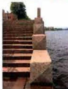
каменный настил в ступенчатой площадке, каменный настил протурки в обход ступен, решетки лестниц из гранитных профилированных блоков;
