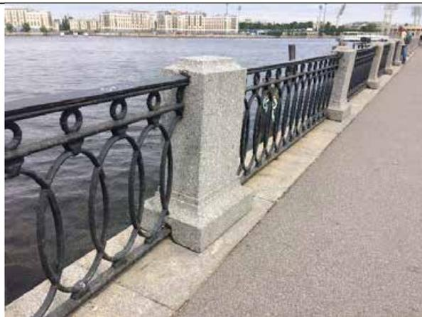
парапетные вертикальные тумбы с профилированным плинтусом и завершением в виде усеченной трапеции (розовый оvoidальный гранит рапакиви – от восточного берегового устья Тучкова моста до западного берегового устья Биржевого моста) с металлическими ажурными решетками между ними – кованые металлические звенья в виде пересекающихся овальных элементов, с фризом из колец по верхнему поясу;
