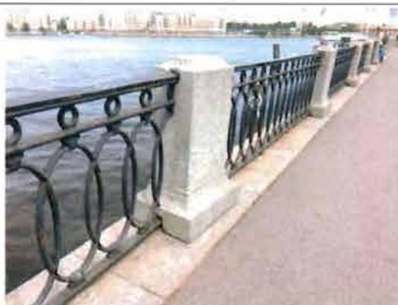
парапетные вертикальные тумбы с профилированным плинтом и завершением в виде усеченной трапеции (розовый овоидальный гранит рапакиви – от восточного берегового устоя Тучкова моста до западного берегового устоя Биржевого моста) с металлическими ажурными решетками между ними – кованые металлические звенья в виде пересекающихся овальных элементов, с фризом из колец по верхнему поясу;
