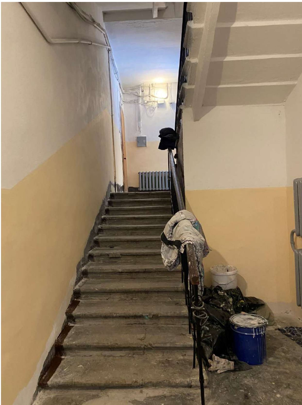
Фото 23. Общий вид лестницы объекта культурного наследия
