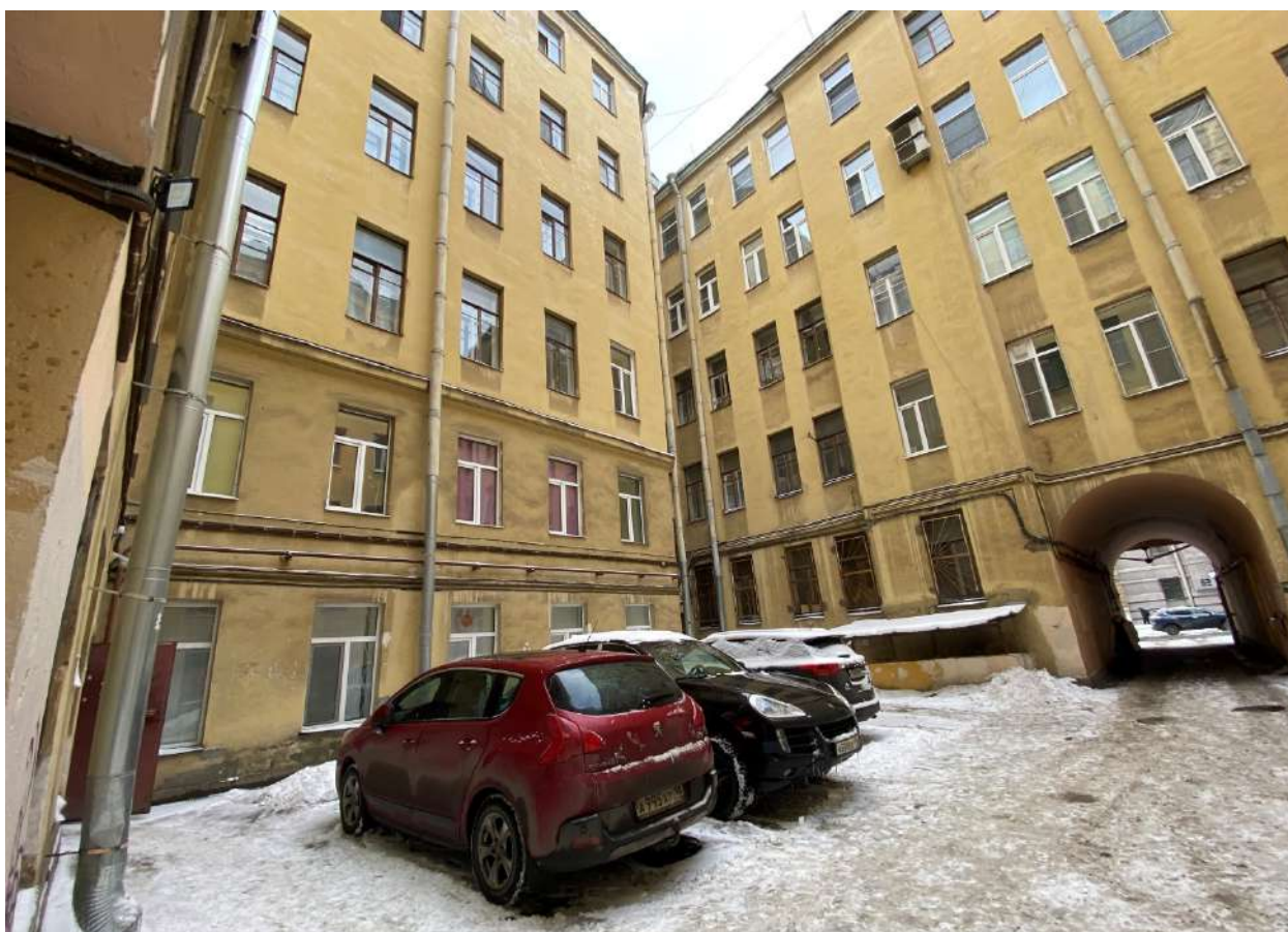
Фото 13. Вид на часть дворовых фасадов объекта культурного наследия
