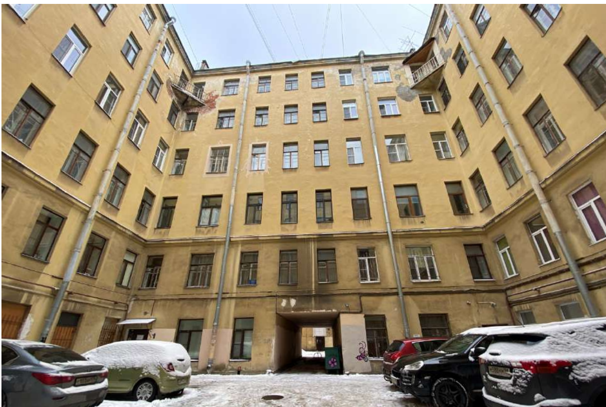
Фото 11. Вид на часть дворовых фасадов объекта культурного наследия
