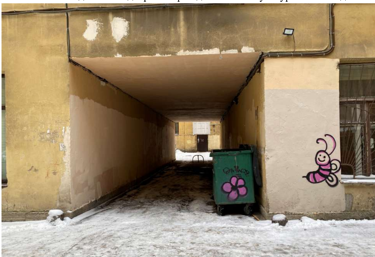
Фото 14. Вид на воротный проезд в северном дворе объекта культурного наследия
