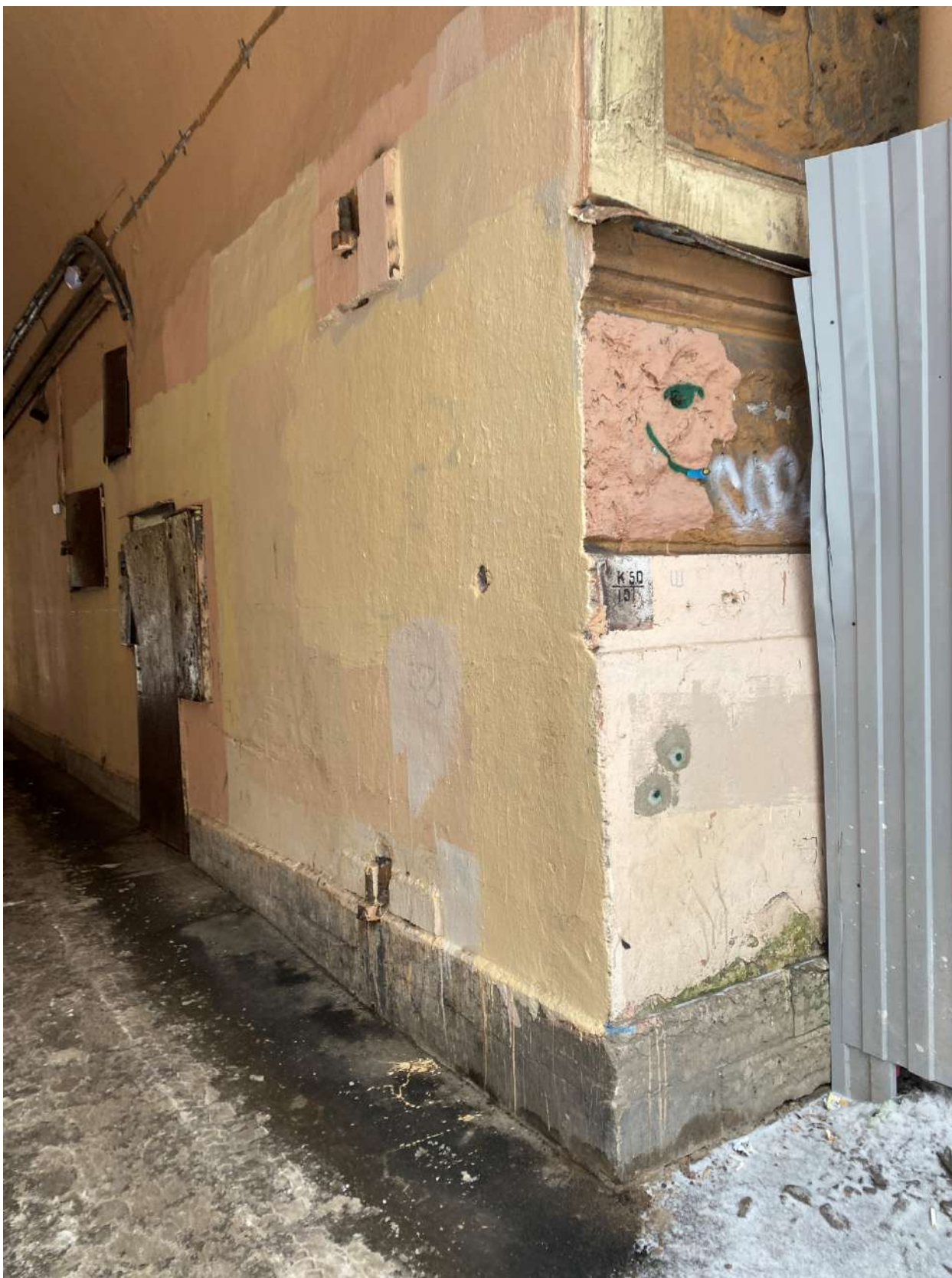
Фото 10. Фрагмент части фасадов объекта культурного наследия
