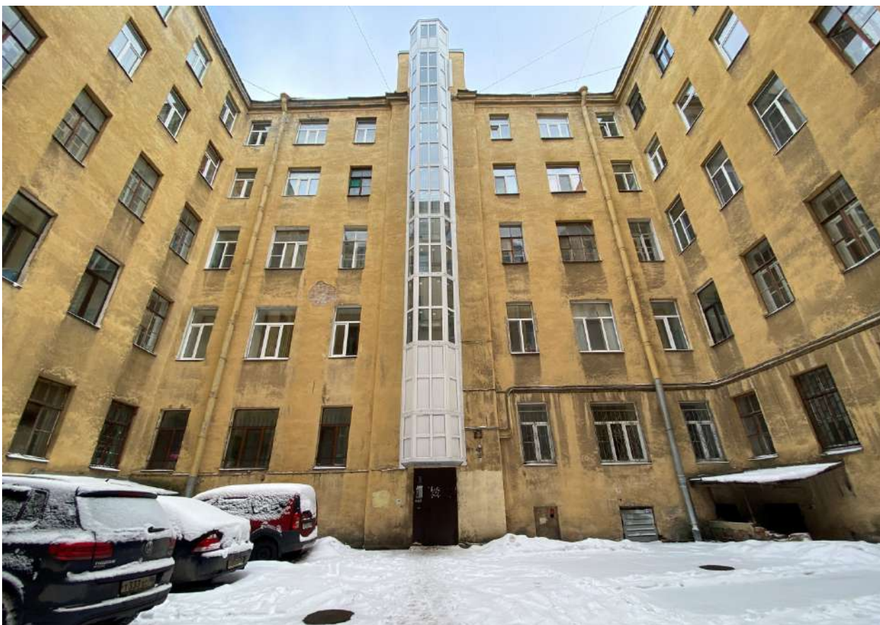
Фото 15. Вид на часть дворовых фасадов объекта культурного наследия
