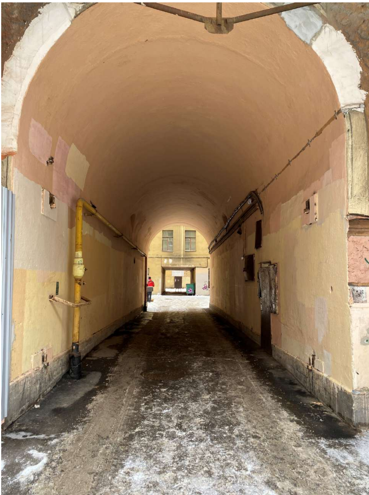
Фото 9. Вид на северный воротный проезд объекта культурного наследия
