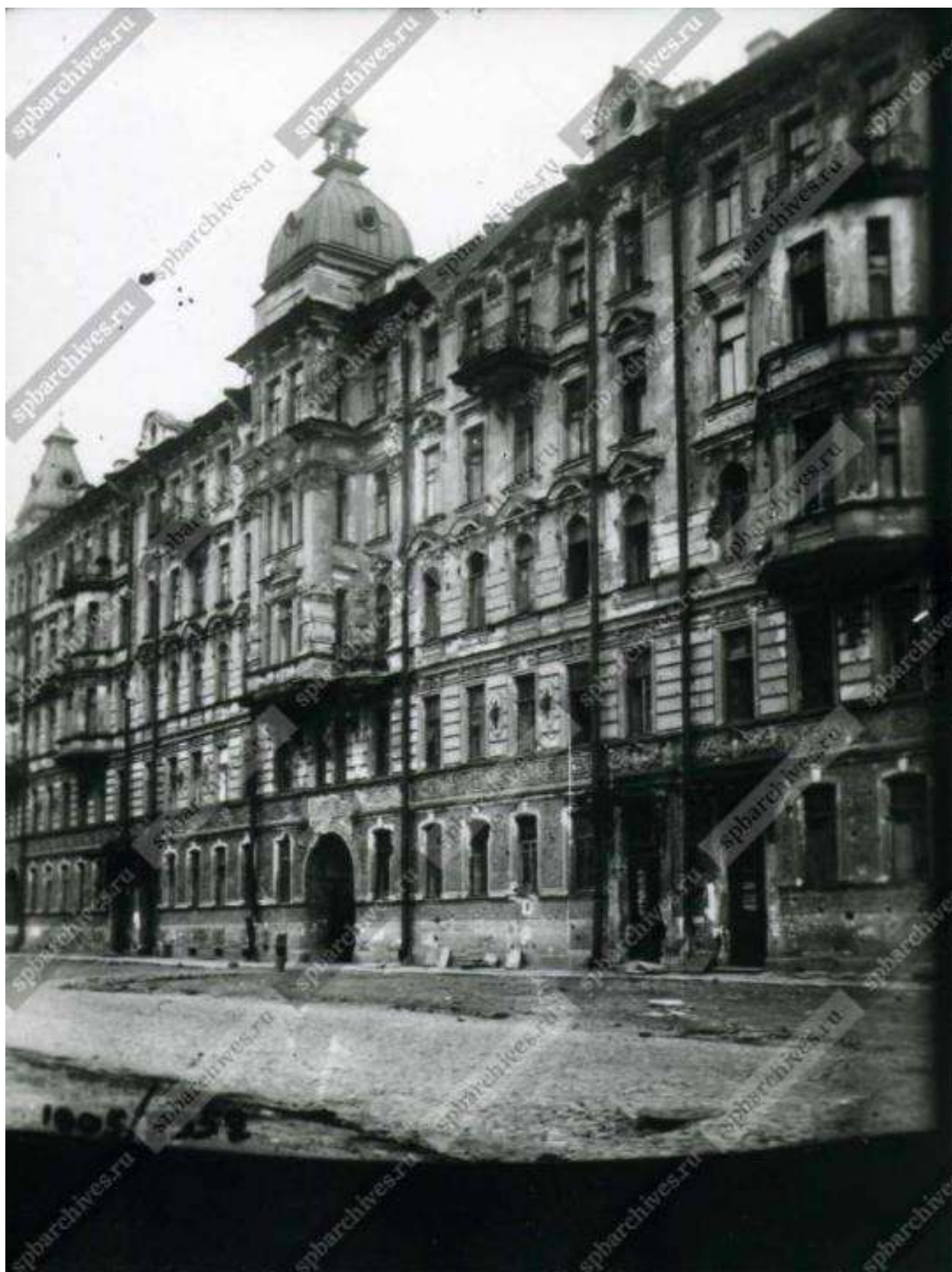
46. Фотография фрагмента фасада жилого дома №33; 1901-1902, арх. В.Р. Курзанов, построен как крупный доходный дом. 12я линия ВО. 1952 г. – ЦГАКФФД СПб – Фотодокумент Вр 79330
