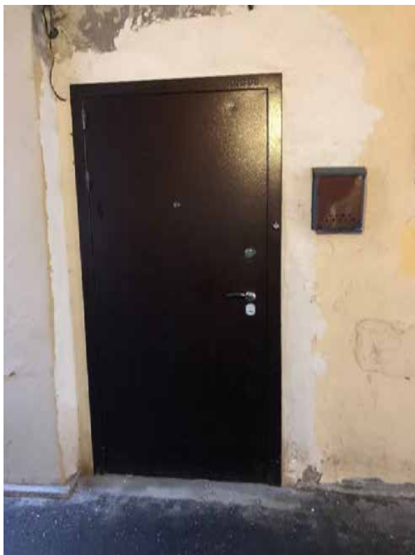
Фото 1. Вид на входную дверь с улицы.
