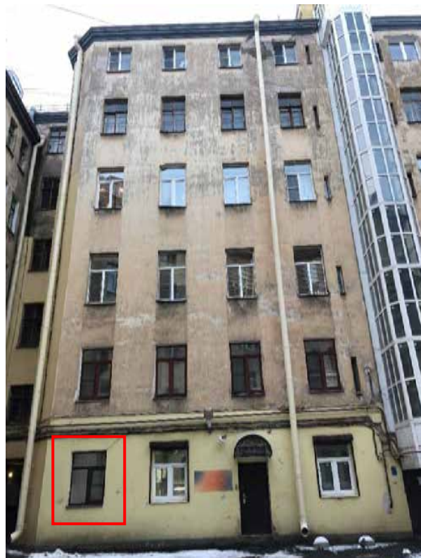
Фото 7. Вид на дворовый фасад.
