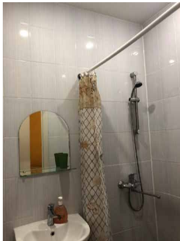
Фото 6. Вид на помещение № 3.
