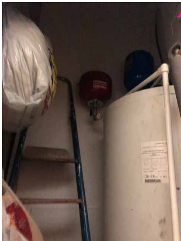
Фото 5. Вид на помещение № 4.
