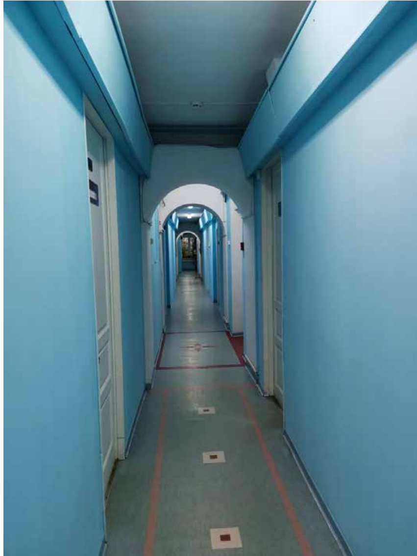
52. Вид в коридоре помещения 8-Н (пом.24).
