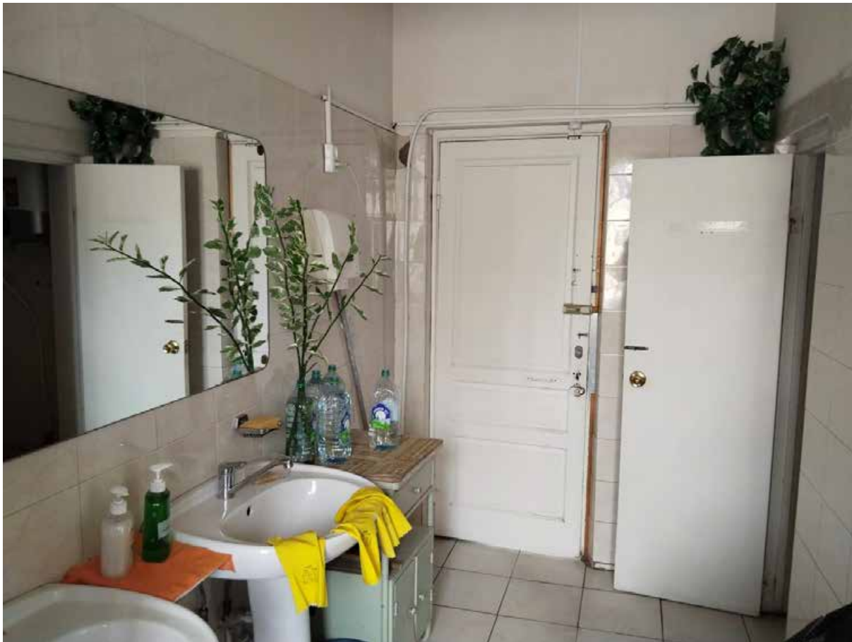
63. Вид в санузле помещения 8-Н (пом.28).
