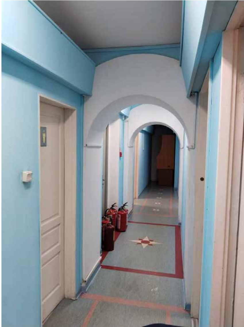
65. Вид в коридоре помещения 8-Н (пом.24).
