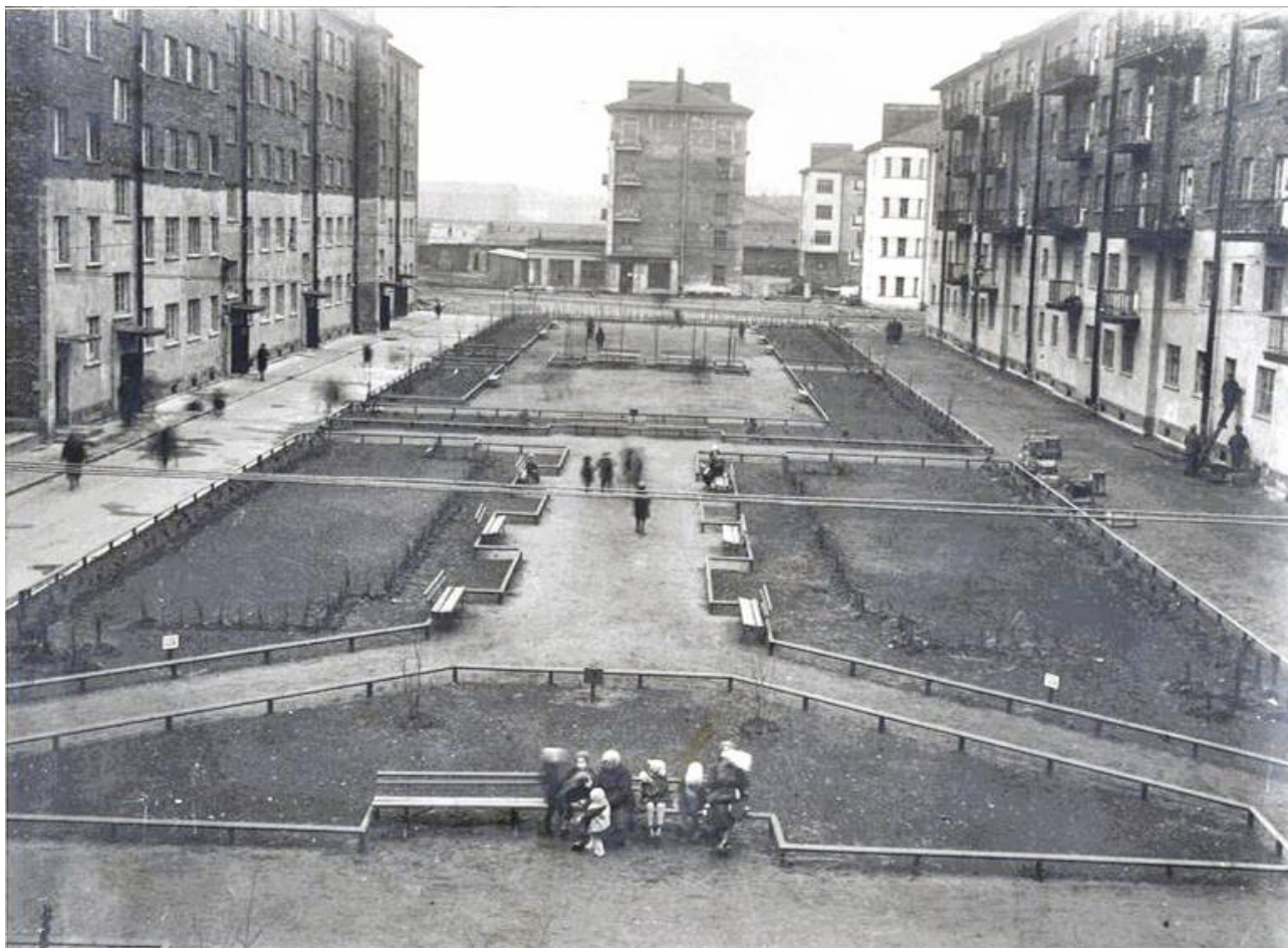
Илл.10. Бабури́нский жилмассив (сквер между корп.3 и 4), арх. Симонов Г. А., Каценеленбоген Т. Д., Жуковская В. А.. 1932 г. ГМИ СПб Инв.№-II-Б-2249 ф. Источник – сайт https://goskatalog.ru .
