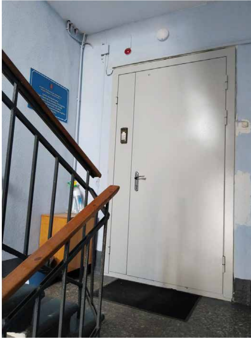
15. Вид на вход с лестничной клетки в помещение 8-Н.
