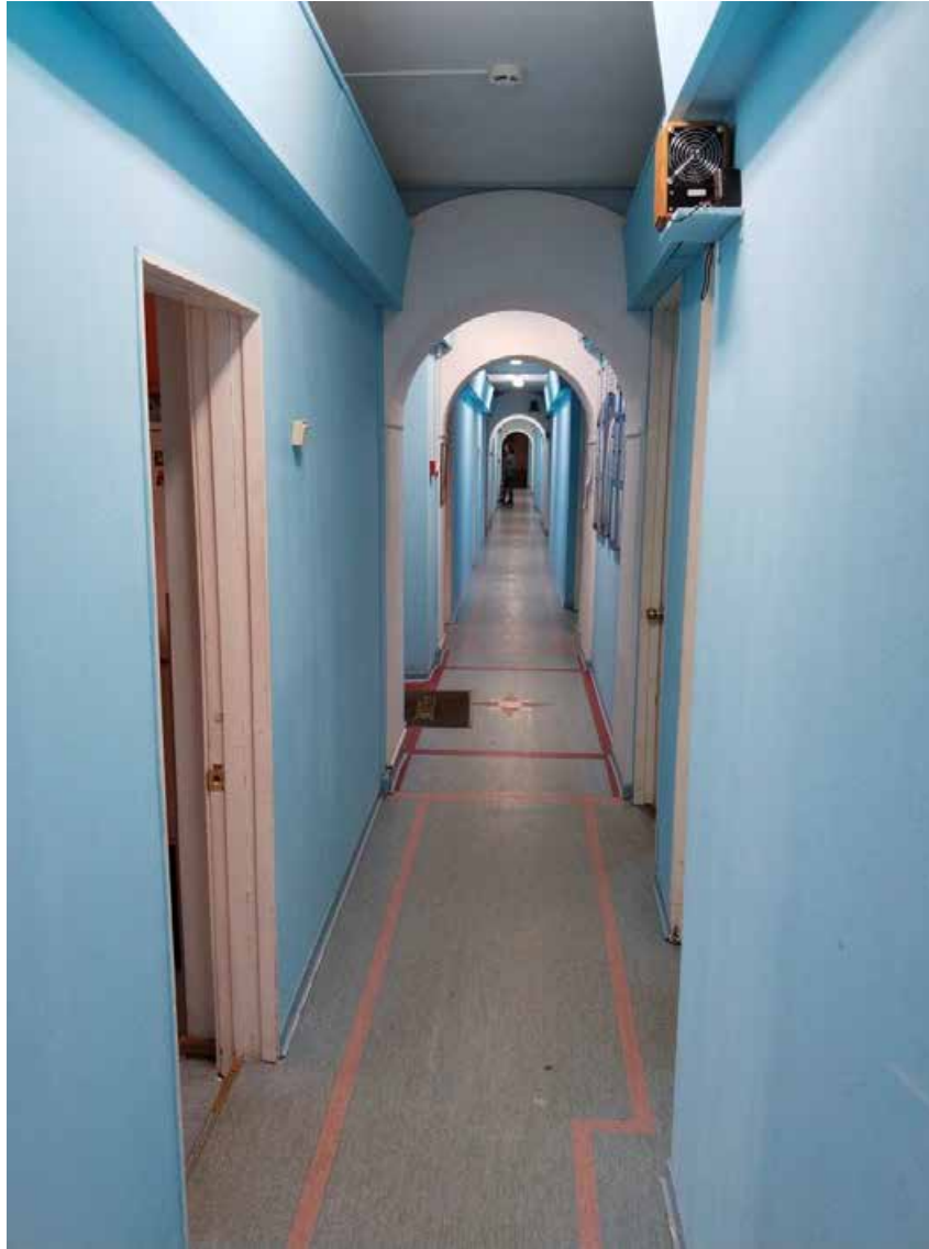
18. Вид в коридоре помещения 8-Н (пом.24).
