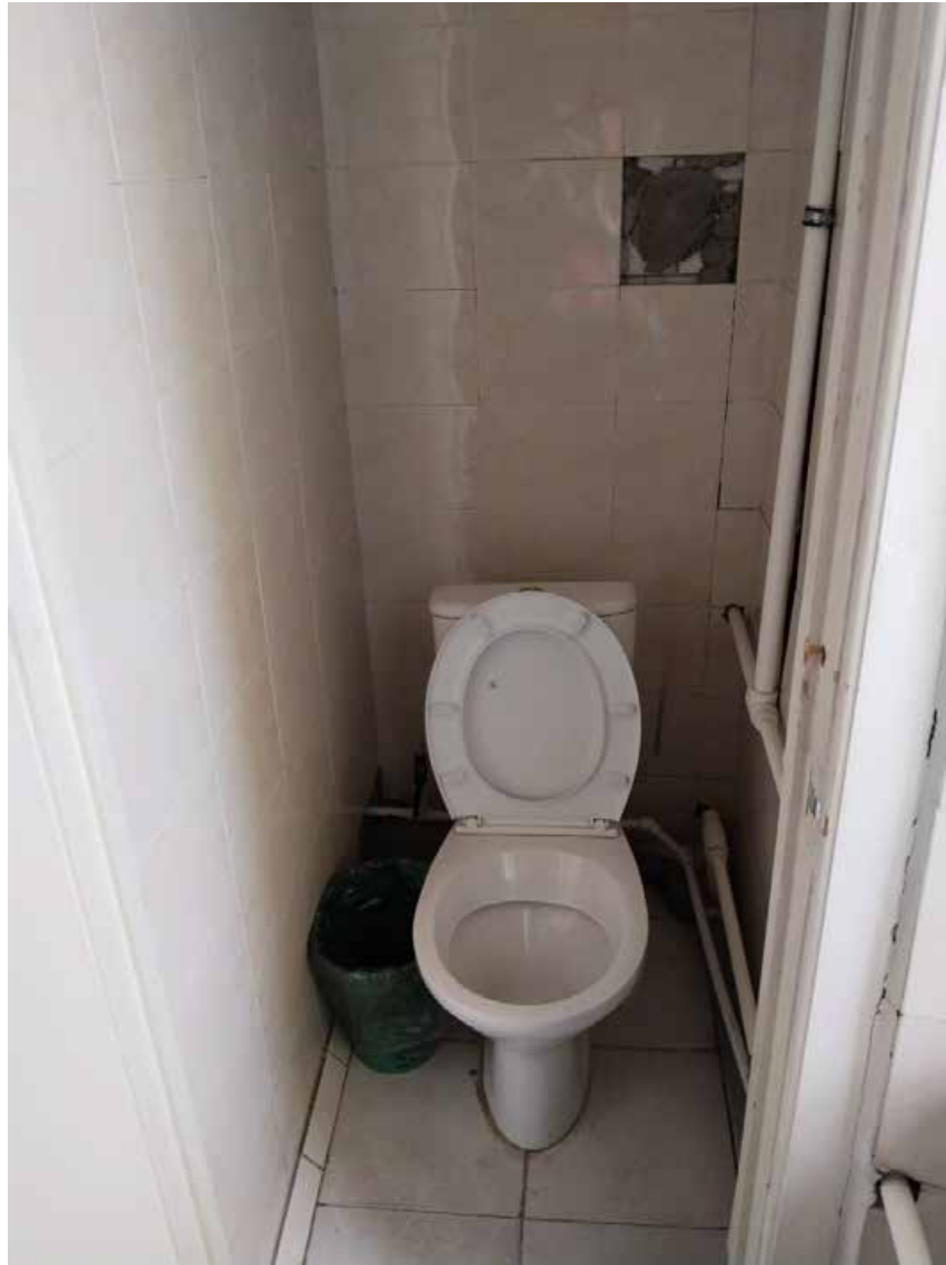
61. Вид в санузле помещения 8-Н (пом.25).
