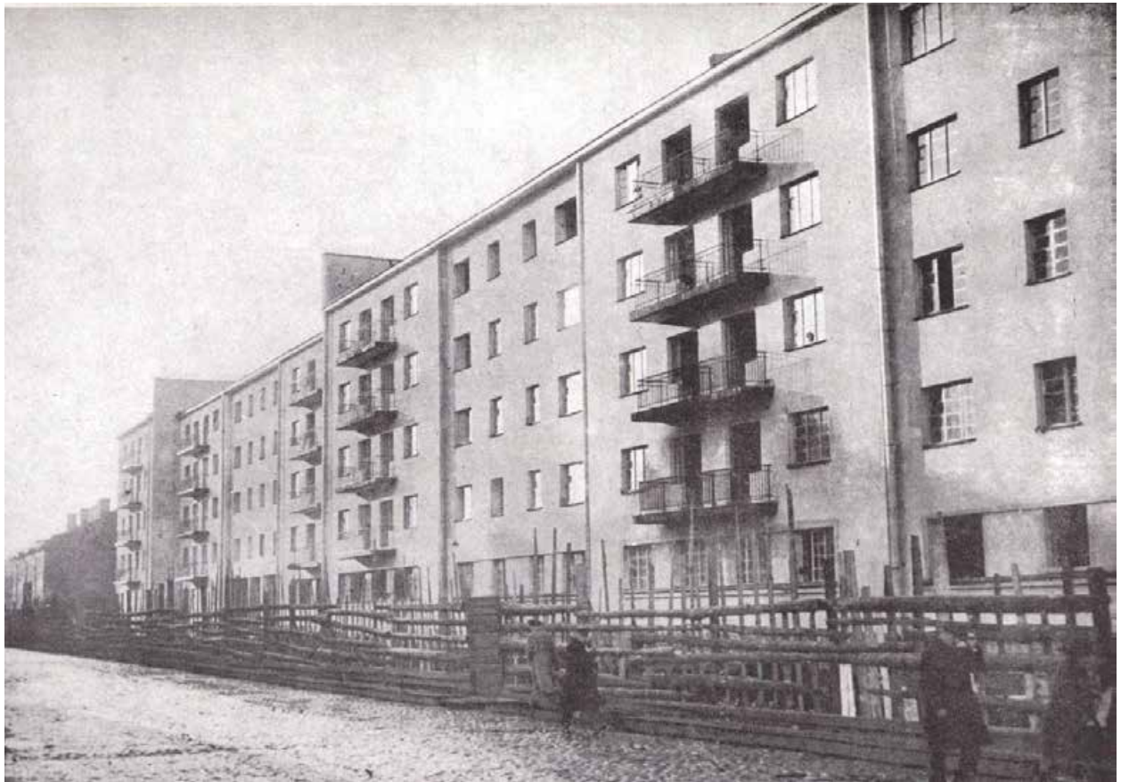
Илл.6. Комплекс зданий Бабуриного жилмассива по улице Смолячкова (корп.1). 1930 г. Источник – сайт www.citywalls.ru .
