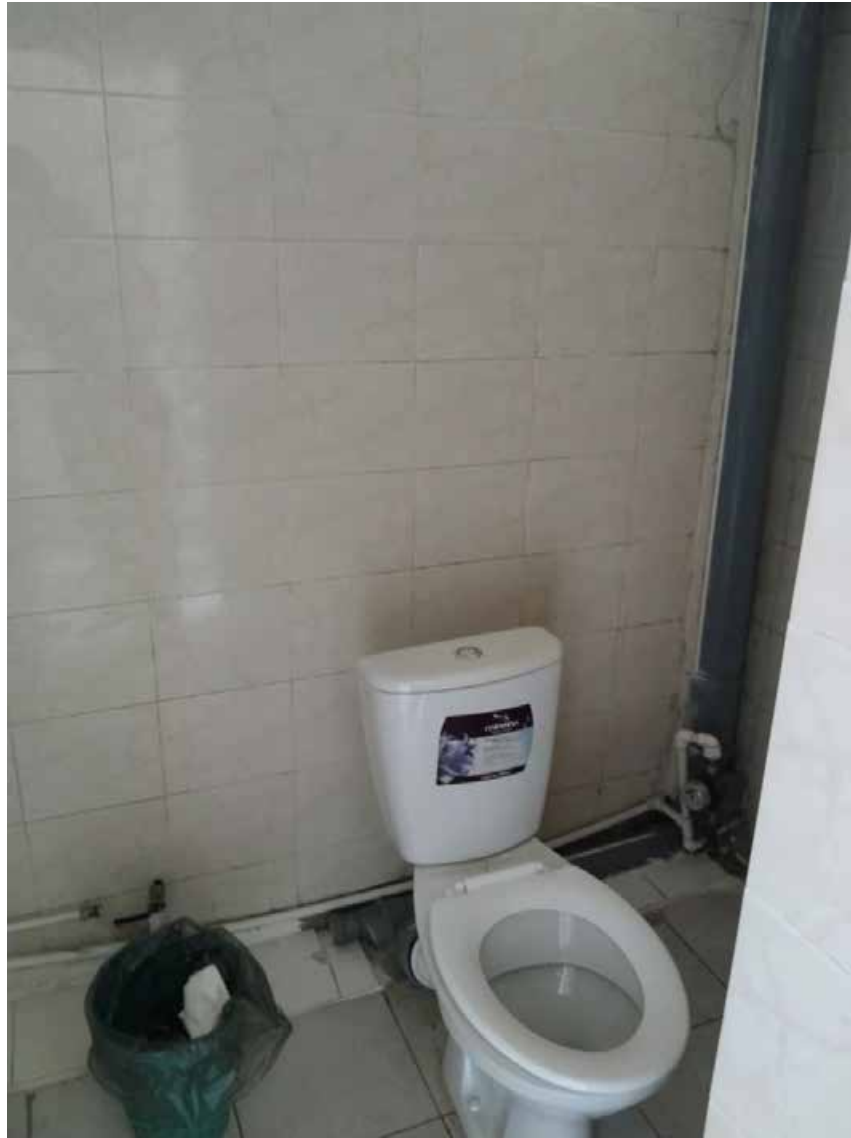
64. Вид в санузле помещения 8-Н (пом.27).
