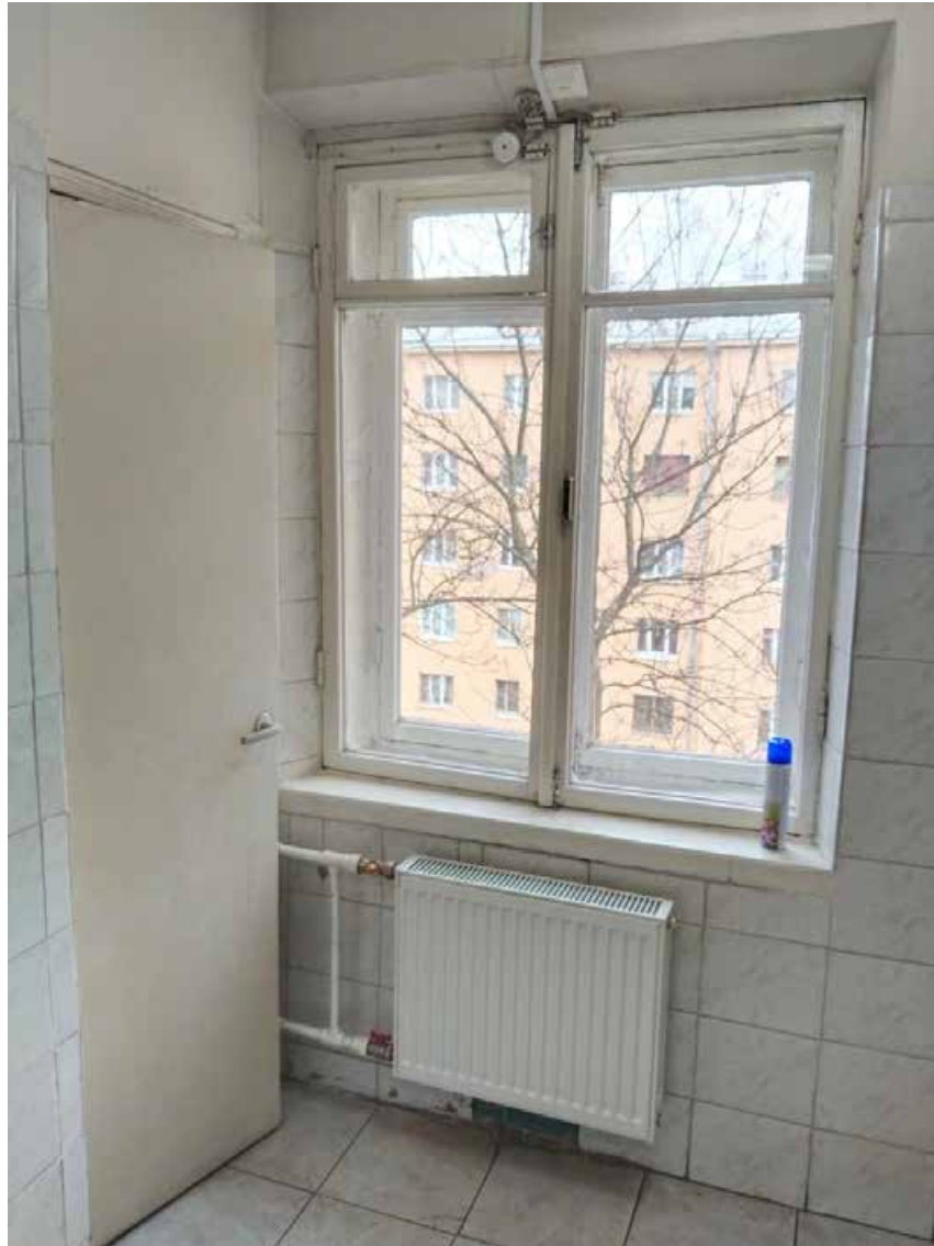
43. Вид в санузле помещения 8-Н (пом.19).
