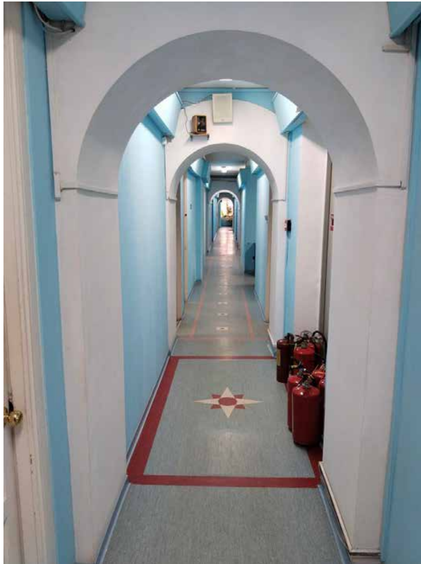
69. Вид в коридоре помещения 8-Н (пом.24).
