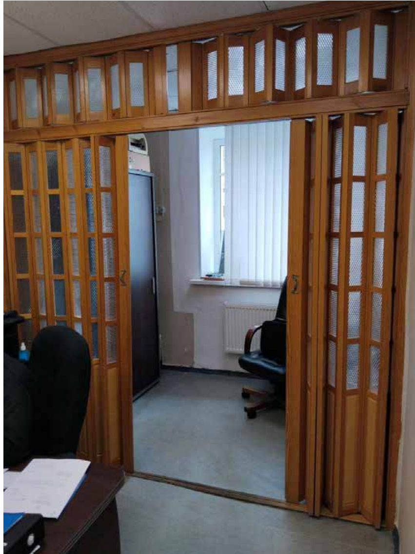
27. Вид в интерьере помещения 8-Н (пом.13).
