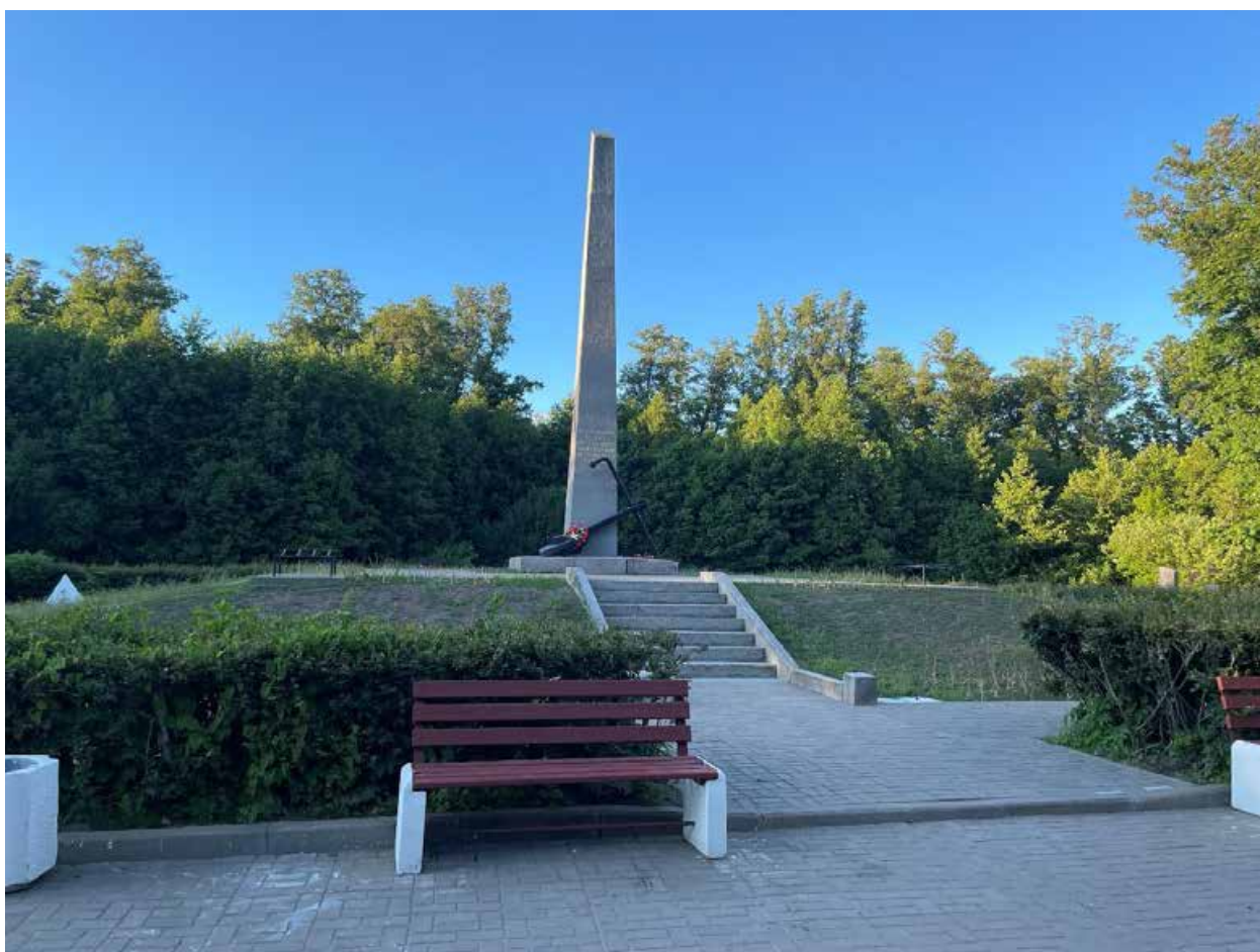
1. Вид с юго-запада на объект культурного наследия регионального значения «Братская могила жителей г. Кронштадта, погибших в годы Великой Отечественной войны 1941-1945 гг.», расположенного по адресу: Санкт-Петербург, г. Кронштадт, около Русского кладбища. 01.06.2024
