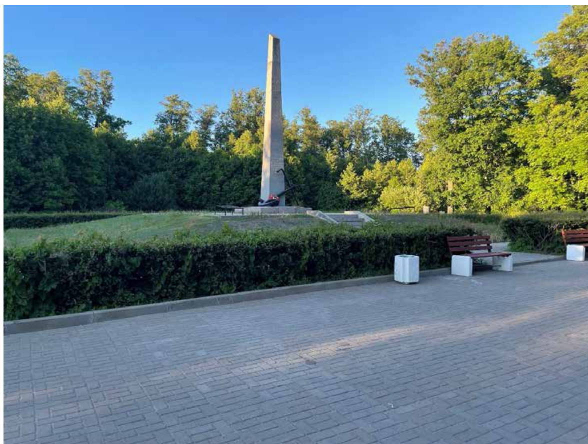
2. Вид с юго-запада на объект культурного наследия регионального значения «Братская могила жителей г. Кронштадта, погибших в годы Великой Отечественной войны 1941-1945 гг.», расположенного по адресу: Санкт-Петербург, г. Кронштадт, около Русского кладбища. 01.06.2024
