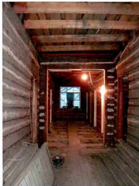
10.«Здание церковно-приходской школы и приюта церкви Апостола Петра». Второй этаж. Коридор.
