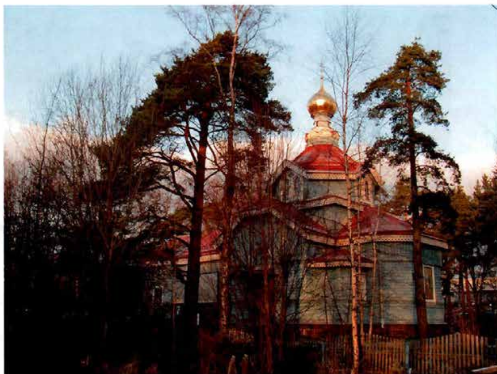
2. Церковь Апостола Петра. Общий вид с юго-востока.
