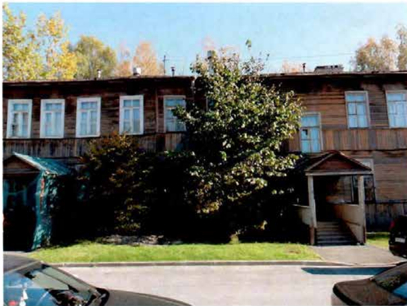
14. «Здание церковно-приходской школы и приюта церкви Апостола Петра». Западный фасад. Центральная часть здания.
