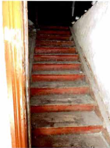
18. «Здание церковно-приходской школы и приюта церкви Апостола Петра». Лестница на чердак.
