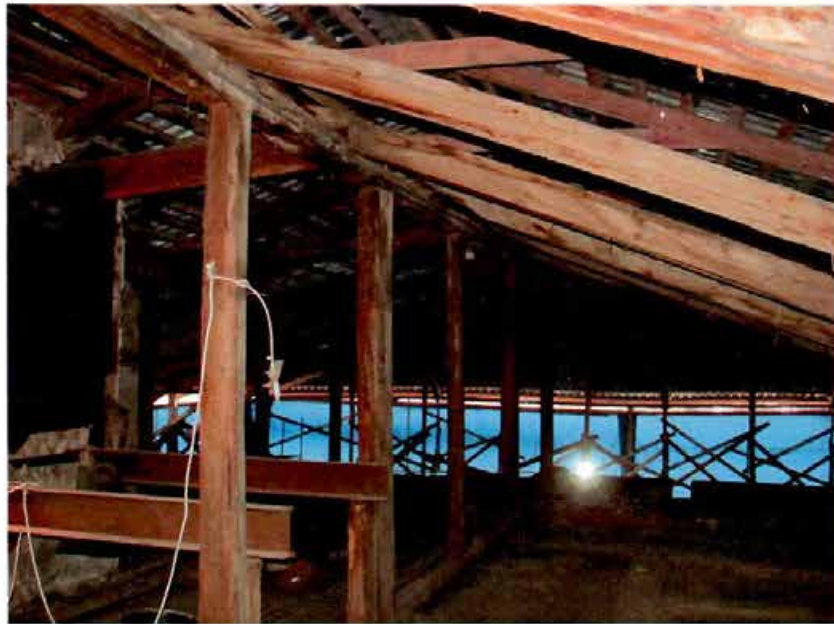
6. «Здание церковно-приходской школы и приюта церкви Апостола Петра». Чердак.
