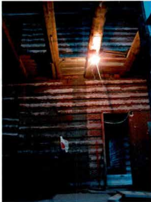
7.«Здание церковно-приходской школы и приюта церкви Апостола Петра». Перекрытия.
