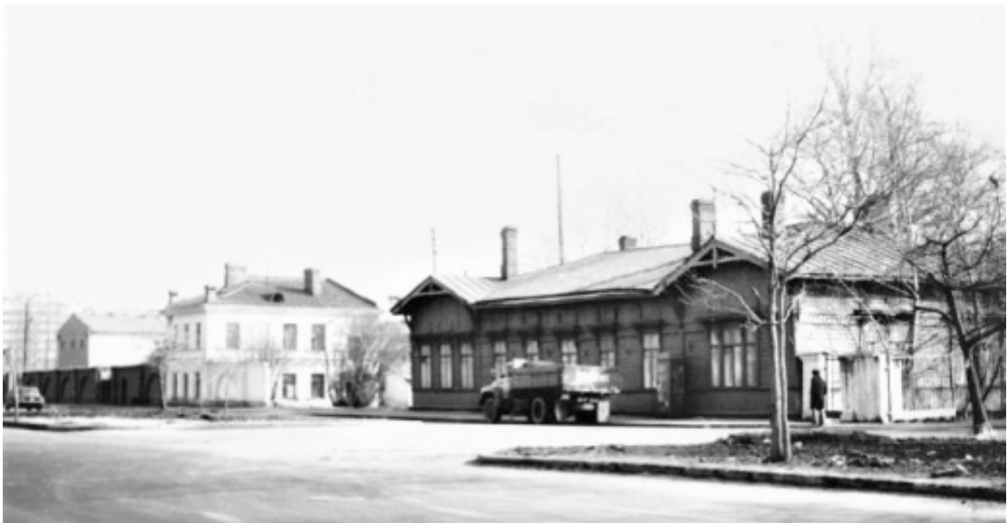
Илл.6. Перекресток улицы Тосина и Лиговского проспекта (дома №№ 238, 240, 242) Павильон товарной станции Московско-Виндаво-Рыбинской железной дороги (дом № 242). 1977г. Источник: ЦГАКФФД СПб. АР 212124
