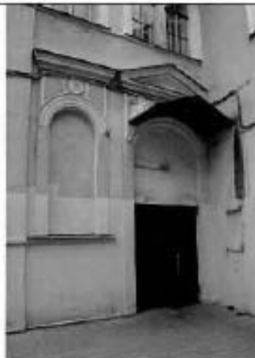
19. (Сформироване входа в здание в центральной части северного фасада)
