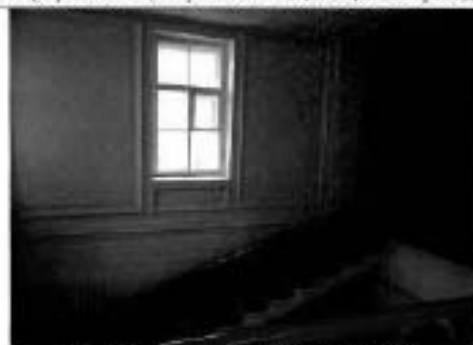
23. (Фрагмент параллельной лестницы)
