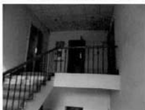
23. Лестничная клетка 4Н (36)
