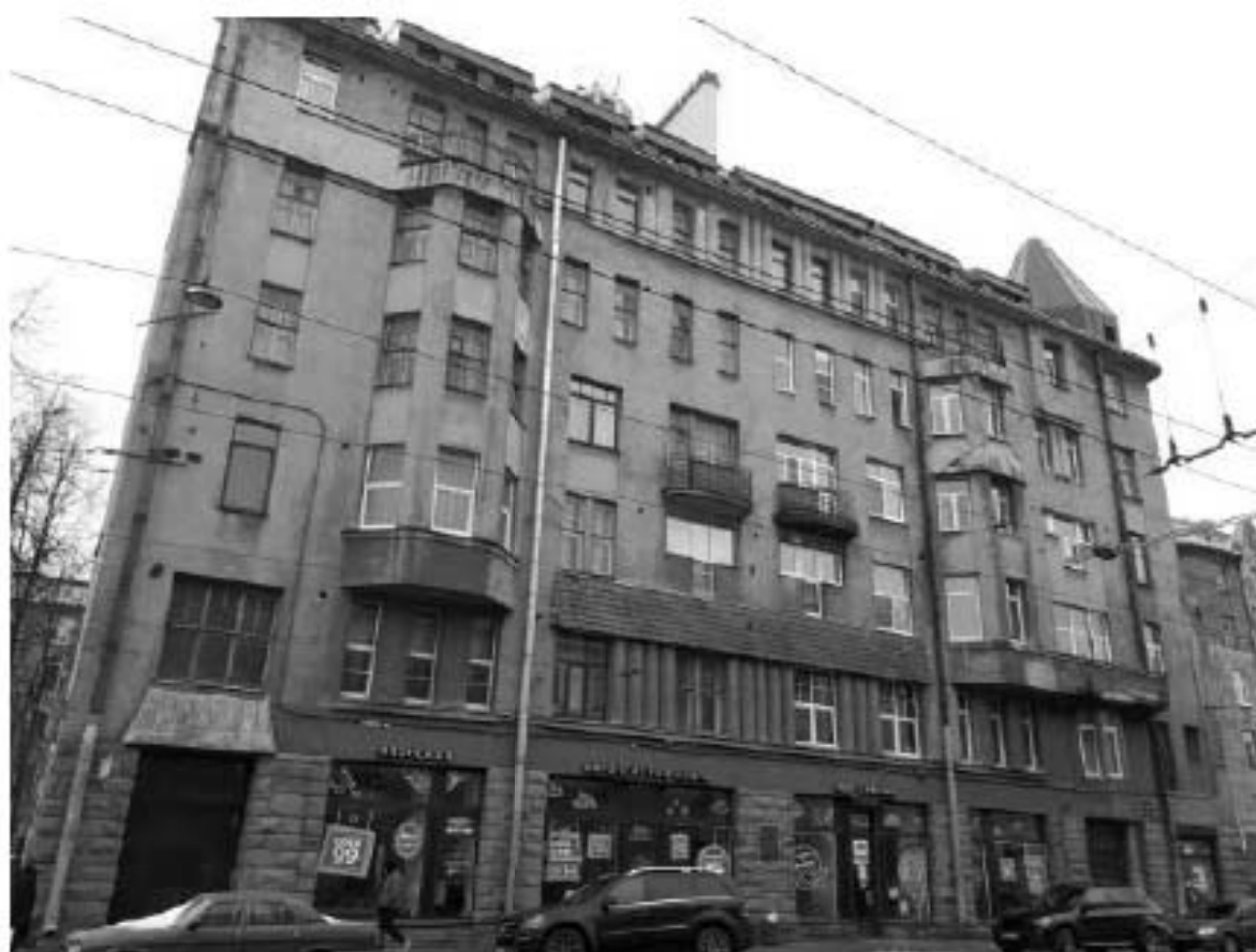
33. Доходный дом (в составе «Здания при Латвийской лютеранской церкви Христа Спасителя»). Загородный пр., д. 64, лит. А. Фото мест установки оборудования и кабельных трасс. Штиглиц М.С. 06.03.2022.
