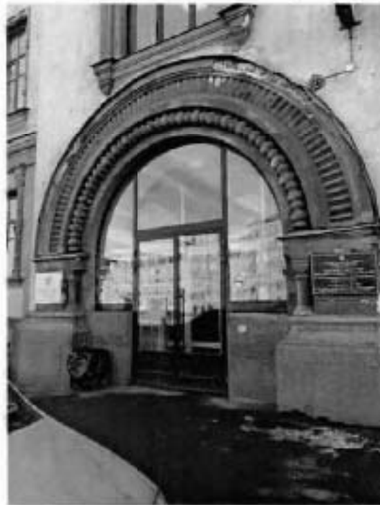
5. Фрагмент объекта культурного наследия с северной стороны. Дверя.
