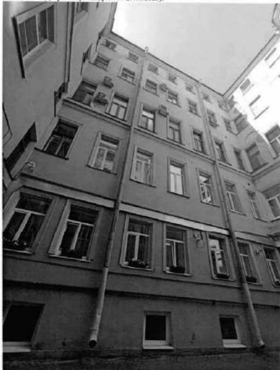
8. Здание 12. Дворовой фасад (фото от 27.06.2023).
