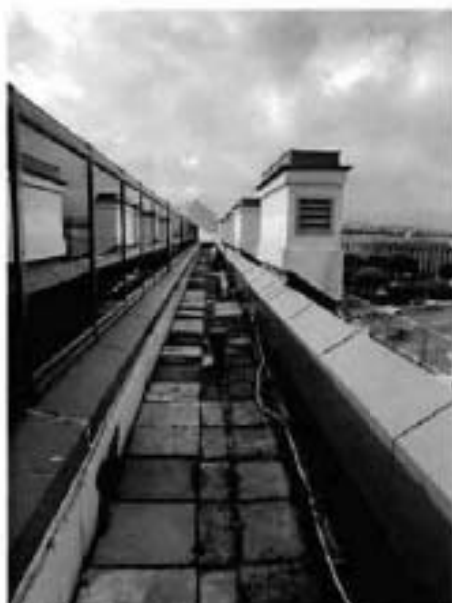
7. Фрагмент эксплуатируемой кровли объекта культурного наследия.
