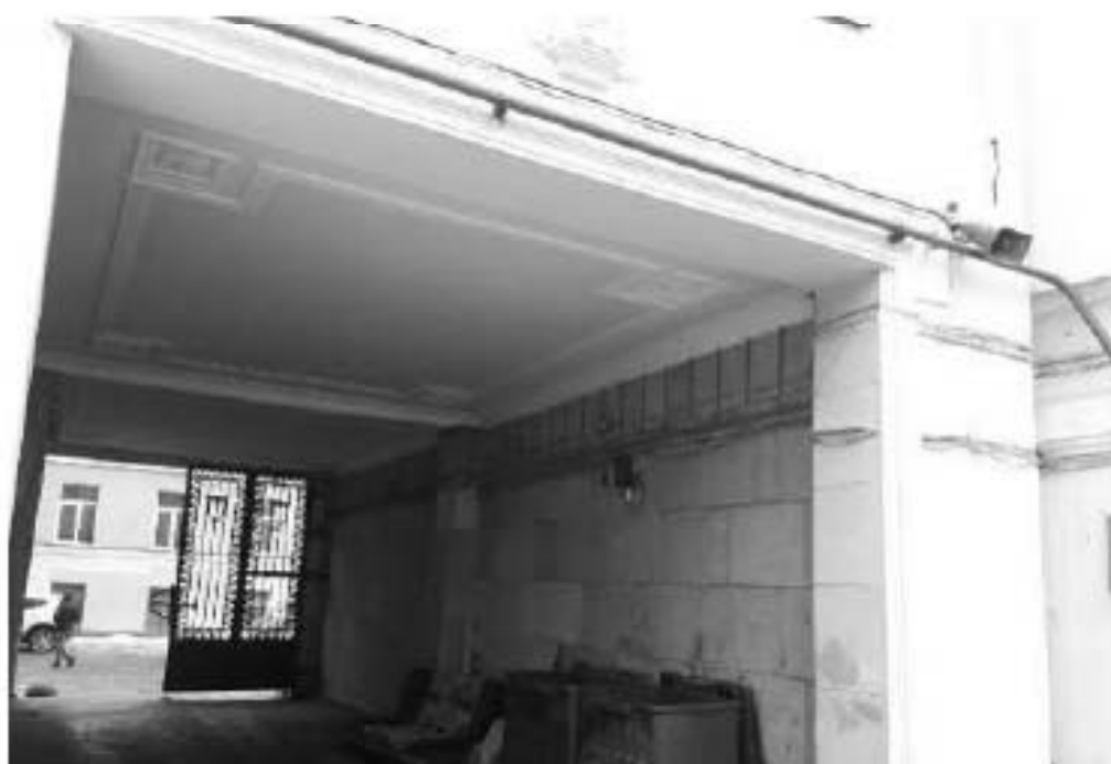
7. Дом Яковлевых (Евментьева А.Ф.). Гороховая ул., д. 57, лит. А. Воротный проезд. Фото мест установки оборудования и кабельных трасс. Штиглиц М.С. 06.03.2022.
