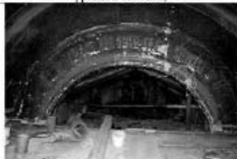
26. (Фрагмент интерьера в уровне чердака, помещения утраченной перемычки)
