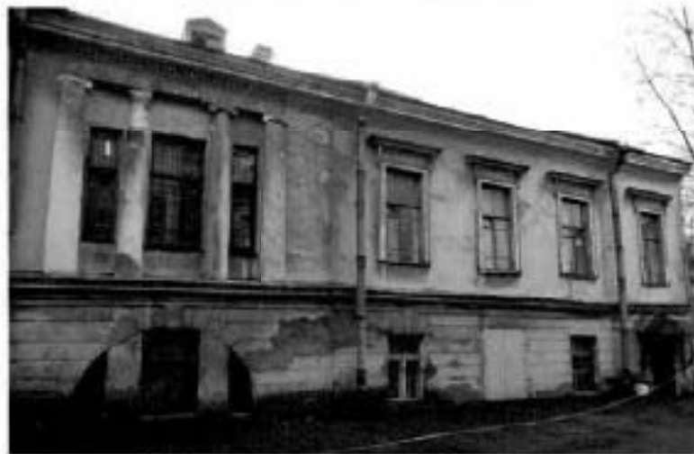
10. Фрагмент северного дворового фасада здания.
