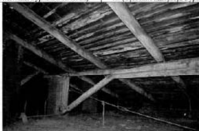
16. (Фрагмент чердачного помещения)
