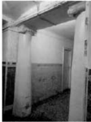
11. Фрагмент интерьера 1-го этажа здания.
