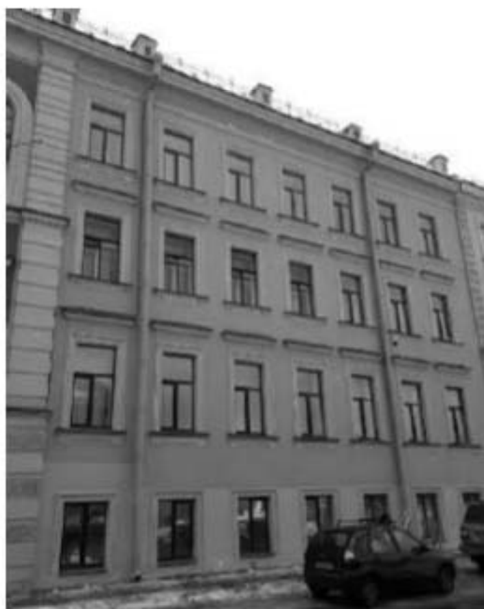
30. Демидовский дом призрения трудящихся. Мойки наб. реки, д. 108, лит. А. Фото мест установки оборудования и кабельных трасс. Штиглиц М.С. 06.03.2022.
