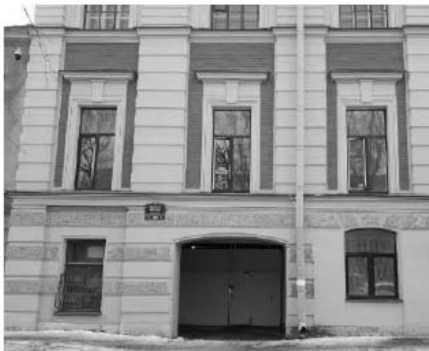
29. Демидовский дом призрения трудящихся. Мойки наб. реки, д. 108, лит. А. Фото мест установки оборудования и кабельных трасс. Штиглиц М.С. 06.03.2022.
