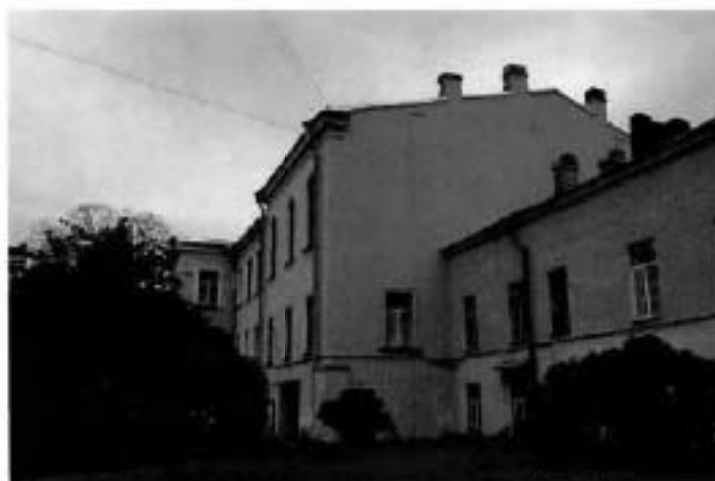
4. (Фрагмент юго-восточного дворового фасада)
