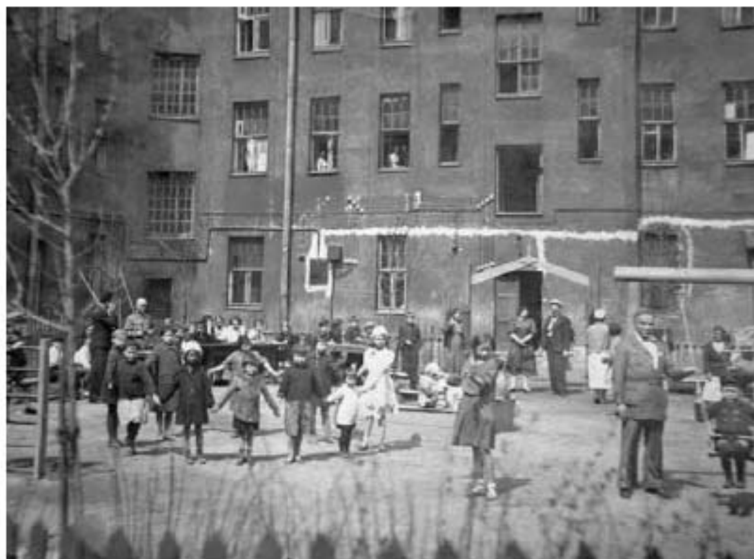
46. Доходный дом (в составе «Здания при Латышской лютеранской церкви Христа Спасителя»). Загородный пр., д. 64, лит. А. Вид со двора. Фото 1940 г. (24).
