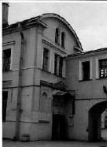
18. (Фрагмент центральной части северного фасада)
