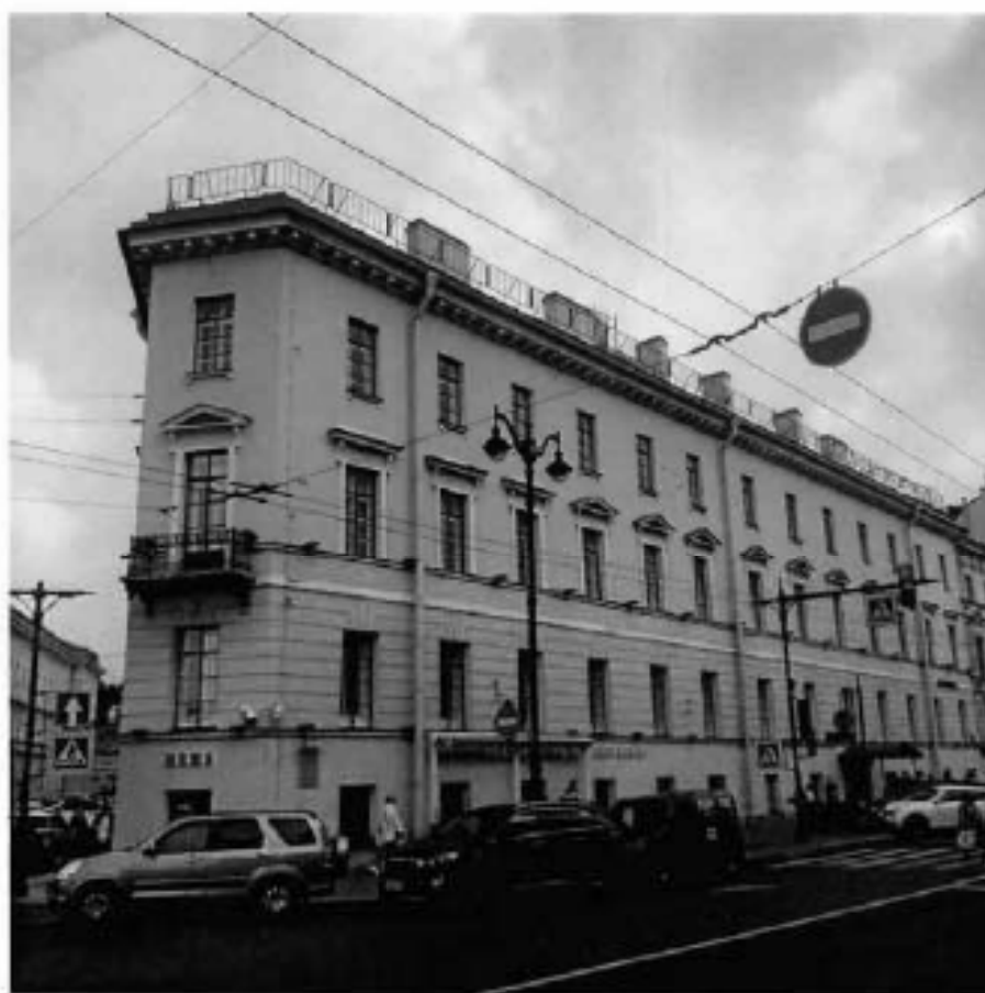
1. Общий вид объекта культурного наследия.
