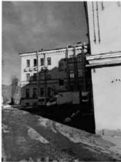
6. Фрагмент объекта культурного наследия с юго-западной стороны.
