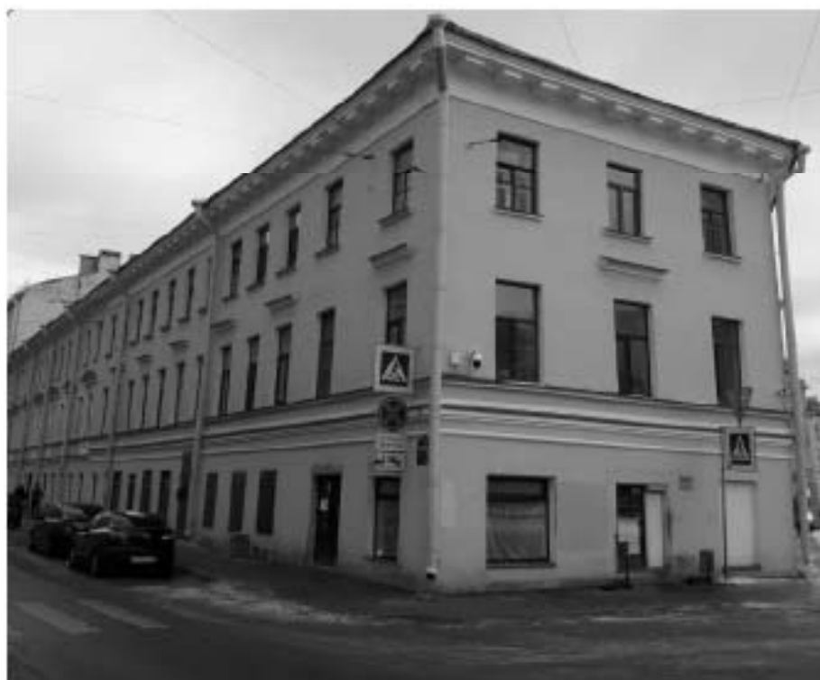
11. Дом Сутугиных. Грибоедова канала наб., д. 106, лит. А. Лицевой фасад. Фото мест установки оборудования и кабельных трасс. Штиглиц М.С. 06.03.2022.
