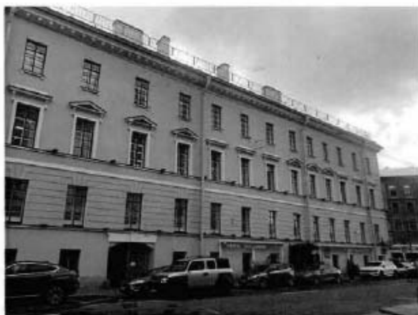
3. Фрагмент западного фасада объекта культурного наследия.
