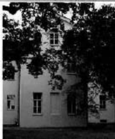
21. (Фрагмент центральной части восточного фасада)
