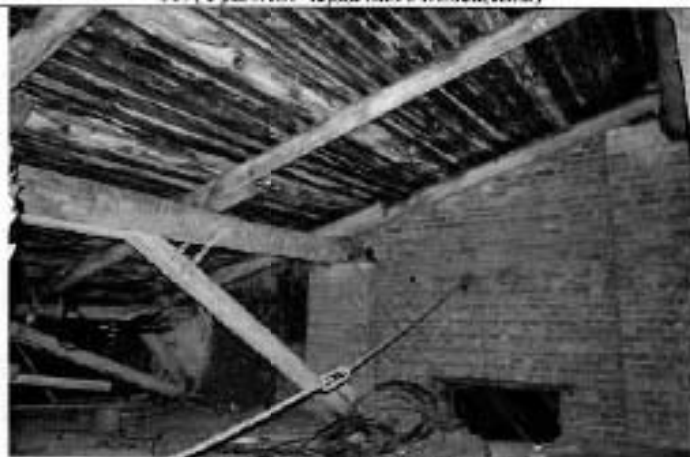
17. (Фрагмент чердачного помещения)
