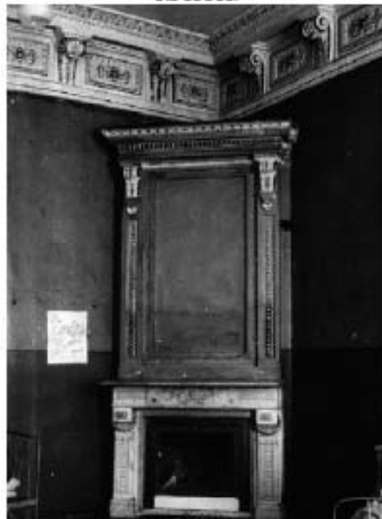
68. Главный корпус. Камин в золотой гостиной. Фото 1978. Архив КГИОП.
