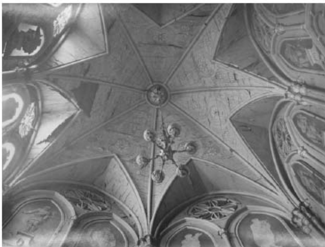
49. Притвор домової церкви. Вид плафона. Фото к. 1930-х гг. Архив КГИОП.
