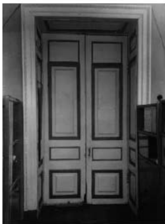
71. Дверь в золотую гостиную. Фото 1995. Архив КГИОП.
