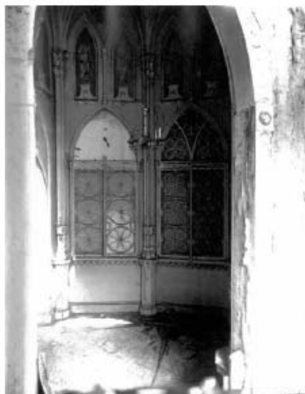
47. Бывшая домовая церковь. Притвор. Фотография 1930 г. Архив КГИОП.
