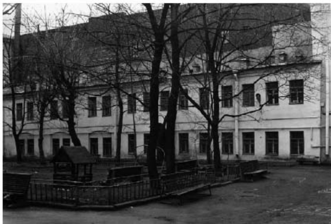
59. Южный фасад северный флигелей 2-й хоз. двор 1895. Фото 1995. Архив КГИОП.
