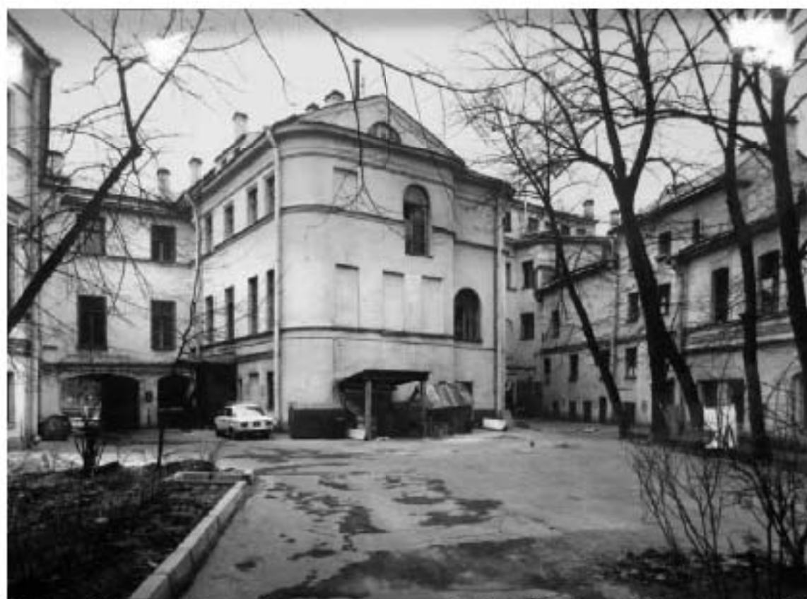
54.1-й хозяйственный двор. Вид в направлении Ю-В – С-З. Фото 1978 г. Архив КГИОП.
