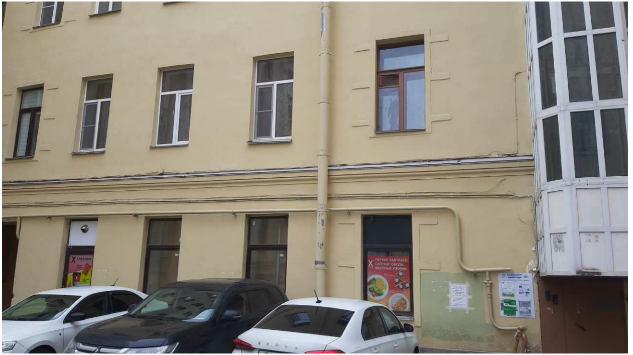
29. Дом В.Н. Зеленина (Лесной пр., д. 3, лит. А). Вид со двора. Фото мест установки оборудования и кабельных трасс. Штиглиц М.С. 18.04.2024.
