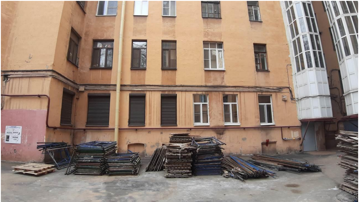
21. Дом М.Е. Румшишского. Вид со двора. Фото мест установки оборудования и кабельных трасс. (Академика Лебедева ул., д. 14/2, лит. А). Штиглиц М.С. 18.04.2024.
