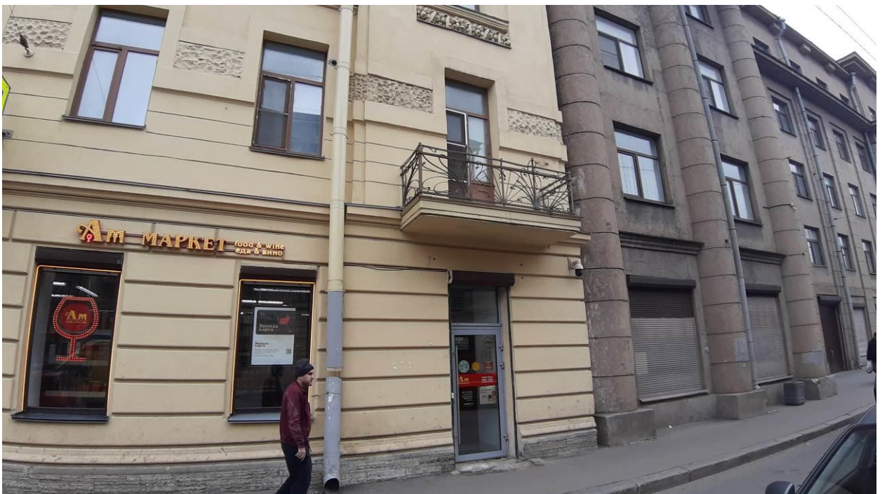
34. Дом В.Н. Зеленина (Лесной пр., д. 3, лит. А). Фрагмент лицевого фасада. Фото мест установки оборудования и кабельных трасс. Штиглиц М.С. 18.04.2024.
