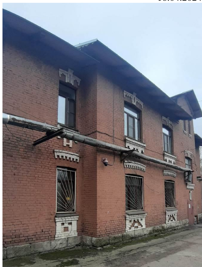
38. Комплекс построек железнодорожной станции «Кушелевка» (4 здания)» (Политехническая ул., д. 1, корп. 3, лит. Б). Северный фасад. Фрагмент лицевого фасада. Фото мест установки оборудования и кабельных трасс. Штиглиц М.С. 18.04.2024.
