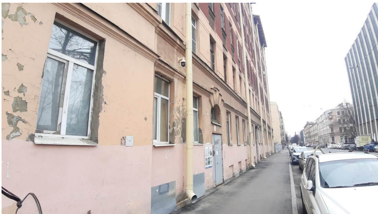
19. Дом М.Е. Румшишского (Академика Лебедева ул., д. 14/2, лит. А). Фрагмент лицевого фасада. Фото мест установки оборудования и кабельных трасс. Штиглиц М.С. 18.04.2024.
