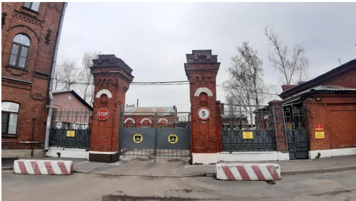
13. Караульная с оградой. Фото мест установки оборудования и кабельных трасс. (Академика Лебедева ул., д. 18, лит. А). Штиглиц М.С. 18.04.2024.
