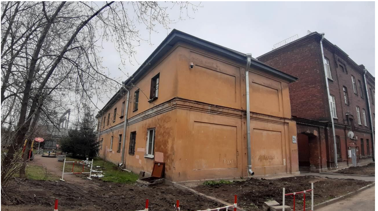
10. Казармы со службой. Фото мест установки оборудования и кабельных трасс. (Академика Лебедева ул., д. 20а, лит. Б). Штиглиц М.С. 18.04.2024.
