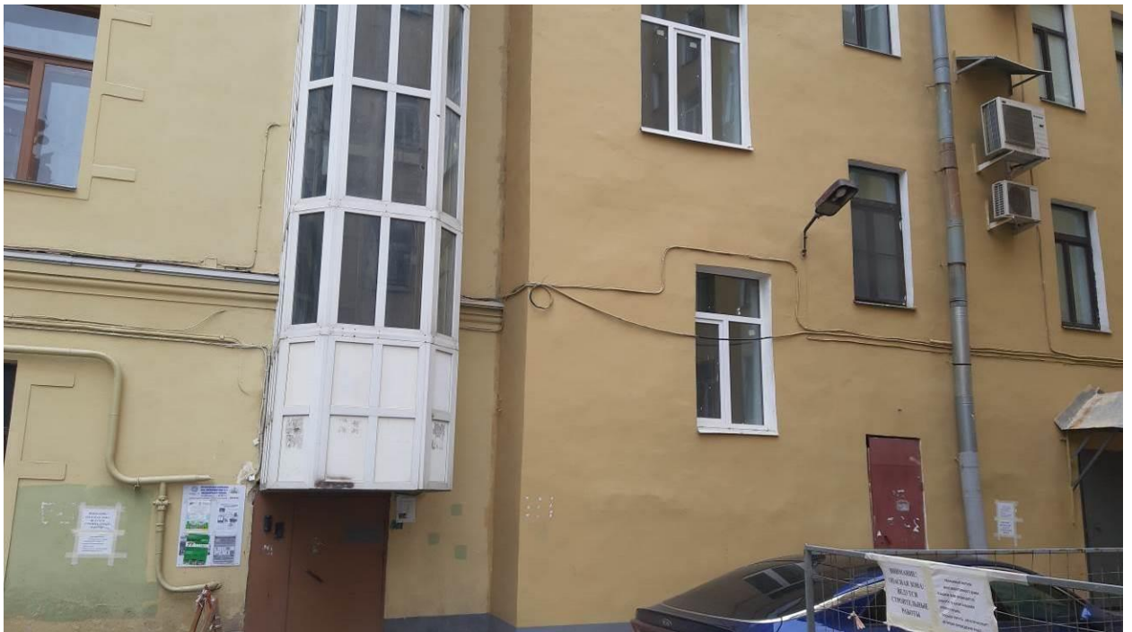
30. Дом В.Н. Зеленина (Лесной пр., д. 3, лит. А). Вид со двора. Фото мест установки оборудования и кабельных трасс. Штиглиц М.С. 18.04.2024.
