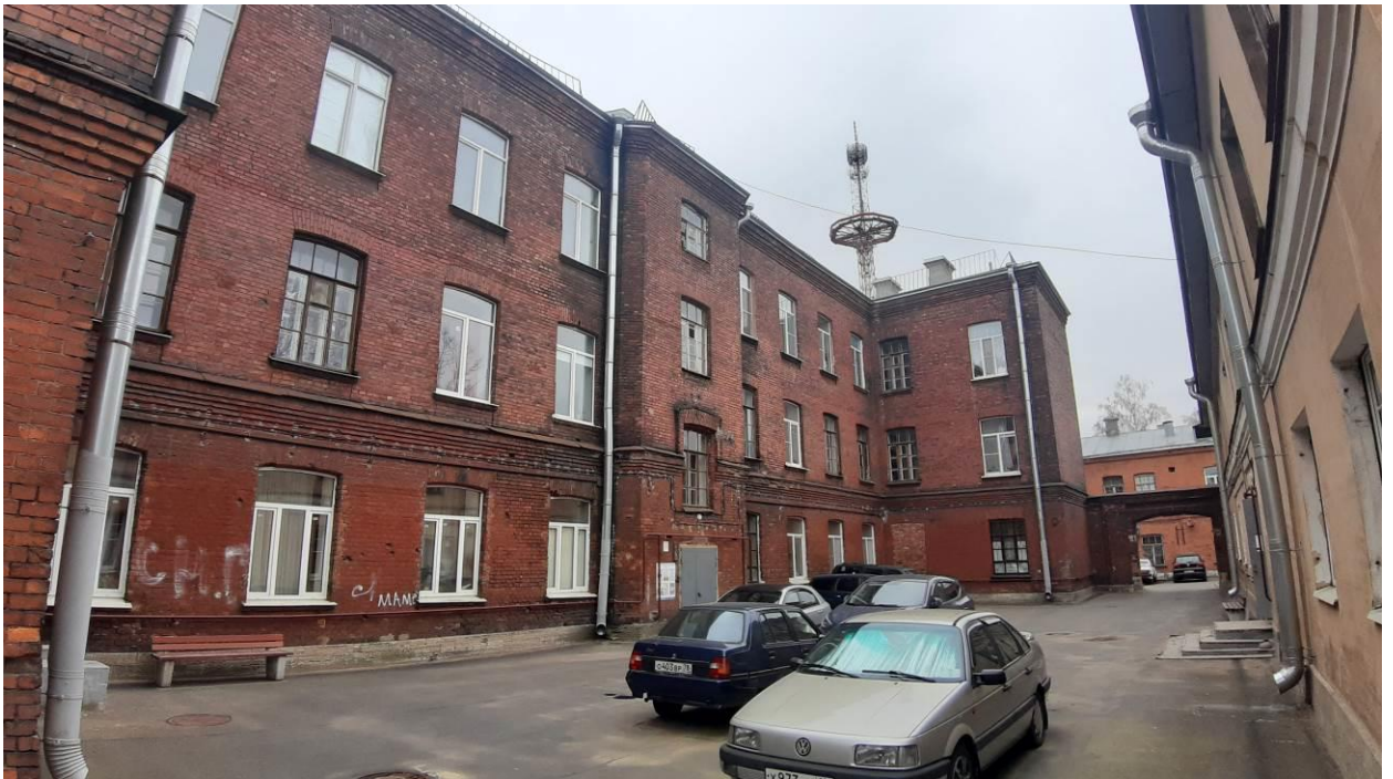
4. Казармы со службой (Академика Лебедева ул., д. 20, лит. А). Дворовый фасад. Фото мест установки оборудования и кабельных трасс. Штиглиц М.С. 18.04.2024.
