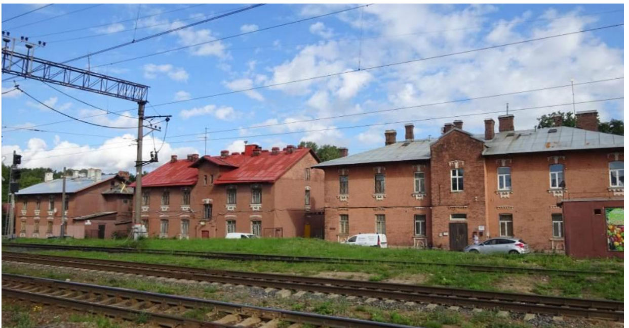
27. Комплекс построек железнодорожной станции «Кушелевка» (4 здания)». Фото 2020 г. (25)
