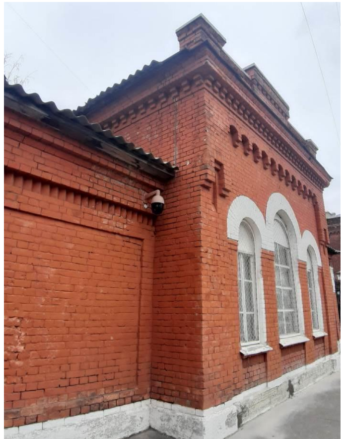
12. Караульная с оградой. Фото мест установки оборудования и кабельных трасс. (Академика Лебедева ул., д. 18, лит. А). Штиглиц М.С. 18.04.2024.
