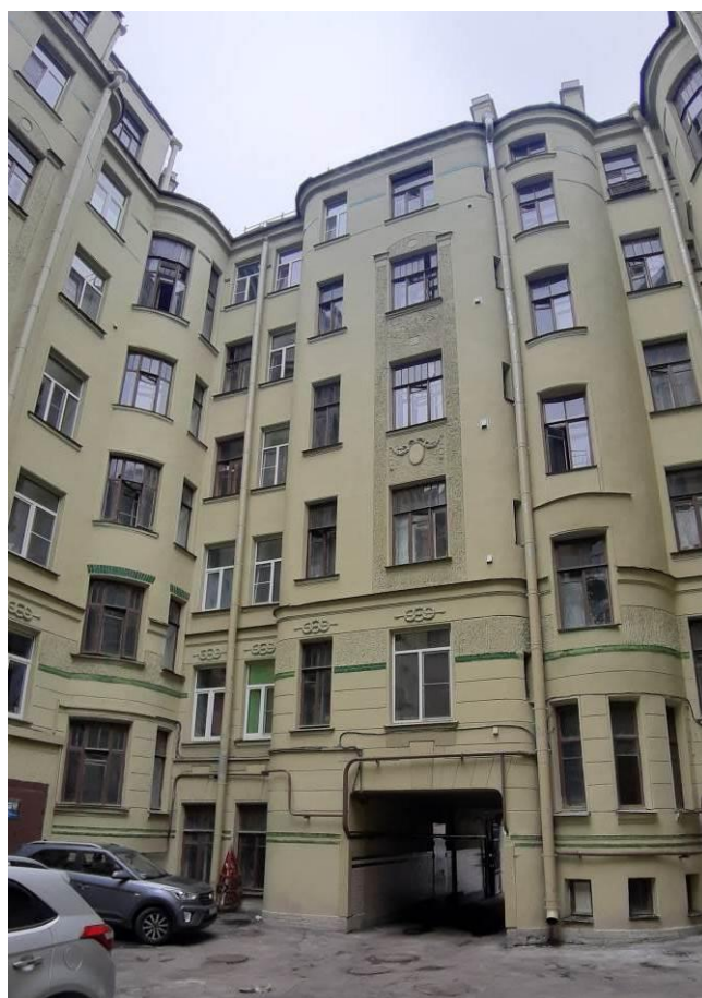
26. Доходный дом Российского общества страхования капиталов и доходов «Жизнь». (Академика Лебедева ул., д.12, лит. А). Вид со двора. Фото мест установки оборудования и кабельных трасс. Штиглиц М.С. 18.04.2024.
