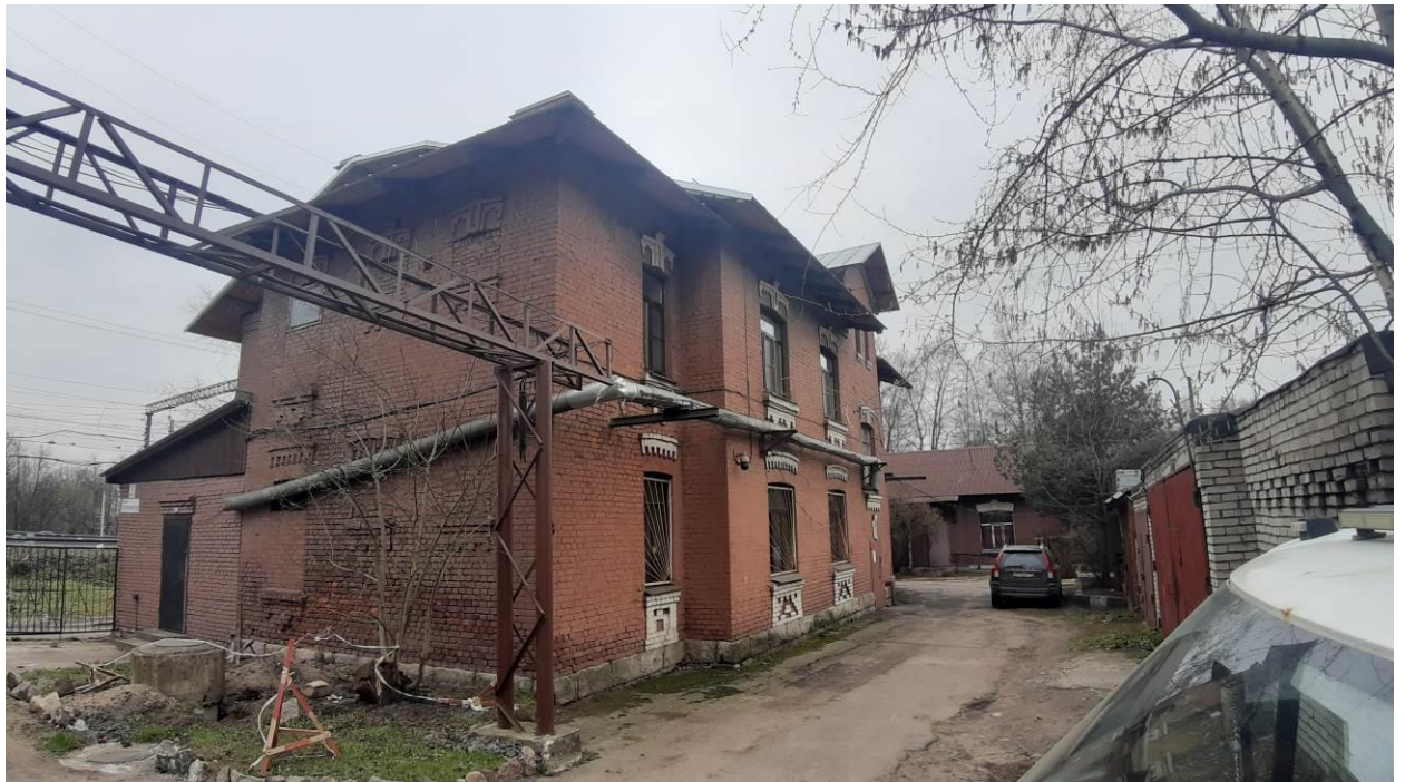
36. Комплекс построек железнодорожной станции «Кушелевка» (4 здания)» (Политехническая ул., д. 1, корп. 3, лит. Б). Общий вид. Штиглиц М.С. 18.04.2024.
