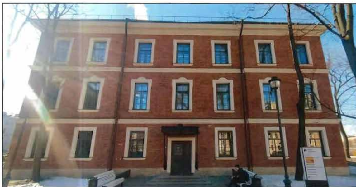
1. Северный фасад объекта культурного наследия.
