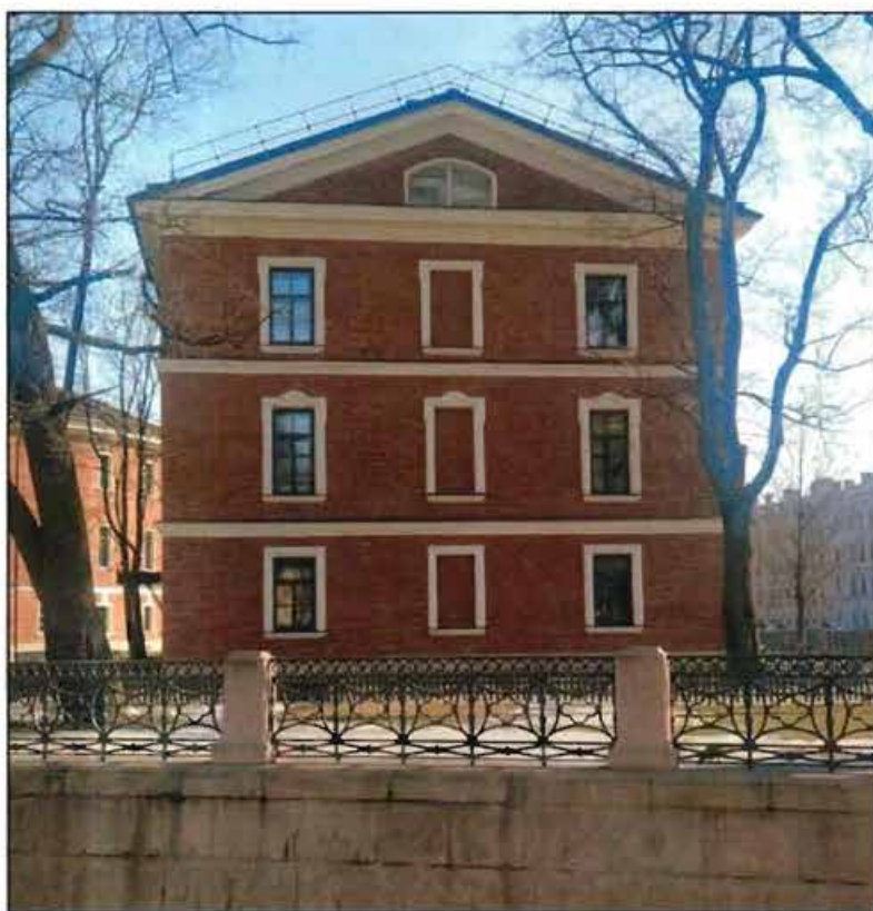
4. Западный фасад объекта культурного наследия.
