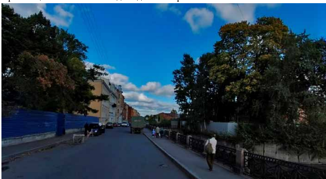
Илл. 44. Тротуар набережной Адмиралтейского канала от 1-го моста Круштейна до Храповицкого моста. 2009 год. Яндекс.Панорамы.
