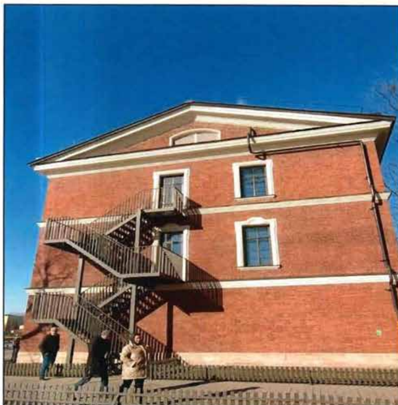
3. Восточный фасад объекта культурного наследия
