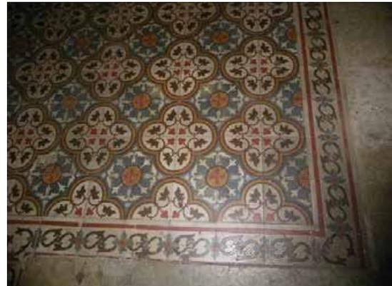
покрытие пола вестибюля лестницы поперечного дворового корпуса 9-ЛК – двуцветная метлахская плитка геометрического рисунка с бордюром;
