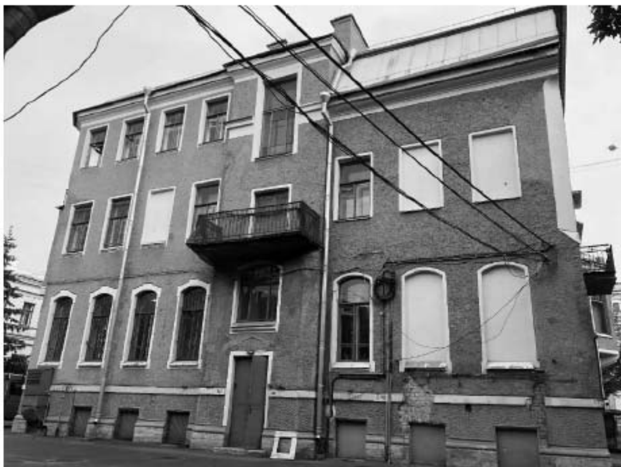
Фото 9. Вид на северный фасад.
