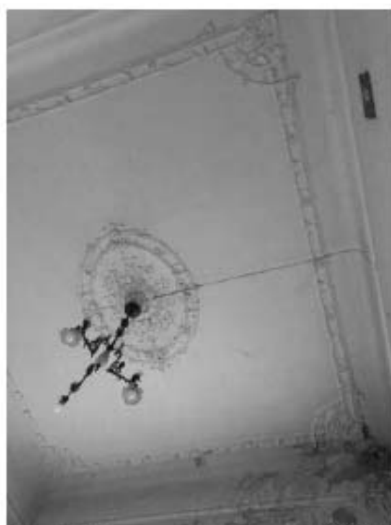
Фото 31. Потолок в помещении 3-Н (25).
