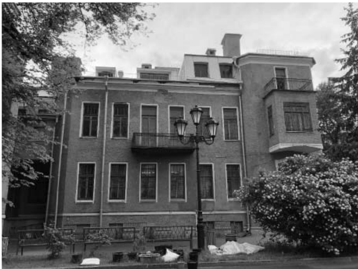
Фото 11. Вид на восточный фасад.
