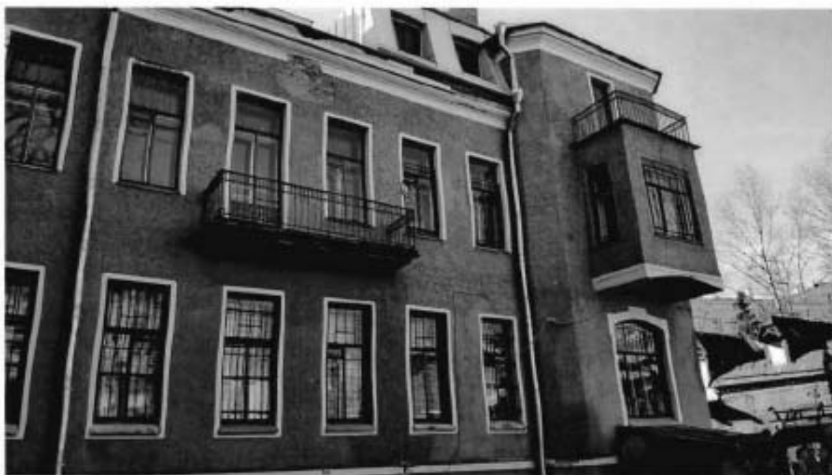
9. Восточный фасад объекта культурного наследия
