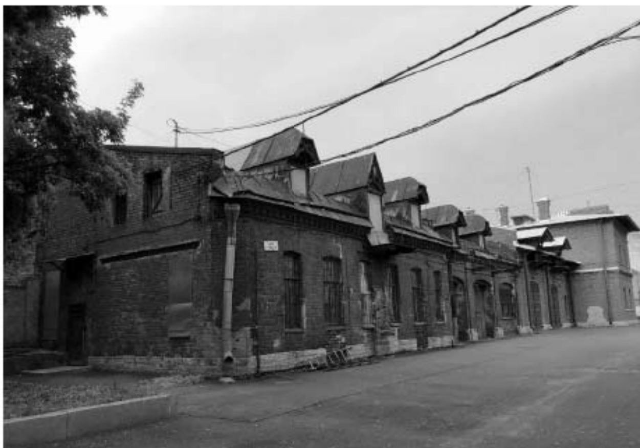
Фото 14. Вид на служебный корпус.
