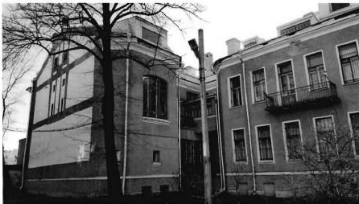
8. Восточный фасад объекта культурного наследия
