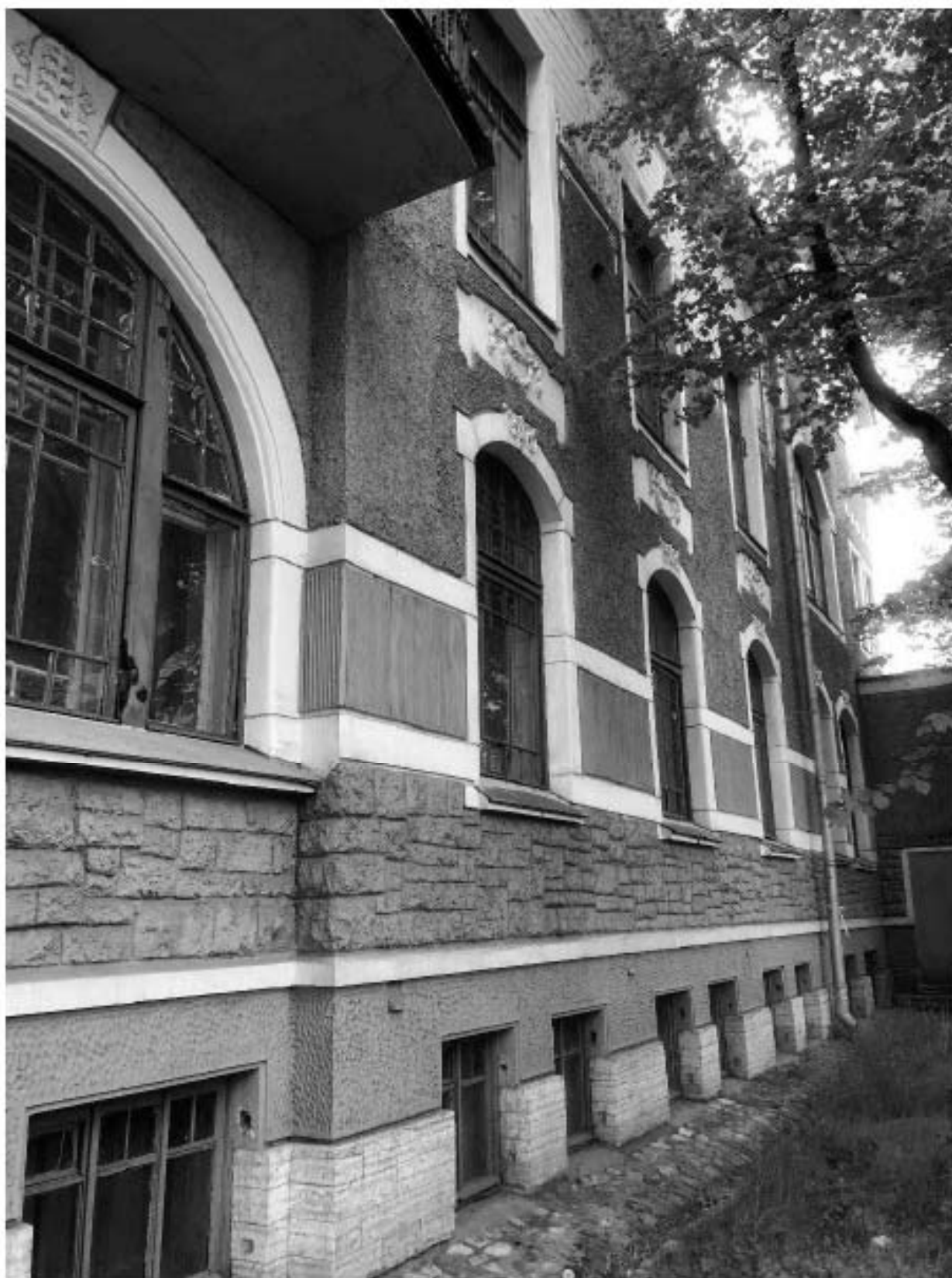
Фото 6. Вид на лицевой фасад.
