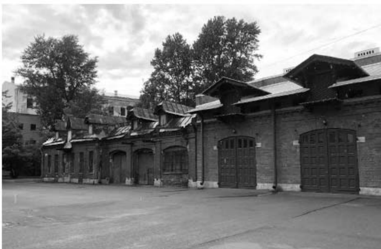
Фото 15. Вид на служебный корпус.
