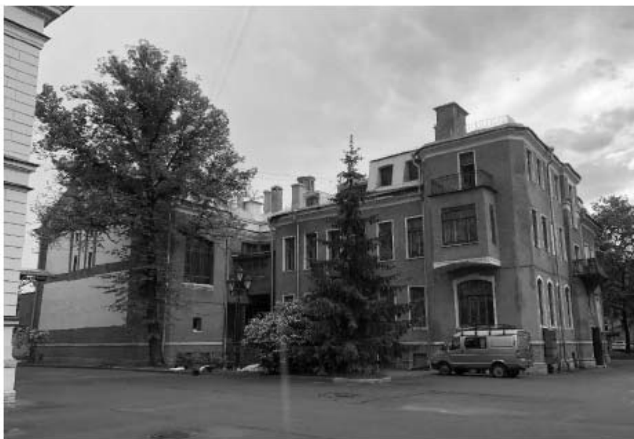
Фото 10. Вид на восточный фасад.
