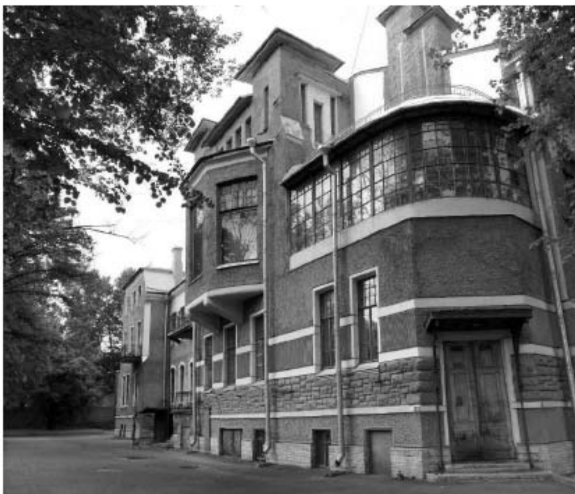
Фото 7. Вид на западный фасад.
