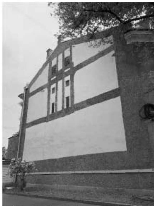
Фото 13. Торцевой восточный фасад.
