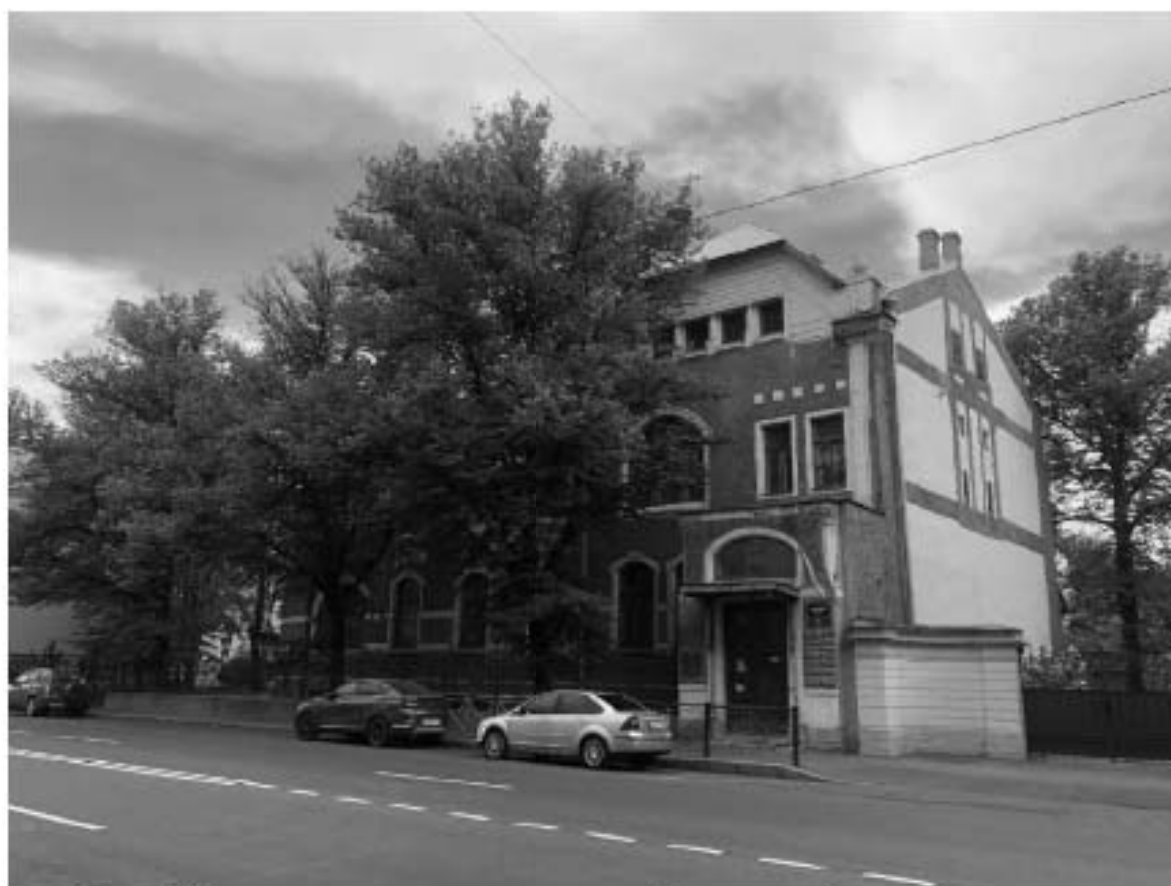
Фото 2. Вид на угол лицевого и торцевого фасадов по Рижскому проспекту.
