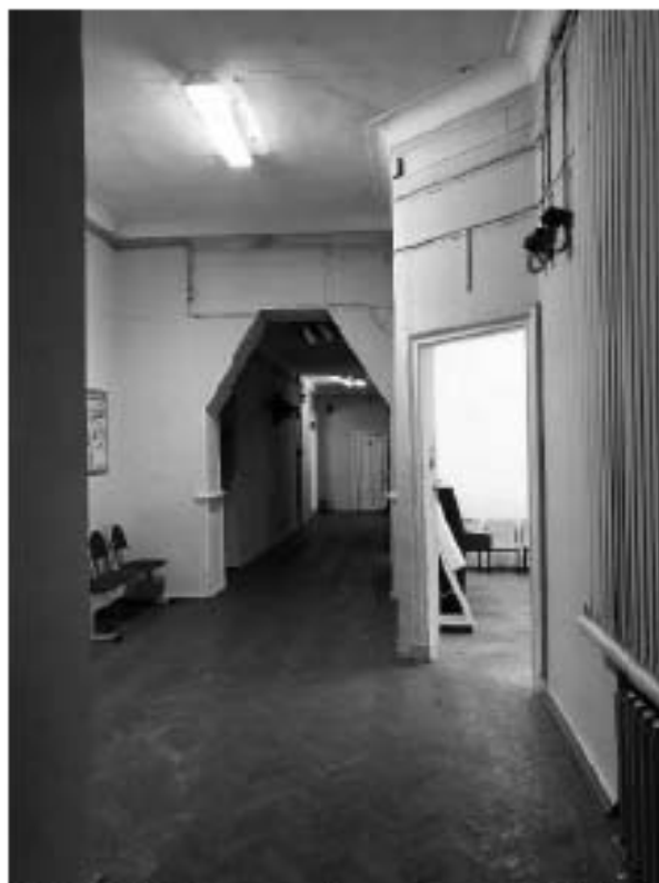
Фото 14. Коридор (помещение 2-Н (1)).
