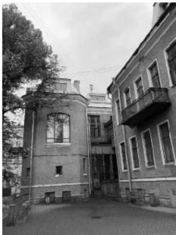
Фото 12. Вид на часть северного фасада в восточной части.
