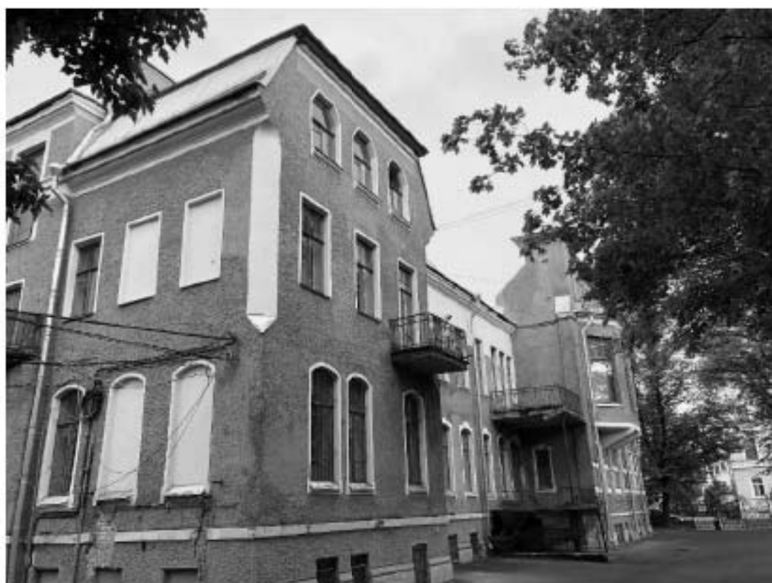
Фото 8. Вид на западный фасад.
