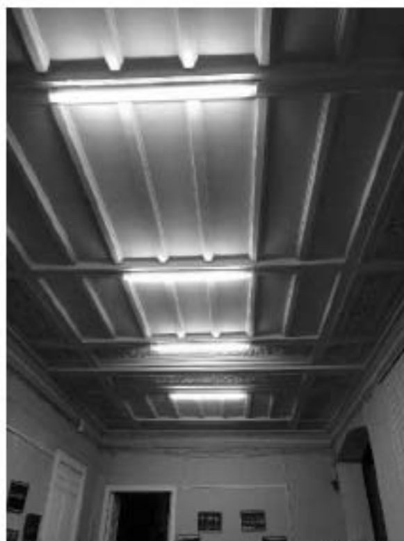
Фото 5. Потолок в помещении 2-Н (1).
