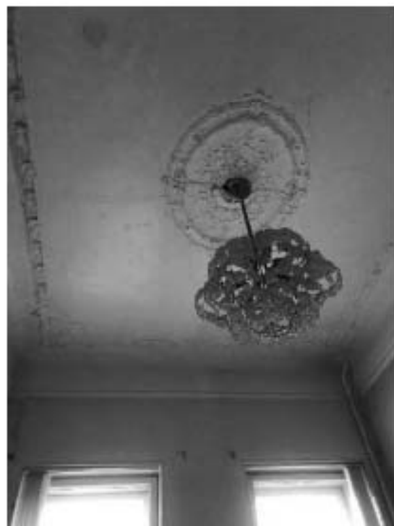
Фото 24. Потолок в помещении 3-Н (9).
