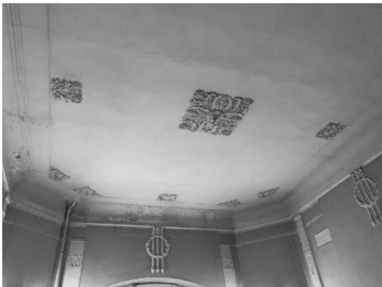
Фото 47. Потолок в помещении парадной лестницы.
