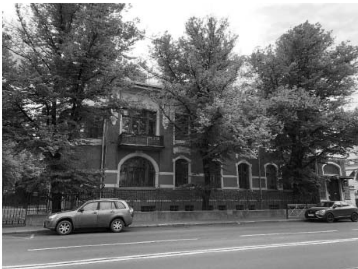
Фото 1. Вид на лицевой фасад по Рижскому проспекту.
