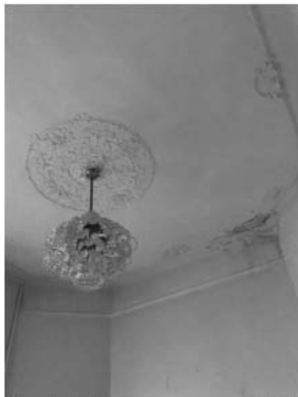
Фото 27. Потолок в помещении 3-Н (11).
