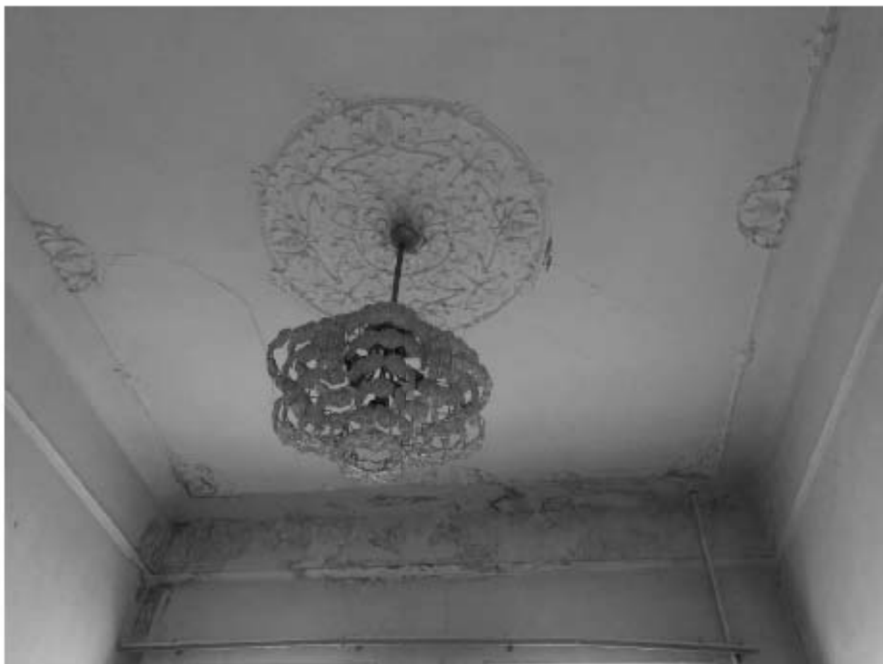
Фото 25. Потолок в помещении 3-Н (10).
