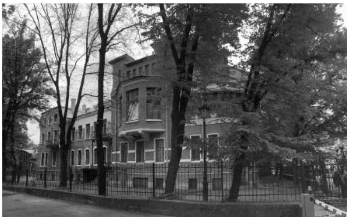
Фото 5. Вид на западный фасад.
