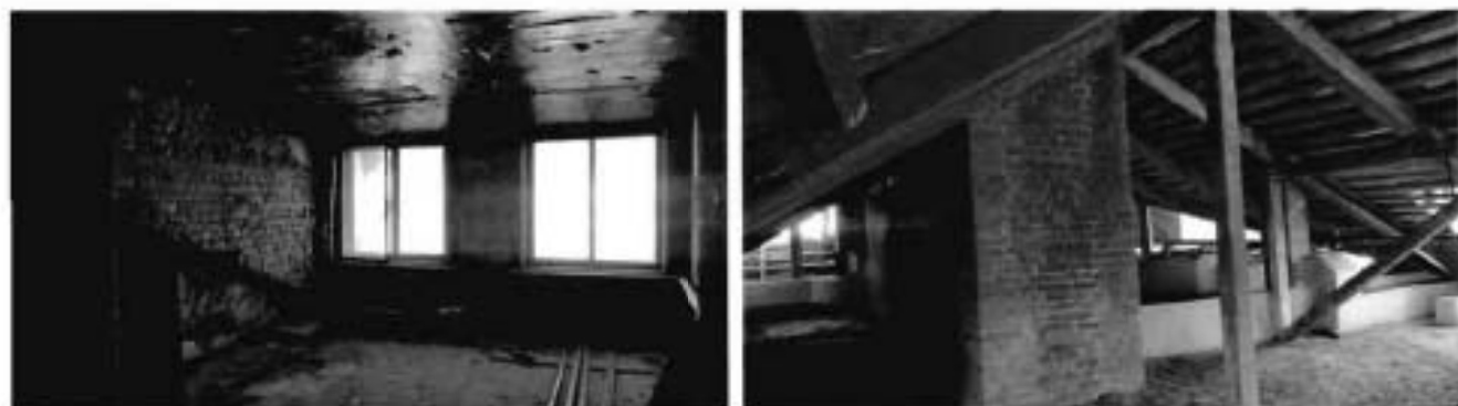
72, 73, 74, 75. Чердак объекта культурного наследия
