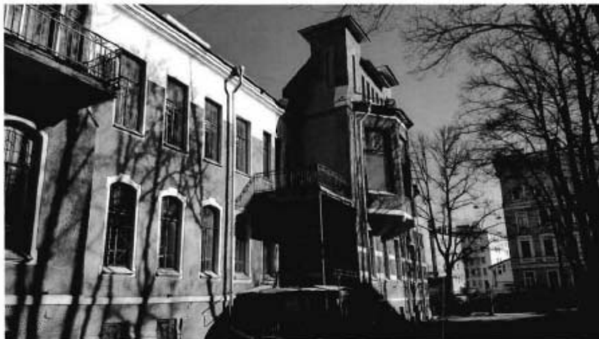
5. Западный фасад объекта культурного наследия
