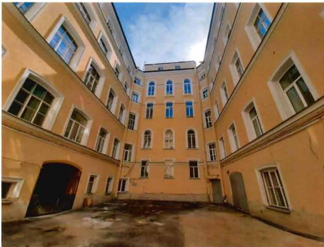
6. Общий вид на дворовые фасады объекта культурного наследия, южный двор (20.05.2022)
