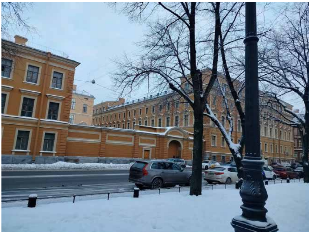
Фото 3. Лицевой фасад объекта культурного наследия федерального значения «Корпус для прислуги», входящего в состав объекта культурного наследия федерального значения «Дворец Великого князя Николая Николаевича (Ксенинский институт)» (со стороны Конногвардейского бульвара)
