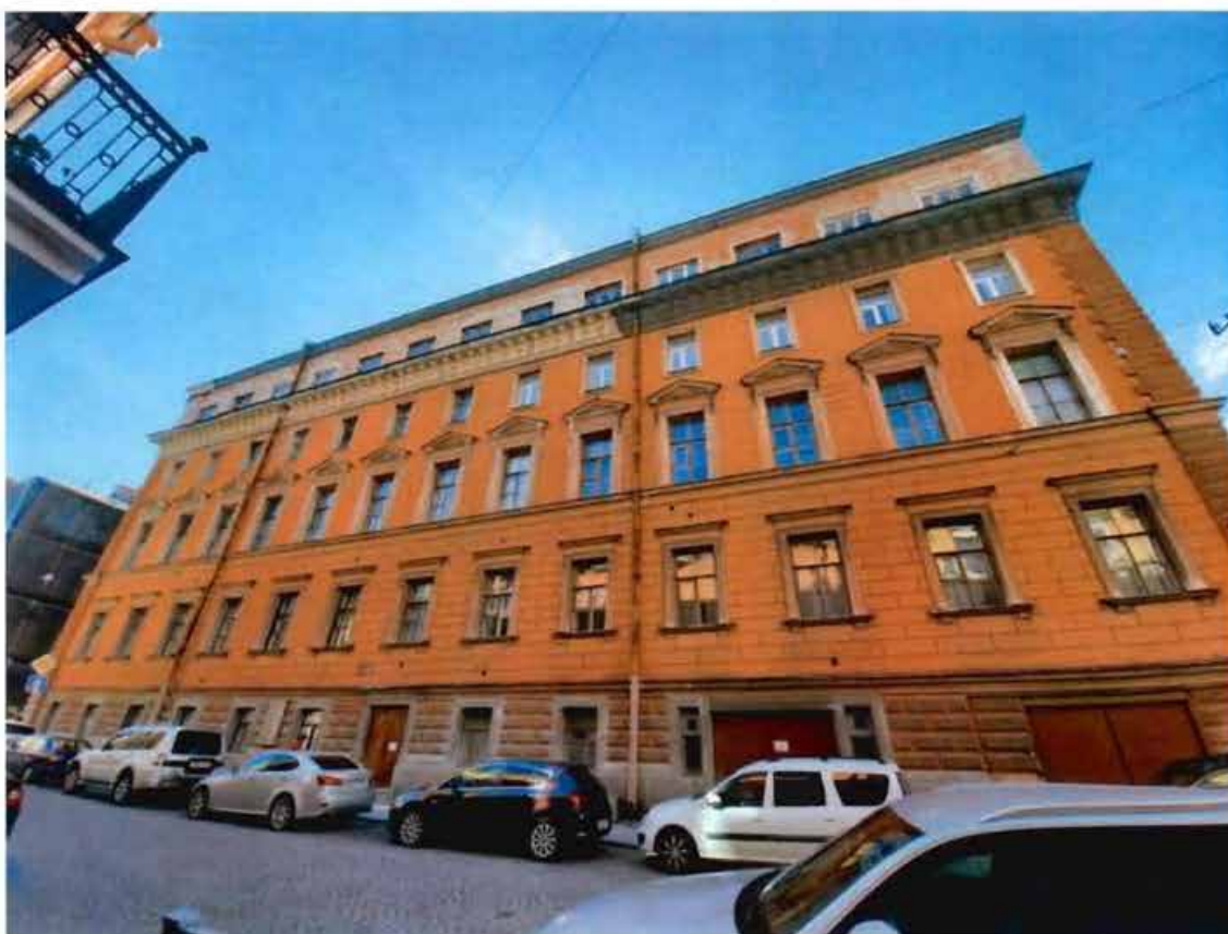
3. Общий вид на северо-западный фасад объекта культурного наследия (20.05.2022)
