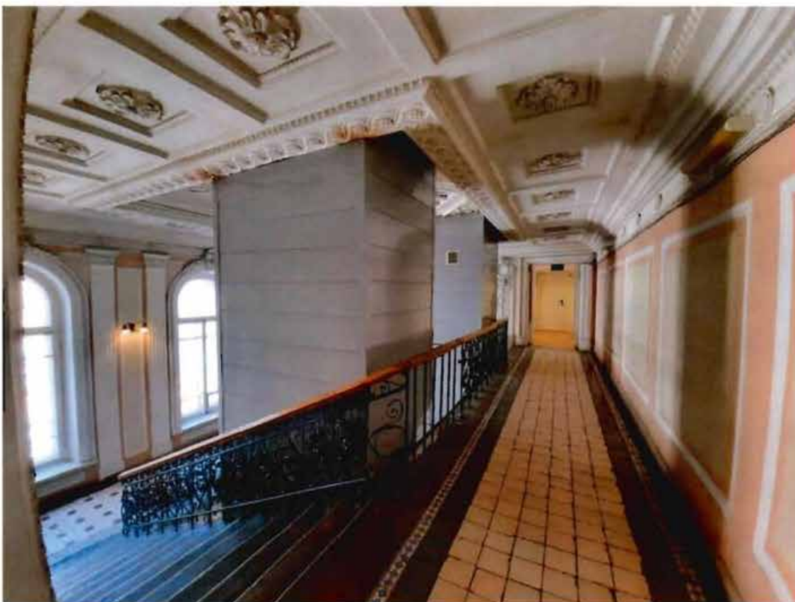
15. Лестница 1ЛК объекта культурного наследия (20.05.2022)
