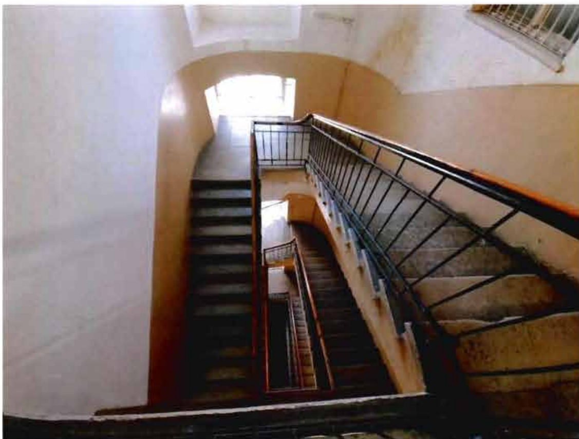
17. Западная лестница 2ЛК объекта культурного наследия (20.05.2022)
