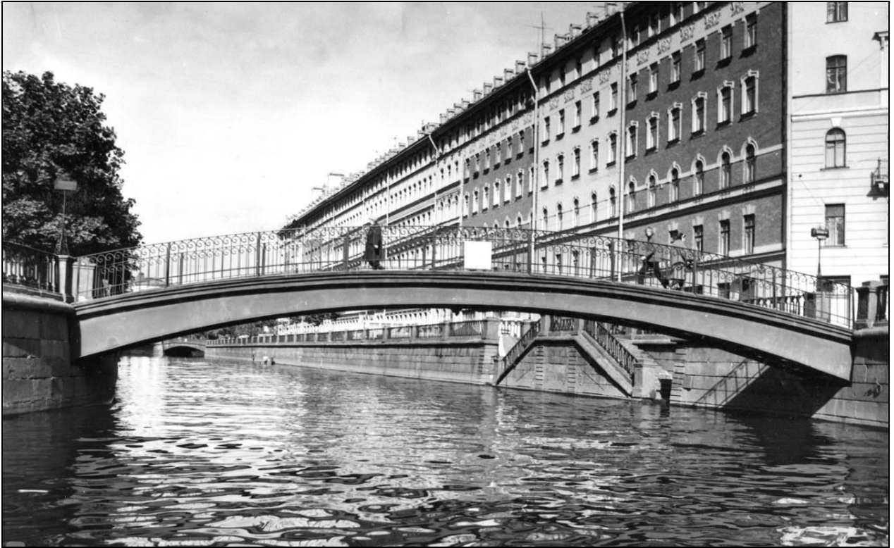
Илл. 32. Сенной мост через канал Грибоедова. Фотография. Автор съемки: неизвестен. 1973 г.
