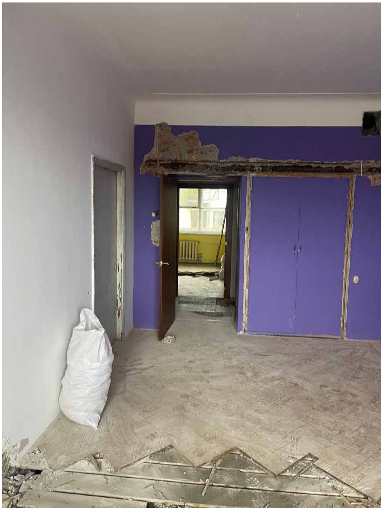
10.Фрагмент интерьера комнаты (помещение 7/17.7);
