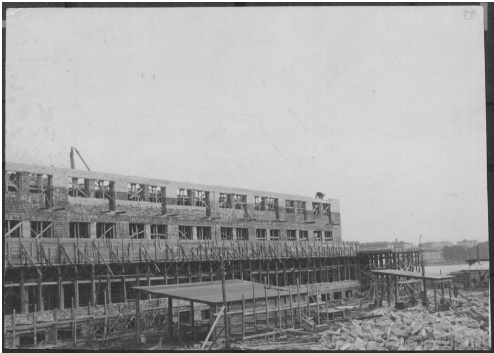
1. Строящийся дом политкаторжан. Фотография. 1920-е гг.
