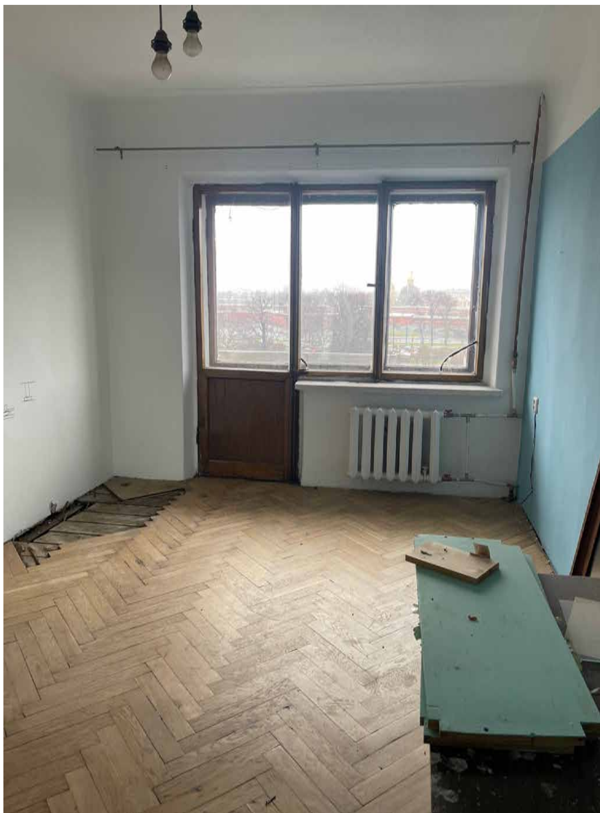
17. Фрагмент интерьера комнаты (помещение 10/16.6);
