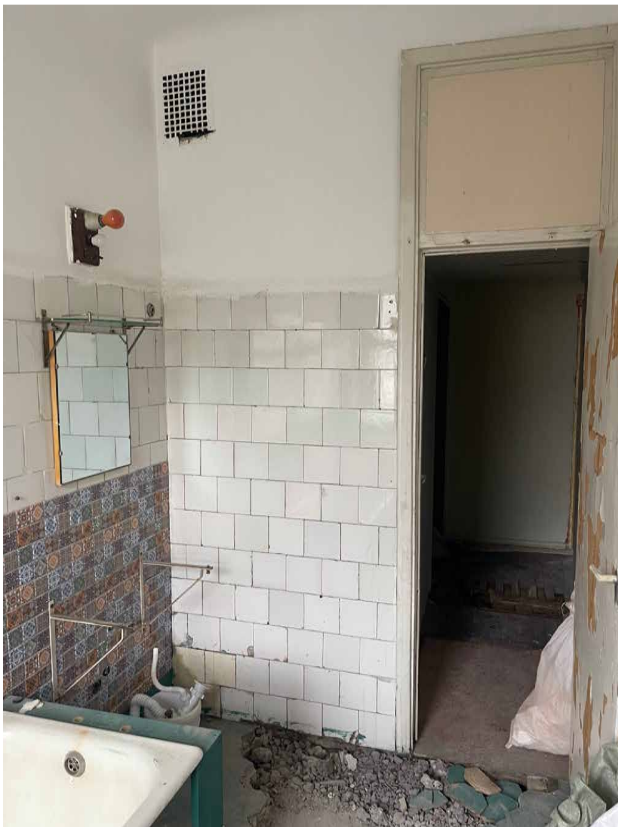
8. Фрагмент интерьера ванной (помещение 3/5.5);
