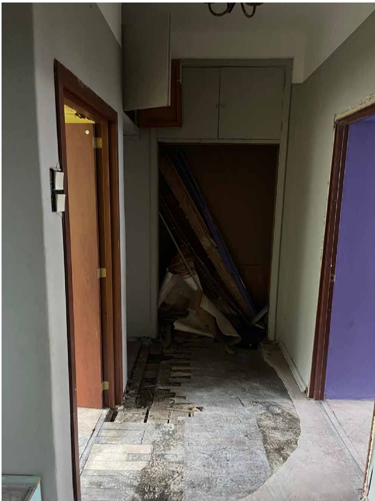
2. Фрагмент интеръера коридора (помещение 1/8.2);
