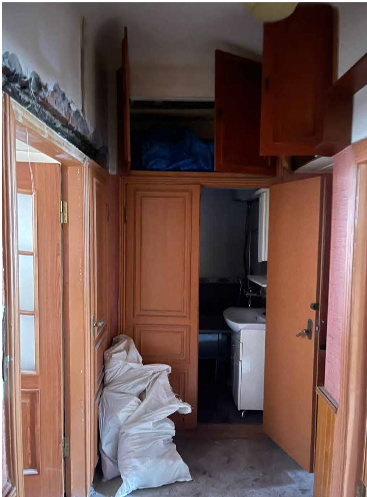
20. Фрагмент интеръера коридора (помещение 1/7.7);
