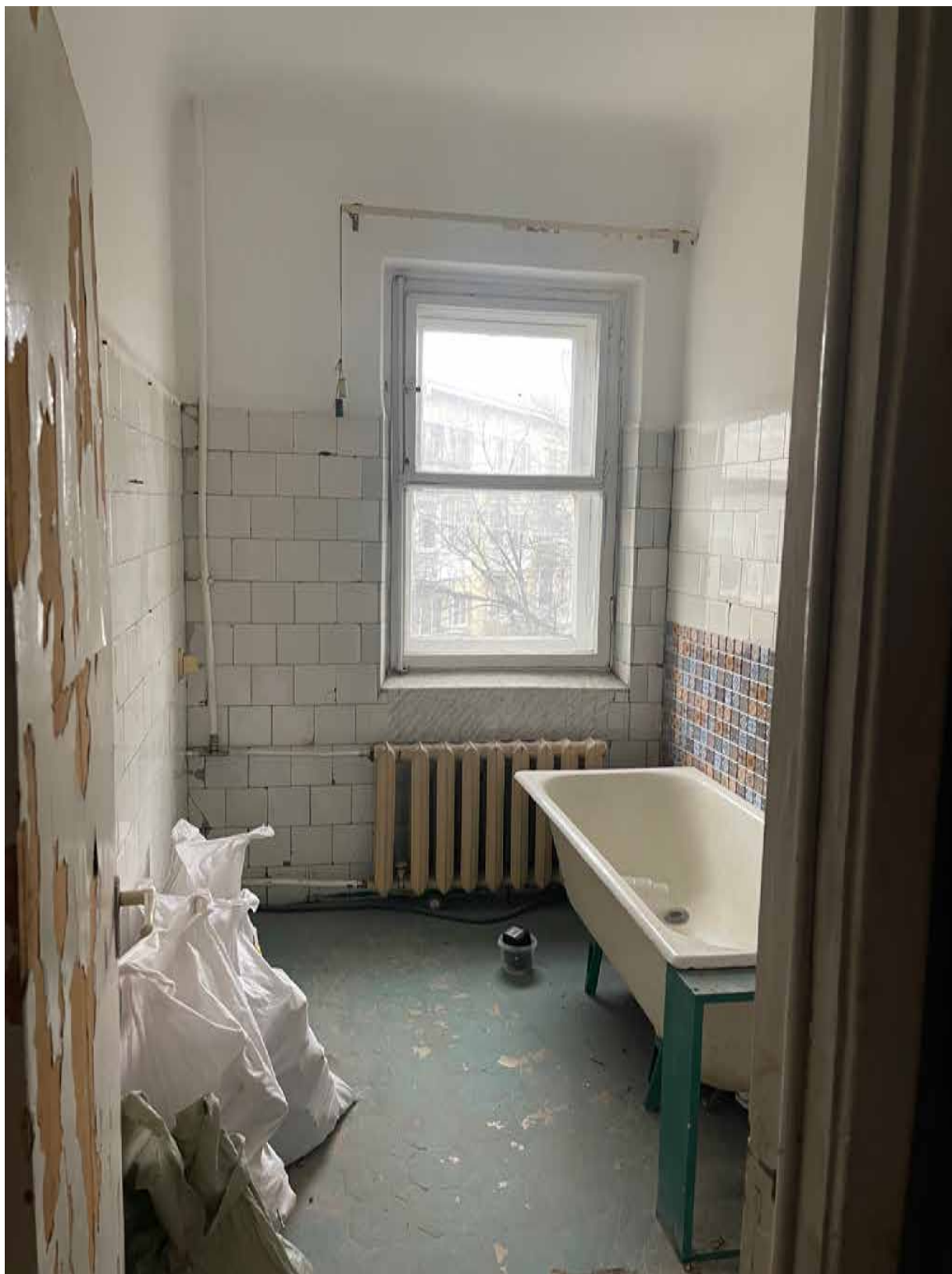
7. Фрагмент интерьера ванной (помещение 3/5.5);
