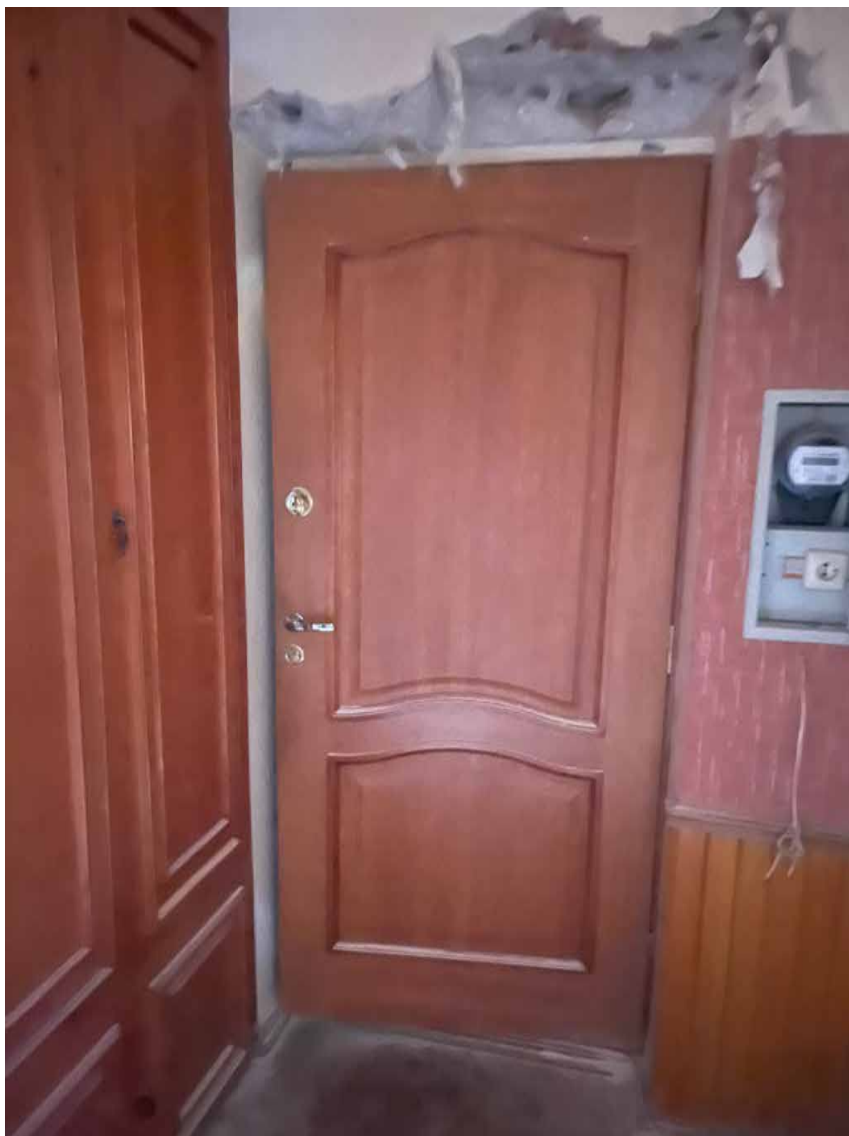
19. Вид на входную дверь в квартире №19;
