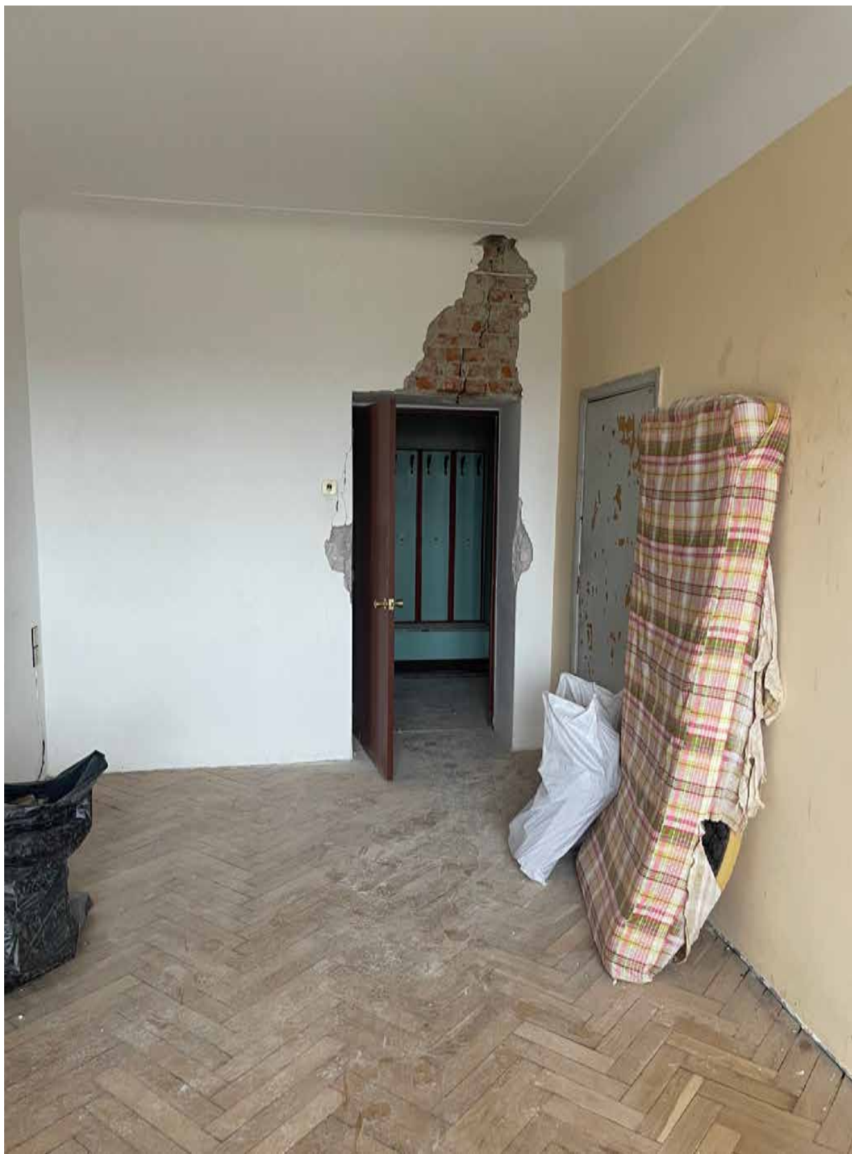
12.Фрагмент интерьера комнаты (помещение 8/16.4);
