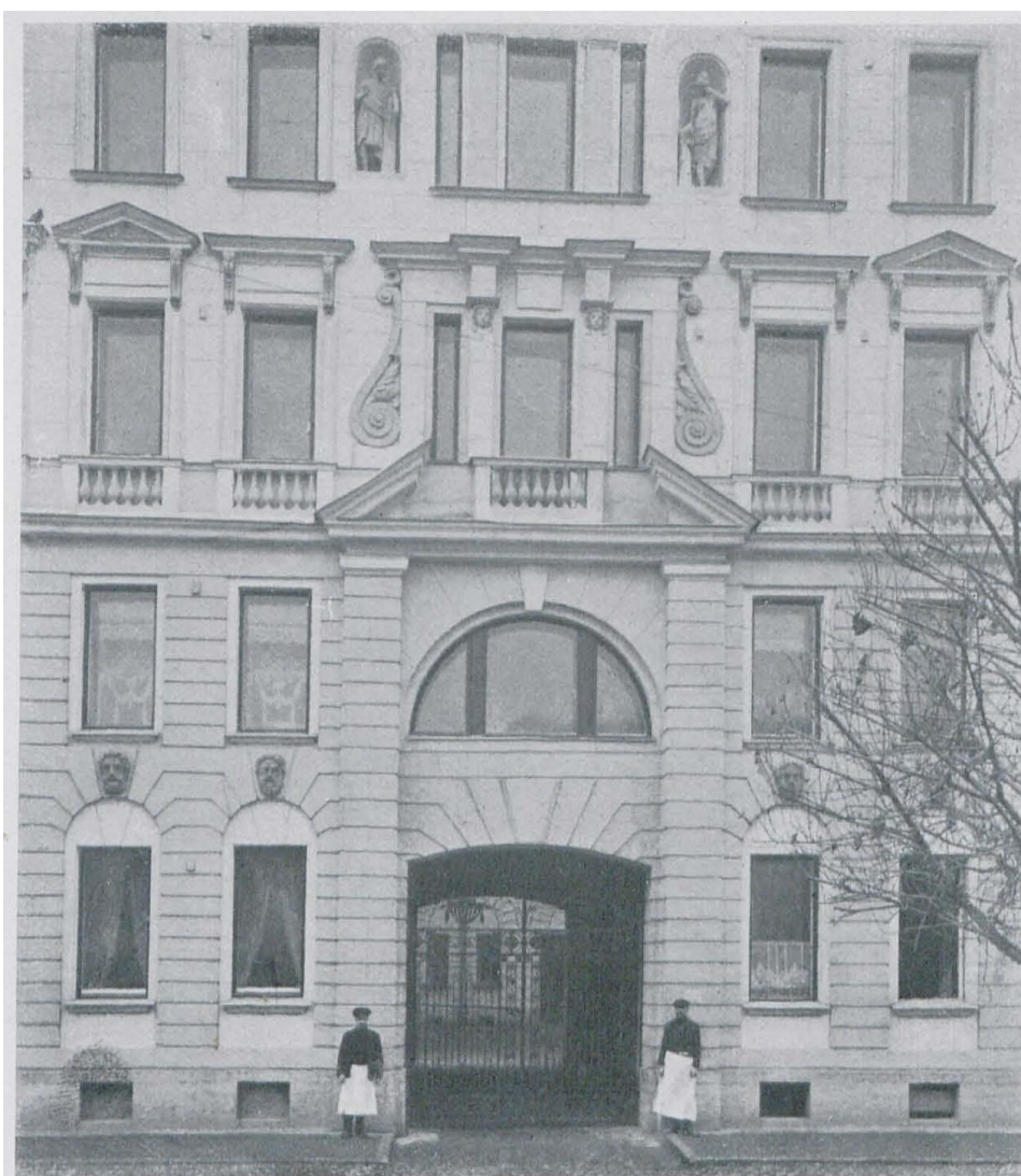
Деталь доходнаго дома, Фонтанка, 126, С.-Петербургъ. Проект. и стр. И. И. ДОЛГИНОВЪ, архит.-худ. С.П.Бургъ.
