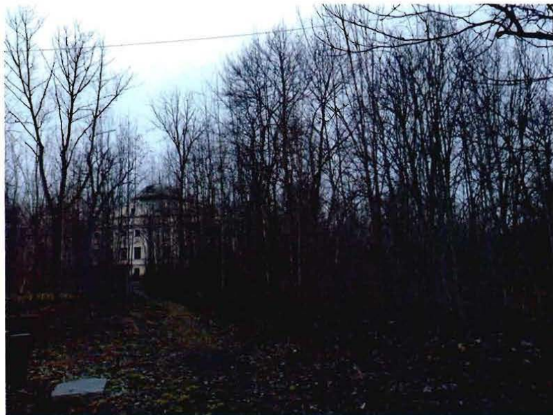
3. Центральная часть объекта культурного наследия.
