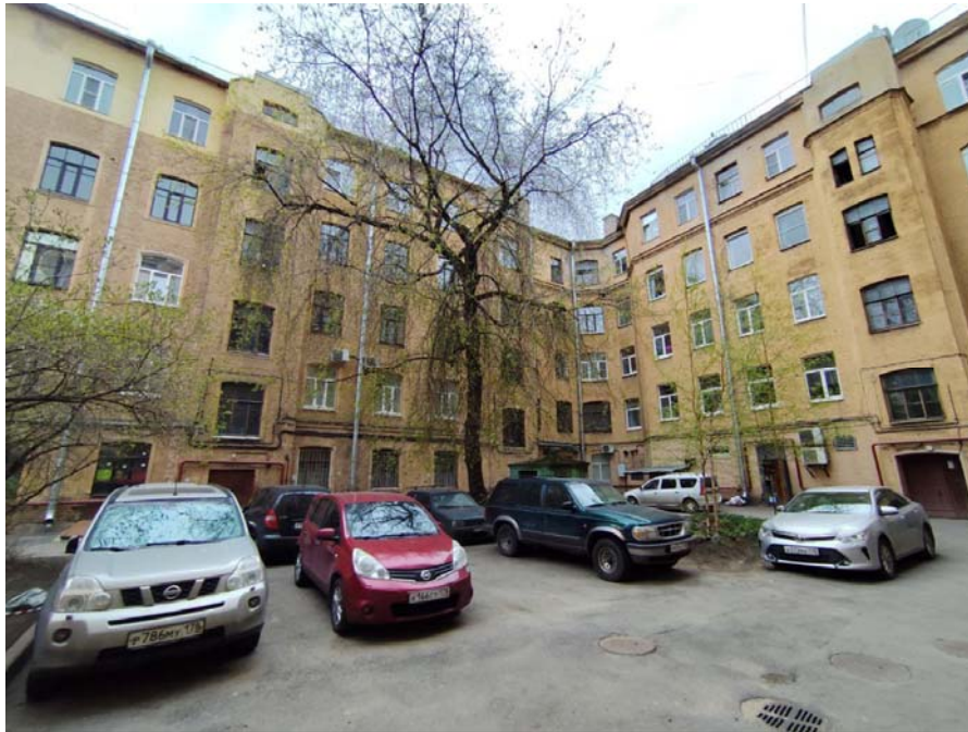
Фото 5. Дворовые фасады, общий вид.
