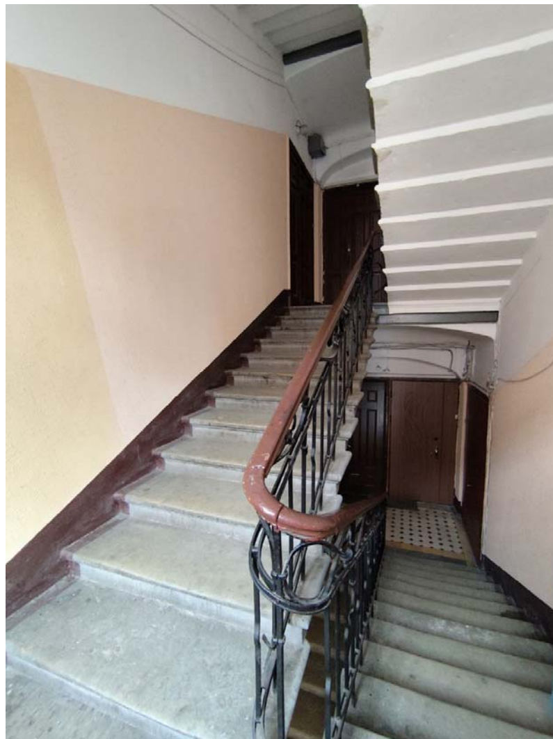
Фото 13. Лестничная клетка 2-3 этаж.
