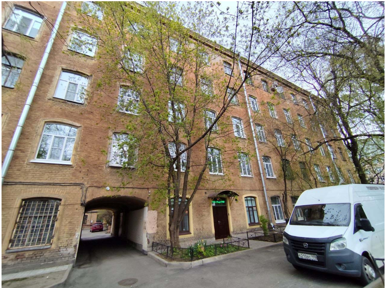
Фото 10. Юго-восточный фасад дворового корпуса.
