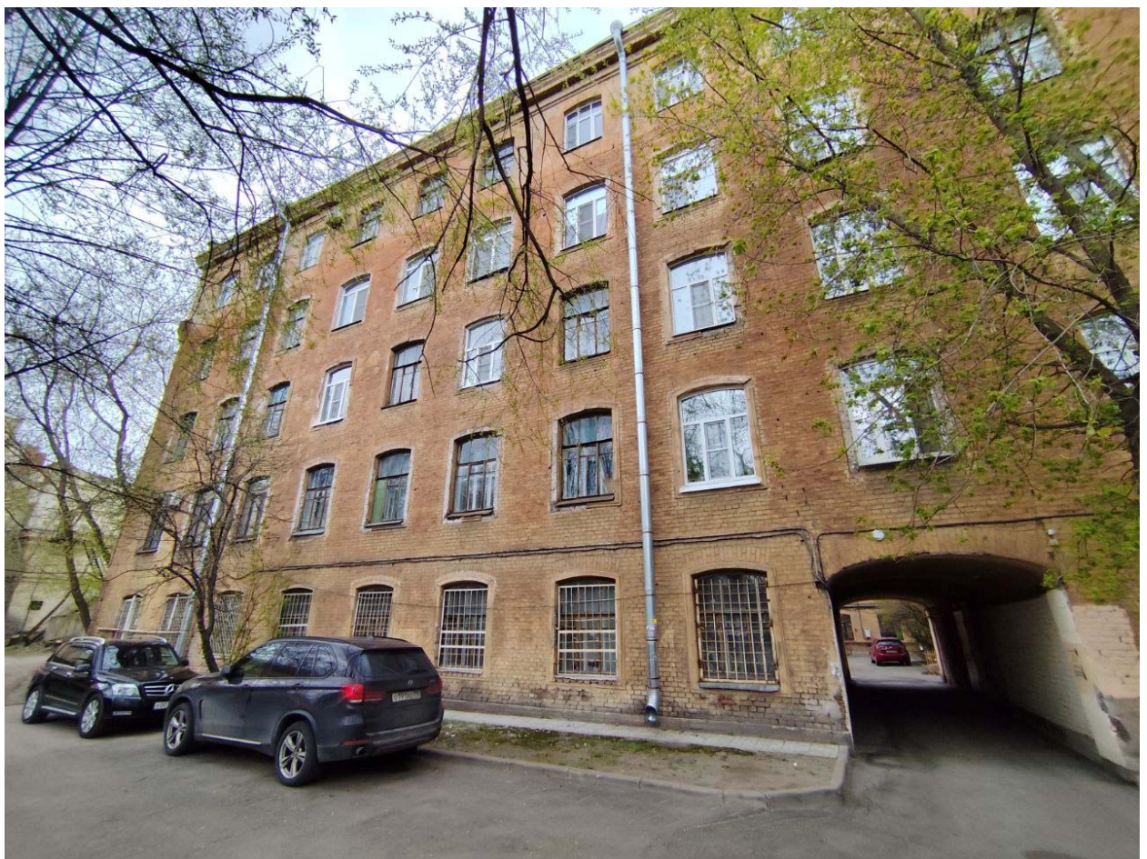
Фото 9. Юго-восточный фасад дворового корпуса.
