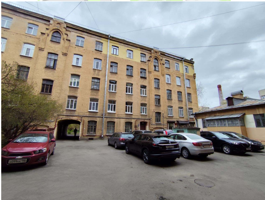
Фото 8. Северо-западный дворовый фасад дворового корпуса.
