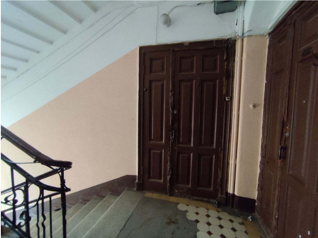
Фото 15. 3 этаж, вход в квартиру №32.
