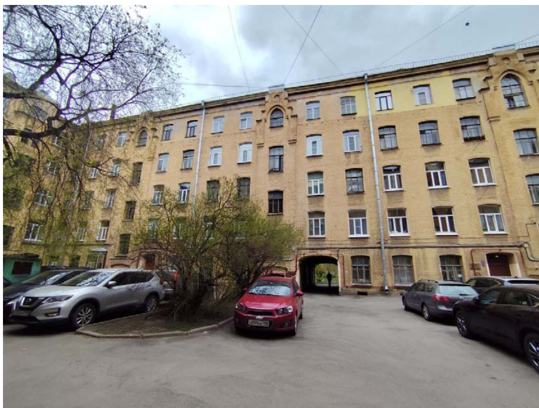
Фото 7. Северо-западный дворовый фасад дворового корпуса.
