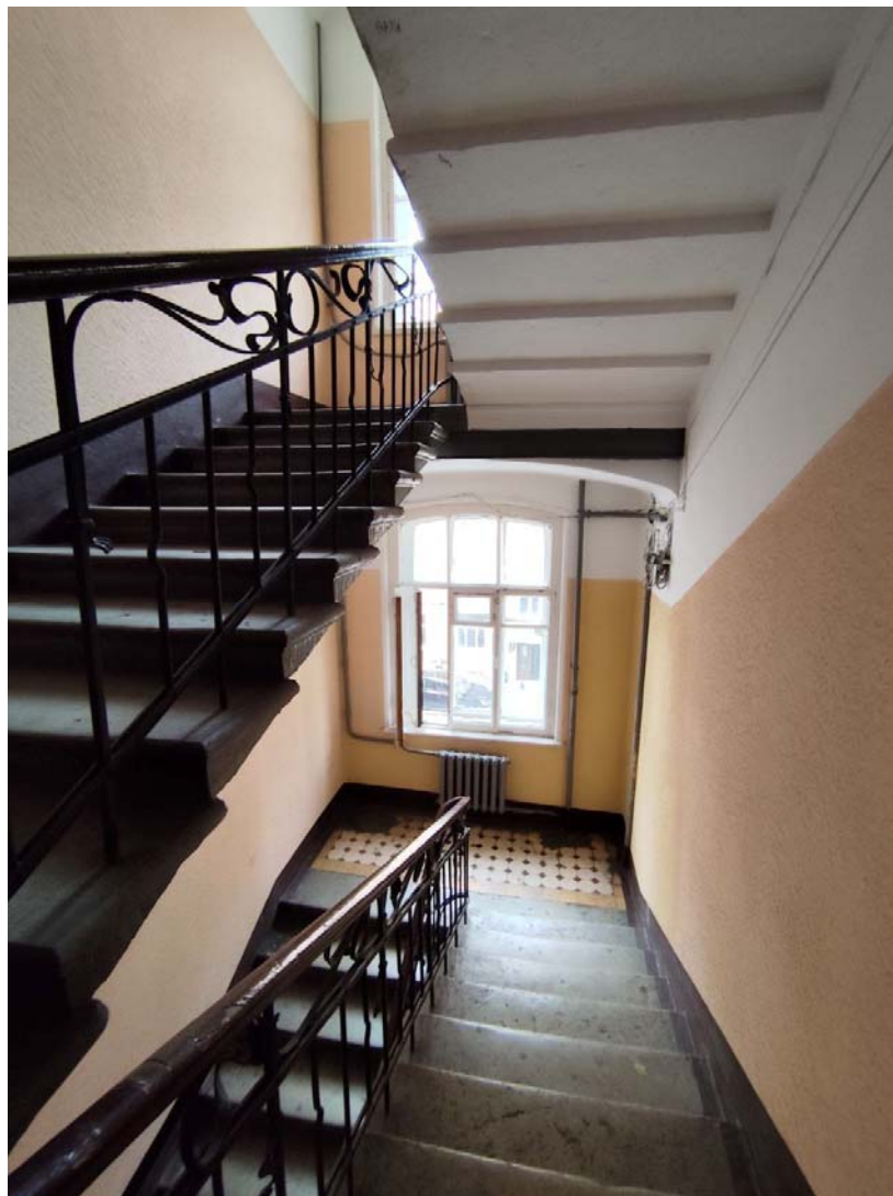
Фото 14. Лестничная клетка 2-3 этаж.
