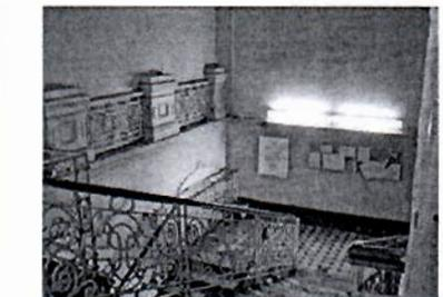
лестница в северо-западной части главного корпуса – местоположение, габариты, тип (двухмаршевая), конструкция (на косоурах), ступени (из лещадной плиты);
