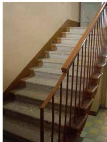
лестница в западном крыле главного корпуса – местоположение, габариты, тип (двухмаршевая), конструкция (на косоурах), ступени (из лещадной плиты);
