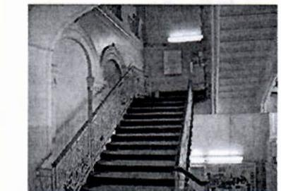
ограждение маршей и площадок – материал (металл), техника исполнения (ковка, сборная), рисунок (звенья с заполнением геометрического орнамента); поручни – материал (дерево), конфигурация (профилированные);
