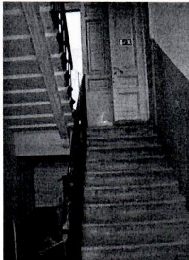
лестница в четырехэтажном дворежном корпусе – местоположение, габариты, тип (трехмаршевая), конструкция (на косоурах), ступени (из лещадной плиты);
