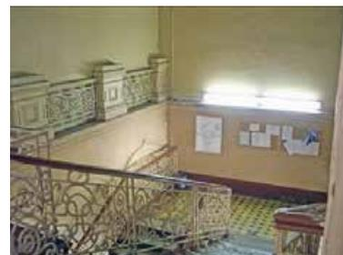
лестница в северо-западной части главного корпуса – местоположение, габариты, тип (двухмаршевая), конструкция (на косоурах), ступени (из лещадной плиты);
