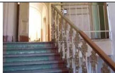
лестница в восточном крыле главного корпуса – местоположение, габариты, тип (двухмаршевая), конструкция (на косоурах), ступени (из лещадной плиты);
