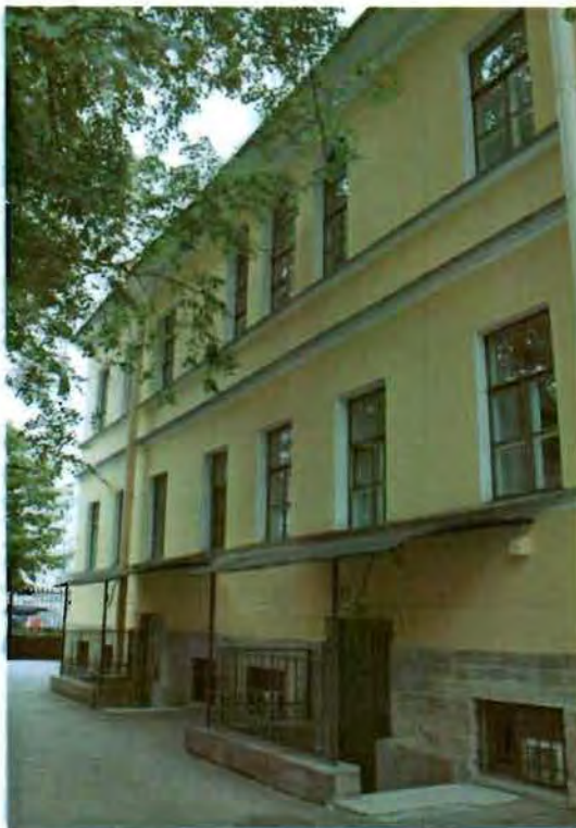
Фото №4. Фрагмент восточного фасада, вид со стороны внутреннего двора.
