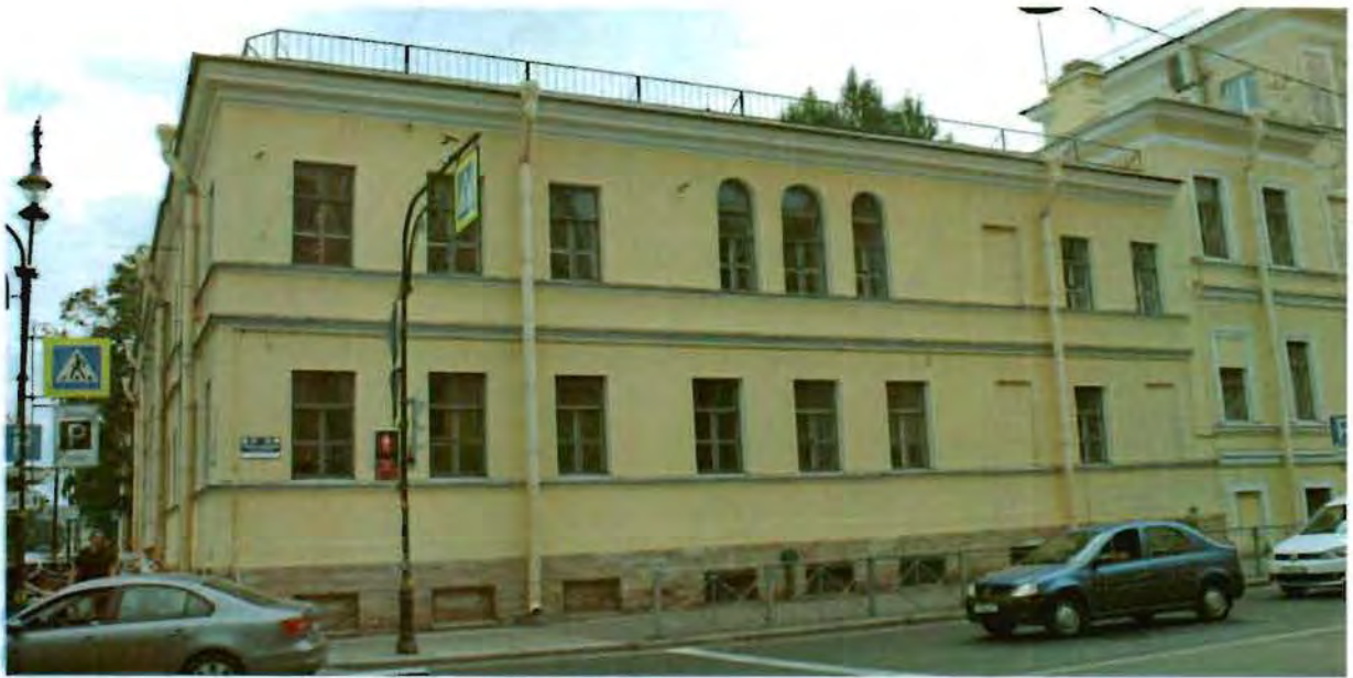
Фото №3. Вид на западный фасад со стороны ул. Радищева.
