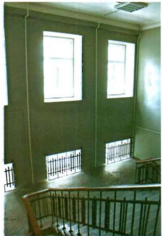
Фото №8. Распашная межэтажная лестница.
