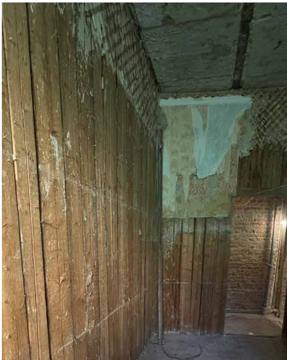
16.Фрагмент интерьера комнаты (помещение 8/10.8);
