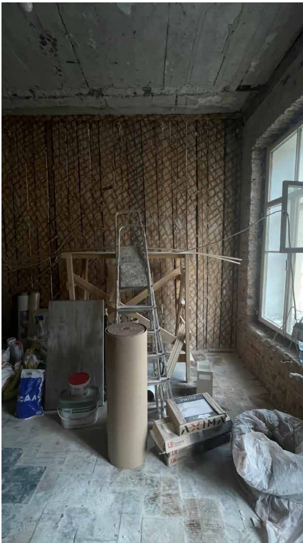
5. Фрагмент интерьера кухни (помещение 1/16.2);
