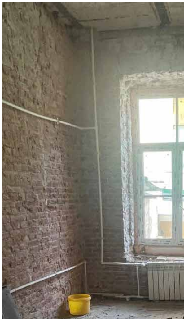
18.Фрагмент интерьера комнаты (помещение 7/14.50);
