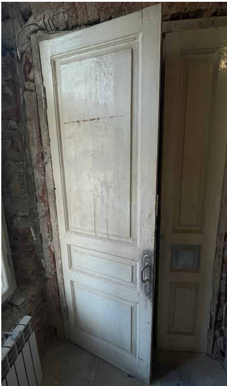
4. Вид на входную дверь в квартире;
