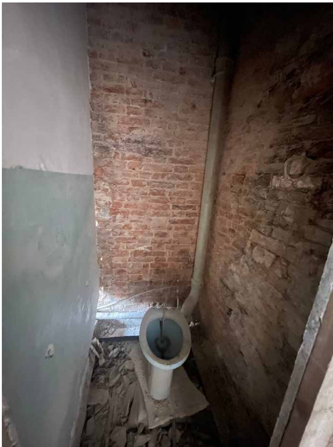
8. Фрагмент интерьера туалета (помещение 5/1.50);
