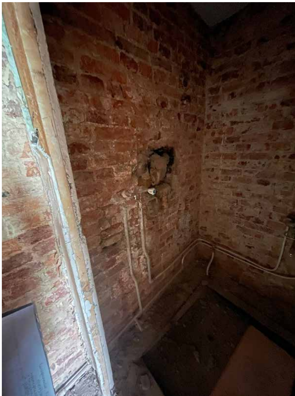
17. Фрагмент интерьера комнаты (помещение 7/14.50);
