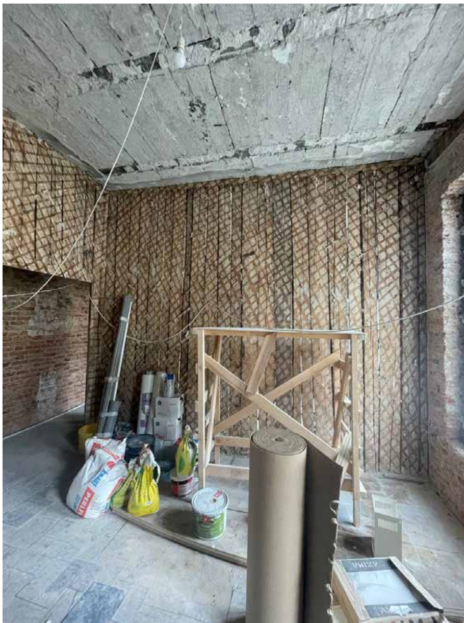
7. Фрагмент интерьера кухни (помещение 1/16.2);
