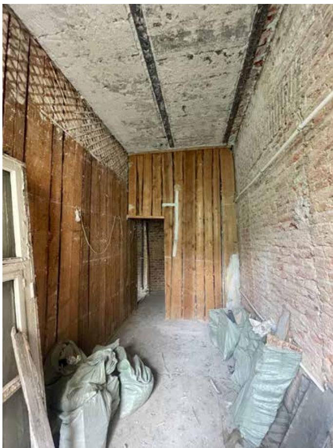
19.Фрагмент интерьера комнаты (помещение 7/14.50).
