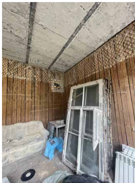
13.Фрагмент интерьера комнаты (помещение 2/25.0);
