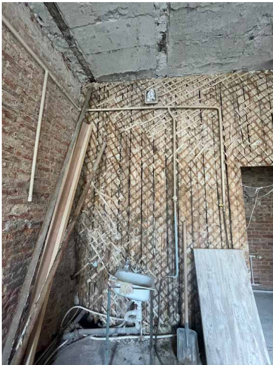
6. Фрагмент интерьера кухни (помещение 1/16.2);
