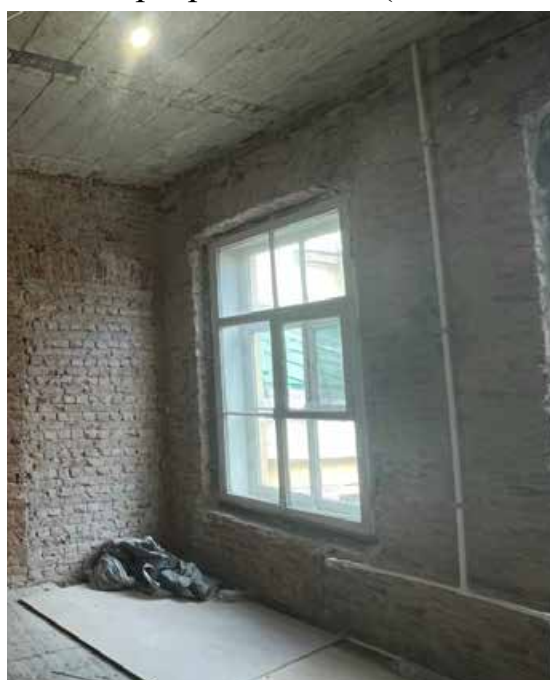
11.Фрагмент интерьера комнаты (помещение 3/19.1);
