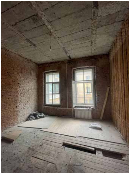
10.Фрагмент интерьера комнаты (помещение 3/19.1);
