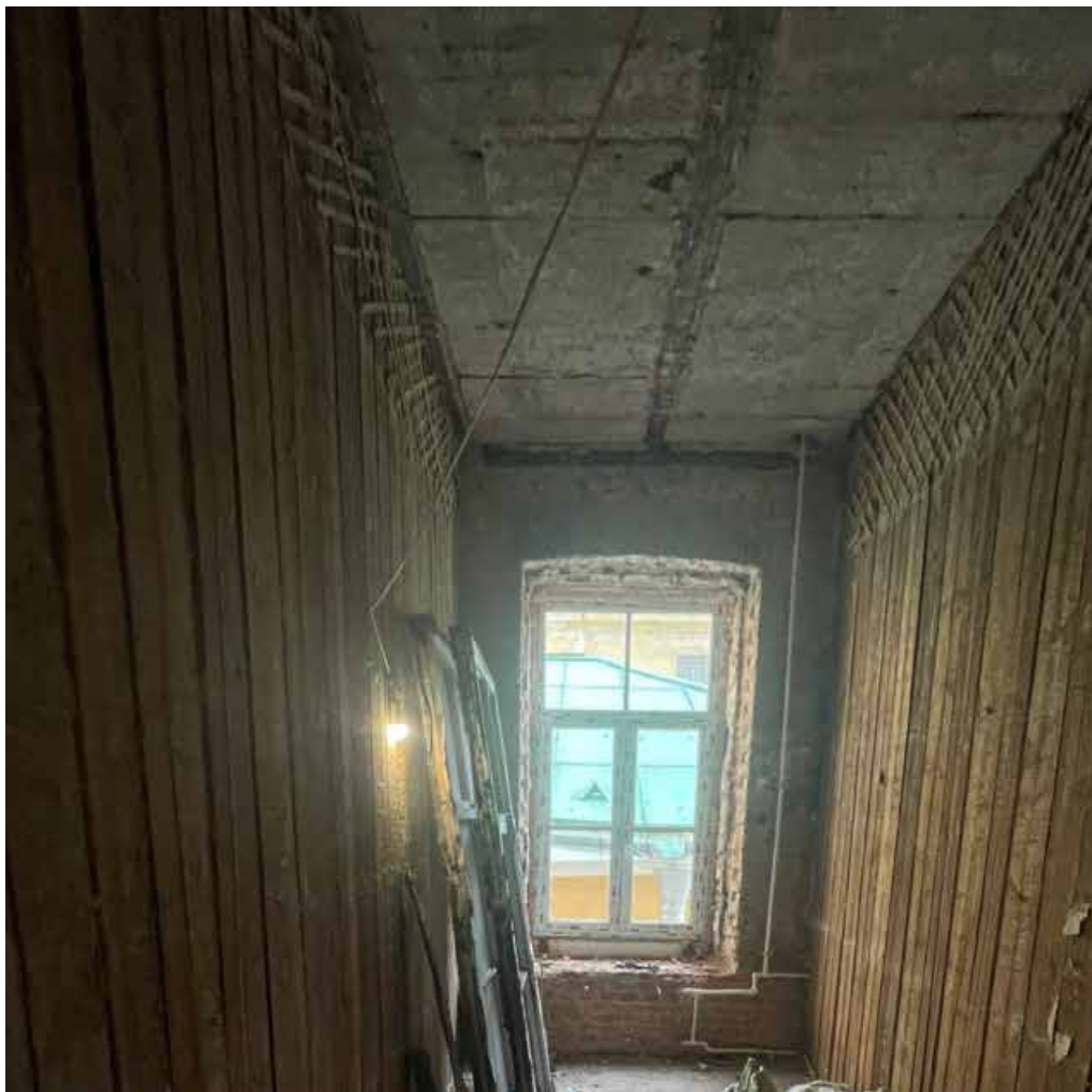
15.Фрагмент интерьера комнаты (помещение 8/10.8);
