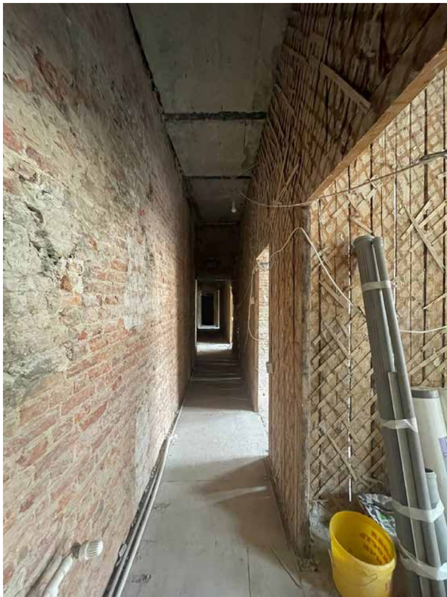
9. Фрагмент интеръера коридора (помещение 4/7.60);
