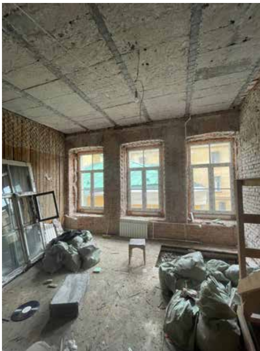
12.Фрагмент интерьера комнаты (помещение 2/25.0);
