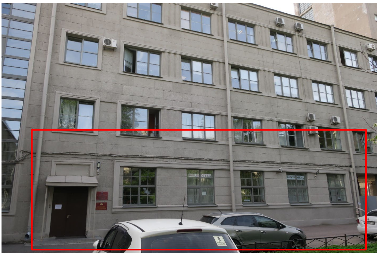
1. Дворовый фасад объекта культурного наследия федерального значения «Райсовет Кировский», расположенного по адресу: г. Санкт-Петербург, пр. Стачек, д. 18, литера А. 13.06.2023.
