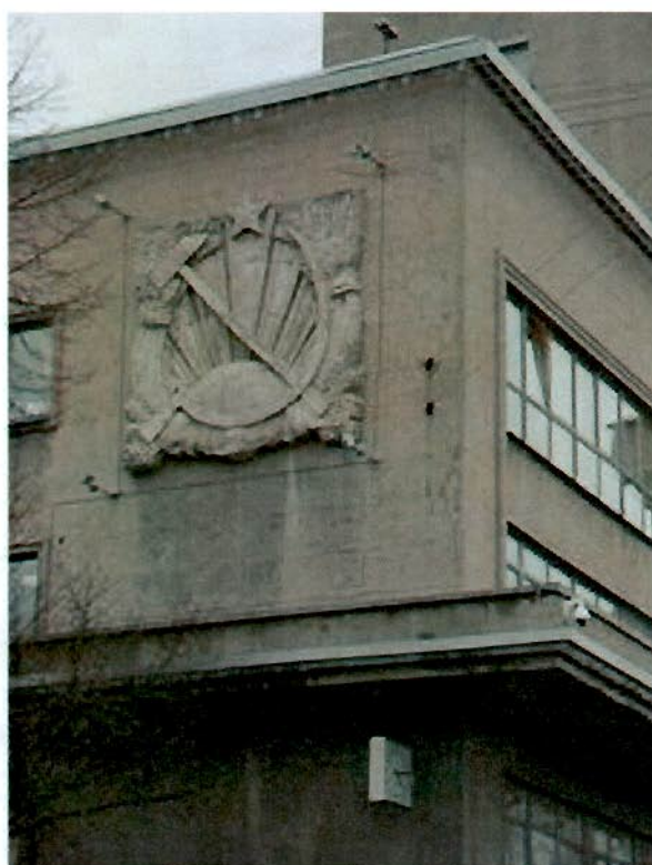
13. Угловая башня. Барельеф.
