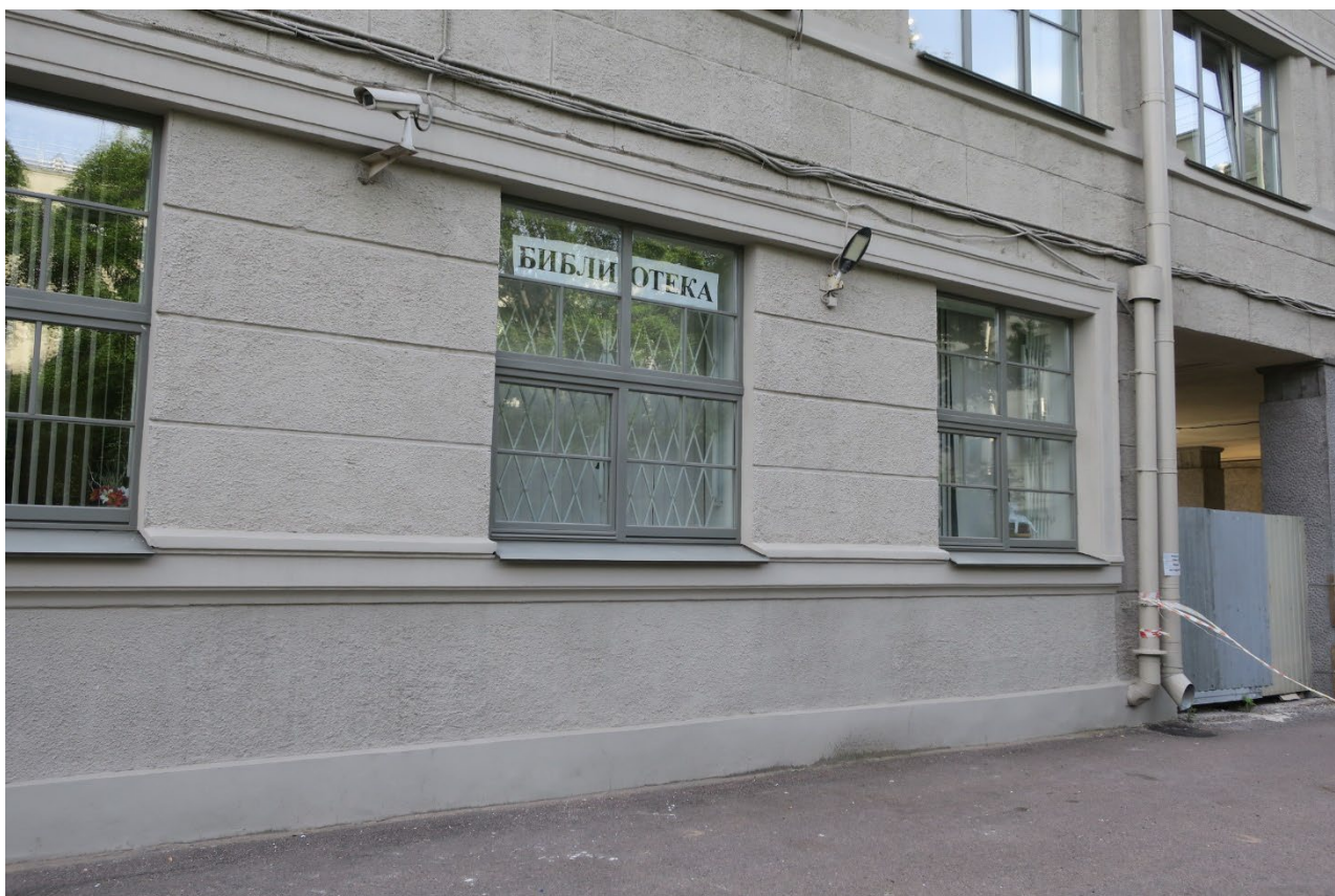
2. Дворовый фасад объекта культурного наследия федерального значения «Райсовет Кировский», расположенного по адресу: г. Санкт-Петербург, пр. Стачек, д. 18, литера А. 13.06.2023.
