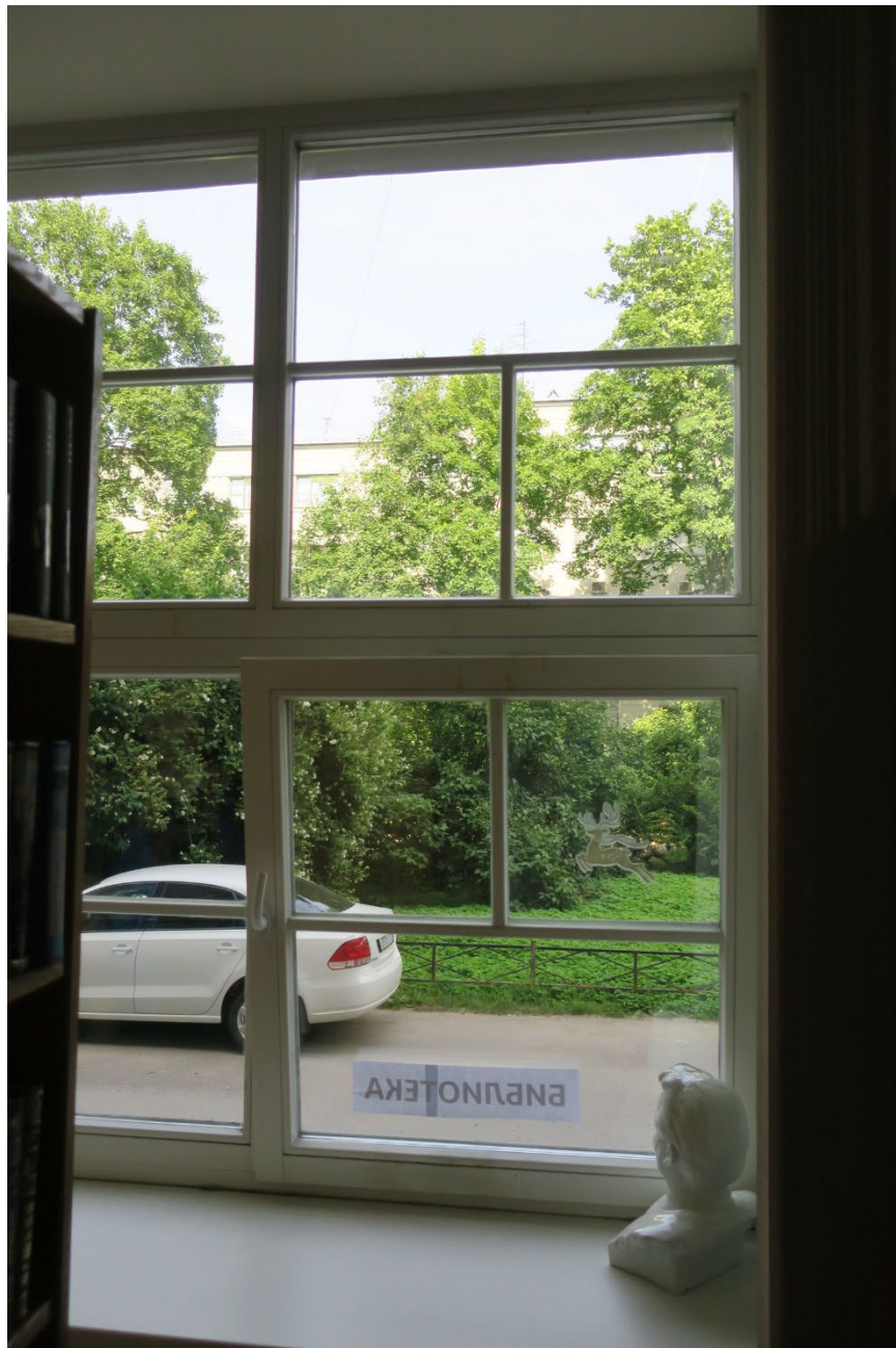
13. Оконные заполнения помещения №6 (25-Н) объекта культурного наследия федерального значения «Райсовет Кировский», расположенного по адресу: г. Санкт-Петербург, пр. Стачек, д. 18, литера А. 13.06.2023.
