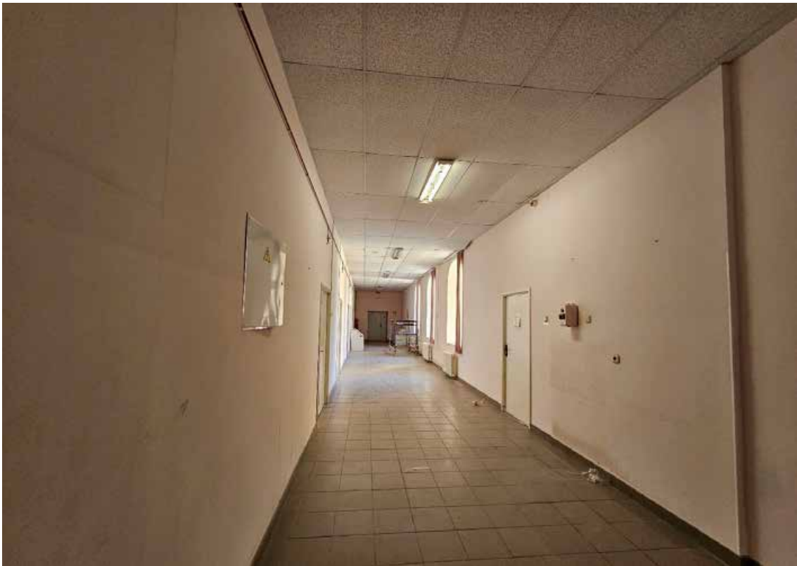
59. Объект культурного наследия регионального значения «Корпус № 2», по адресу: Санкт-Петербург, город Петергоф, Санкт-Петербургский проспект, дом 20, литера В, в составе объекта культурного наследия регионального значения «Комплекс дворцового госпиталя (с территорией)». Общий вид пом. 1-Н (53) в уровне 2-го этажа.
