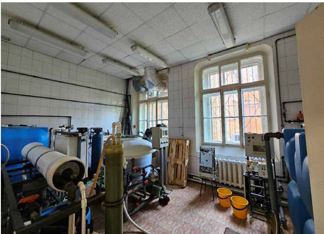
18. Объект культурного наследия регионального значения «Корпус № 2», по адресу: Санкт-Петербург, город Петергоф, Санкт-Петербургский проспект, дом 20, литера В, в составе объекта культурного наследия регионального значения «Комплекс дворцового госпиталя (с территорией)». Общий вид пом. 1-Н (8) в уровне 1-го этажа.
