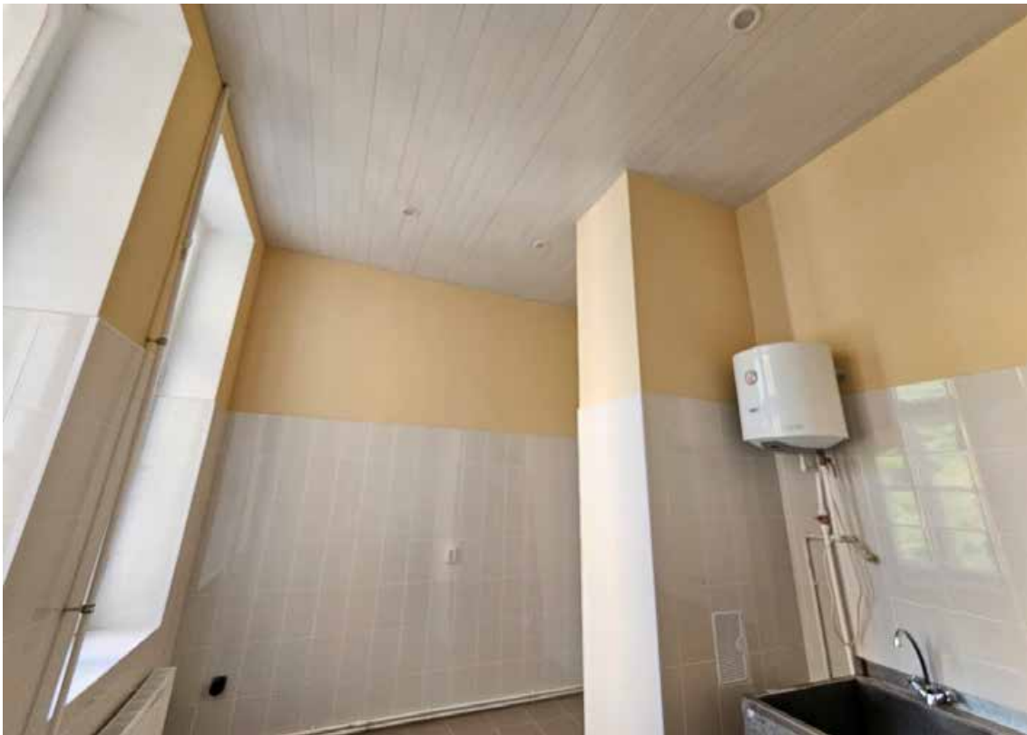
49. Объект культурного наследия регионального значения «Корпус № 2», по адресу: Санкт-Петербург, город Петергоф, Санкт-Петербургский проспект, дом 20, литера В, в составе объекта культурного наследия регионального значения «Комплекс дворцового госпиталя (с территорией)». Общий вид пом. 1-Н (77) в уровне 2-го этажа.
