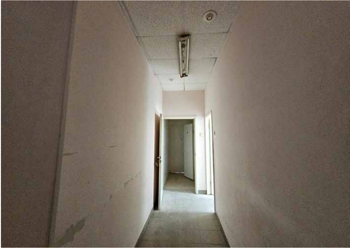
63. Объект культурного наследия регионального значения «Корпус № 2», по адресу: Санкт-Петербург, город Петергоф, Санкт-Петербургский проспект, дом 20, литера В, в составе объекта культурного наследия регионального значения «Комплекс дворцового госпиталя (с территорией)». Общий вид пом. 1-Н (67) в уровне 2-го этажа.
