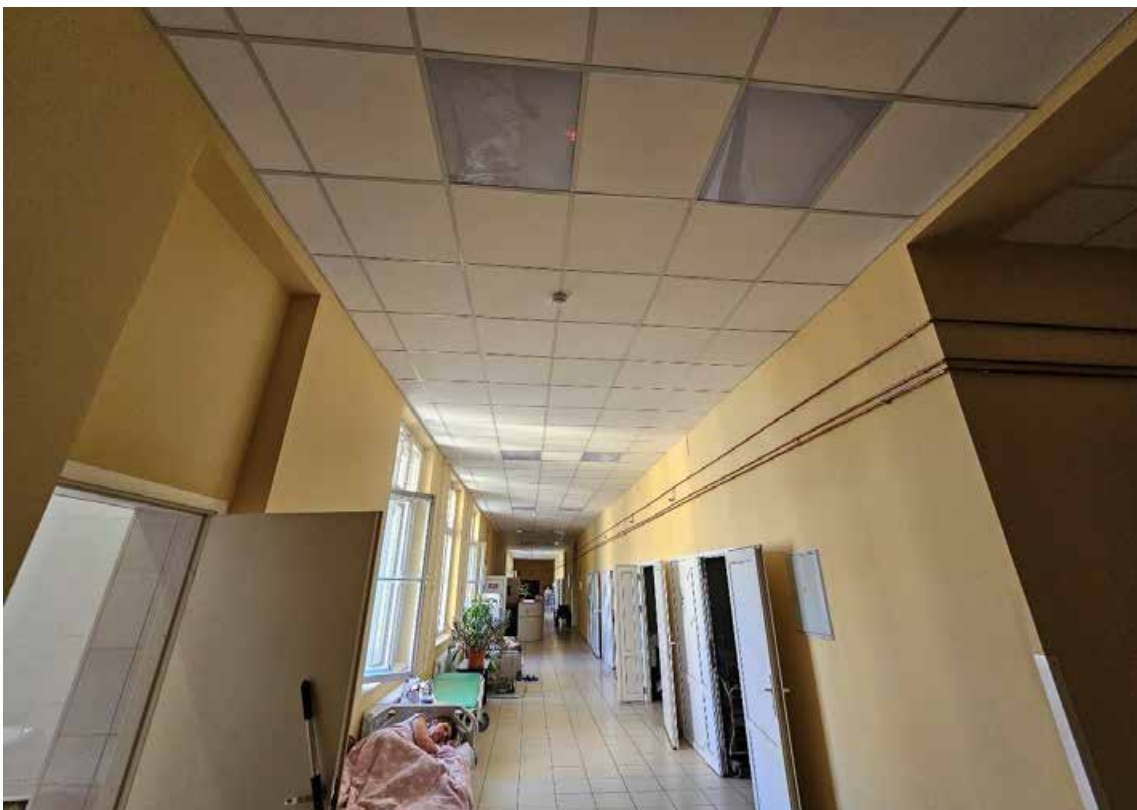
93. Объект культурного наследия регионального значения «Корпус № 2», по адресу: Санкт-Петербург, город Петергоф, Санкт-Петербургский проспект, дом 20, литера В, в составе объекта культурного наследия регионального значения «Комплекс дворцового госпиталя (с территорией)». Общий вид пом. 1-Н (87) в уровне 3-го этажа.
