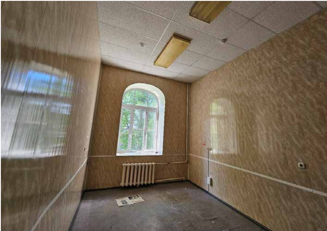
58. Объект культурного наследия регионального значения «Корпус № 2», по адресу: Санкт-Петербург, город Петергоф, Санкт-Петербургский проспект, дом 20, литера В, в составе объекта культурного наследия регионального значения «Комплекс дворцового госпиталя (с территорией)». Общий вид пом. 1-Н (53) в уровне 2-го этажа.
