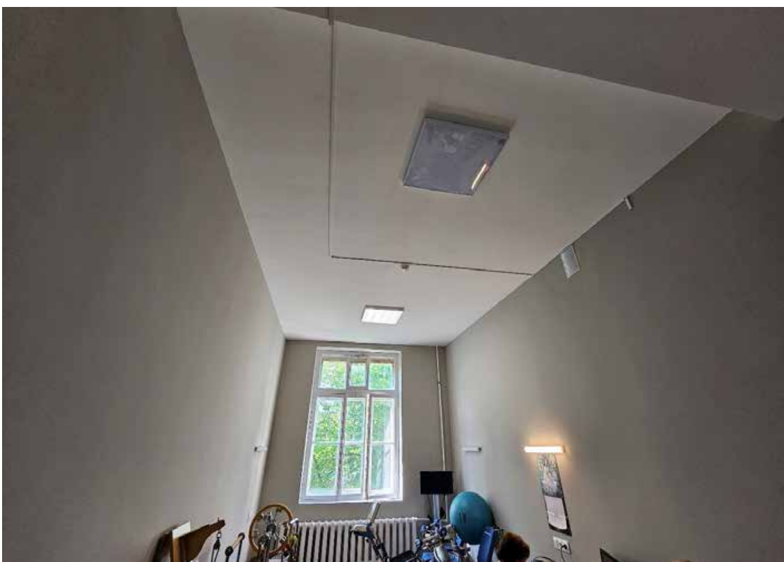
85. Объект культурного наследия регионального значения «Корпус № 2», по адресу: Санкт-Петербург, город Петергоф, Санкт-Петербургский проспект, дом 20, литера В, в составе объекта культурного наследия регионального значения «Комплекс дворцового госпиталя (с территорией)». Общий вид пом. 1-Н (98) в уровне 3-го этажа.
