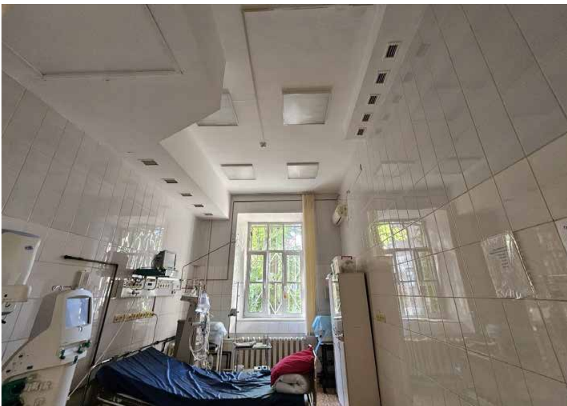
26. Объект культурного наследия регионального значения «Корпус № 2», по адресу: Санкт-Петербург, город Петергоф, Санкт-Петербургский проспект, дом 20, литера В, в составе объекта культурного наследия регионального значения «Комплекс дворцового госпиталя (с территорией)». Общий вид пом. 1-Н (13) в уровне 1-го этажа.
