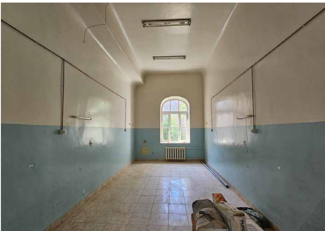
52. Объект культурного наследия регионального значения «Корпус № 2», по адресу: Санкт-Петербург, город Петергоф, Санкт-Петербургский проспект, дом 20, литера В, в составе объекта культурного наследия регионального значения «Комплекс дворцового госпиталя (с территорией)». Общий вид пом. 1-Н (47) в уровне 2-го этажа.
