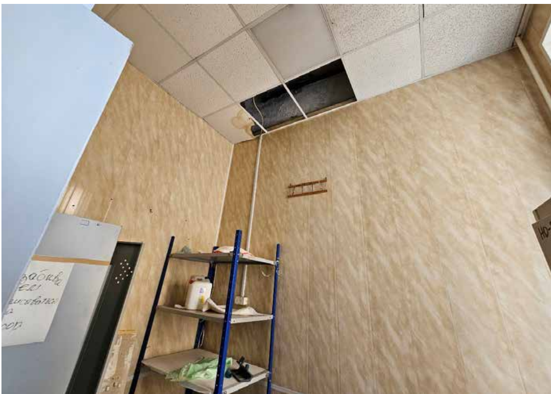
62. Объект культурного наследия регионального значения «Корпус № 2», по адресу: Санкт-Петербург, город Петергоф, Санкт-Петербургский проспект, дом 20, литера В, в составе объекта культурного наследия регионального значения «Комплекс дворцового госпиталя (с территорией)». Общий вид пом. 1-Н (73) в уровне 2-го этажа.
