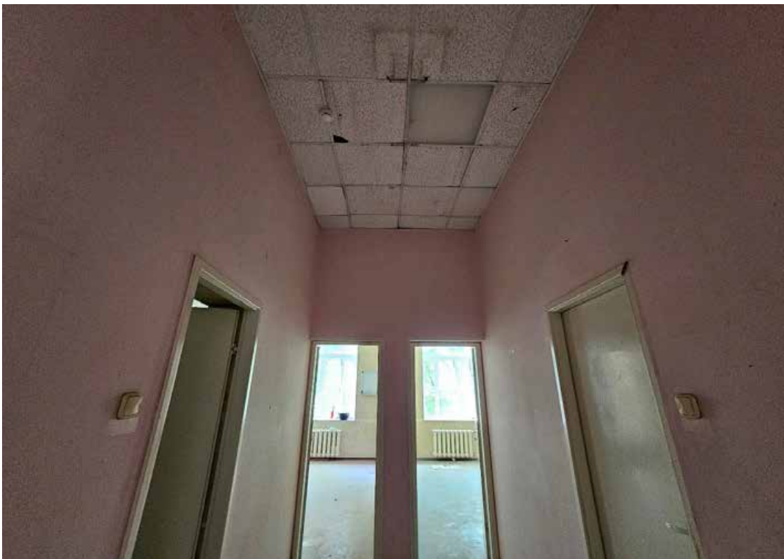
55. Объект культурного наследия регионального значения «Корпус № 2», по адресу: Санкт-Петербург, город Петергоф, Санкт-Петербургский проспект, дом 20, литера В, в составе объекта культурного наследия регионального значения «Комплекс дворцового госпиталя (с территорией)». Общий вид пом. 1-Н (50) в уровне 2-го этажа.
