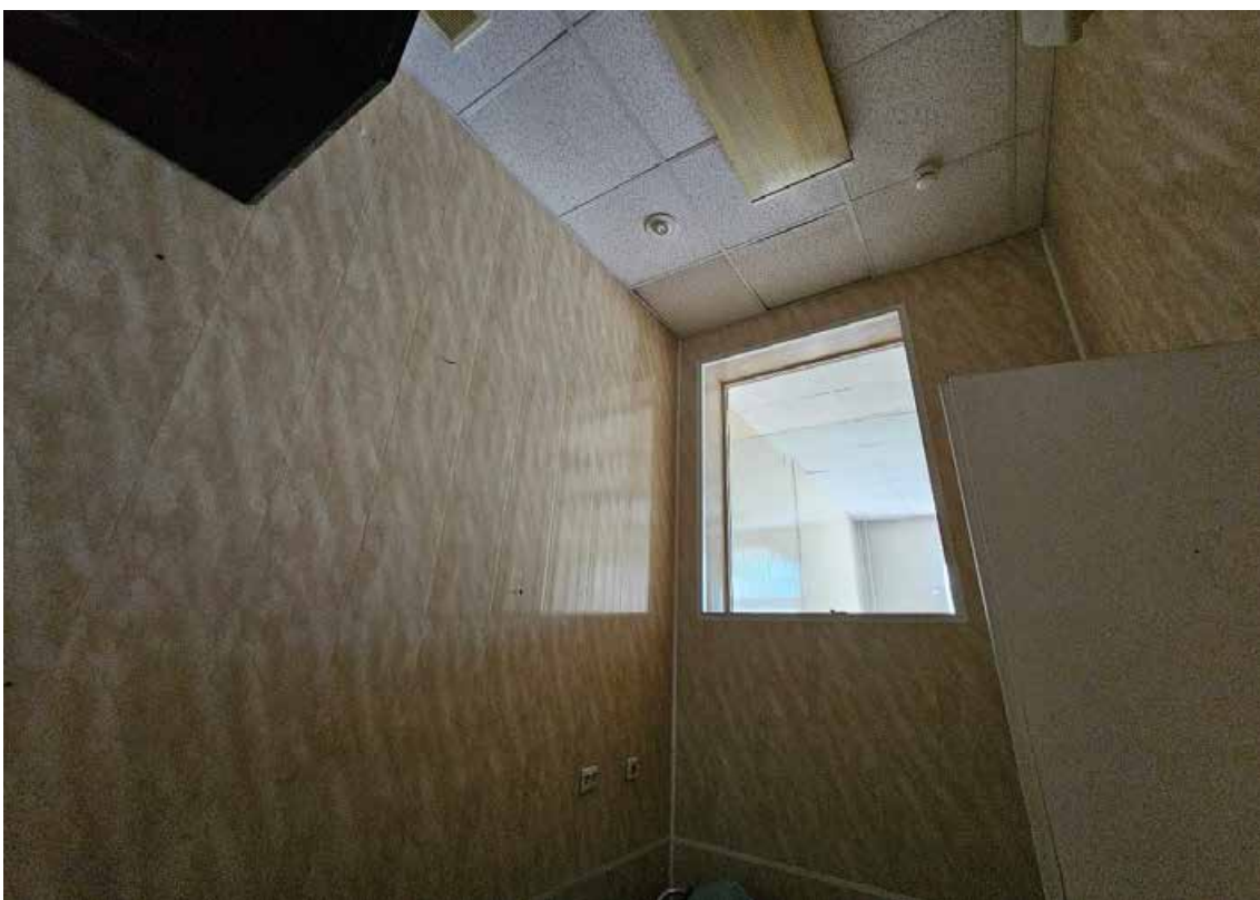
56. Объект культурного наследия регионального значения «Корпус № 2», по адресу: Санкт-Петербург, город Петергоф, Санкт-Петербургский проспект, дом 20, литера В, в составе объекта культурного наследия регионального значения «Комплекс дворцового госпиталя (с территорией)». Общий вид пом. 1-Н (51) в уровне 2-го этажа.
