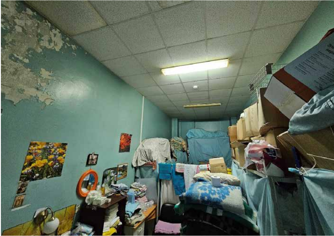
70. Объект культурного наследия регионального значения «Корпус № 2», по адресу: Санкт-Петербург, город Петергоф, Санкт-Петербургский проспект, дом 20, литера В, в составе объекта культурного наследия регионального значения «Комплекс дворцового госпиталя (с территорией)». Общий вид пом. 1-Н (86) в уровне 3-го этажа.
