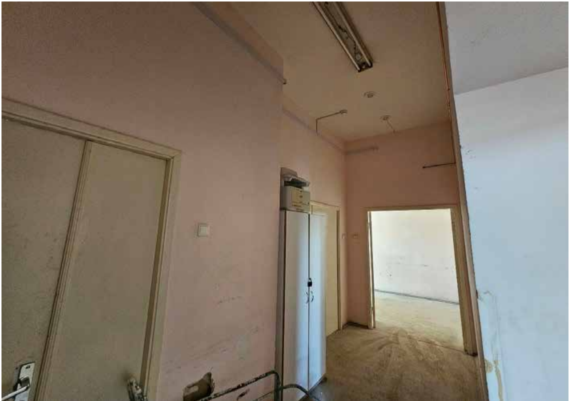
64. Объект культурного наследия регионального значения «Корпус № 2», по адресу: Санкт-Петербург, город Петергоф, Санкт-Петербургский проспект, дом 20, литера В, в составе объекта культурного наследия регионального значения «Комплекс дворцового госпиталя (с территорией)». Общий вид пом. 1-Н (67) в уровне 2-го этажа.
