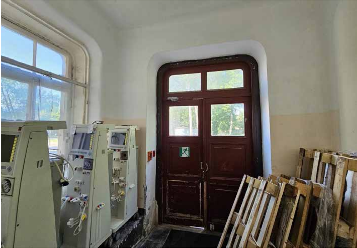
44. Объект культурного наследия регионального значения «Корпус № 2», по адресу: Санкт-Петербург, город Петергоф, Санкт-Петербургский проспект, дом 20, литера В, в составе объекта культурного наследия регионального значения «Комплекс дворцового госпиталя (с территорией)». Общий вид пом. 1-Н (40) в уровне 1-го этажа.
