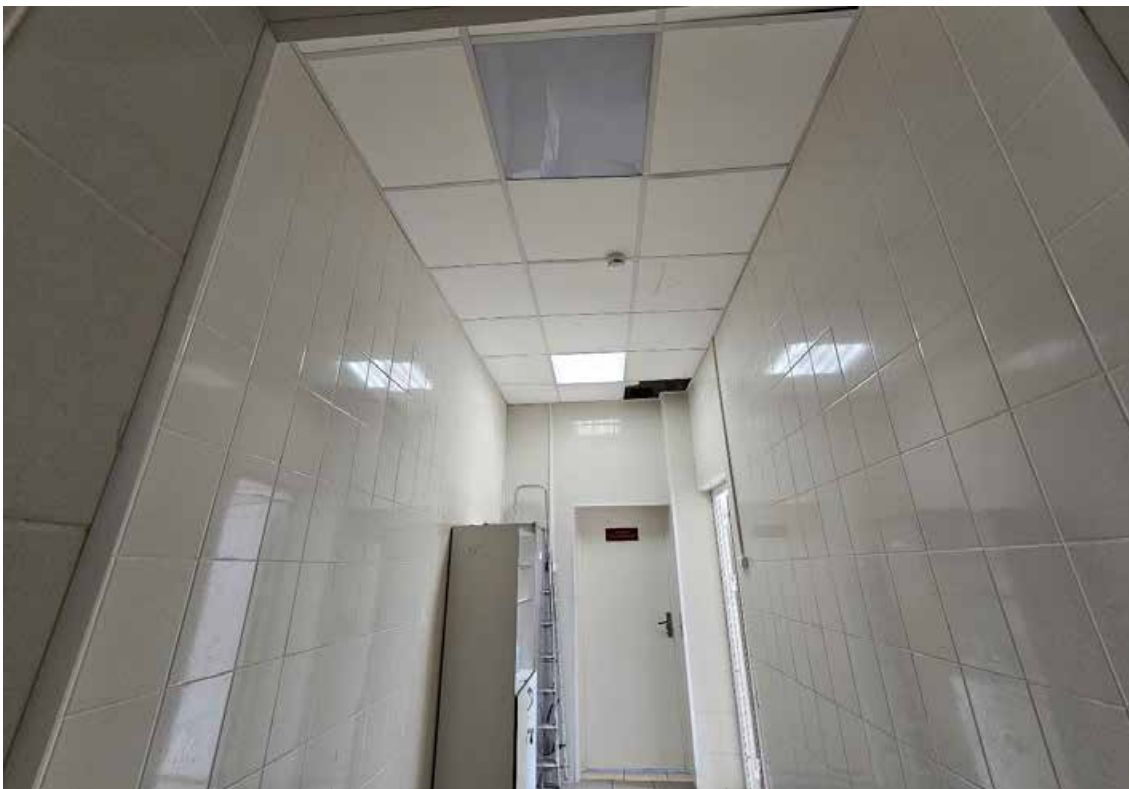
94. Объект культурного наследия регионального значения «Корпус № 2», по адресу: Санкт-Петербург, город Петергоф, Санкт-Петербургский проспект, дом 20, литера В, в составе объекта культурного наследия регионального значения «Комплекс дворцового госпиталя (с территорией)». Общий вид пом. 1-Н (87) в уровне 3-го этажа.
