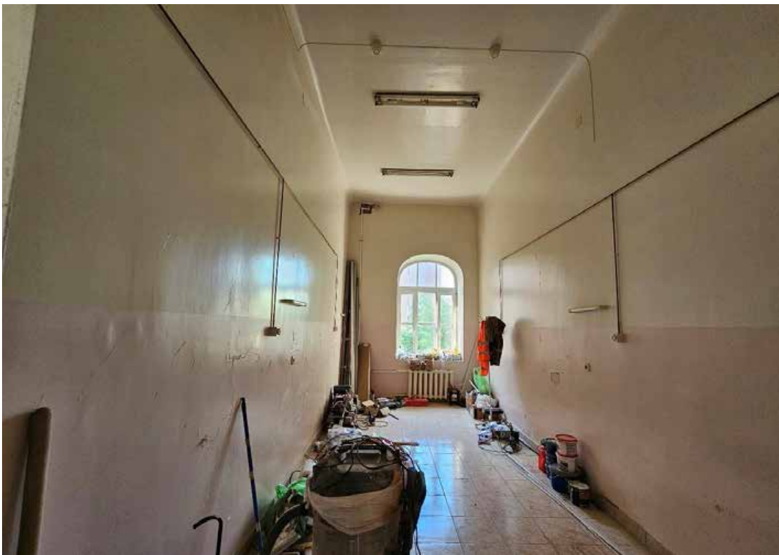
51. Объект культурного наследия регионального значения «Корпус № 2», по адресу: Санкт-Петербург, город Петергоф, Санкт-Петербургский проспект, дом 20, литера В, в составе объекта культурного наследия регионального значения «Комплекс дворцового госпиталя (с территорией)». Общий вид пом. 1-Н (46) в уровне 2-го этажа.
