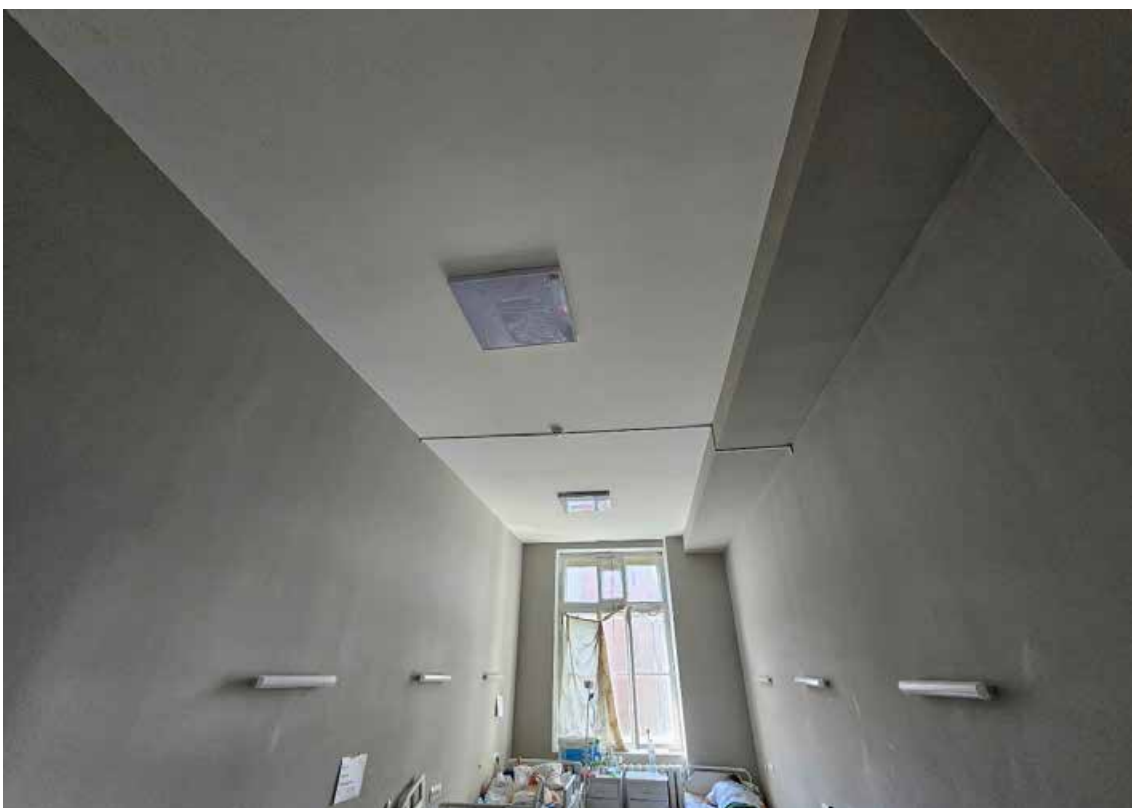
77. Объект культурного наследия регионального значения «Корпус № 2», по адресу: Санкт-Петербург, город Петергоф, Санкт-Петербургский проспект, дом 20, литера В, в составе объекта культурного наследия регионального значения «Комплекс дворцового госпиталя (с территорией)». Общий вид пом. 1-Н (92) в уровне 3-го этажа.
