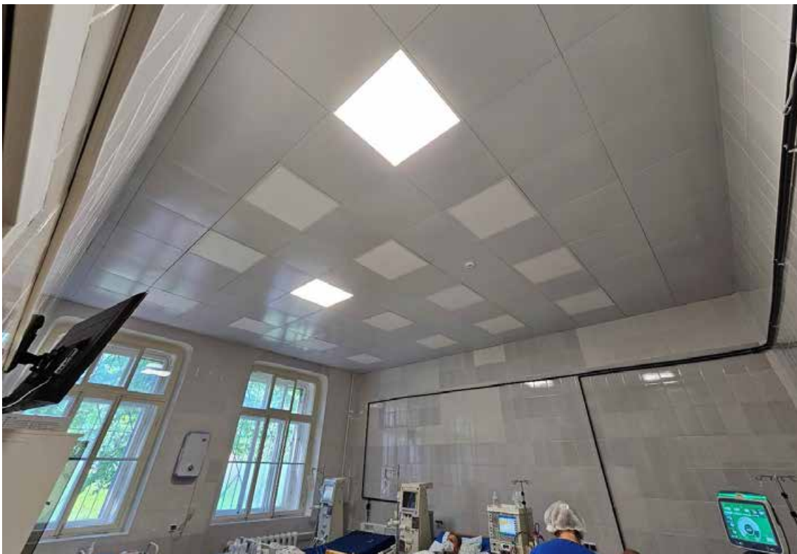
42. Объект культурного наследия регионального значения «Корпус № 2», по адресу: Санкт-Петербург, город Петергоф, Санкт-Петербургский проспект, дом 20, литера В, в составе объекта культурного наследия регионального значения «Комплекс дворцового госпиталя (с территорией)». Общий вид пом. 1-Н (27) в уровне 1-го этажа.
