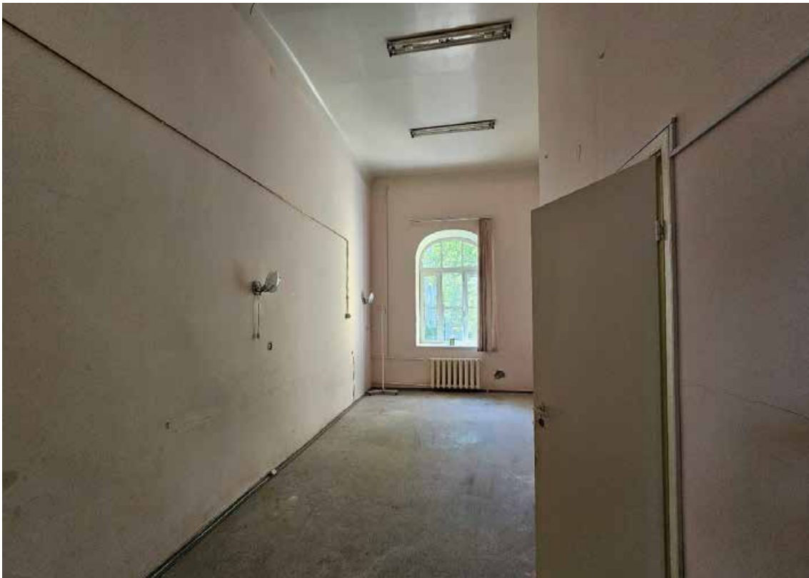
53. Объект культурного наследия регионального значения «Корпус № 2», по адресу: Санкт-Петербург, город Петергоф, Санкт-Петербургский проспект, дом 20, литера В, в составе объекта культурного наследия регионального значения «Комплекс дворцового госпиталя (с территорией)». Общий вид пом. 1-Н (48) в уровне 2-го этажа.
