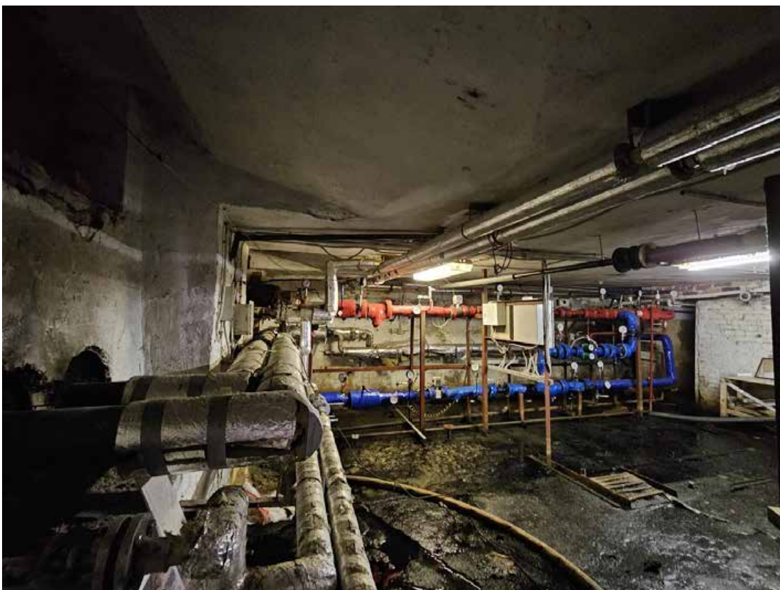
11. Объект культурного наследия регионального значения «Корпус № 2», по адресу: Санкт-Петербург, город Петергоф, Санкт-Петербургский проспект, дом 20, литера В, в составе объекта культурного наследия регионального значения «Комплекс дворцового госпиталя (с территорией)». Общий вид пом. 2-Н (1) в уровне подвала.
