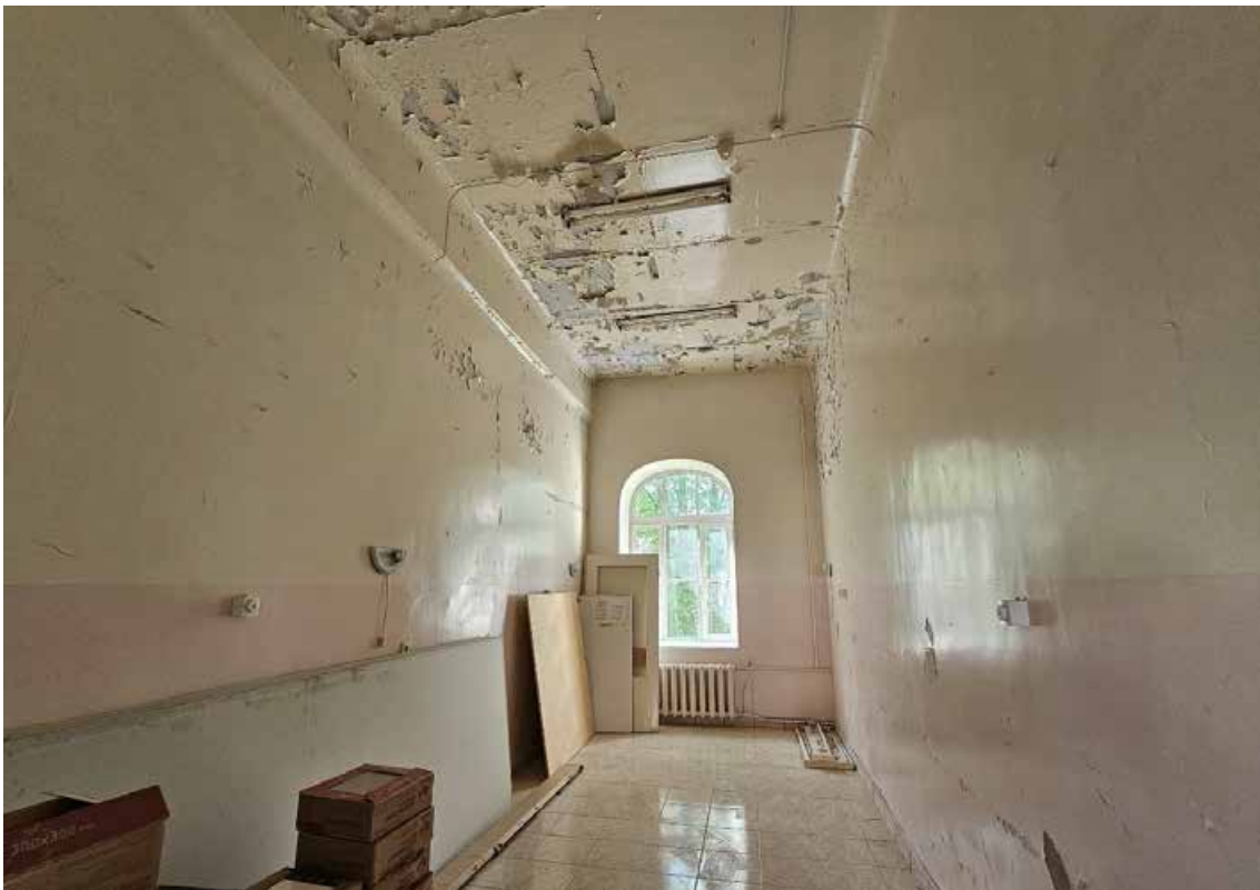
60. Объект культурного наследия регионального значения «Корпус № 2», по адресу: Санкт-Петербург, город Петергоф, Санкт-Петербургский проспект, дом 20, литера В, в составе объекта культурного наследия регионального значения «Комплекс дворцового госпиталя (с территорией)». Общий вид пом. 1-Н (57) в уровне 2-го этажа.
