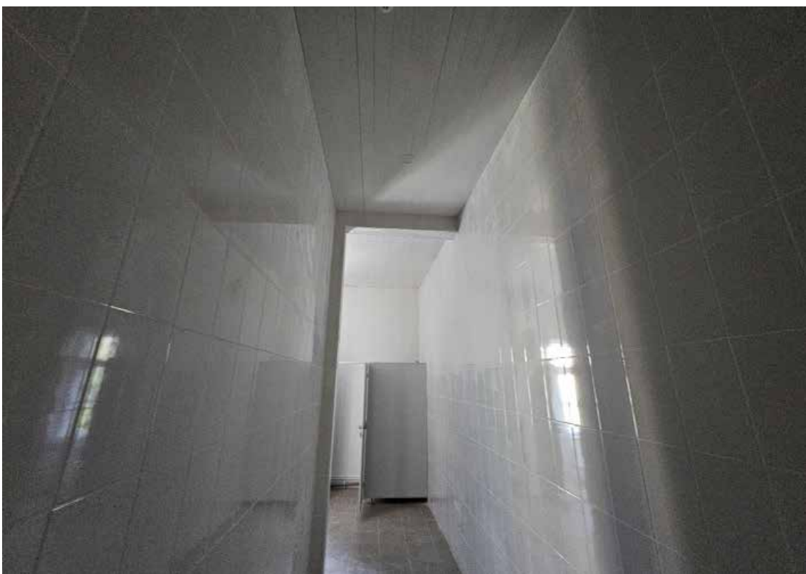
48. Объект культурного наследия регионального значения «Корпус № 2», по адресу: Санкт-Петербург, город Петергоф, Санкт-Петербургский проспект, дом 20, литера В, в составе объекта культурного наследия регионального значения «Комплекс дворцового госпиталя (с территорией)». Общий вид пом. 1-Н (78) в уровне 2-го этажа.
