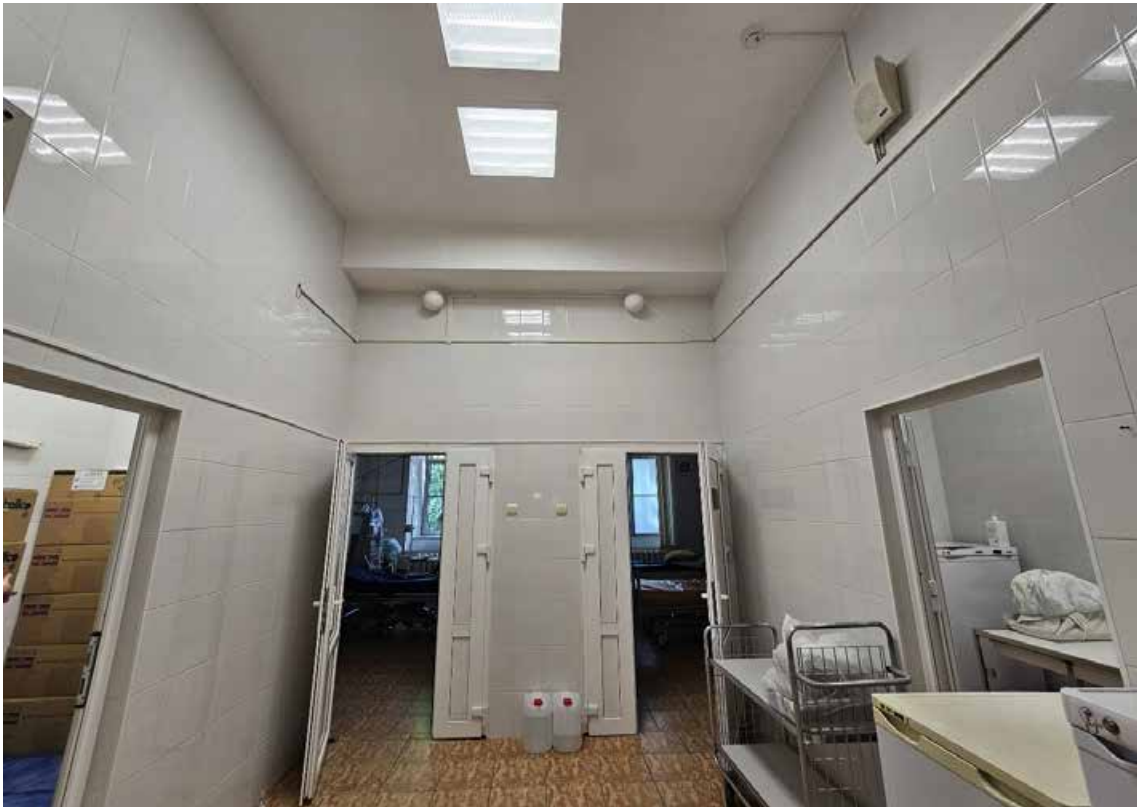
23. Объект культурного наследия регионального значения «Корпус № 2», по адресу: Санкт-Петербург, город Петергоф, Санкт-Петербургский проспект, дом 20, литера В, в составе объекта культурного наследия регионального значения «Комплекс дворцового госпиталя (с территорией)». Общий вид пом. 1-Н (11) в уровне 1-го этажа.
