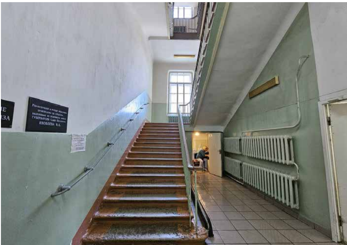
13. Объект культурного наследия регионального значения «Корпус № 2», по адресу: Санкт-Петербург, город Петергоф, Санкт-Петербургский проспект, дом 20, литера В, в составе объекта культурного наследия регионального значения «Комплекс дворцового госпиталя (с территорией)». Общий вид междуэтажной лестницы в восточной части здания в уровне 1-го этажа (пом. 1-Н (2)).
