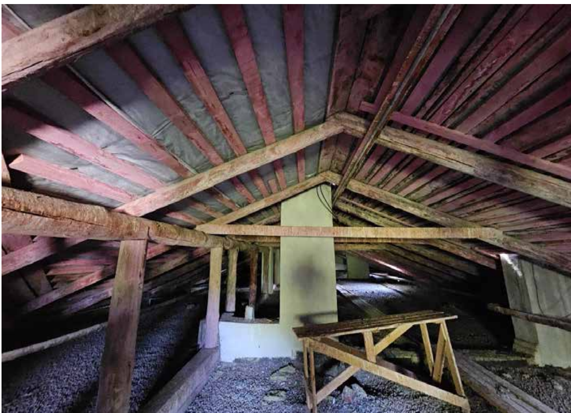
96. Объект культурного наследия регионального значения «Корпус № 2», по адресу: Санкт-Петербург, город Петергоф, Санкт-Петербургский проспект, дом 20, литера В, в составе объекта культурного наследия регионального значения «Комплекс дворцового госпиталя (с территорией)». Общий вид стропильной системы крыши.
