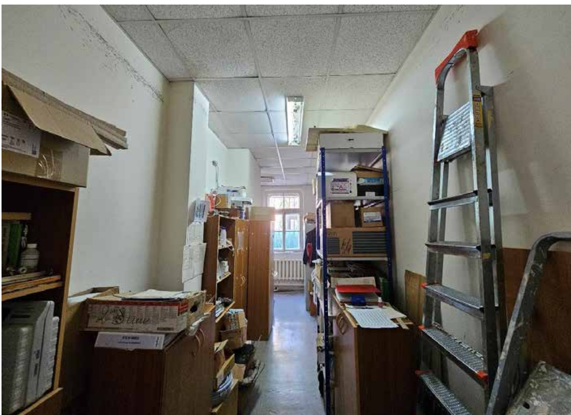
15. Объект культурного наследия регионального значения «Корпус № 2», по адресу: Санкт-Петербург, город Петергоф, Санкт-Петербургский проспект, дом 20, литера В, в составе объекта культурного наследия регионального значения «Комплекс дворцового госпиталя (с территорией)». Общий вид пом. 1-Н (37) в уровне 1-го этажа.
