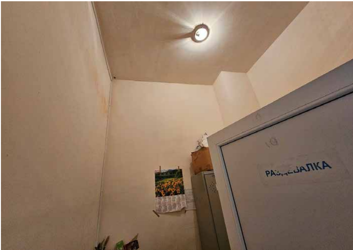
86. Объект культурного наследия регионального значения «Корпус № 2», по адресу: Санкт-Петербург, город Петергоф, Санкт-Петербургский проспект, дом 20, литера В, в составе объекта культурного наследия регионального значения «Комплекс дворцового госпиталя (с территорией)». Общий вид пом. 1-Н (99) в уровне 3-го этажа.
