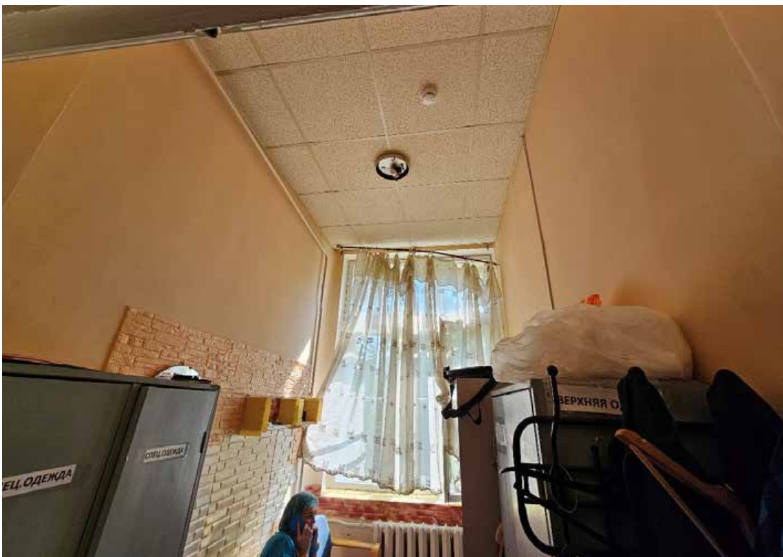
69. Объект культурного наследия регионального значения «Корпус № 2», по адресу: Санкт-Петербург, город Петергоф, Санкт-Петербургский проспект, дом 20, литера В, в составе объекта культурного наследия регионального значения «Комплекс дворцового госпиталя (с территорией)». Общий вид пом. 1-Н (84) в уровне 3-го этажа.
