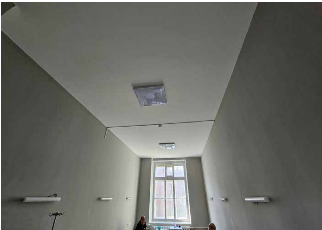
78. Объект культурного наследия регионального значения «Корпус № 2», по адресу: Санкт-Петербург, город Петергоф, Санкт-Петербургский проспект, дом 20, литера В, в составе объекта культурного наследия регионального значения «Комплекс дворцового госпиталя (с территорией)». Общий вид пом. 1-Н (93) в уровне 3-го этажа.
