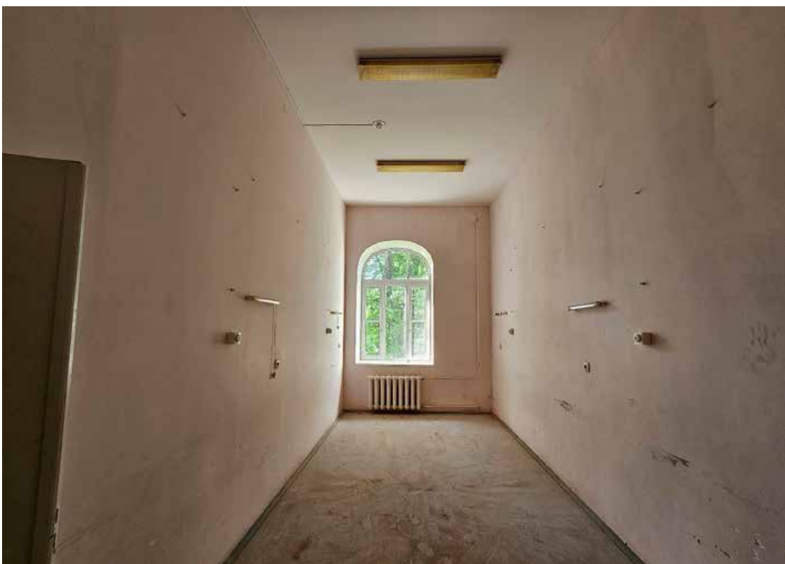
66. Объект культурного наследия регионального значения «Корпус № 2», по адресу: Санкт-Петербург, город Петергоф, Санкт-Петербургский проспект, дом 20, литера В, в составе объекта культурного наследия регионального значения «Комплекс дворцового госпиталя (с территорией)». Общий вид пом. 1-Н (65) в уровне 2-го этажа.
