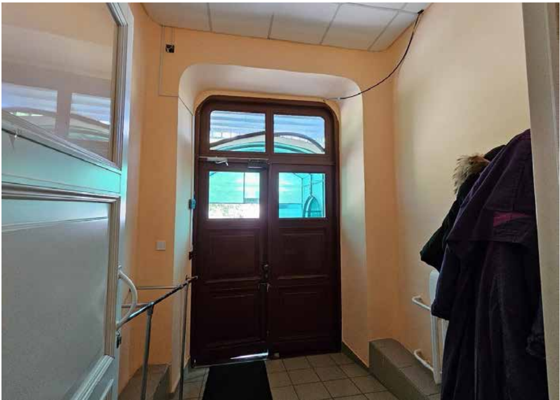
29. Объект культурного наследия регионального значения «Корпус № 2», по адресу: Санкт-Петербург, город Петергоф, Санкт-Петербургский проспект, дом 20, литера В, в составе объекта культурного наследия регионального значения «Комплекс дворцового госпиталя (с территорией)». Общий вид пом. 1-Н (33) в уровне 1-го этажа.
