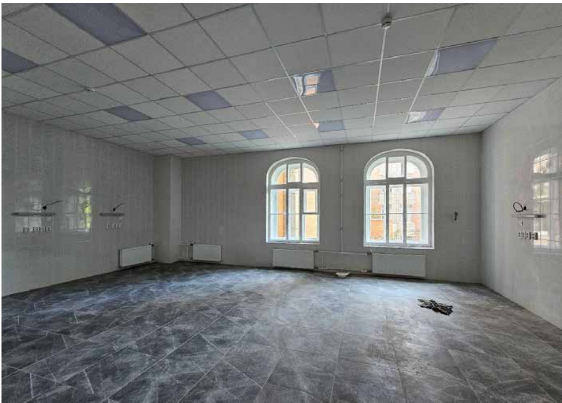
47. Объект культурного наследия регионального значения «Корпус № 2», по адресу: Санкт-Петербург, город Петергоф, Санкт-Петербургский проспект, дом 20, литера В, в составе объекта культурного наследия регионального значения «Комплекс дворцового госпиталя (с территорией)». Общий вид пом. 1-Н (43) в уровне 2-го этажа.
