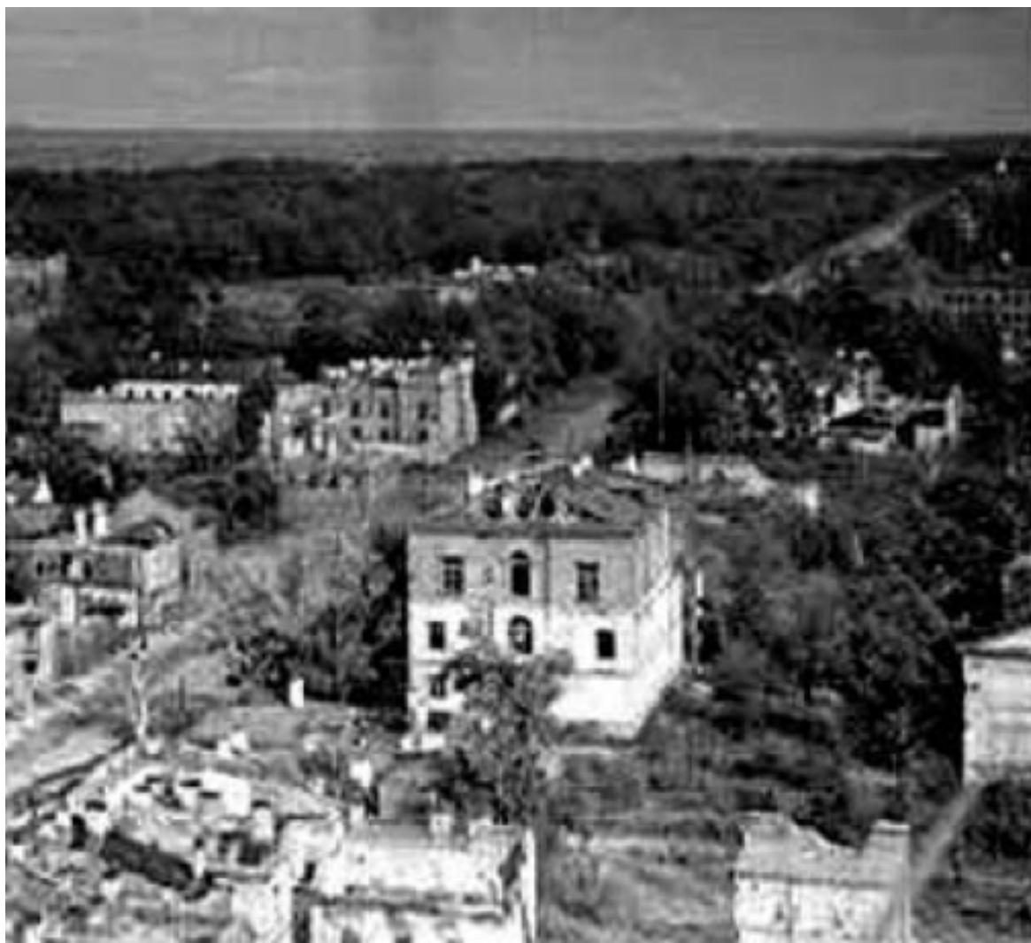
10. Территория госпиталя (бывшего дворцового госпиталя). 1944 г. ЦГАКФФД Бр 587963.
