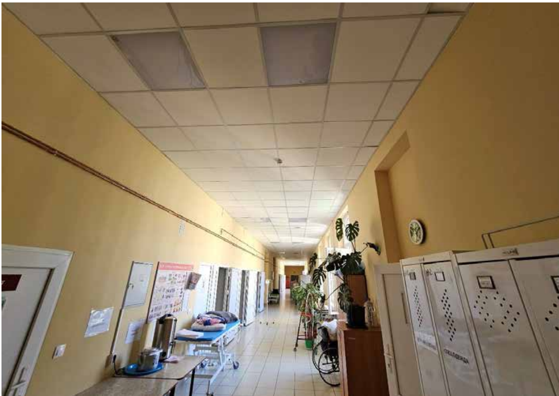
71. Объект культурного наследия регионального значения «Корпус № 2», по адресу: Санкт-Петербург, город Петергоф, Санкт-Петербургский проспект, дом 20, литера В, в составе объекта культурного наследия регионального значения «Комплекс дворцового госпиталя (с территорией)». Общий вид пом. 1-Н (87) в уровне 3-го этажа.
