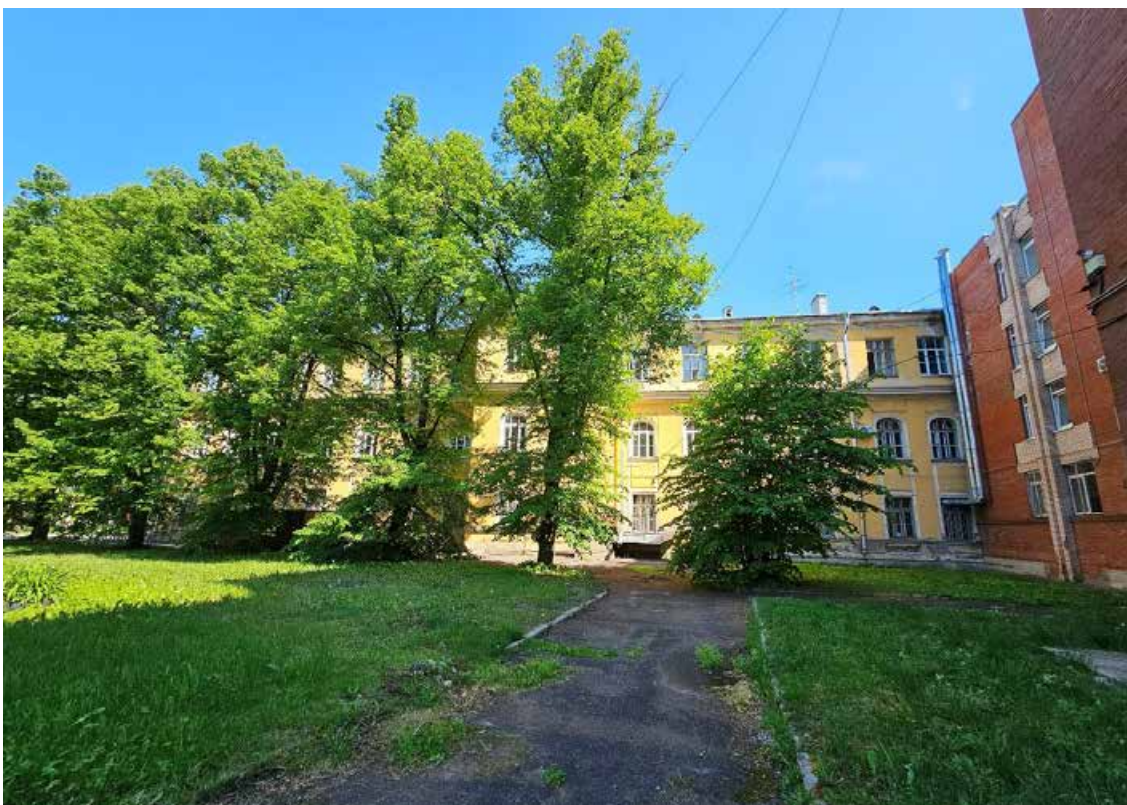
7. Объект культурного наследия регионального значения «Корпус № 2», по адресу: Санкт-Петербург, город Петергоф, Санкт-Петербургский проспект, дом 20, литера В, в составе объекта культурного наследия регионального значения «Комплекс дворцового госпиталя (с территорией)». Вид на южный дворовый фасад.
