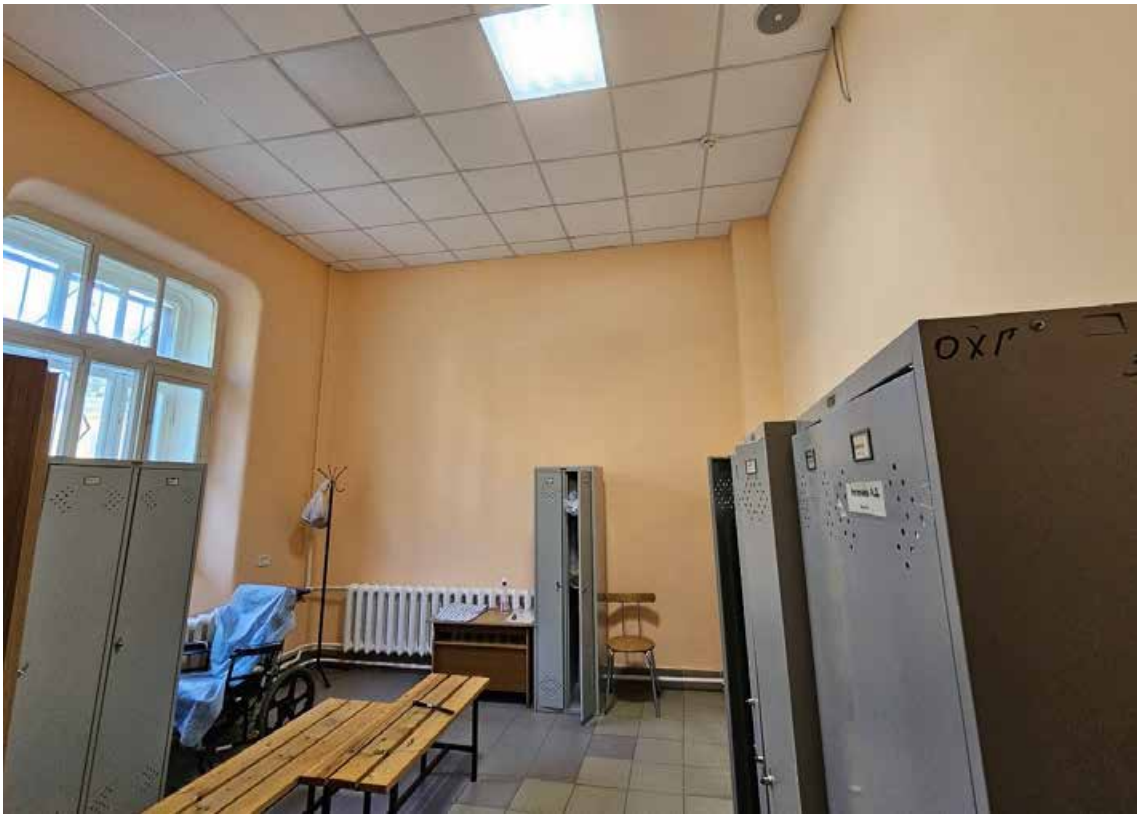
28. Объект культурного наследия регионального значения «Корпус № 2», по адресу: Санкт-Петербург, город Петергоф, Санкт-Петербургский проспект, дом 20, литера В, в составе объекта культурного наследия регионального значения «Комплекс дворцового госпиталя (с территорией)». Общий вид пом. 1-Н (36) в уровне 1-го этажа.
