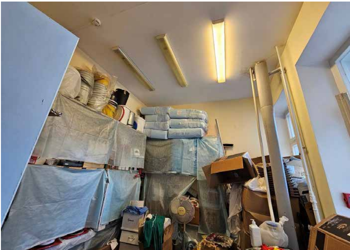
39. Объект культурного наследия регионального значения «Корпус № 2», по адресу: Санкт-Петербург, город Петергоф, Санкт-Петербургский проспект, дом 20, литера В, в составе объекта культурного наследия регионального значения «Комплекс дворцового госпиталя (с территорией)». Общий вид пом. 1-Н (32) в уровне 1-го этажа.
