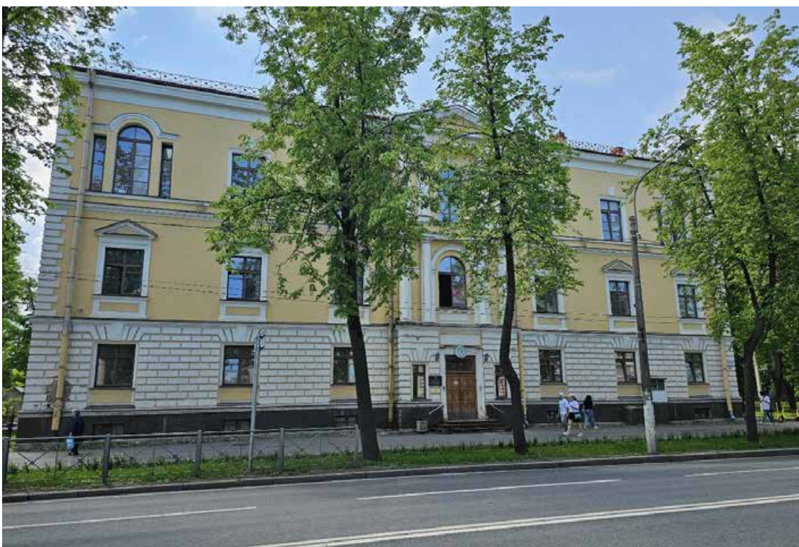
2. Объект культурного наследия регионального значения «Главный корпус», по адресу: Санкт-Петербург, г. Петергоф, Санкт-Петербургский пр., д. 20, лит. А, в составе объекта культурного наследия регионального значения «Комплекс дворцового госпиталя (с территорией)». Общий вид северного лицевого фасада по Санкт-Петербургскому проспекту.
