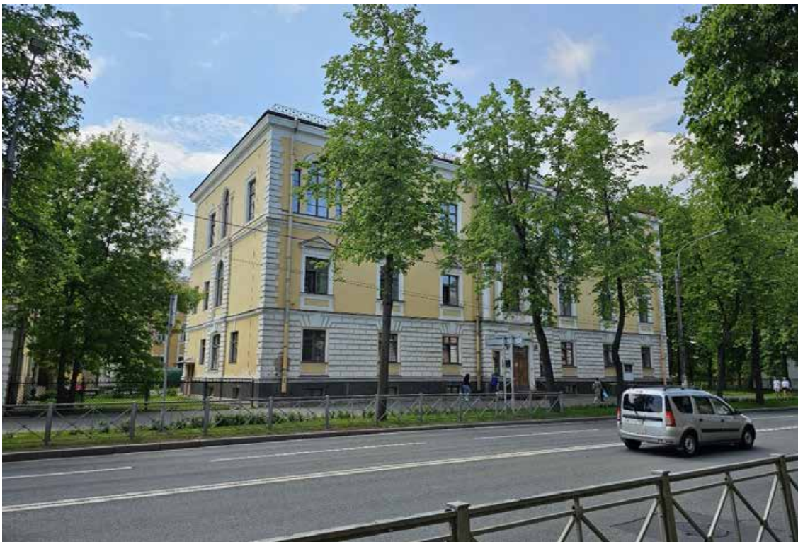
3. Объект культурного наследия регионального значения «Главный корпус», по адресу: Санкт-Петербург, г. Петергоф, Санкт-Петербургский пр., д. 20, лит. А, в составе объекта культурного наследия регионального значения «Комплекс дворцового госпиталя (с территорией)». Общий вид объекта с северо-востока – северный лицевой и восточный торцевой фасады.
