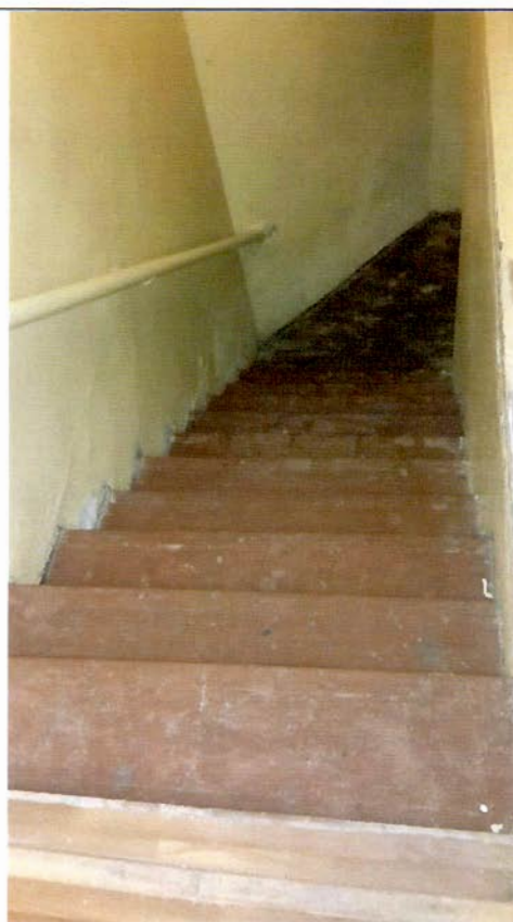
Фото 6. Интерьер. Лестница. Общий вид. 22.12.2016.
