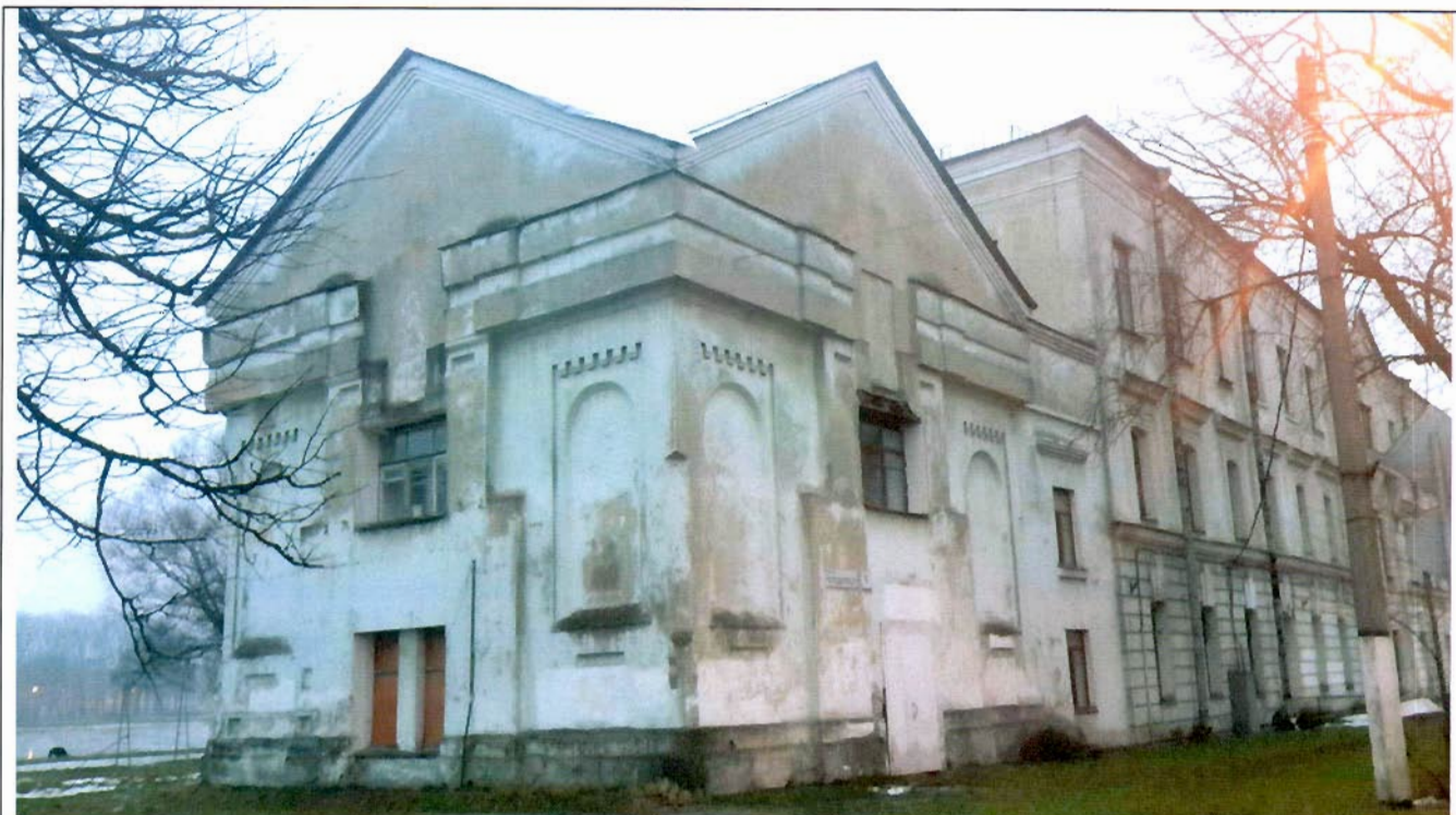
Фото 1. Западный, северный фасады. Общий вид. 22.12.2016.
