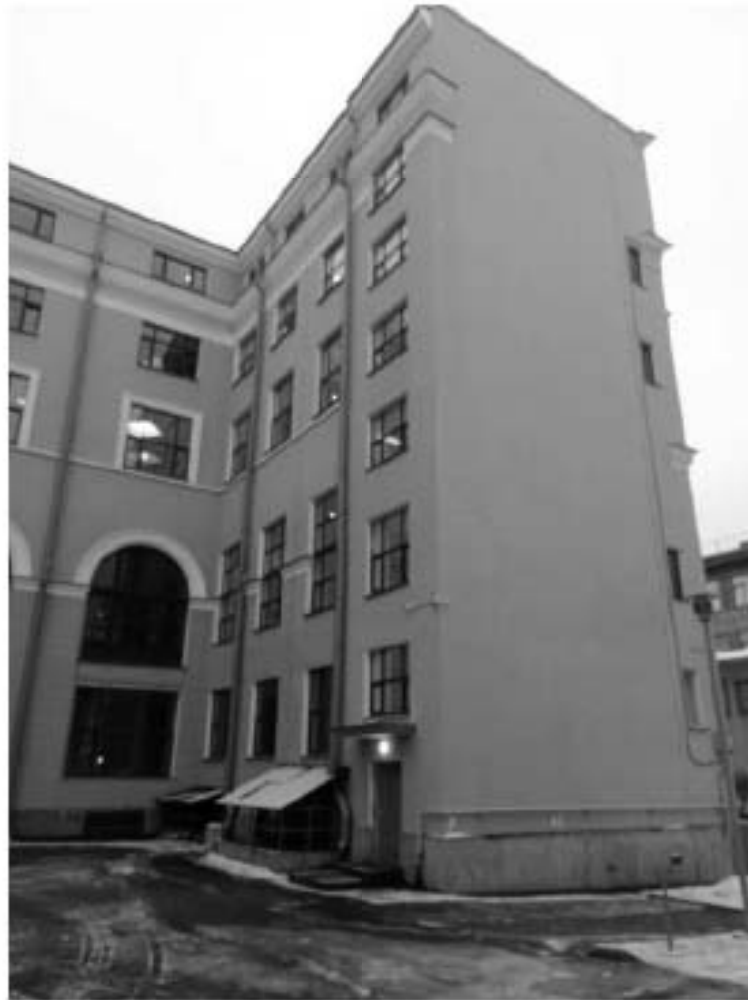
41. ОКНРЗ «Дворец пушкинъ». Торец северного ризалита восточного фасада. Вид на северо-запад. Дата съёмки: 15.01.2024г.
