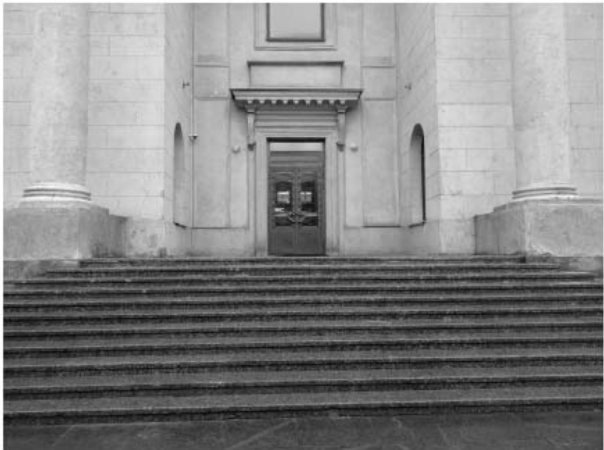
17. ОКНРЗ «Дворец пушкинъ». Фрагмент центральной части западного фасада (портика). Дата съёмки: 15.01.2024г.
