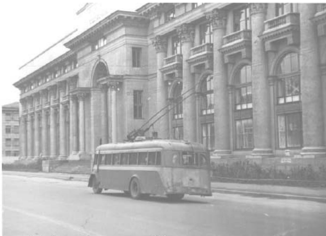
79. Вид фасада Дворца пушкины на Международном проспекте, где в аукционном и выставочном залах проводятся реставрационные работы. 1945г. ЦГАКФФД СПб. Ар 6848.
