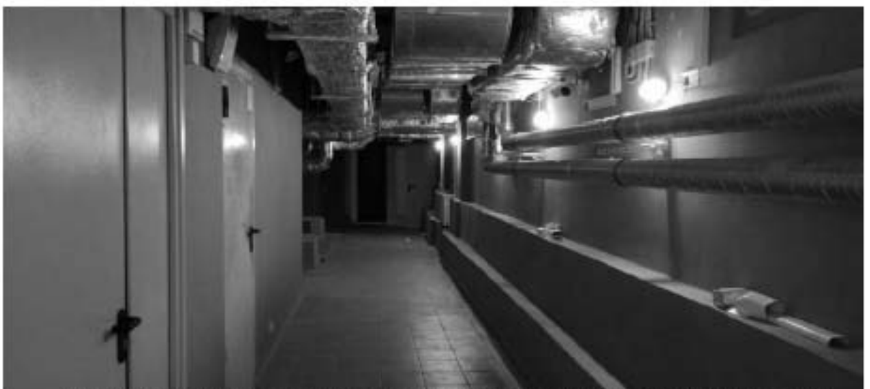
9. ОКНРЗ «Дворец пушкинъ». Интерьер подвального этажа. Фрагмент конструктивной системы – колонны. Дата дополнительной съёмки: 15.07.2024г.
