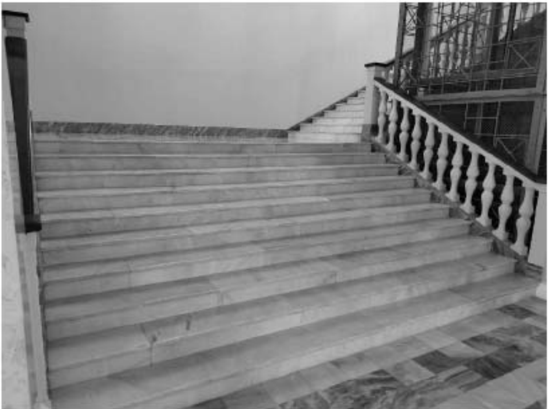
6. ОКНРЗ «Дворец пушкинъ». Вид на помещение парадной лестницы: мраморная облицовка ступеней и межлестничных площадок, балюстрада парадной лестницы, деревянные профилированные перила. Дата дополнительной съёмки: 15.07.2024г.
