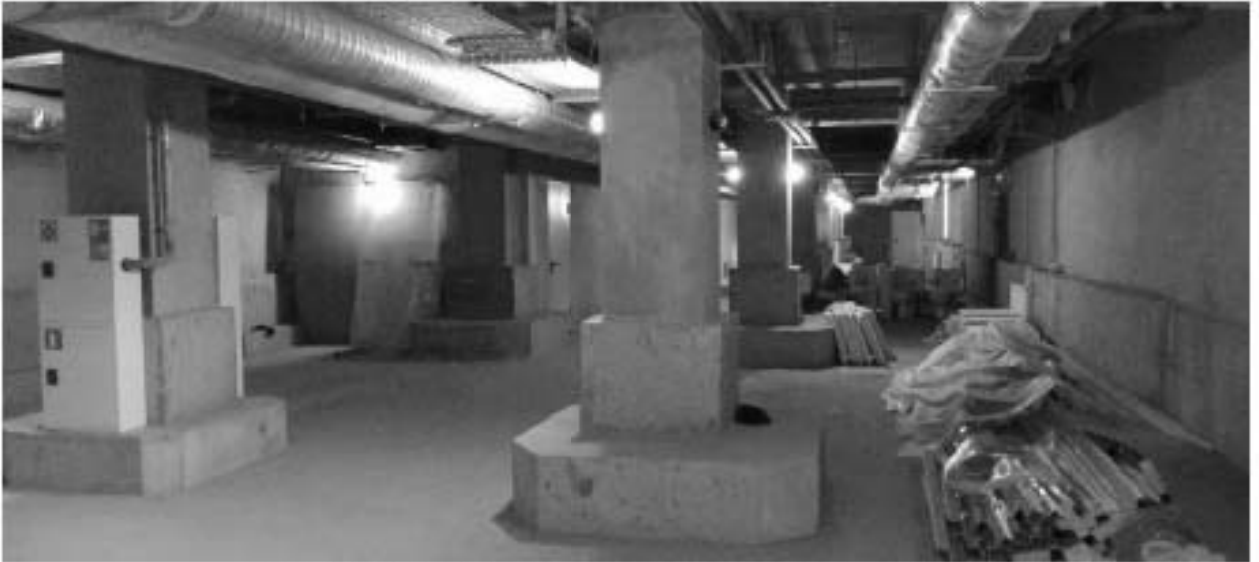
10. ОКНРЗ «Дворец пушнины». Интерьер подвального этажа. Фрагмент конструктивной системы – колонны. Дата дополнительной съёмки: 15.07.2024г.
