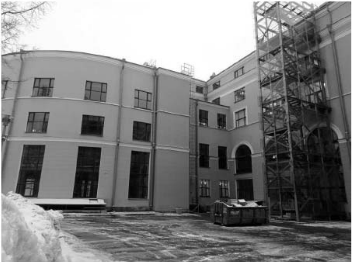
39. ОКНРЗ «Дворец пушкинь». Фрагмент северной части восточного фасада. Вид на юго-запад. Дата съёмки: 15.01.2024г.
