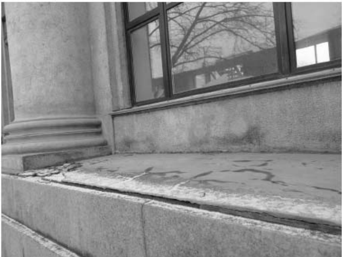
9. ОКНРЗ «Дворец пушкины». Фрагмент южной части западного фасада. Дата съёмки: 15.01.2024г.
