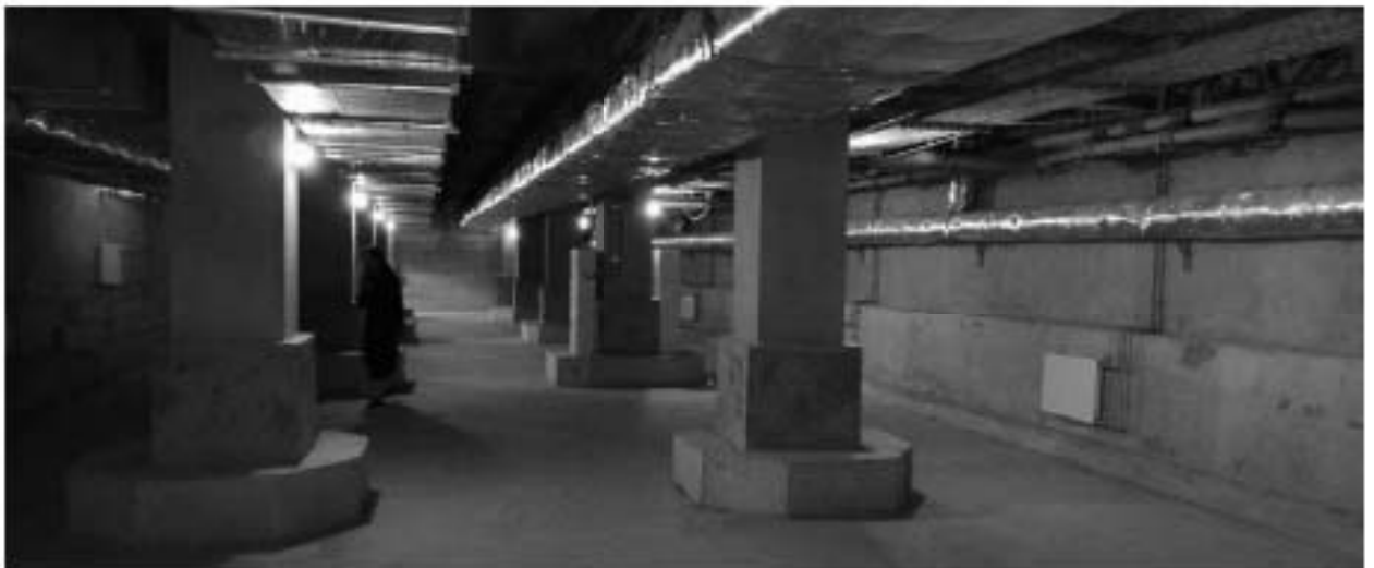
8. ОКНРЗ «Дворец пушкинъ». Интерьер подвального этажа. Фрагмент конструктивной системы – колонны. Дата дополнительной съёмки: 15.07.2024г.
