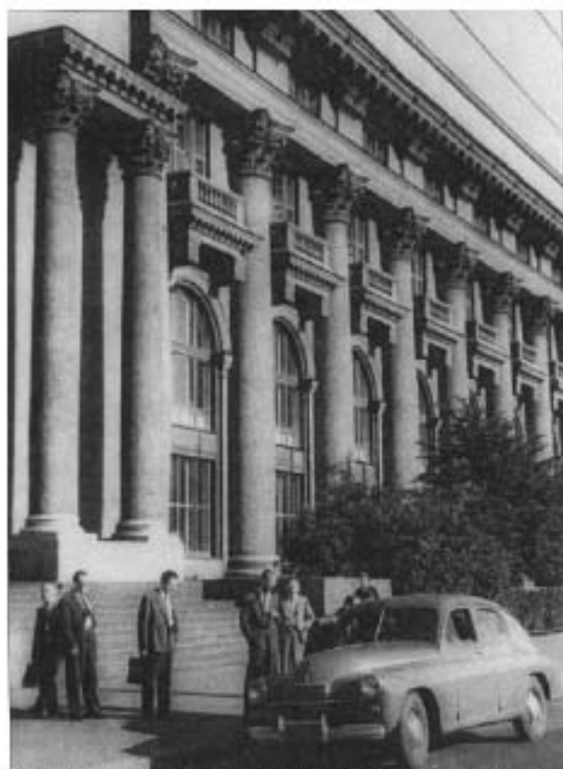
82. Вид части фасада здания «Союзпушнина» на проспекте имени Сталина. 1951г. ЦГАКФФД СПб. Ар 54401.
