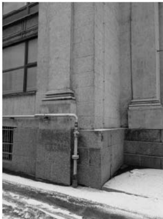
26. ОКНРЗ «Дворец пушкинъ». Фрагмент западной части северного фасада. Вид на юго-восток. Дата съёмки: 15.01.2024г.
