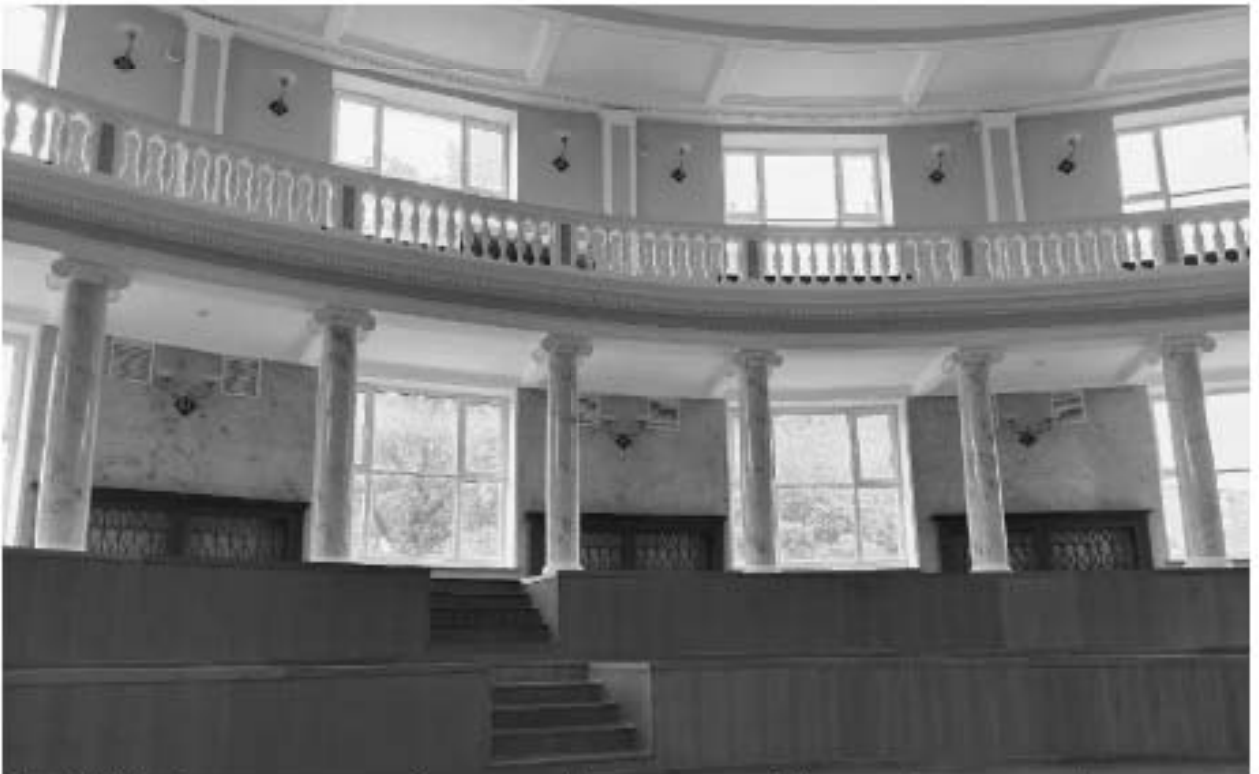
13. ОКНРЗ «Дворец пушкины». Аукционный зал: двухсветный зал с амфитеатром, с балконом с балюстрадным ограждением по полуокружности амфитеатра. Дата дополнительной съёмки: 15.07.2024г.
