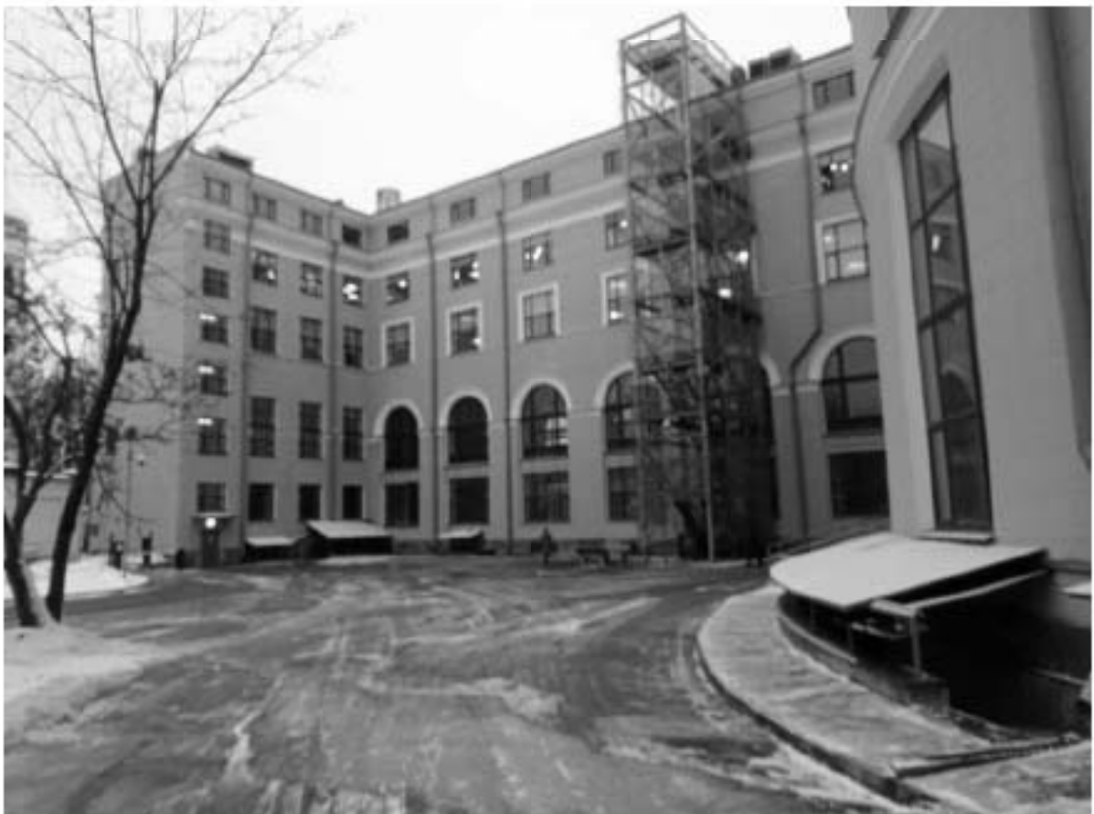
31. ОКНРЗ «Дворец пушкин». Южная часть восточного фасада. Вид на запад. Дата съёмки: 15.01.2024г.
