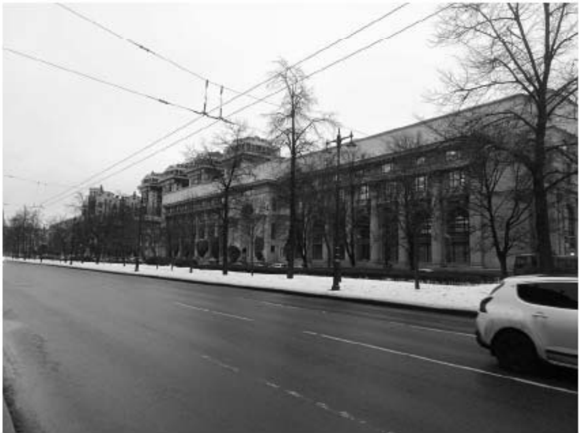
3. ОКНРЗ «Дворец пушкинъ». Южная часть западного фасада. Вид на северо-восток с Московского проспекта. Дата съёмки: 15.01.2024г.
