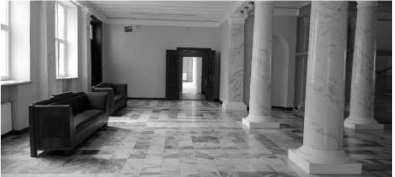
3. ОКНРЗ «Дворец пушкины». Дверные проемы с деревянным филёнчатým заполнением. Пол с облицовкой из плит серого и белого мрамора геометрического рисунка. Дата дополнительной съёмки: 15.07.2024г.
