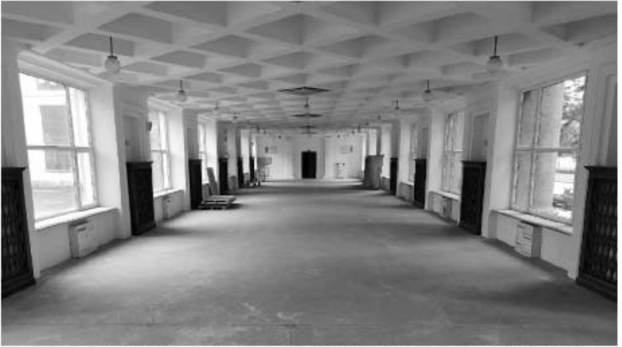
5. ОКНРЗ «Дворец пушкинъ». Вид на междуэтажные перекрытия. Оформление потолка. Ниши в межоконных простенках; профилированные порталы, обрамляющие ниши. Дата дополнительной съёмки: 15.07.2024г.
