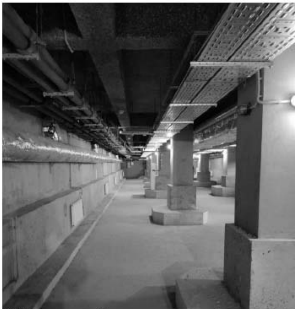
2. ОКНРЗ «Дворец пушкины». Интерьер подвального этажа. Фрагмент конструктивной системы – колонны. Дата дополнительной съёмки: 15.07.2024г.
