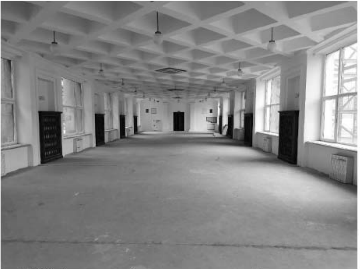
4. ОКНРЗ «Дворец пушкины». Вид на междуэтажные перекрытия (перекрестная система железобетонных балок с бетонным заполнением). Дата дополнительной съёмки: 15.07.2024г.
