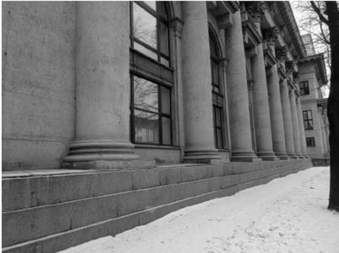
12. ОКНРЗ «Дворец пушкинь». Северная часть западного фасада. Вид на юго-восток. Дата съёмки: 15.01.2024г.
