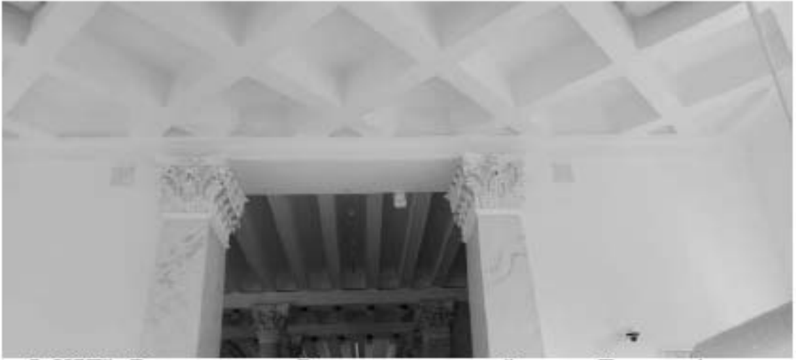
7. ОКНРЗ «Дворец пушкины». Вид на кессонированный потолок. Пилястры, фланкирующие входы, профилированный карниз. Дата дополнительной съёмки: 15.07.2024г.
