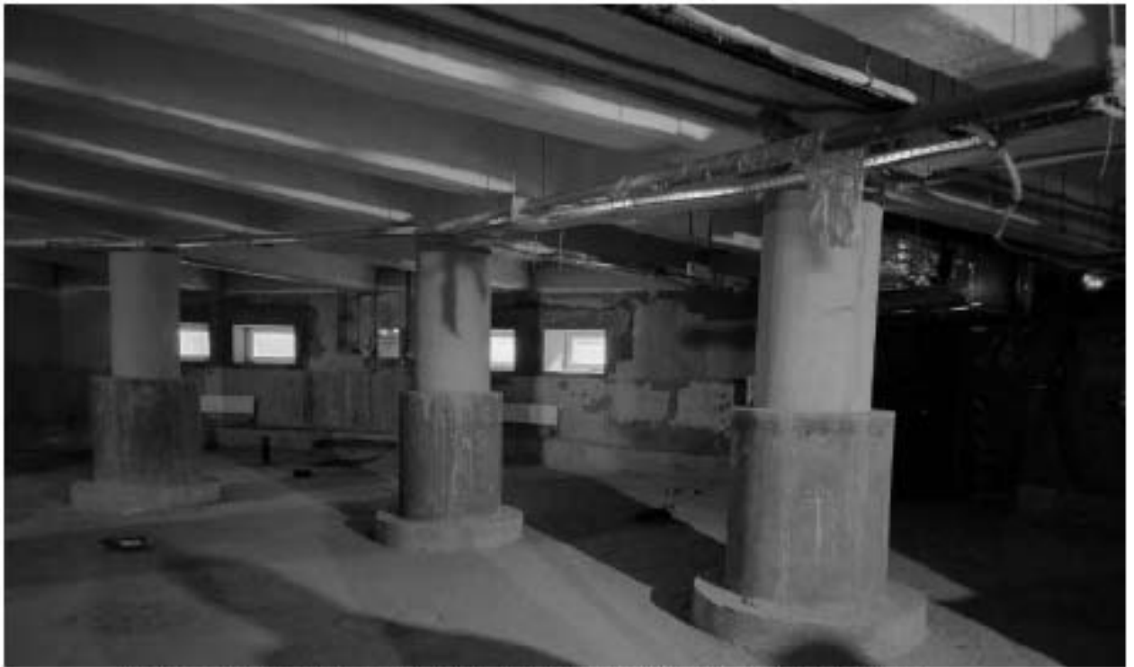
5. ОКНРЗ «Дворец пушкины». Интерьер подвального этажа. Фрагмент конструктивной системы – колонны. Дата дополнительной съёмки: 15.07.2024г.
