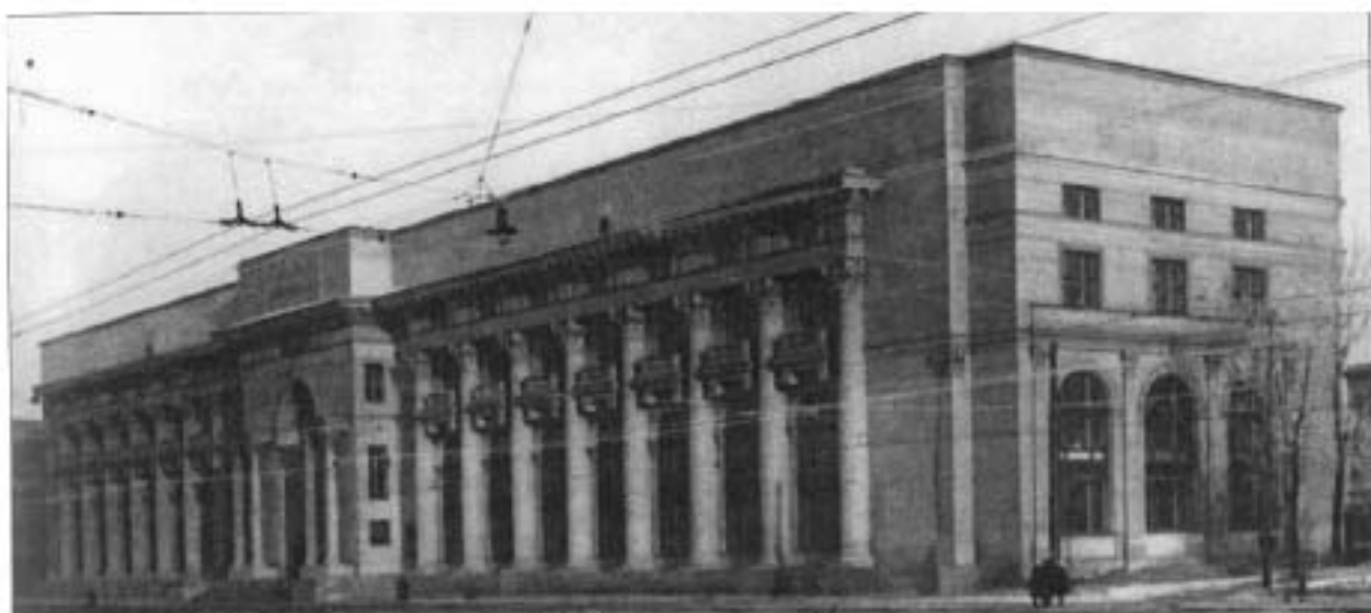
71. Вид на здание Дворца пушнина с юго-запада. 1939г. ЦГАКФФД СПб. Вр 37575.
