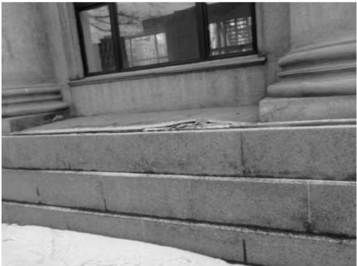
22. ОКНРЗ «Дворец пушкинский». Фрагмент северной части западного фасада. Дата съёмки: 15.01.2024г.
