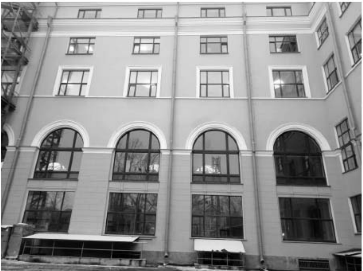
38. ОКНРЗ «Дворец пушкинъ». Фрагмент северной части восточного фасада. Дата съёмки: 15.01.2024г.
