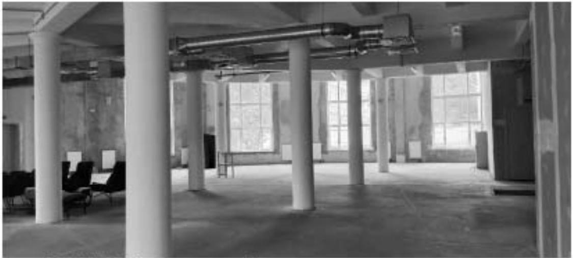
8. ОКНРЗ «Дворец пушкины». Вид на помещение под аукционным залом. Колонны и пилоны. Дата дополнительной съёмки: 15.07.2024г.
