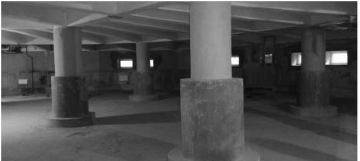
7. ОКНРЗ «Дворец пушкинъ». Интерьер подвального этажа. Фрагмент конструктивной системы – колонны и историческое перекрытие (перекрестная система железобетонных балок с бетонным заполнением). Дата дополнительной съёмки: 15.07.2024г.
