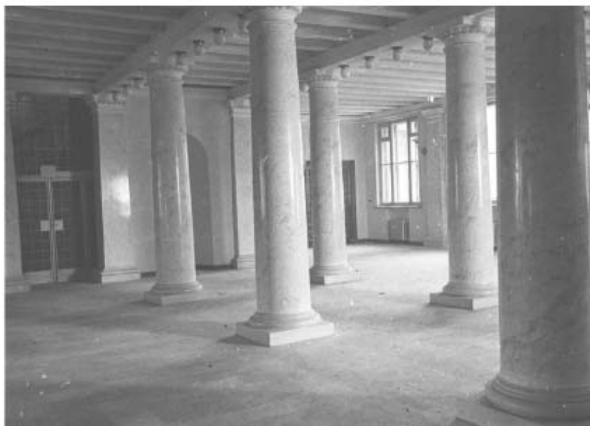
56. 1-й этаж. Вестибюль. 1938г. ЦГАКФФД СПб. Ар 129352.
