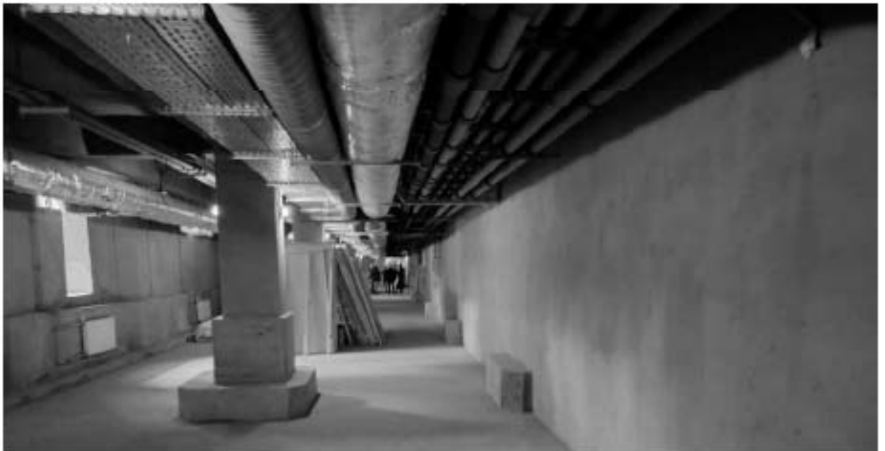
4. ОКНРЗ «Дворец пушкины». Интерьер подвального этажа. Фрагмент конструктивной системы – колонны. Дата дополнительной съёмки: 15.07.2024г.
