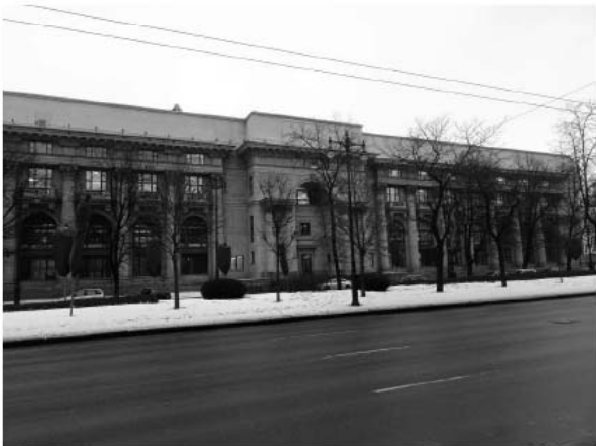
5. ОКНРЗ «Дворец пушкины». Центральная часть западного фасада. Вид на юго-восток с Московского проспекта. Дата съёмки: 15.01.2024г.
