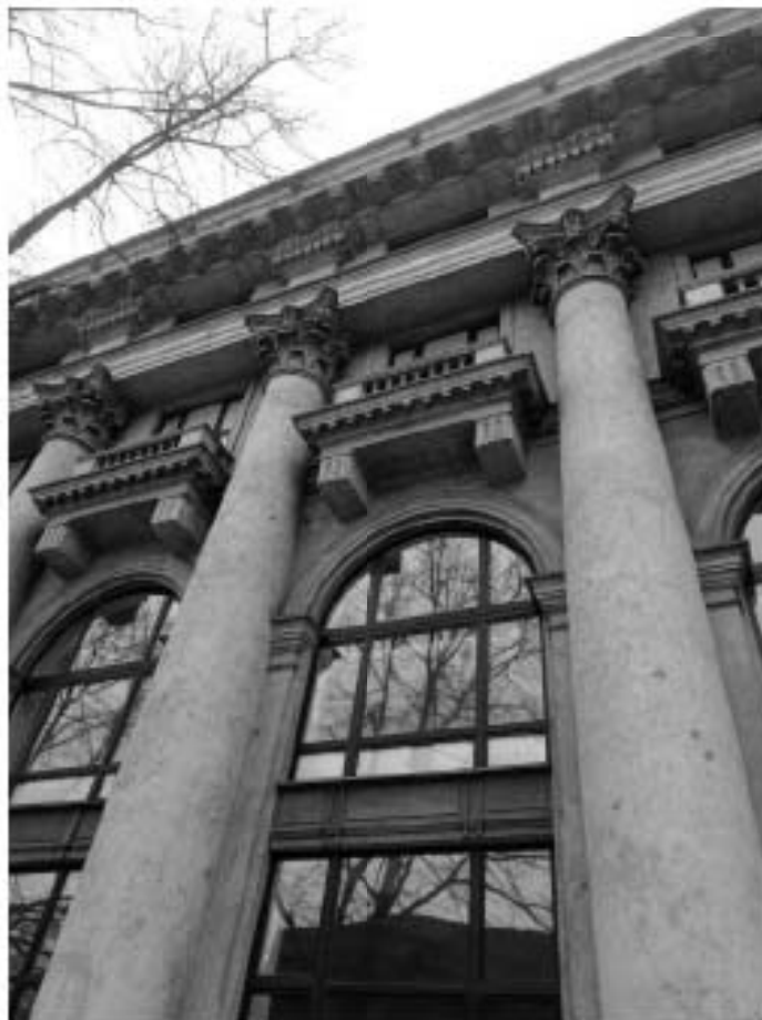
13. ОКНРЗ «Дворец пушкинь». Фрагмент северной части западного фасада. Дата съёмки: 15.01.2024г.
