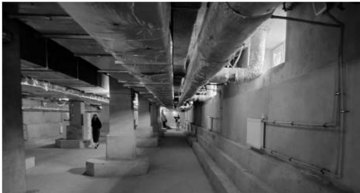
1. ОКНРЗ «Дворец пушкины». Интерьер подвального этажа. Фрагмент конструктивной системы – колонны. Дата дополнительной съёмки: 15.07.2024г.
