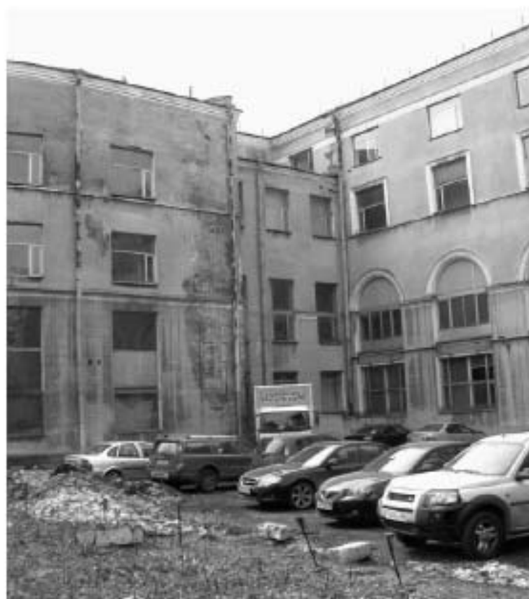
100. Дворовый фасад. Вид на примыкание аукционного зала к объему холлов. Фрагмент северного крыла. 2010г. ООО «БРК».
