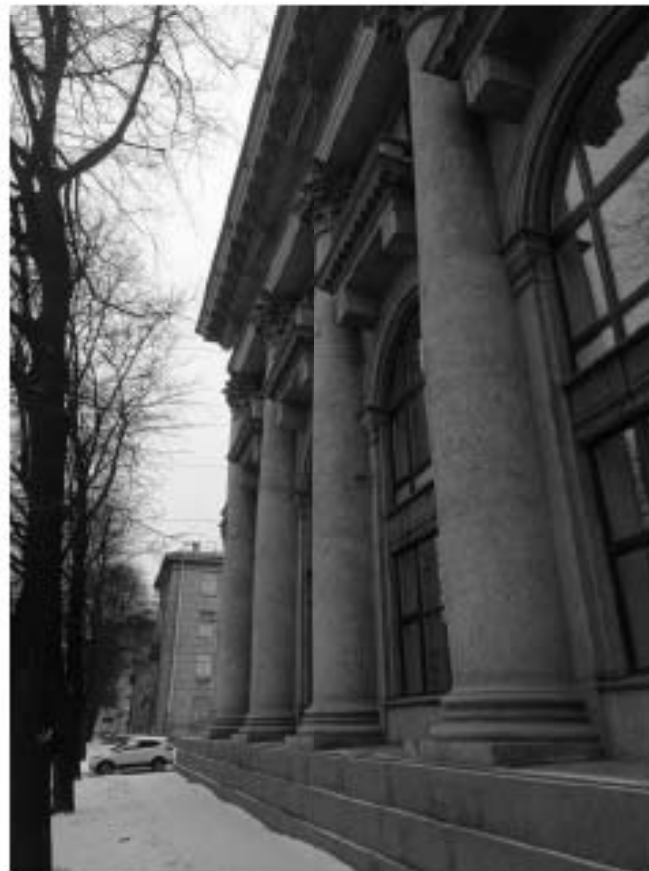
14. ОКНРЗ «Дворец пушкинь». Фрагмент северной части западного фасада. Дата съёмки: 15.01.2024г.
