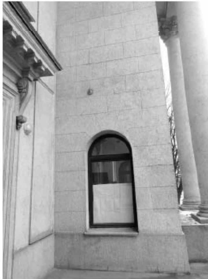
18. ОКНРЗ «Дворец пушкинъ». Фрагмент портика. Дата съёмки: 15.01.2024г.
