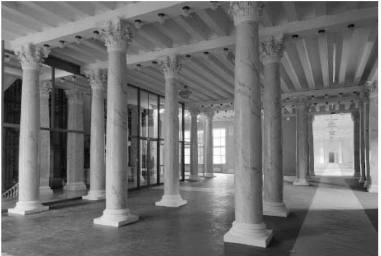
10. ОКНРЗ «Дворец пушнины». Вид холла второго этажа: колонны коринфского ордера, облицованные искусственным мрамором, поддерживающие потолочные балки; пилястры коринфского ордера. Оформление потолка – балки с профилем по краю. Дата дополнительной съёмки: 15.07.2024г.
