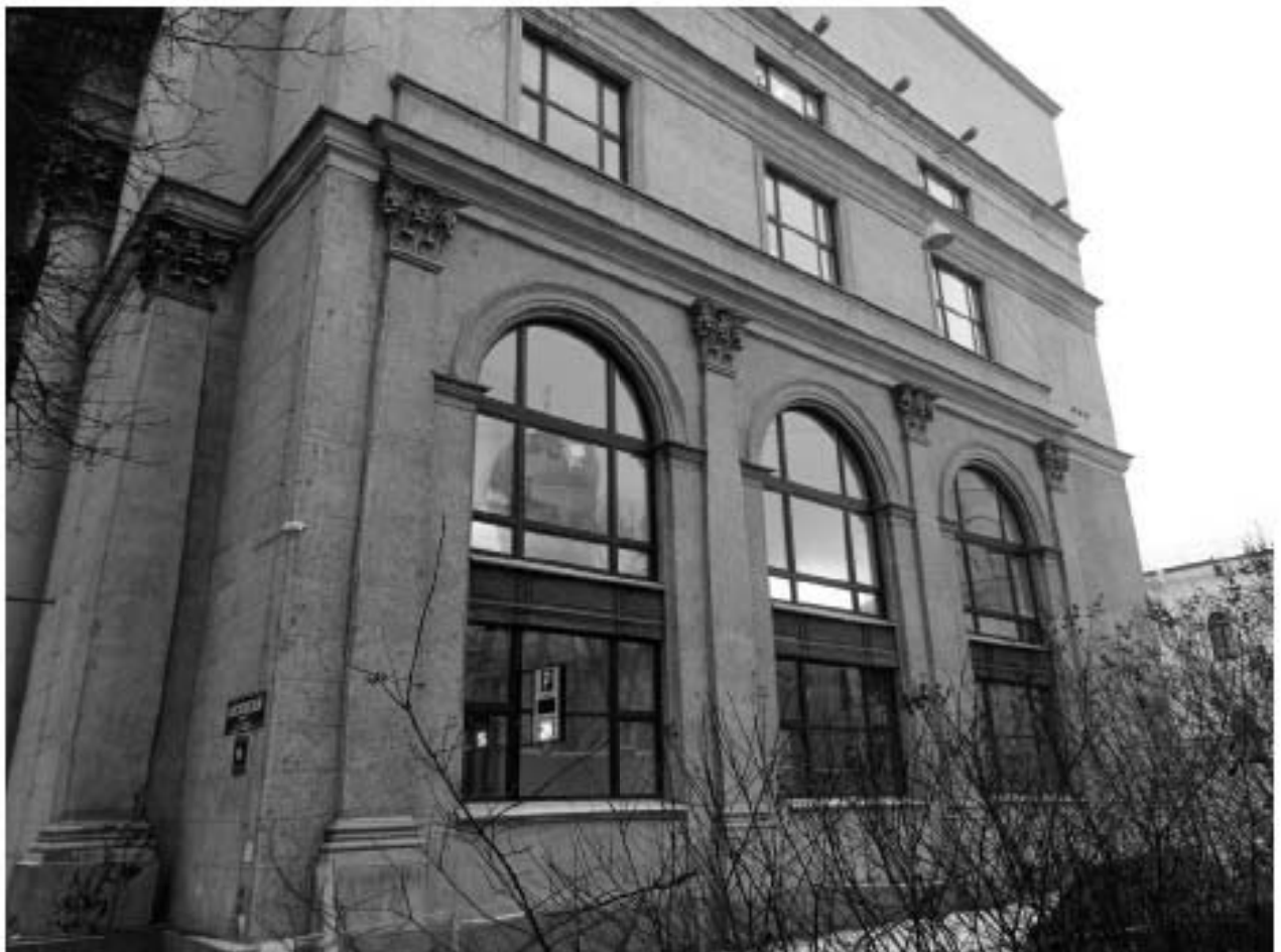
27. ОКНРЗ «Дворец пушкинский». Южный фасад. Вид на северо-восток. Дата съёмки: 15.01.2024г.
