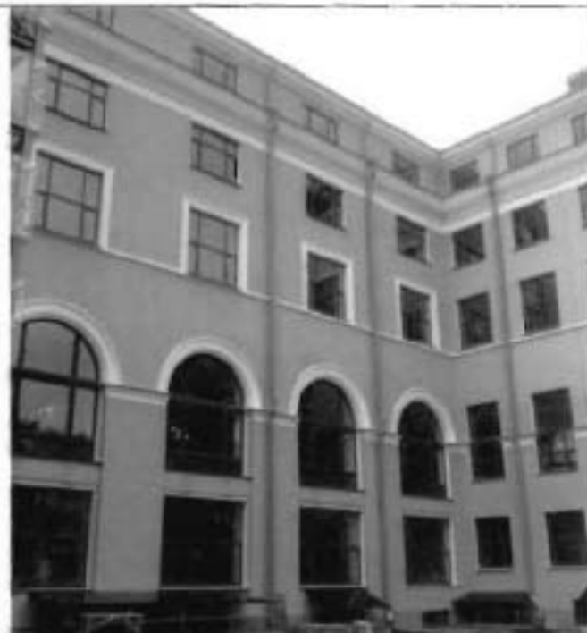
3. Фрагмент восточного фасада
