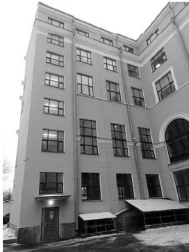
30. ОКНРЗ «Дворец пушкинъ». Южная часть восточного фасада. Вид на юго-запад. Дата съёмки: 15.01.2024г.
