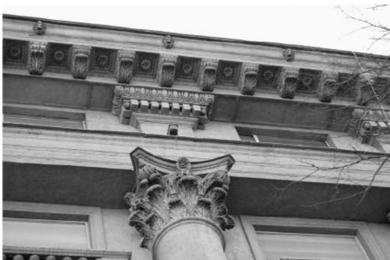
92. Лицевой фасад. Фрагмент. 2010г. ООО «БРК».
