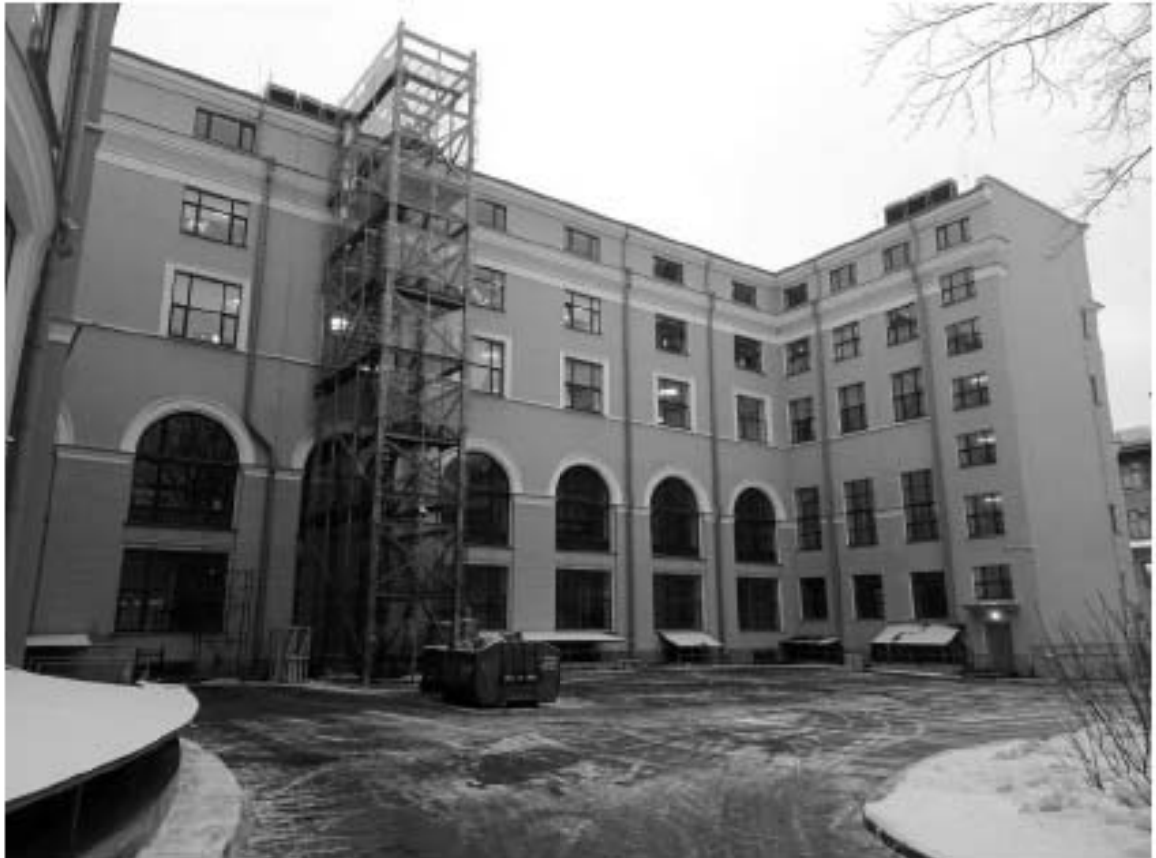
36. ОКНРЗ «Дворец пушкинь». Северная часть восточного фасада. Вид на северо-запад. Дата съёмки: 15.01.2024г.
