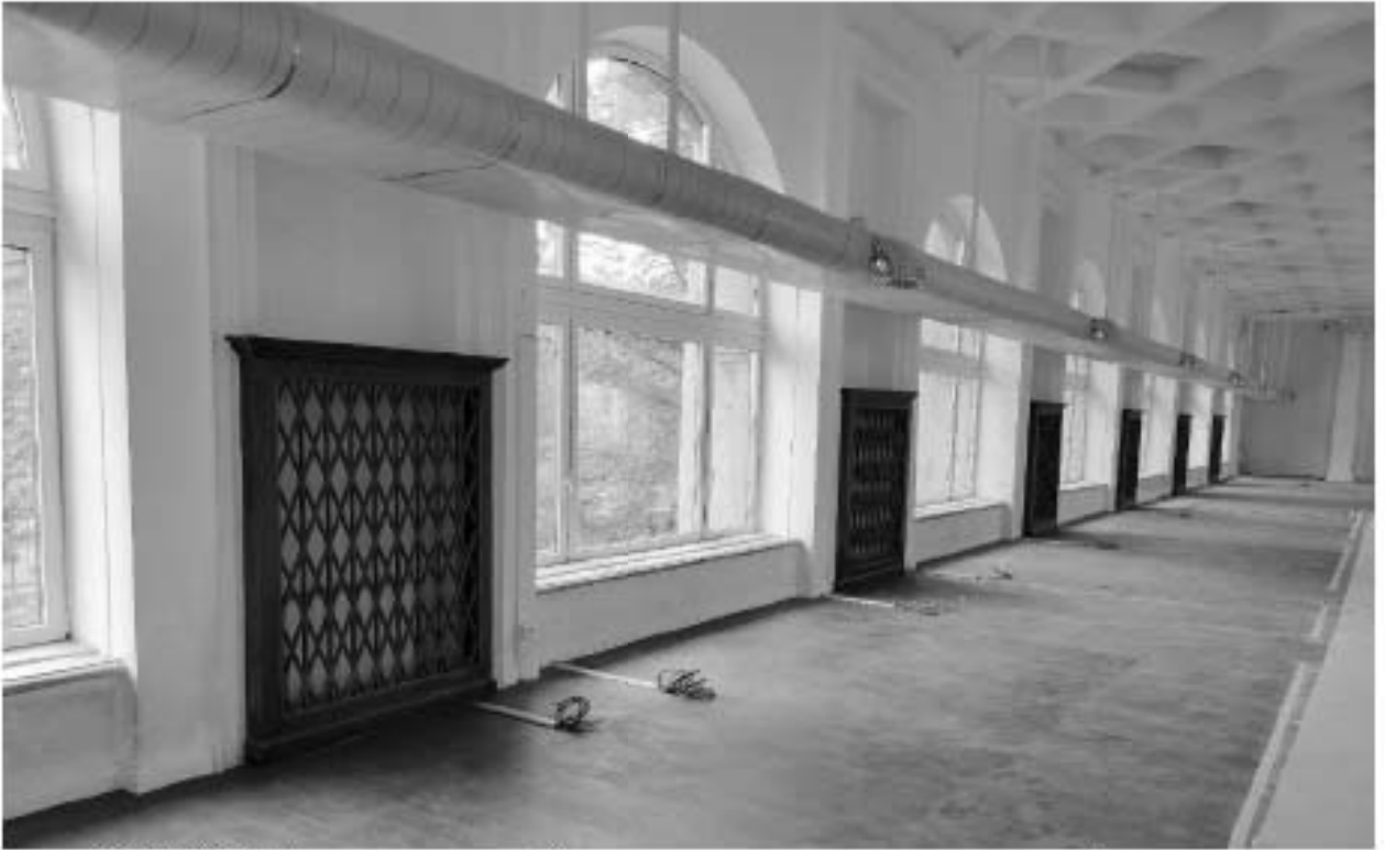
12. ОКНРЗ «Дворец пушкины». Ниши в межконных простенках в профилированных наличниках с деревянными радиаторными решетками рисунка ромбовидной сеткой. Профилированный карниз. Дата дополнительной съёмки: 15.07.2024г.
