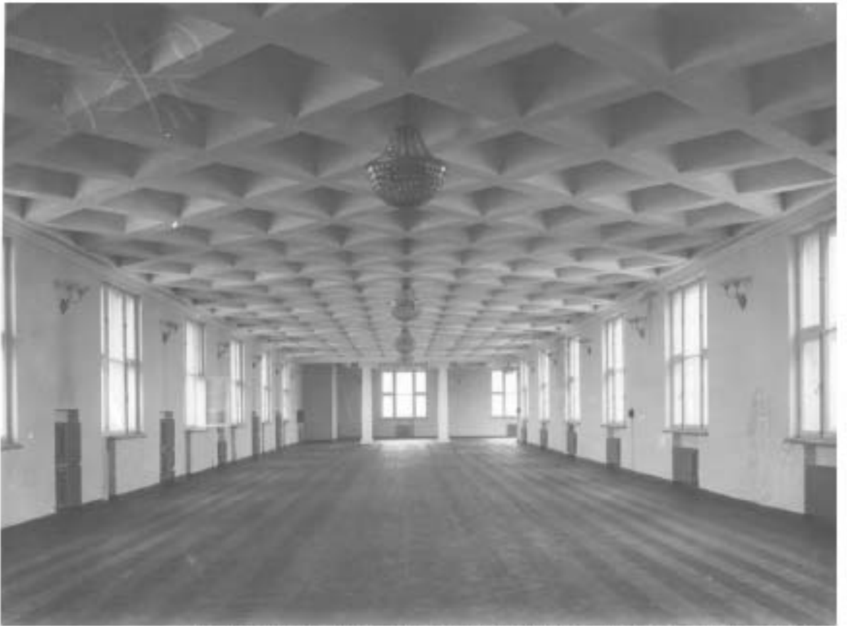
65. Операционный зал 3-го этажа. Северо-западная сторона. 1938г. ЦГАКФФД СПб. Вр 37580.
