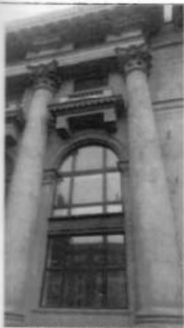
4. Фрагмент оформления западного фасада
