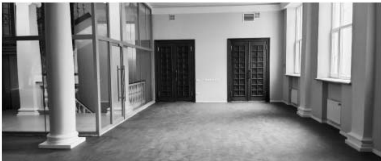
16. ОКНРЗ «Дворец пушкинны». Интерьеры 3-го этажа. Пилоны и пилястры стилизованного ионического ордера. Дверные проемы с деревянным филенчатым двустворчатым заполнением и исторической фурнитурой (ручка-скоба). Дата съёмки. 15.01.2024г.
