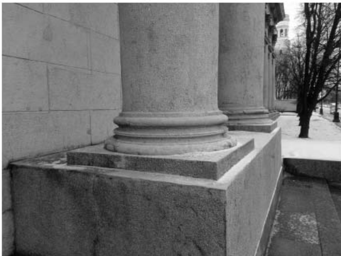
7. ОКНРЗ «Дворец пушкины». Южная часть западного фасада. Вид на юго-восток 15.01.2024г.
