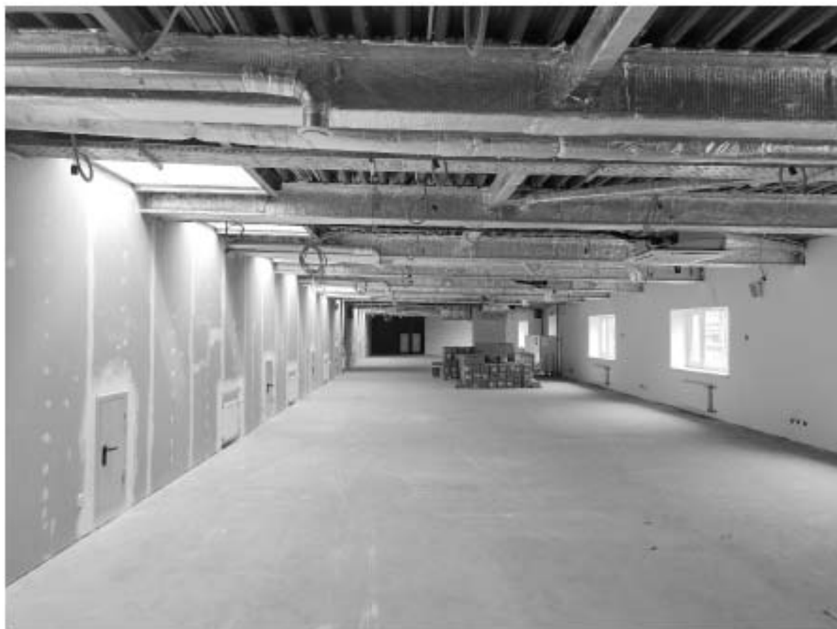
40. ОКНРЗ «Дворец пушнины». Интерьеры 5-го этажа. Дата съёмки: 15.01.2024г.
