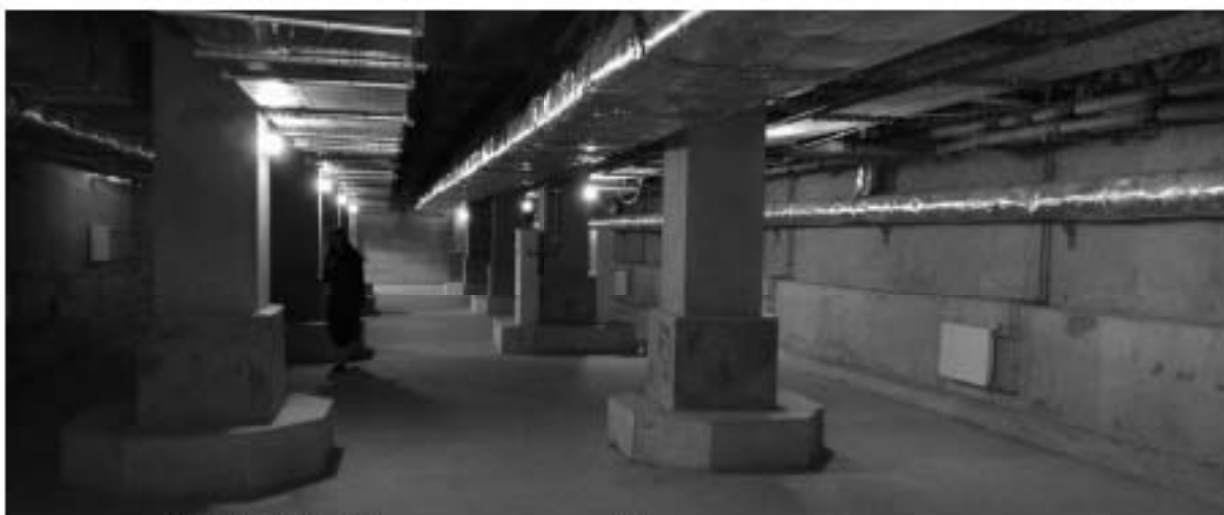
8. ОКНРЗ «Дворец пушнина». Интерьер подвального этажа. Фрагмент конструктивной системы – колонны. Дата съёмки: 15.01.2024г.
