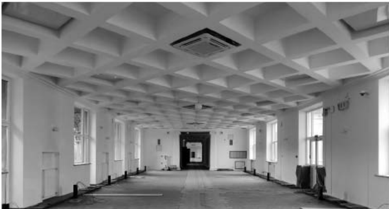
20. ОКНРЗ «Дворец пушкины». Интерьеры 3-го этажа. Оформление потолка – глубокие кессоны. Дата съёмки: 15.01.2024г.
