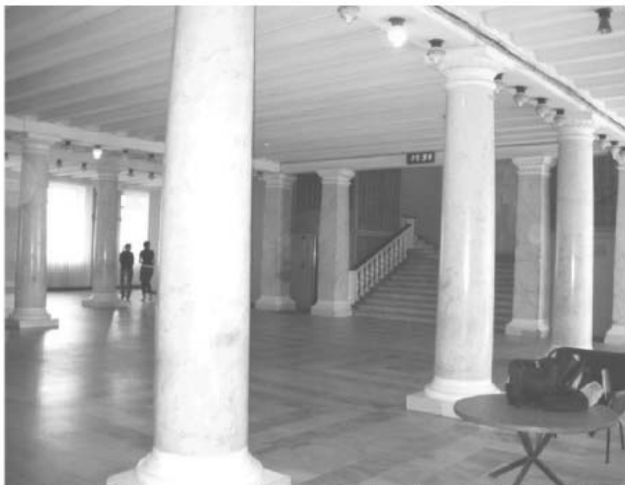
101. Вестибюль 1-го этажа. 2010г. ООО «БРК».
