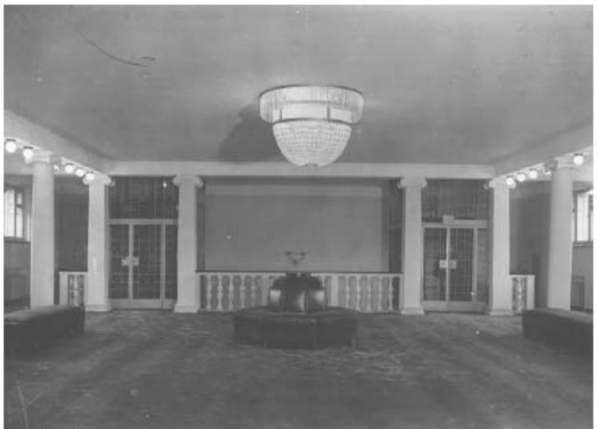
58. Холл 4-го этажа. Вид на балюстраду перильного ограждения парадной лестницы и лифтовые шахты. 1938г. ЦГАКФФД СПб. Вр 37453.
