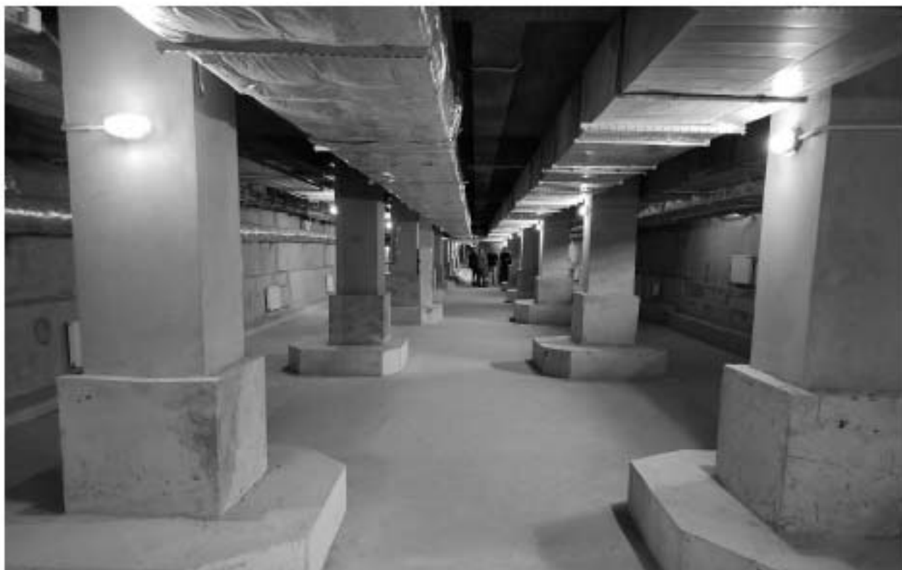
3. ОКНРЗ «Дворец пушнины». Интерьер подвального этажа. Фрагмент конструктивной системы – колонны. Дата съёмки: 15.01.2024г.
