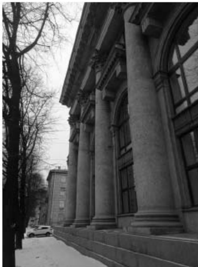
14. ОКНРЗ «Дворец пушкинь». Фрагмент северной части западного фасада. 15.01.2024г.
