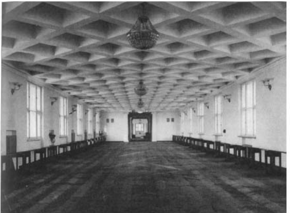
66. Операционный зал 3-го этажа. Юго-западная сторона. 1938г. ЦГАКФФД СПб. Вр 37454.
