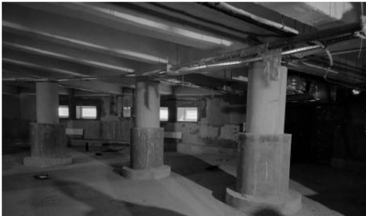
5. ОКНРЗ «Дворец пушкинъ». Интерьер подвального этажа. Фрагмент конструктивной системы – колонны. Дата съёмки: 15.01.2024г.
