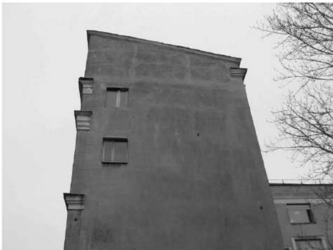
96. Восточный фасад. Фрагмент. 2010г. ООО «БРК».
