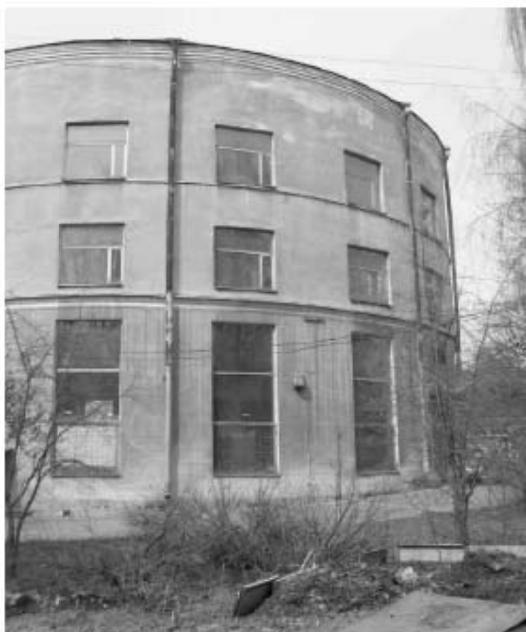
99. Дворовый фасад. Вид на полукруглый корпус аукционного зала. 2010г. ООО «БРК».
