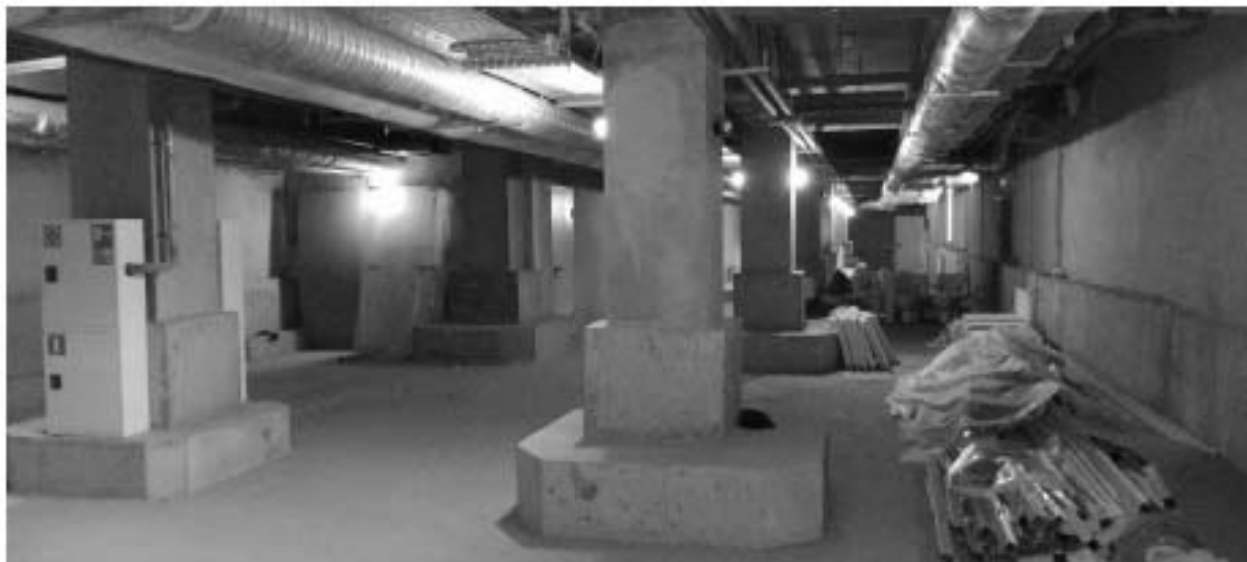
10. ОКНРЗ «Дворец пушкинъ». Интерьер подвального этажа. Фрагмент конструктивной системы – колонны. Дата съёмки: 15.01.2024г.
