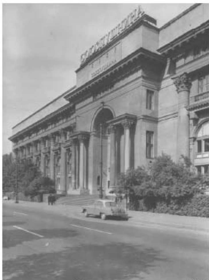
86. Вид фасада здания «Союзпушнина» на Московском проспекте, дом № 98. 1966г. ЦГАКФФД СПб. Бр 63075.
