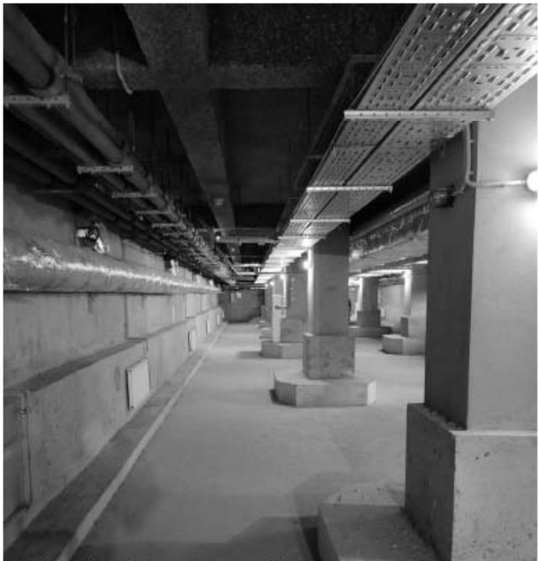
2. ОКНРЗ «Дворец пушкины». Интерьер подвального этажа. Фрагмент конструктивной системы – колонны. Дата съёмки: 15.01.2024г.
