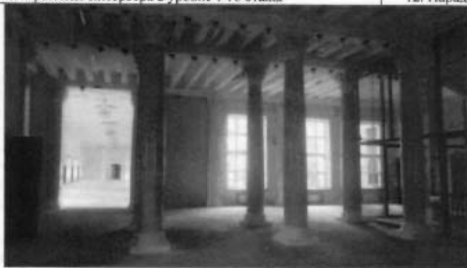
13. Фрагмент интерьера в уровне 2-го этажа
