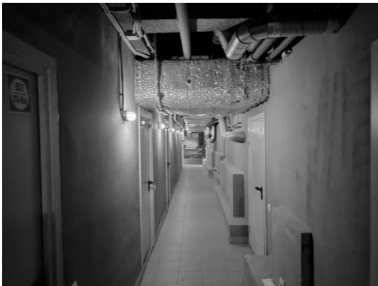
11. ОКНРЗ «Дворец пушкинъ». Интерьер подвального этажа. Дата съёмки: 15.01.2024г.
