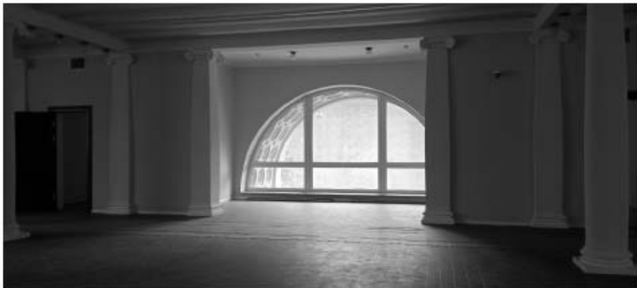
12 ОКНРЗ «Дворец пушкинъ». Интерьеры 3-го этажа. Оконный проем с полуциркульным завершением. Пилоны и пилястры стилизованного ионического ордера. Дата съёмки: 15.01.2024г.
