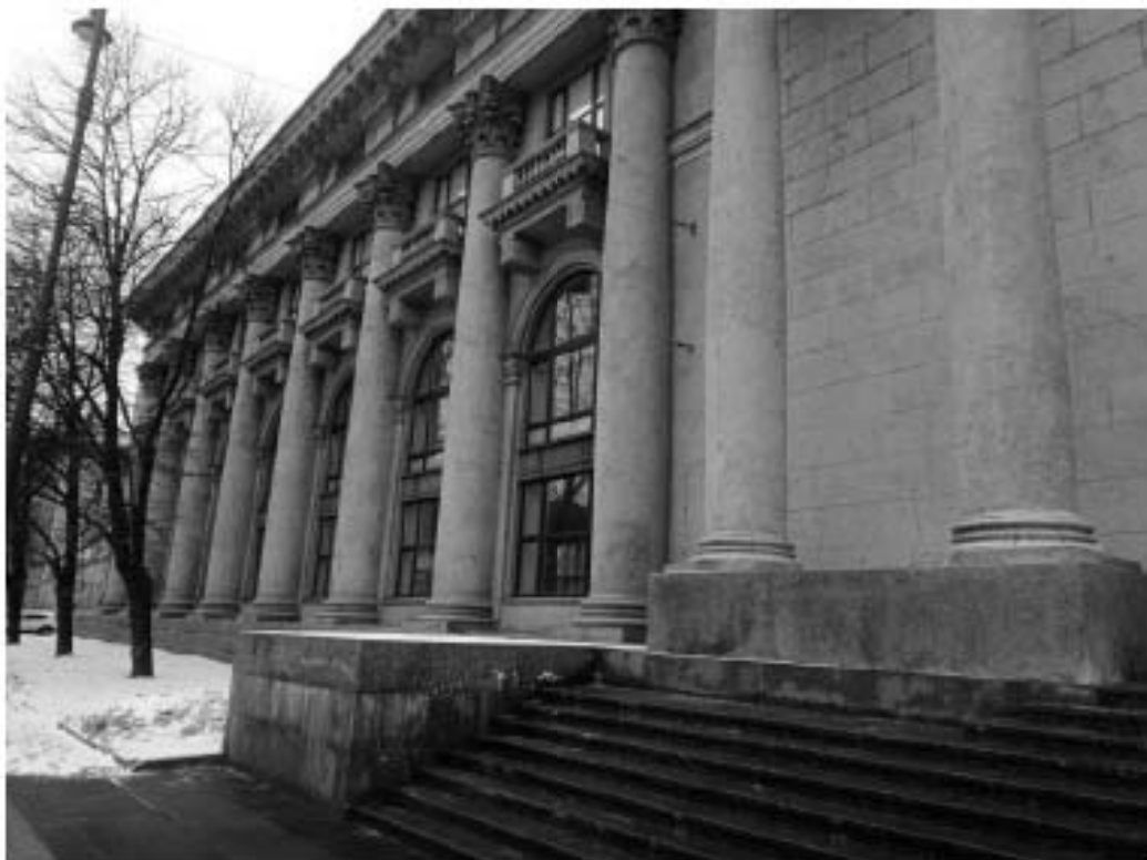
15. ОКНРЗ «Дворец Пушкина». Центральная и северная части западного фасада. Вид на северо-восток. 15.01.2024г.
