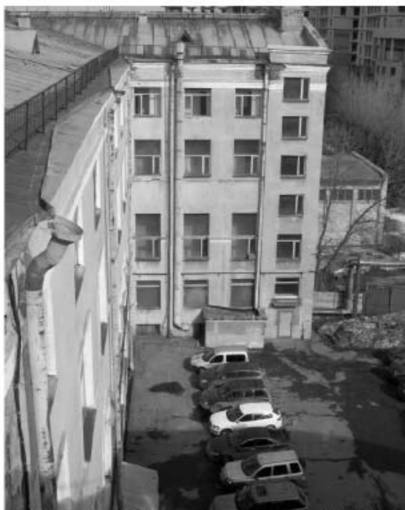
98. Дворовый фасад. Вид на южный фасад левого крыла. 2010г. ООО «БРК».
