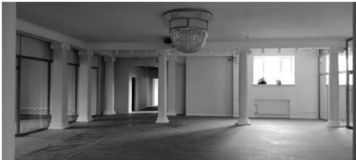
38. ОКНРЗ «Дворец пушкинъ». Интерьеры 4-го этажа. Колонны, поддерживающие потолочные балки с профилем по краю, и пилястры ионического ордера. Дата съёмки: 15.01.2024г.
