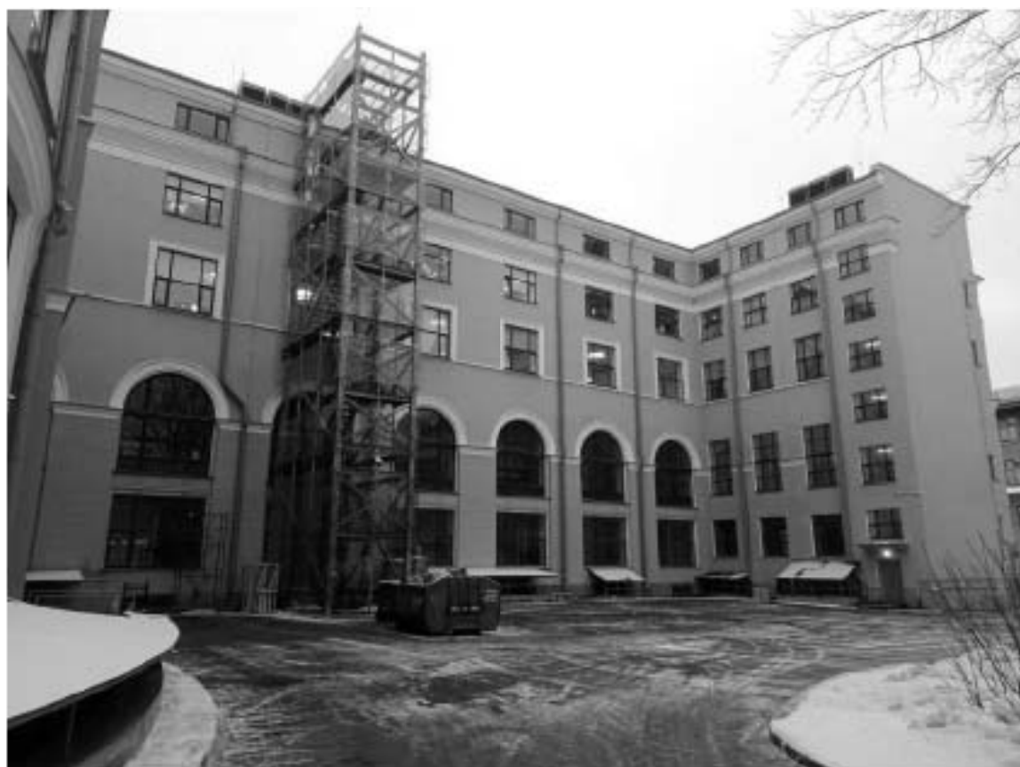
36. ОКНРЗ «Дворец пушкинъ». Северная часть восточного фасада. Вид на северо-запад. 15.01.2024г.
