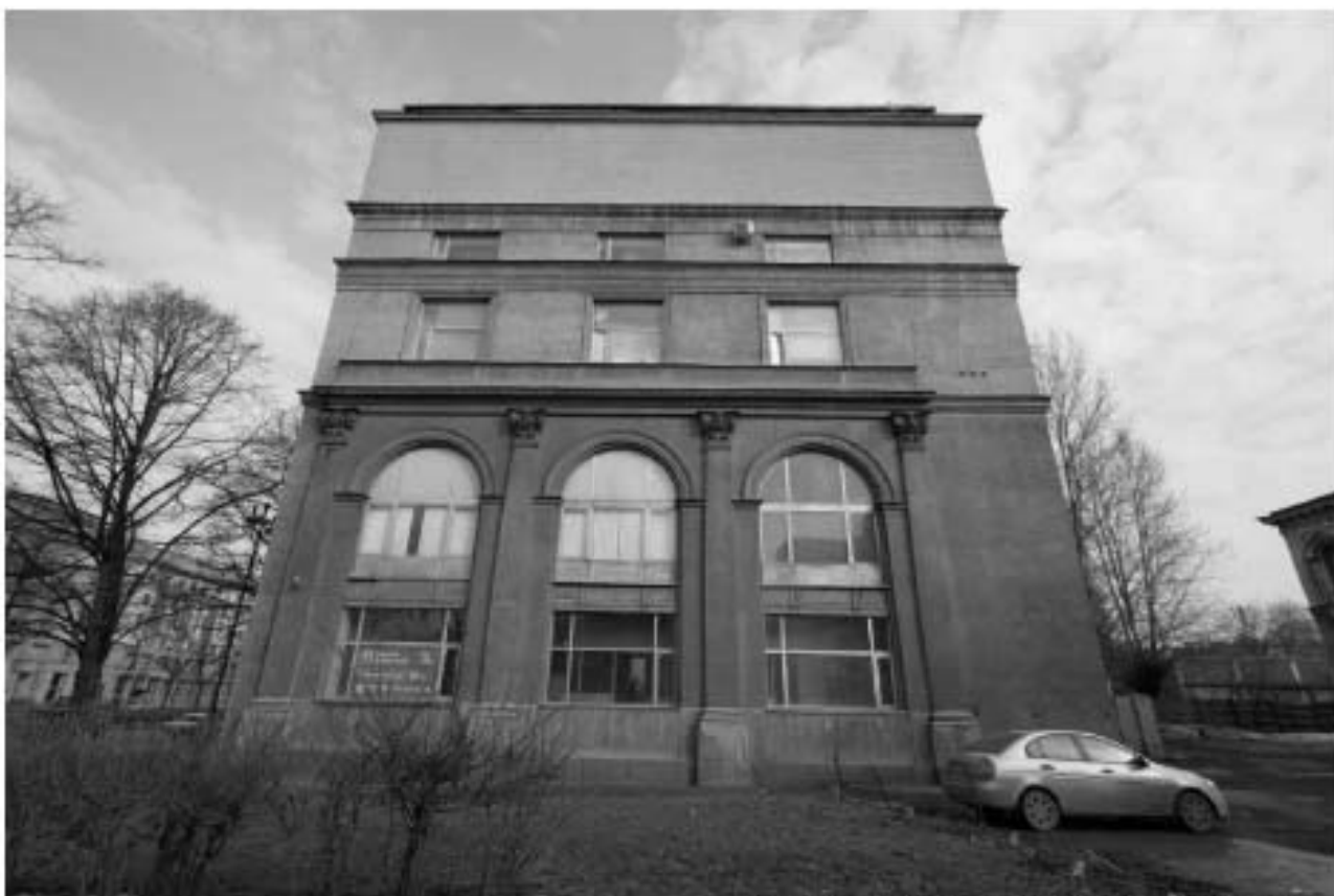
95. Южный фасад. 2010г. ООО «БРК».
