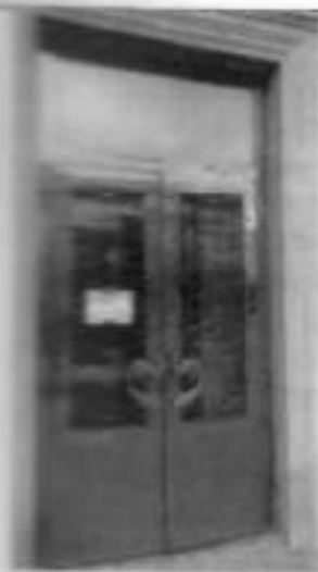
9. Деревянное заполнение парадного входа
