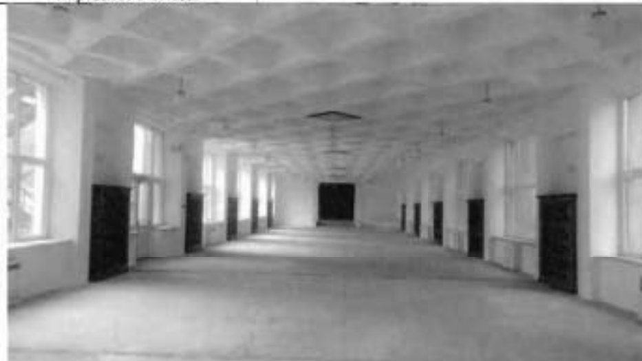
11. Фрагмент интерьера в уровне 1-го этажа
