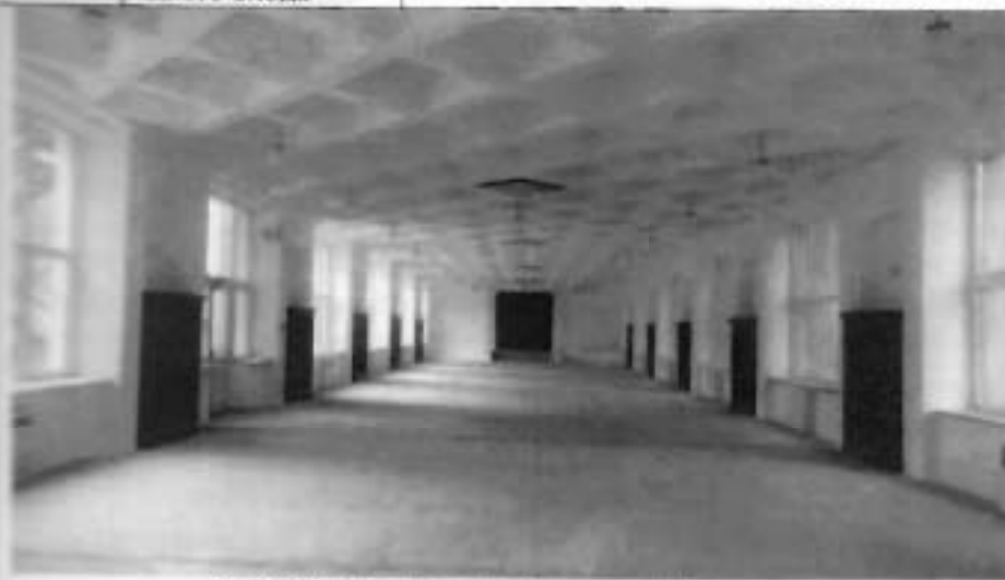
11. Фрагмент интерьера в уровне 1-го этажа
