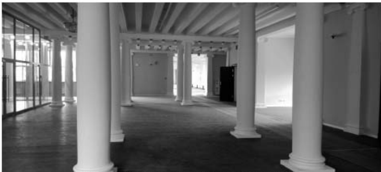
13. ОКНРЗ «Дворец пушкинъ». Интерьеры 3-го этажа. Пилоны и пилястры стилизованного ионического ордера. Дата съёмки: 15.01.2024г.
