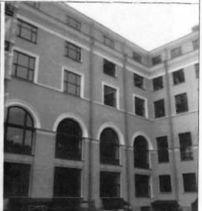
3. Фрагмент восточного фасада
