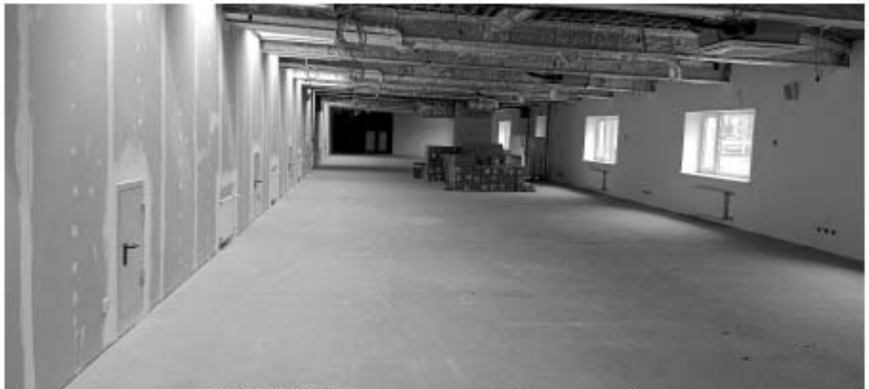
43. ОКНРЗ «Дворец пушнины». Интерьеры 5-го этажа. Оконные проемы с прямым завершением. Дата съёмки: 15.01.2024г.
