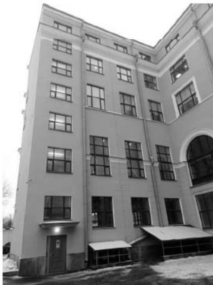
30. ОКНРЗ «Дворец пушкинъ». Южная часть восточного фасада. Вид на юго-запад. 15.01.2024г.
