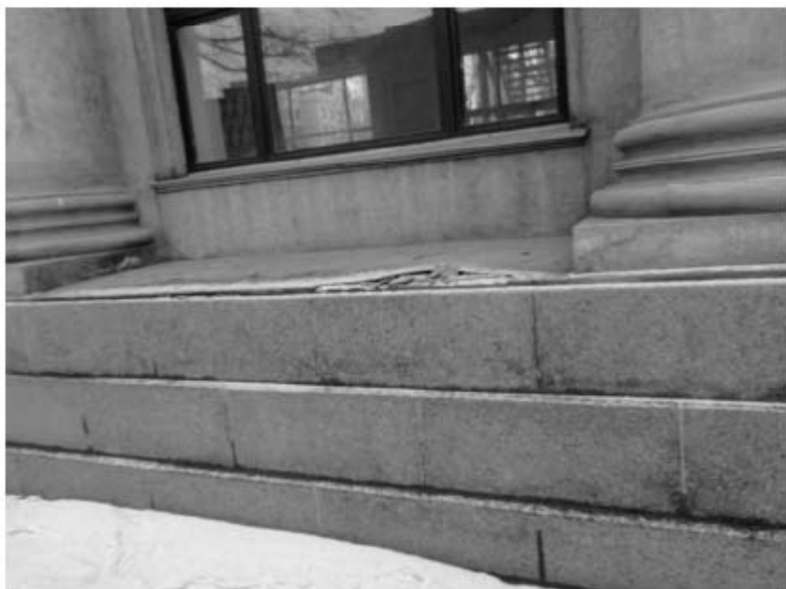
22. ОКНРЗ «Дворец пушкинь». Фрагмент северной части западного фасада. 15.01.2024г.
