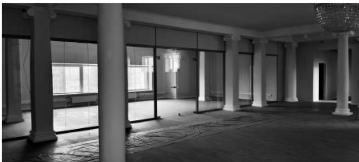
39. ОКНРЗ «Дворец пушкинъ». Интерьеры 4-го этажа. Колонны, поддерживающие потолочные балки с профилем по краю, и пилястры ионического ордера. Дата съёмки: 15.01.2024г.
