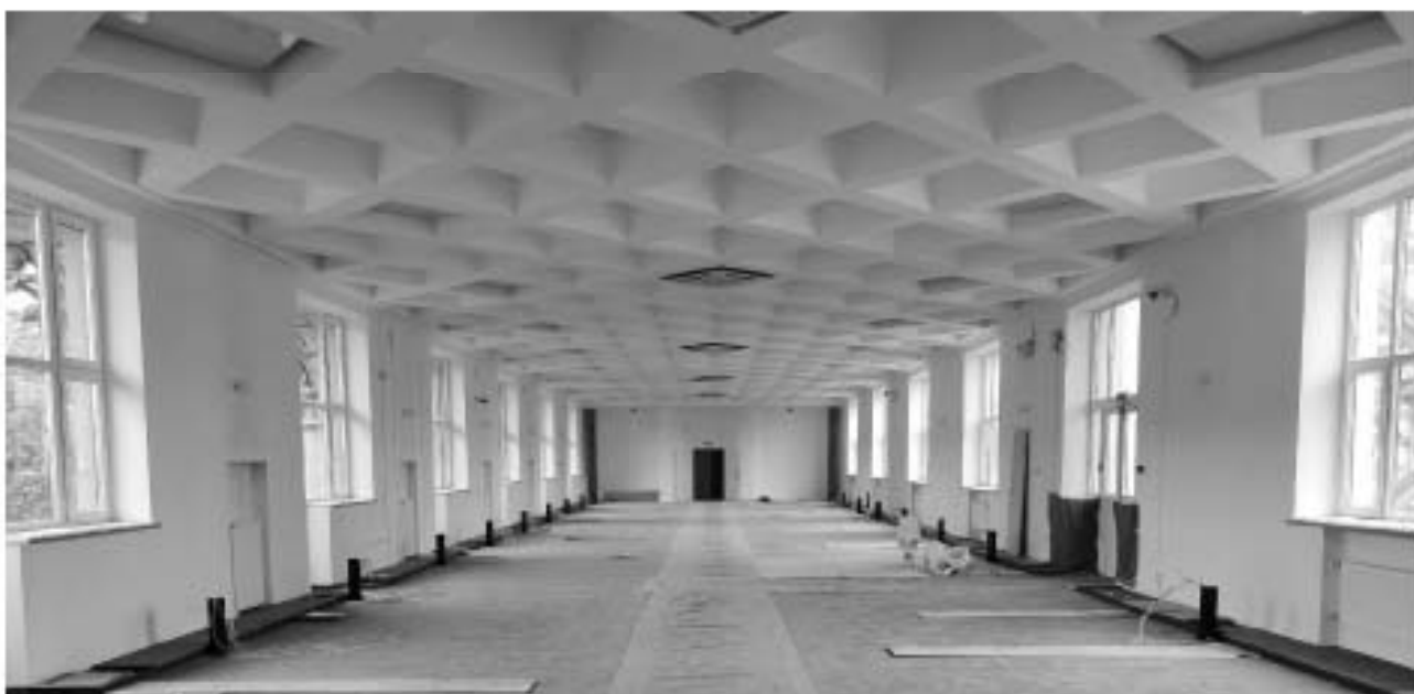
19. ОКНРЗ «Дворец пушкинъ». Интерьеры 3-го этажа. Оформление потолка – глубокие кессоны. Дата съёмки: 15.01.2024г.
