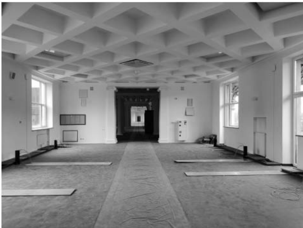
21. ОКНРЗ «Дворец пушкины». Интерьеры 3-го этажа. Оформление потолка – глубокие кессоны. Дата съёмки: 15.01.2024г.
