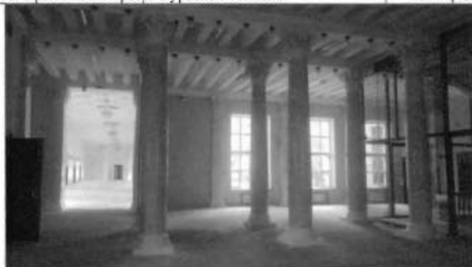
13. Фрагмент интерьера в уровне 2-го этажа
