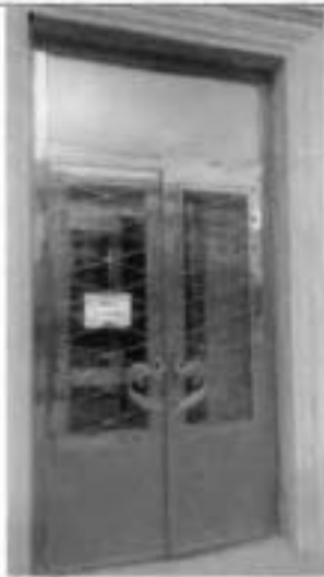
9. Дверное заполнение парадного входа
