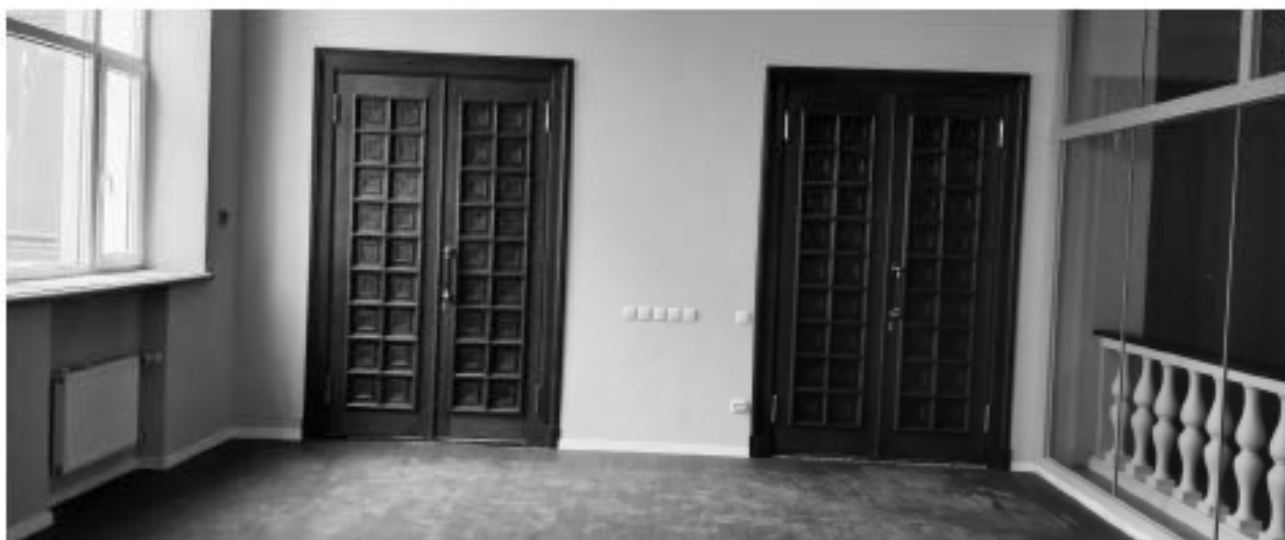
17. ОКНРЗ «Дворец пушкинны». Интерьеры 3-го этажа. Дверные проемы с деревянным филенчатым двустворчатым заполнением и исторической фурнитурой (ручка-скоба). Дата съёмки. 15.01.2024г.
