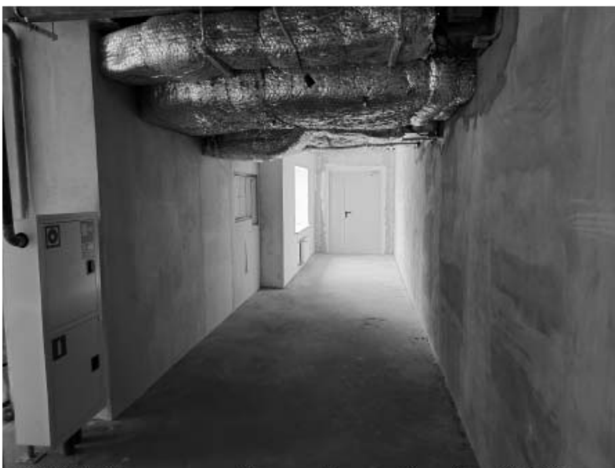
41. ОКНРЗ «Дворец пушнины». Интерьеры 5-го этажа. Дата съёмки: 15.01.2024г.
