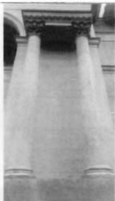
6. Фрагмент оформления западного фасада
