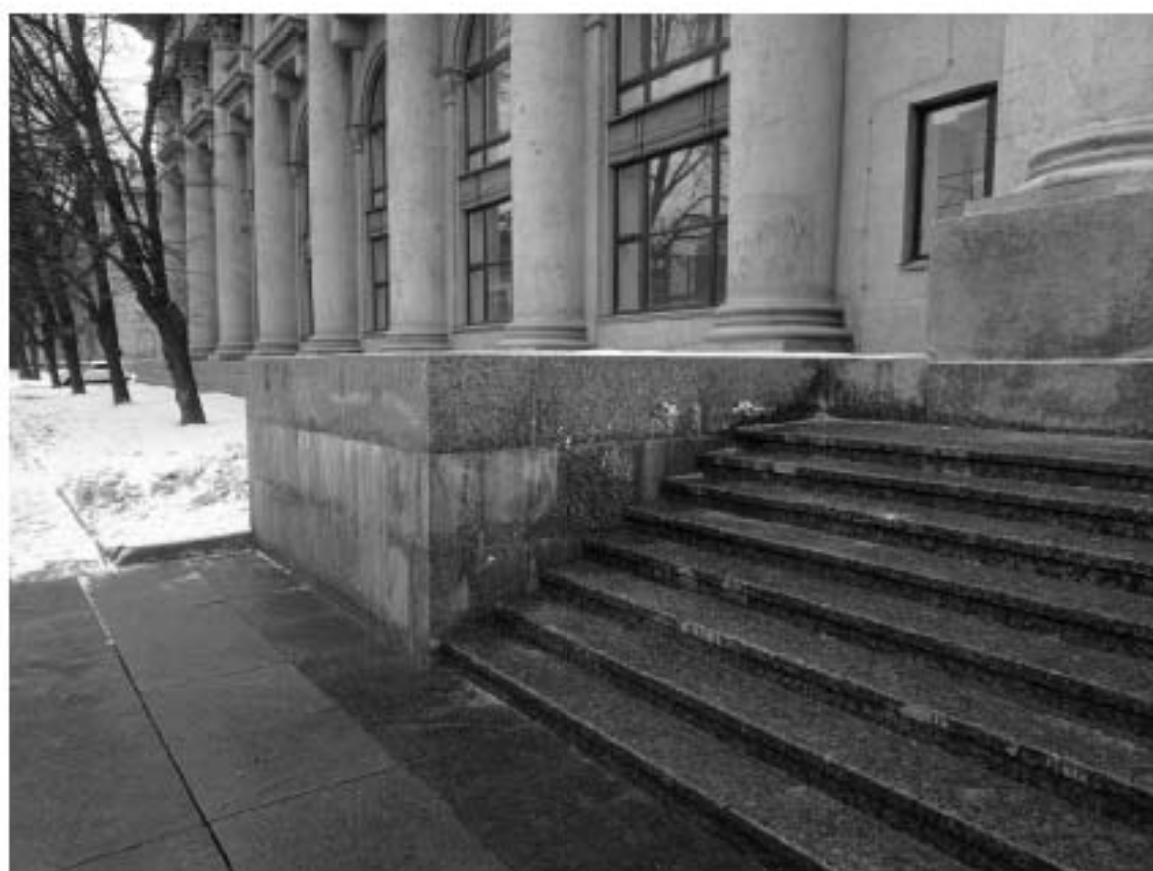
11. ОКНРЗ «Дворец пушкинъ». Северная часть западного фасада. Вид на северо-восток. 15.01.2024г.
