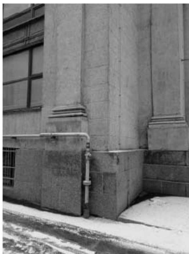
26. ОКНРЗ «Дворец пушкинью». Фрагмент западной части северного фасада. Вид на юго-восток. 15.01.2024г.
