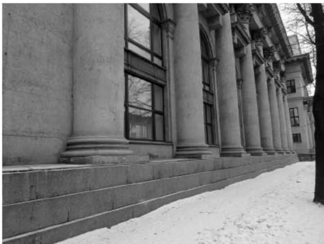
12. ОКНРЗ «Дворец пушкинь». Северная часть западного фасада. Вид на юго-восток. 15.01.2024г.
