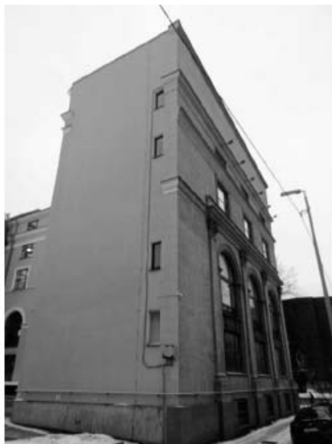
25. ОКНРЗ «Дворец пушкины». Северный фасад. Вид на юго-запад. 15.01.2024г.
