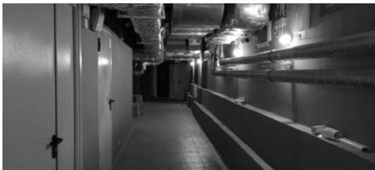
9. ОКНРЗ «Дворец пушнина». Интерьер подвального этажа. Фрагмент конструктивной системы – колонны. Дата съёмки: 15.01.2024г.
