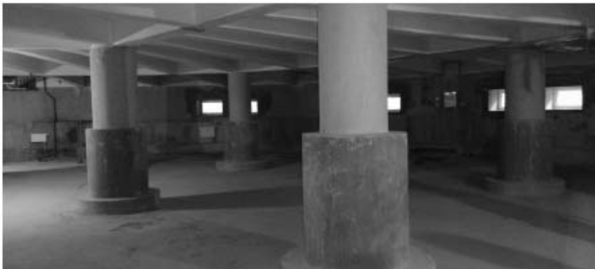
7. ОКНРЗ «Дворец пушнина». Интерьер подвального этажа. Фрагмент конструктивной системы – колонны и историческое перекрытие (перекрестная система железобетонных балок с бетонным заполнением). Дата съёмки: 15.01.2024г.
