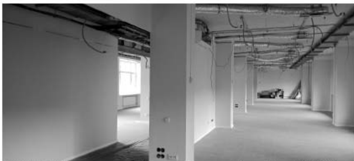
34. ОКНРЗ «Дворец пушнины». Интерьеры 4-го этажа. Дата съёмки: 15.01.2024г.
