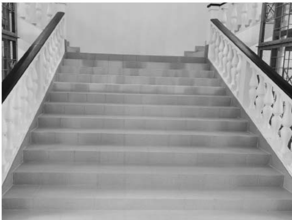
49. ОКНРЗ «Дворец пушкинъ». Интерьеры 5-го этажа. Фрагмент параллельной лестницы. Деревянные профилированные перила балюстрады. Историческое местоположение шахт лифта. Ограждение лифтовых шахт в виде металлических каркасов геометрического рисунка. Дата съёмки: 15.01.2024г.
