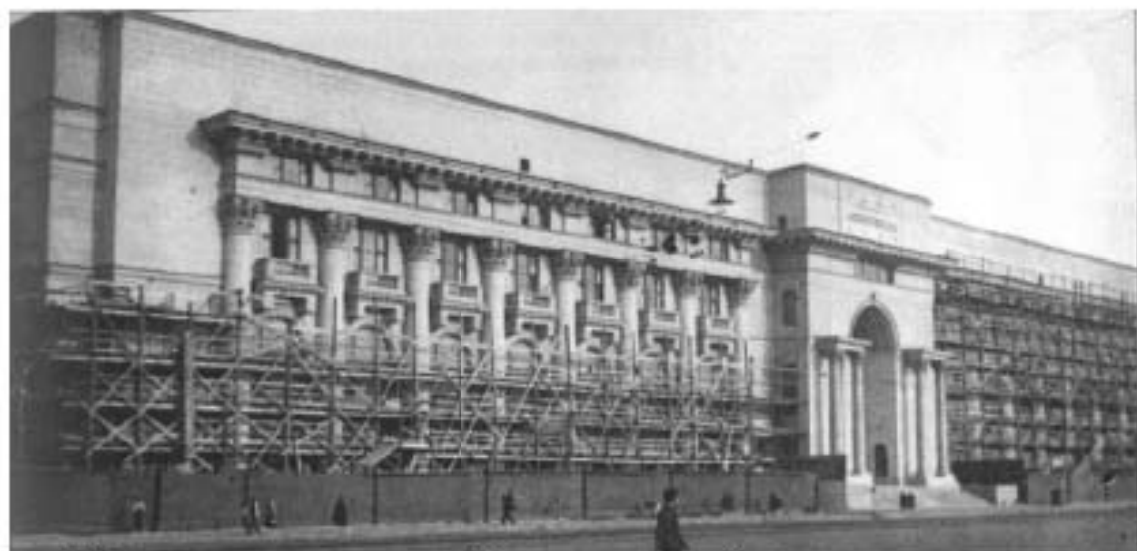
49. Окончание строительства Дворца пушкины. Демонтаж строителных лесов с главных фасадов. 1938г. ЦГАКФФД СПб. Вр 49698.
