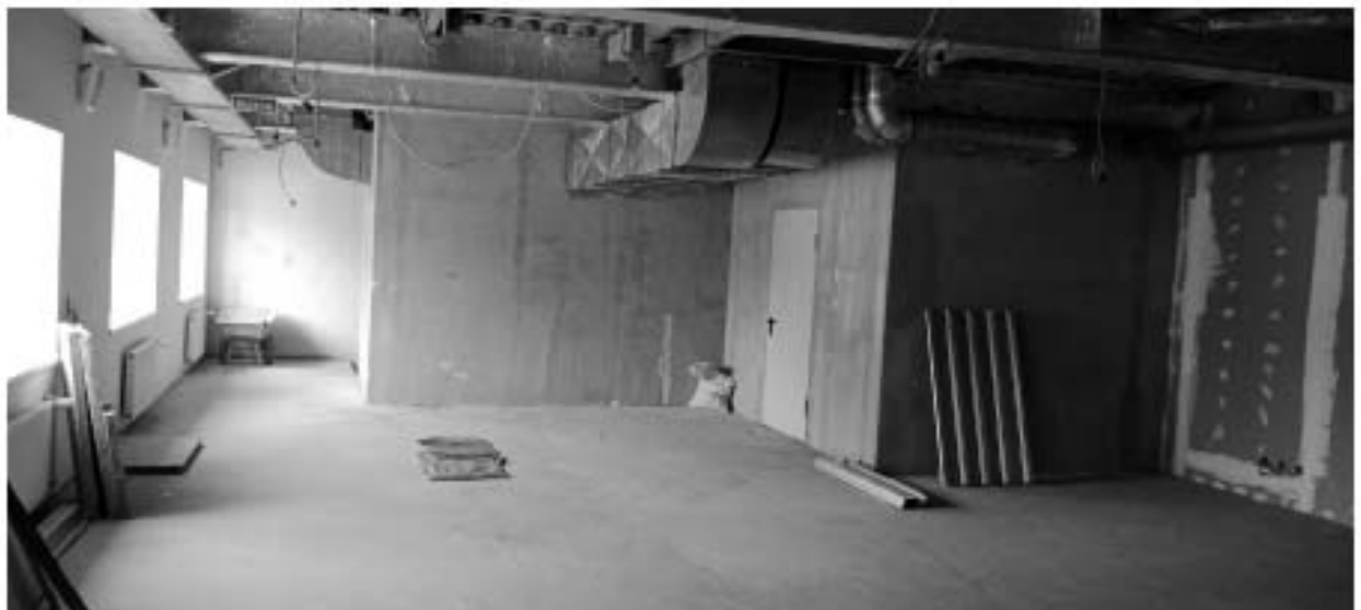
44. ОКНРЗ «Дворец пушнины». Интерьеры 5-го этажа. Дата съёмки: 15.01.2024г.
