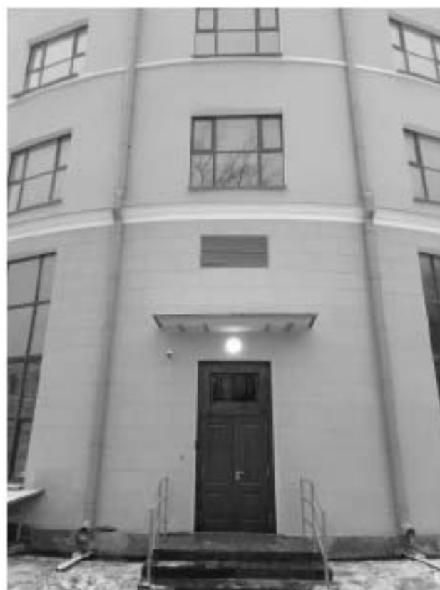
34. ОКНРЗ «Дворец пушкинь». Центральный ризалит восточного фасада. Вид на запад. 15.01.2024г.
