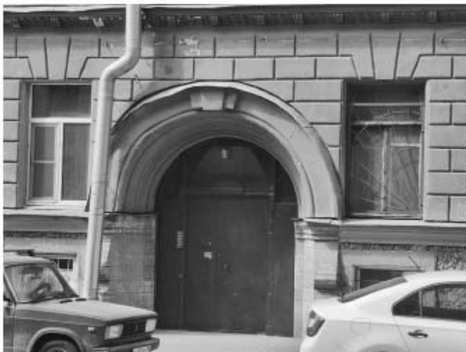
21. «Дом З.Н. Левина», 6-я Красноармейская ул., д. 15, лит. А. Восточный фасад. Фрагмент. Фото 22.04.2024г.
