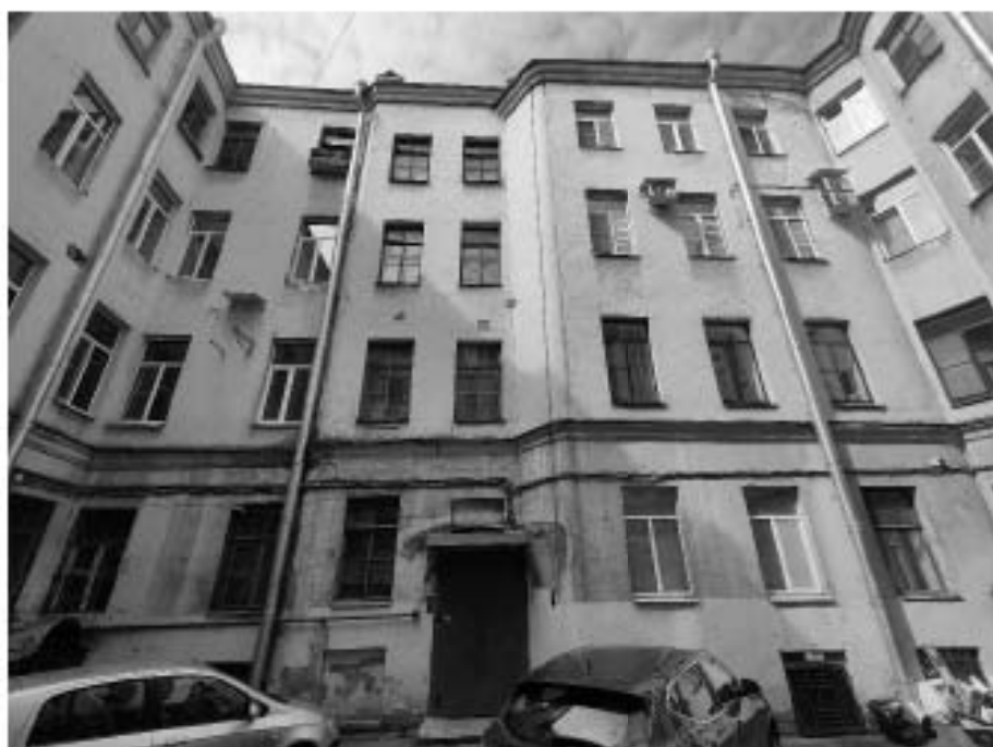
31. «Дом З.Н. Левина», 6-я Красноармейская ул., д. 15, лит. А. Дворовый фасад. Фрагмент. Фото 22.04.2024г.
