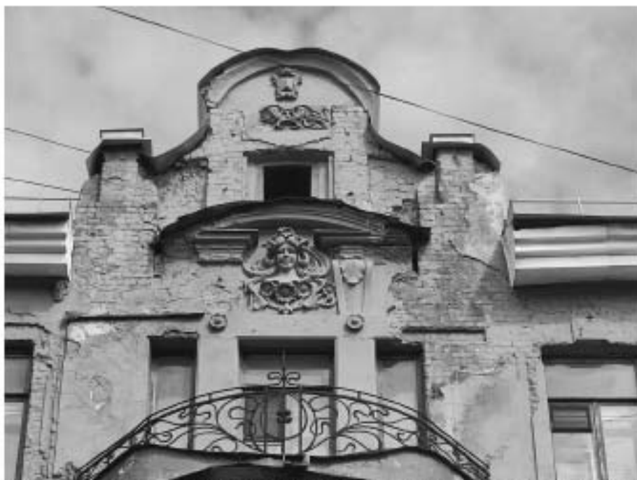
7. «Дом З.Н. Левина», 6-я Красноармейская ул., д. 15, лит. А. Южный фасад. Фрагмент. Фото 22.04.2024г.
