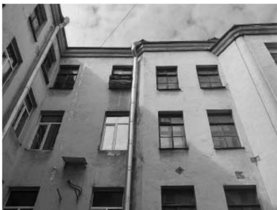
34. «Дом З.Н. Левина», 6-я Красноармейская ул., д. 15, лит. А. Дворовый фасад. Фрагмент. Фото 22.04.2024г.
