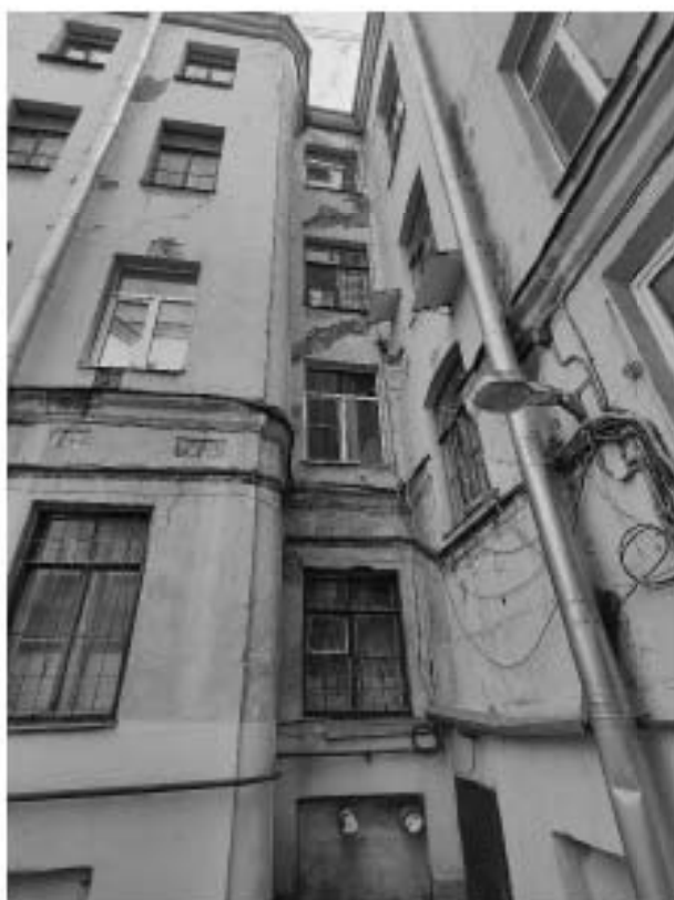
44. «Дом З.Н. Левина», 6-я Красноармейская ул., д. 15, лит. А. Дворовый фасад. Фрагмент. Фото 22.04.2024г.
