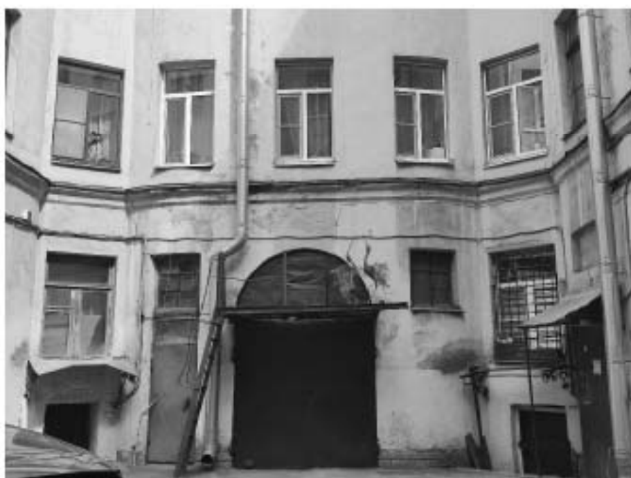
30. «Дом З.Н. Левина», 6-я Красноармейская ул., д. 15, лит. А. Дворовый фасад. Фрагмент. Фото 22.04.2024г.
