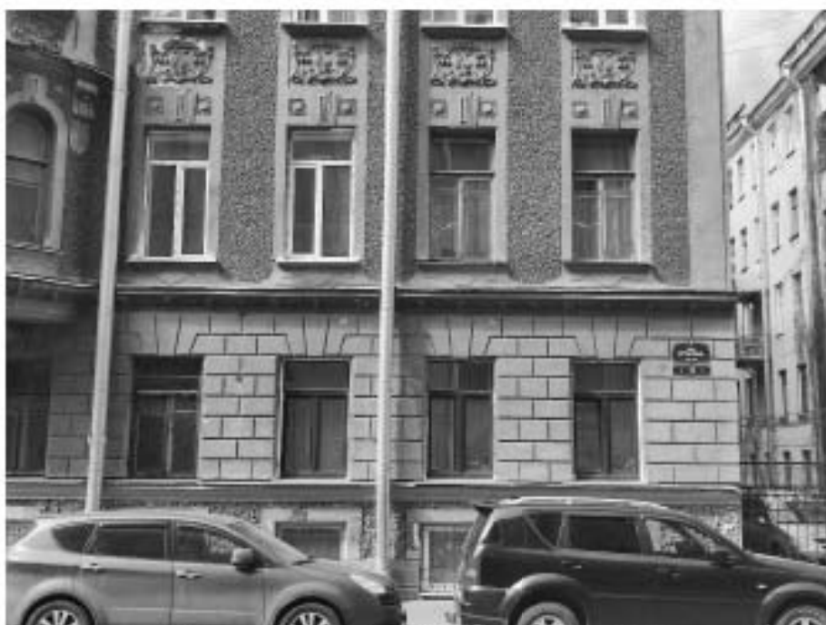
27. «Дом З.Н. Левина», 6-я Красноармейская ул., д. 15, лит. А. Восточный фасад. Фрагмент. Фото 22.04.2024г.
