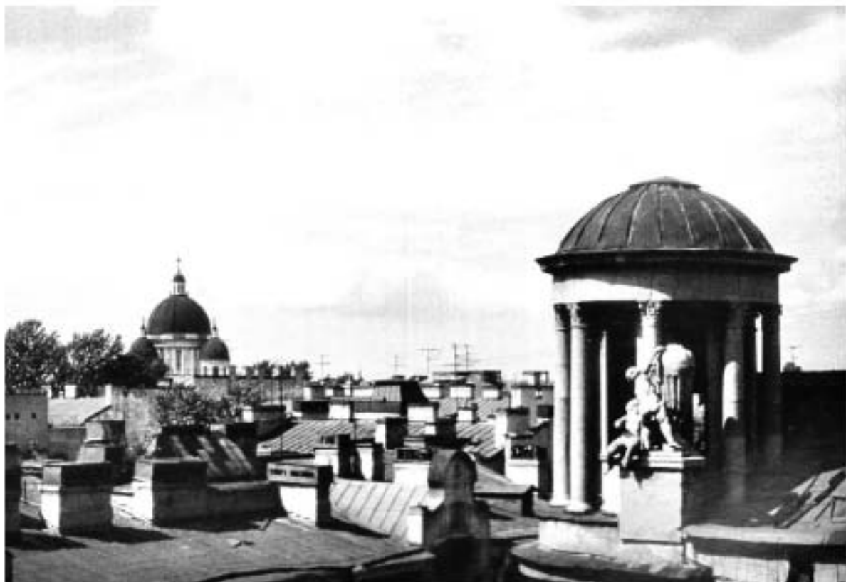
Илл. 63. Крыши зданий по Красноармейским улицам. Вид с крыши дома №12 по 6-й Красноармейской в сторону Измайловского собора (с участком крыши дома №15 по 6-й Красноармейской улицы). Фотография В. Антощенко. 2000-е гг. По изданию: Фотоальбом «Крыши Петербурга». Автор-составитель В. Антощенко. СПб., 2010 г.
