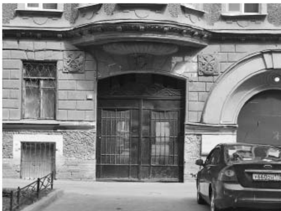
9. «Дом З.Н. Левина», 6-я Красноармейская ул., д. 15, лит. А. Южный фасад. Фрагмент. Фото 22.04.2024г.
