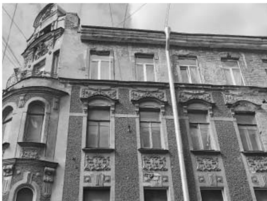
17. «Дом З.Н. Левина», 6-я Красноармейская ул., д. 15, лит. А. Восточный фасад. Фрагмент. Фото 22.04.2024г.
