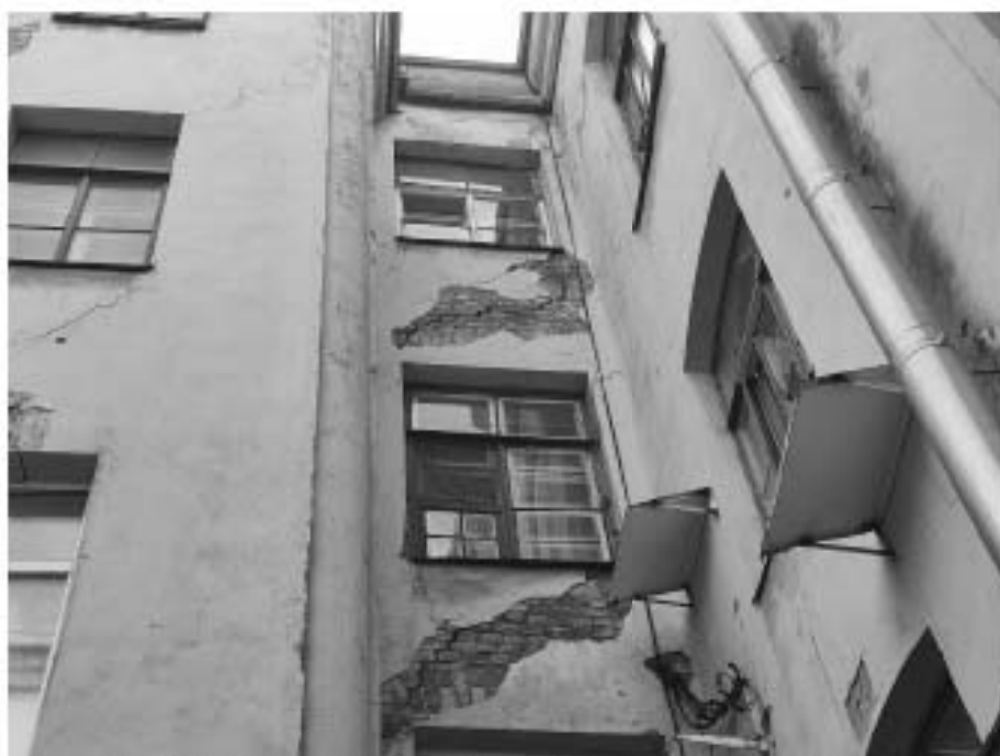
45. «Дом З.Н. Левина», 6-я Красноармейская ул., д. 15, лит. А. Дворовый фасад. Фрагмент. Фото 22.04.2024г.
