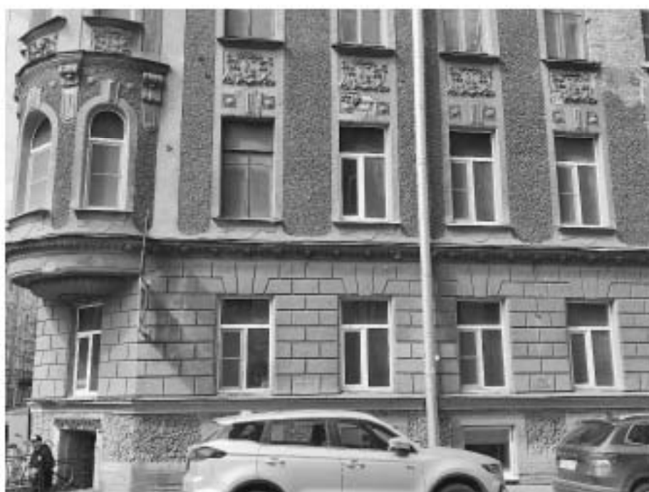
18. «Дом З.Н. Левина», 6-я Красноармейская ул., д. 15, лит. А. Восточный фасад. Фрагмент. Фото 22.04.2024г.
