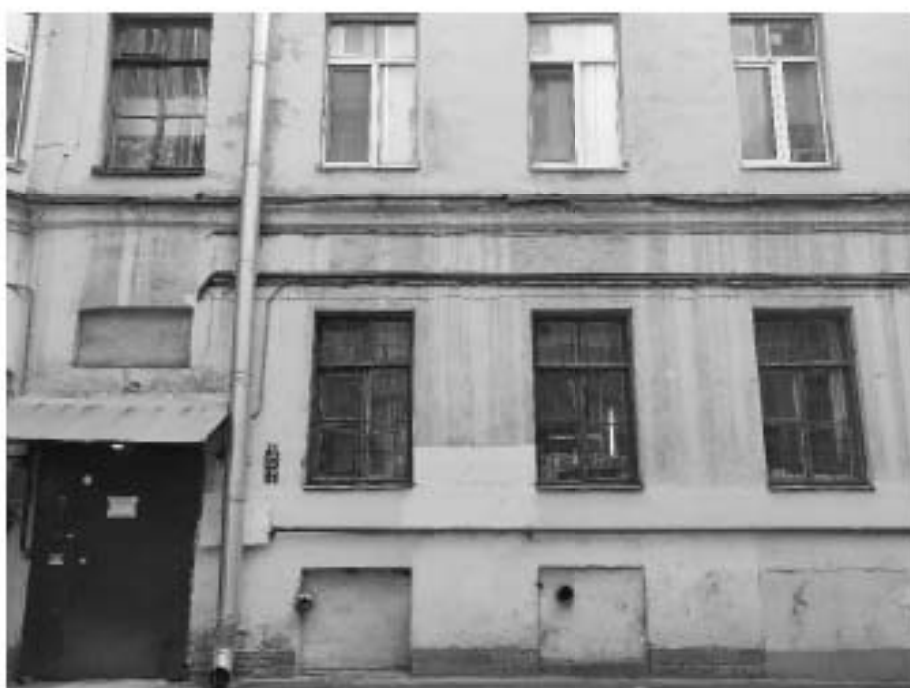
38. «Дом З.Н. Левина», 6-я Красноармейская ул., д. 15, лит. А. Дворовый фасад. Фрагмент. Фото 22.04.2024г.
