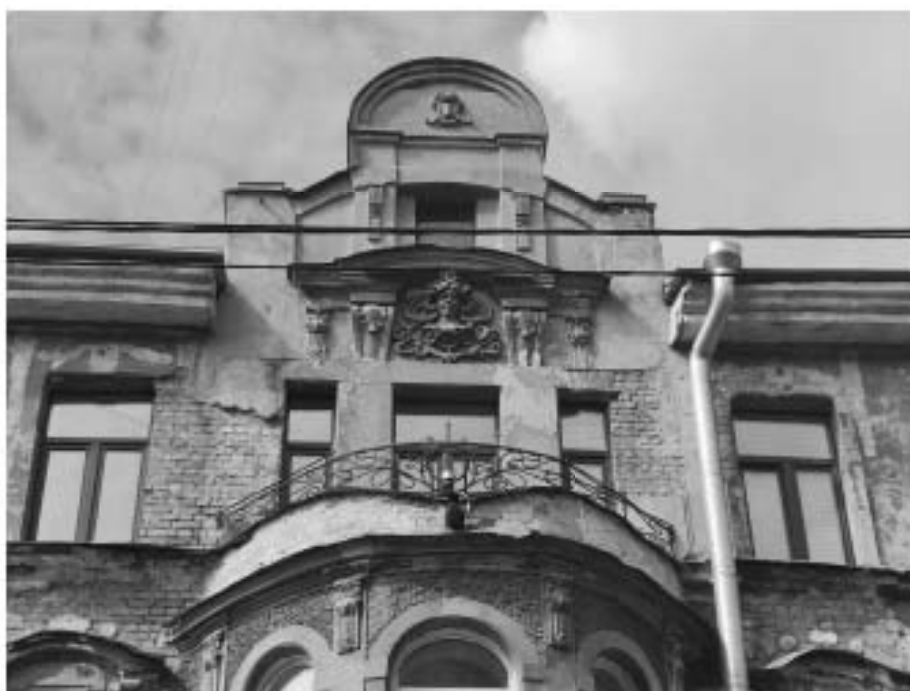
22. «Дом З.Н. Левина», 6-я Красноармейская ул., д. 15, лит. А. Восточный фасад. Фрагмент. Фото 22.04.2024г.
