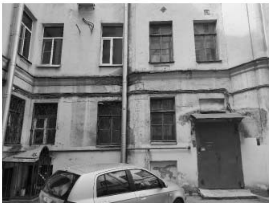
35. «Дом З.Н. Левина», 6-я Красноармейская ул., д. 15, лит. А. Дворовый фасад. Фрагмент. Фото 22.04.2024г.
