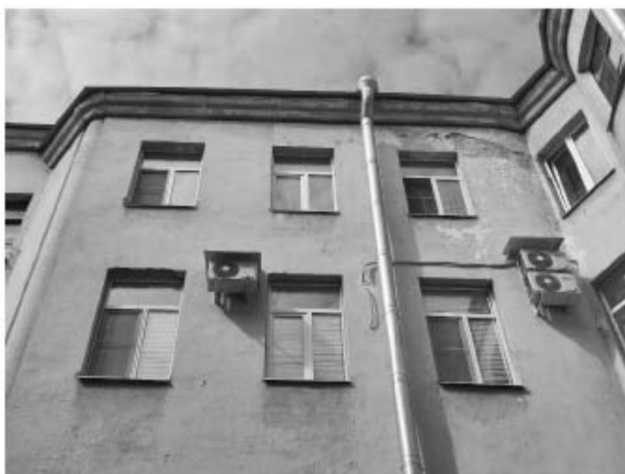
32. «Дом З.Н. Левина», 6-я Красноармейская ул., д. 15, лит. А. Дворовый фасад. Фрагмент. Фото 22.04.2024г.
