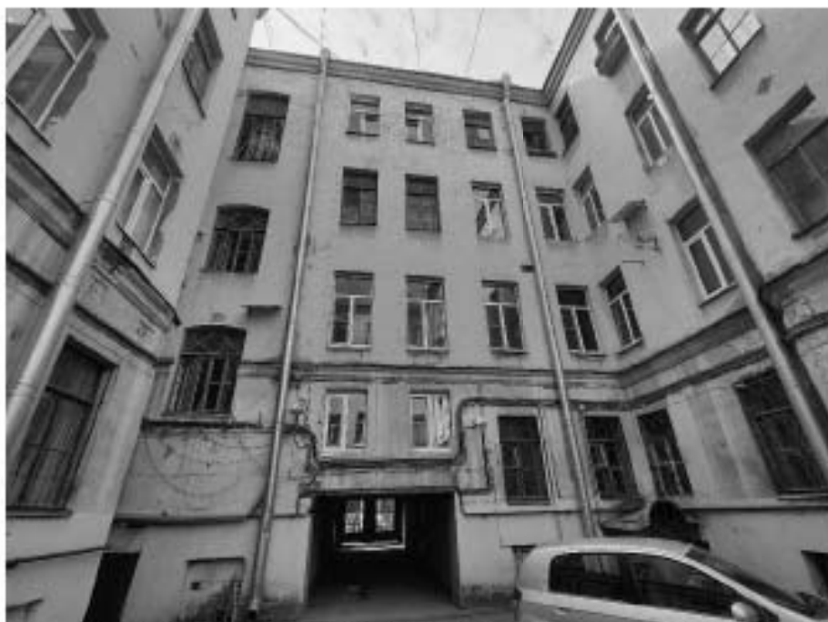
41. «Дом З.Н. Левина», 6-я Красноармейская ул., д. 15, лит. А. Дворовый фасад. Фрагмент. Фото 22.04.2024г.
