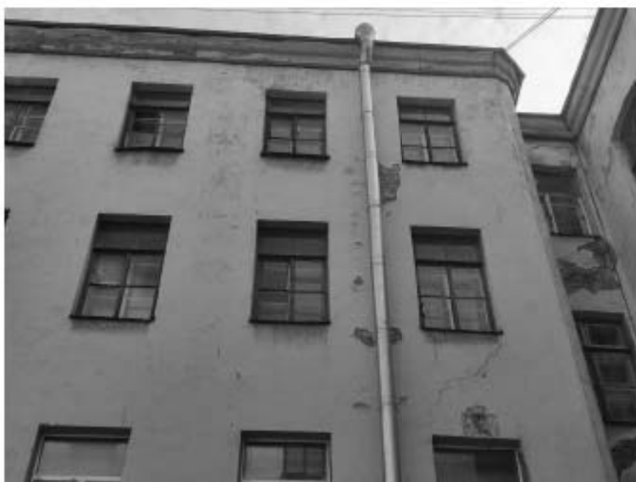
39. «Дом З.Н. Левина», 6-я Красноармейская ул., д. 15, лит. А. Дворовый фасад. Фрагмент. Фото 22.04.2024г.
