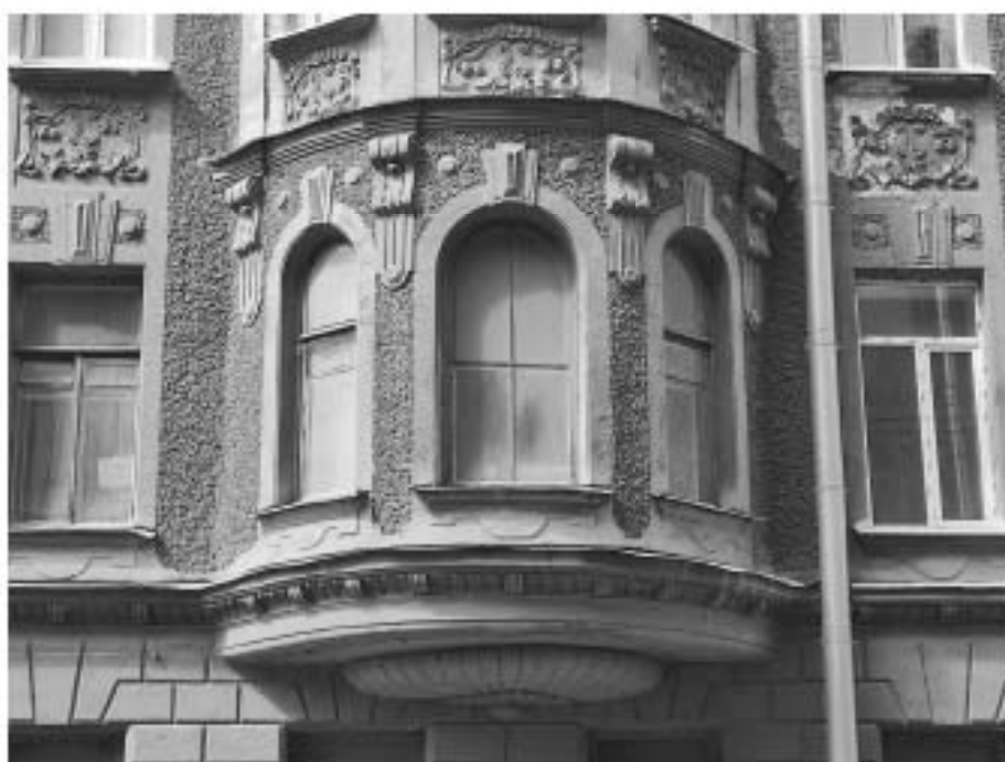
24. «Дом З.Н. Левина», 6-я Красноармейская ул., д. 15, лит. А. Восточный фасад. Фрагмент. Фото 22.04.2024г.
