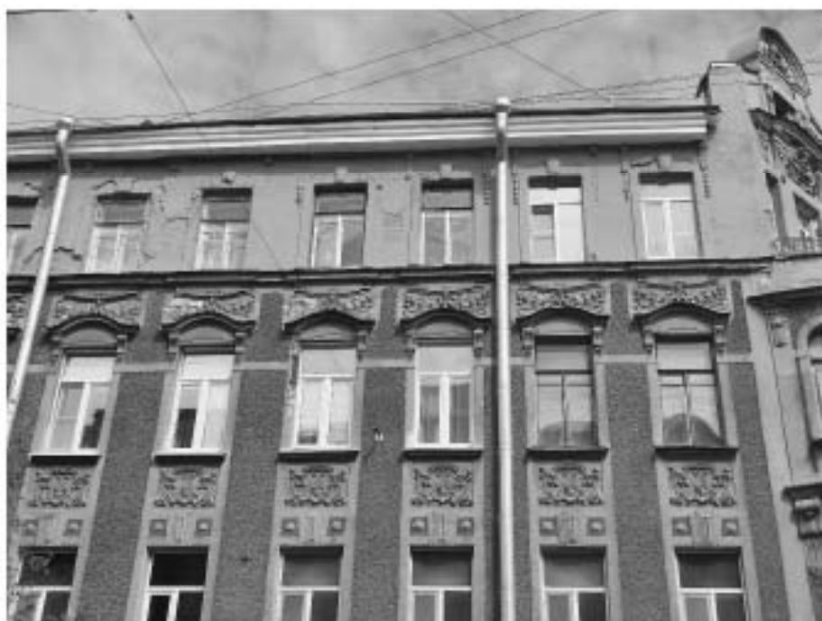
10. «Дом З.Н. Левина», 6-я Красноармейская ул., д. 15, лит. А. Южный фасад. Фрагмент. Фото 22.04.2024г.
