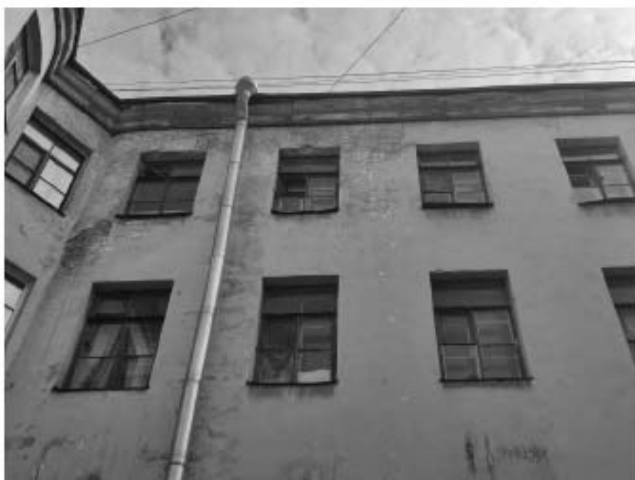
37. «Дом З.Н. Левина», 6-я Красноармейская ул., д. 15, лит. А. Дворовый фасад. Фрагмент. Фото 22.04.2024г.
