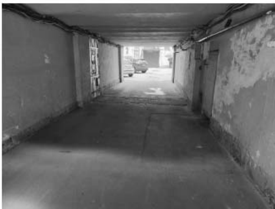
49. «Дом З.Н. Левина», 6-я Красноармейская ул., д. 15, лит. А. Проходная арка. Общий вид. Фото 22.04.2024г.
