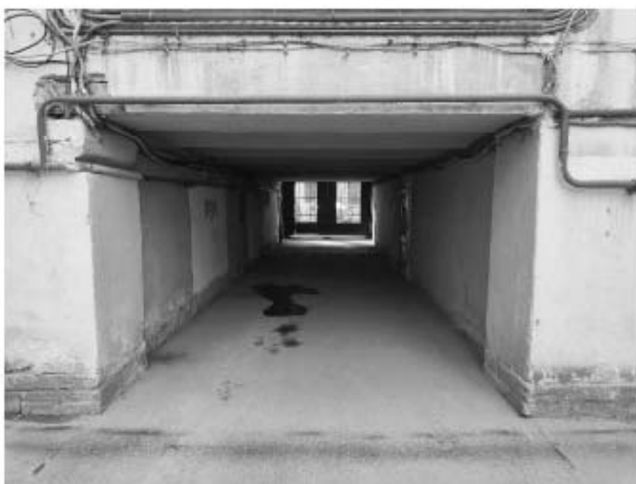
48. «Дом З.Н. Левина», 6-я Красноармейская ул., д. 15, лит. А. Проходная арка. Общий вид. Фото 22.04.2024г.
