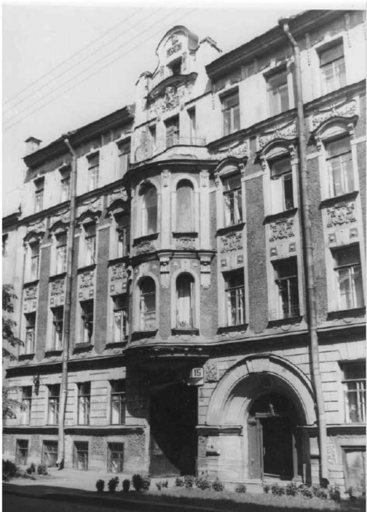
Илл. 57. Фасад жилого дома № 15 по 6-й Красноармейской улице. Фотография Овчинникова К.В. 20 июня 1985 г. ЦГАКФФД СПб (инв. № Ар 217598)
