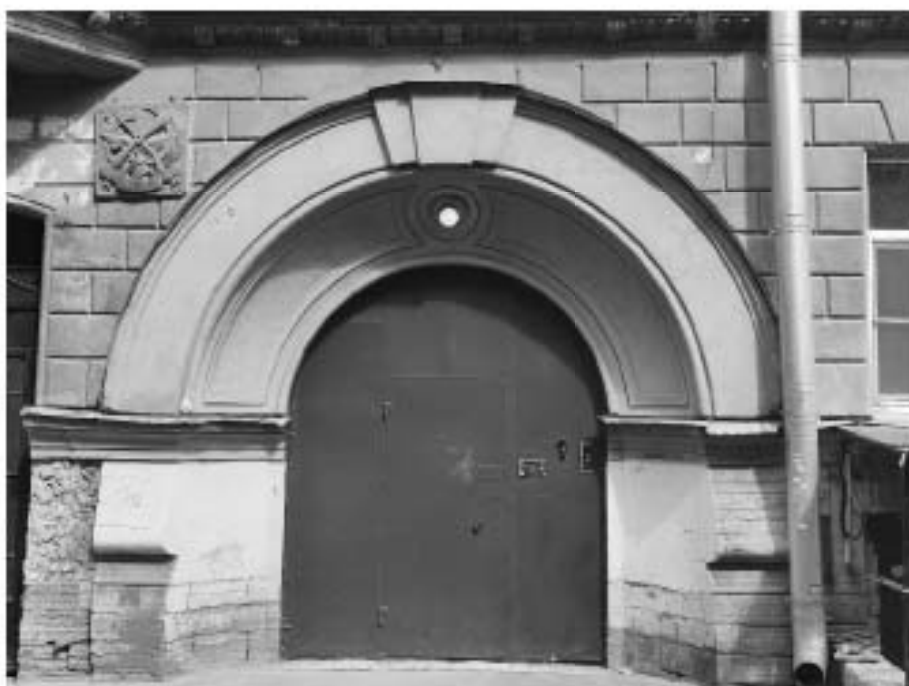
12. «Дом З.Н. Левина», 6-я Красноармейская ул., д. 15, лит. А. Южный фасад. Фрагмент. Фото 22.04.2024г.
