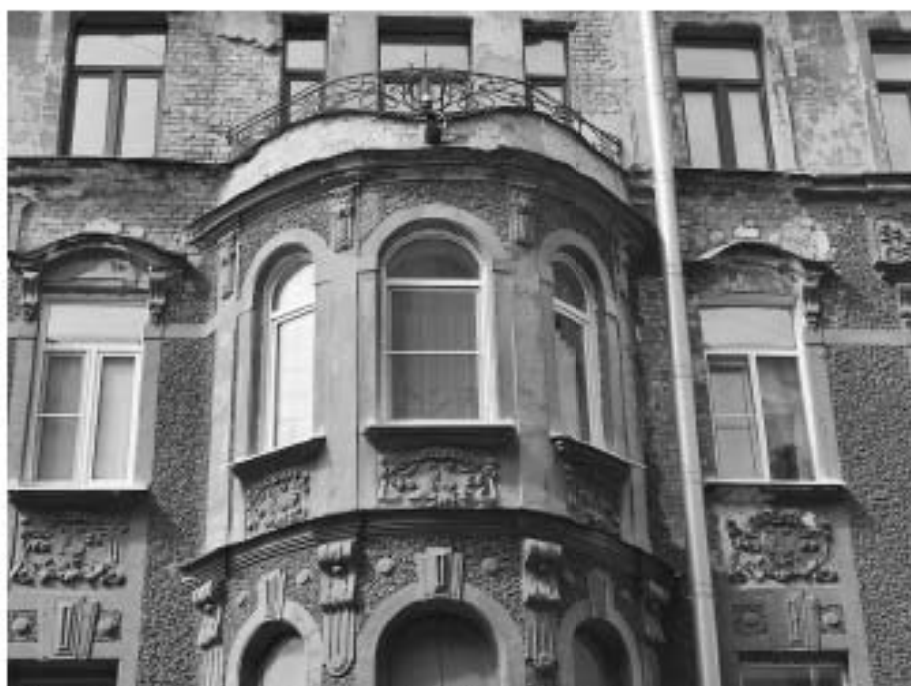
23. «Дом З.Н. Левина», 6-я Красноармейская ул., д. 15, лит. А. Восточный фасад. Фрагмент. Фото 22.04.2024г.
