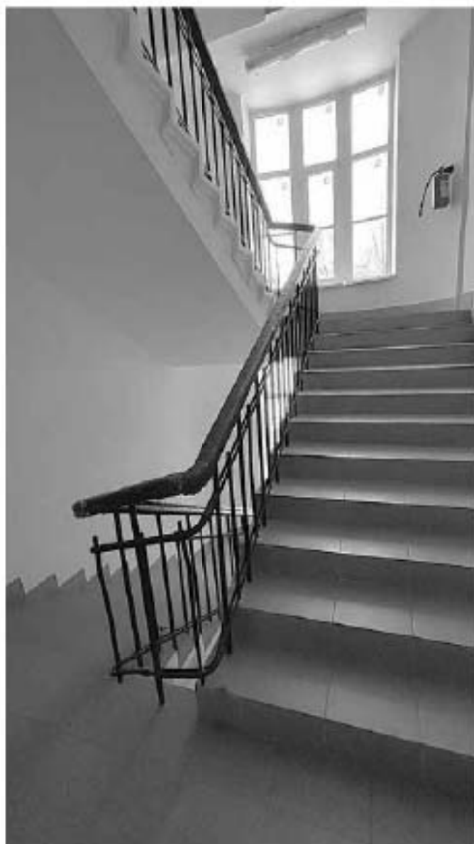
13. Лестница в северной части здания.
