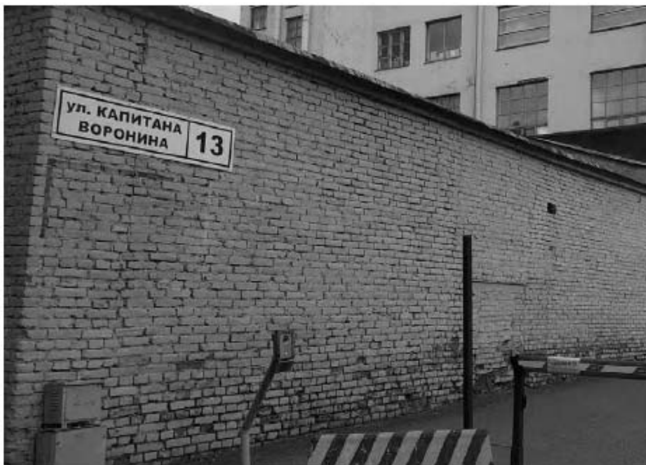
б. Фрагмент западного фасада. Трещины в кладке, перемычка заложеного в центральной части фасада.
