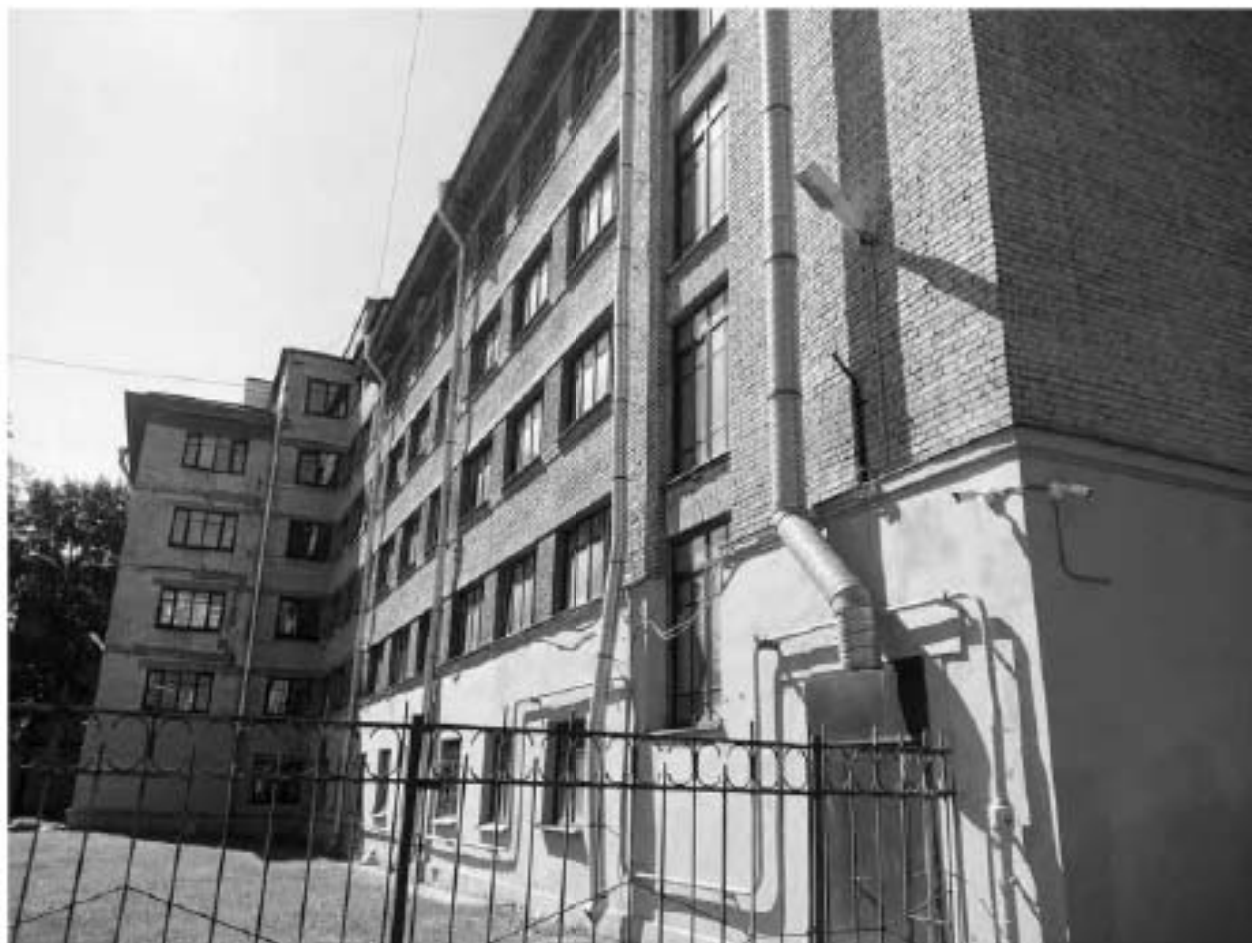
10. Восточный фасад, южная часть. На фасаде в левой части кадра – следы демонтированных исторических балконов.
