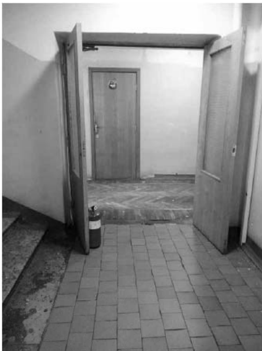
20. Южная часть корпуса. 2ЛК. Площадка в уровне 4 этажа (отделка типовая для этажных площадок данной лестницы).
