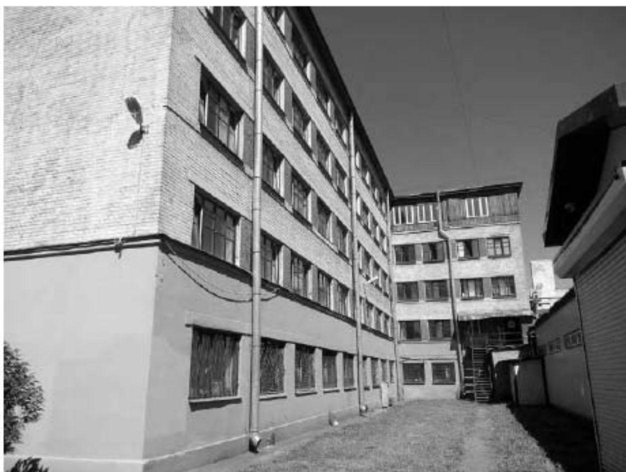
4. Восточный фасад и южный фасад объёма, примыкающего к клубу.
