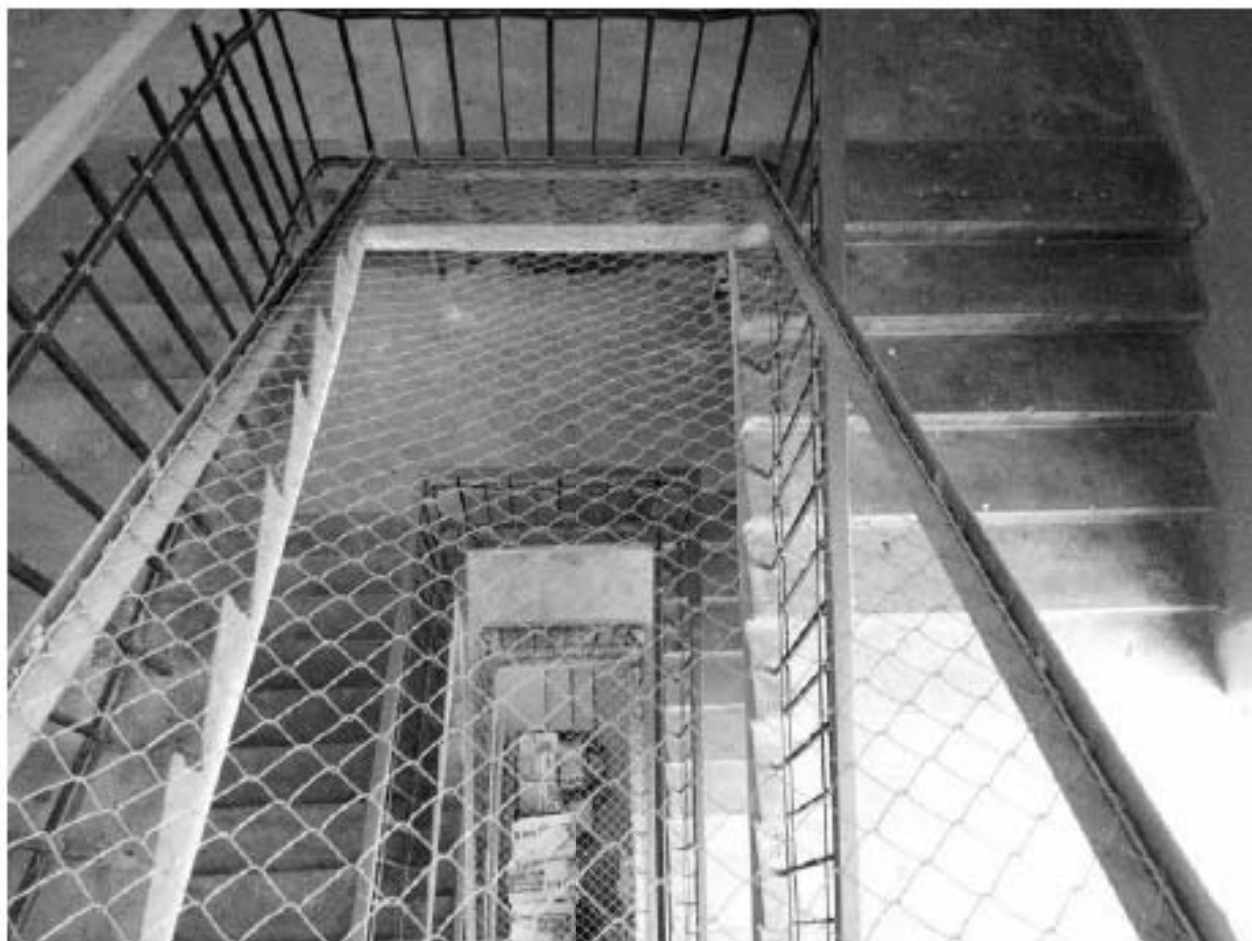
37. 1ЛК. Общий вид лестницы с промежуточной площадкой в уровне 4 этажа.
