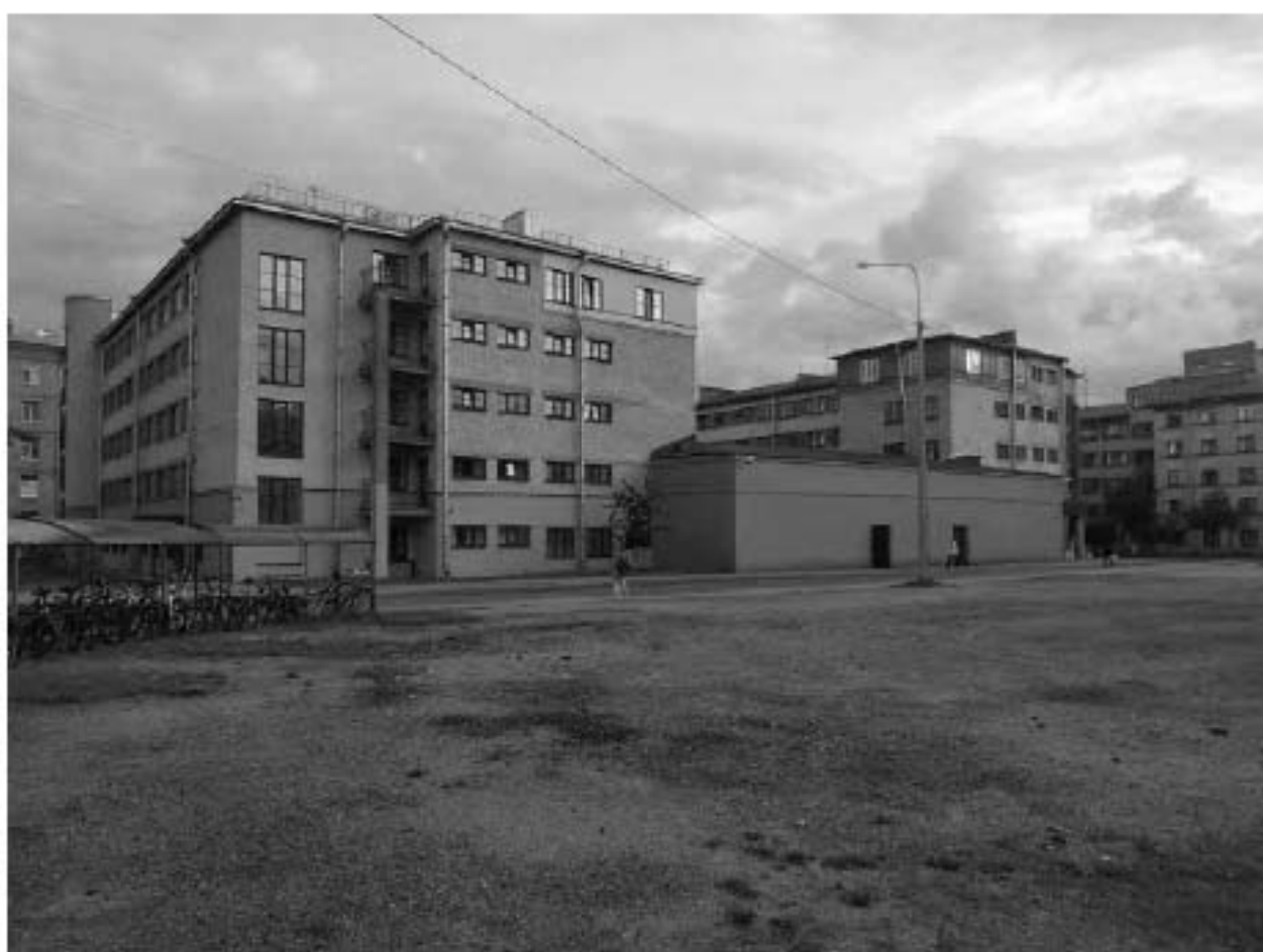
2. Общий вид на клуб и фланкирующие здания общежитий с северо-востока.
