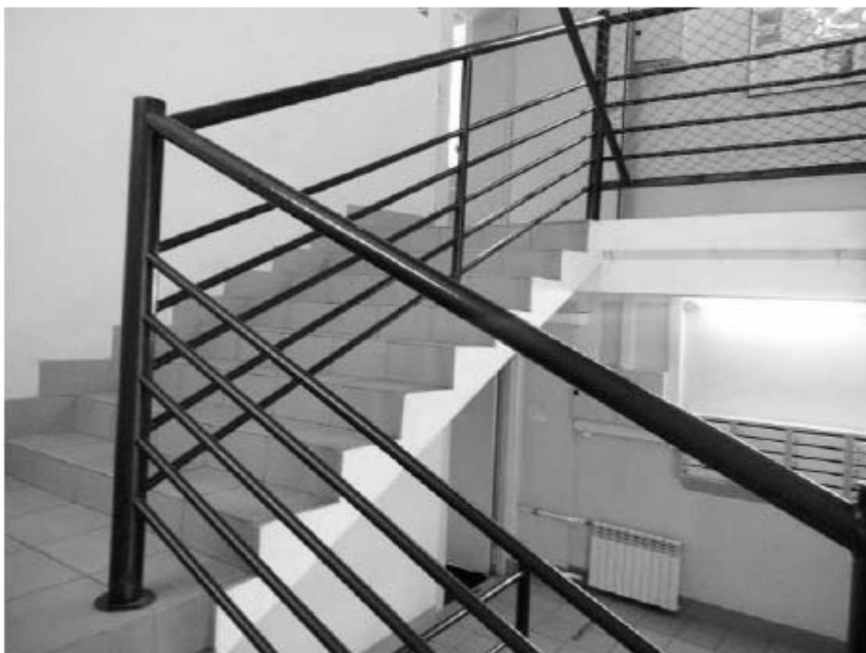
13. Лестница на стыке центрального и южного объема. Современное ограждение.
