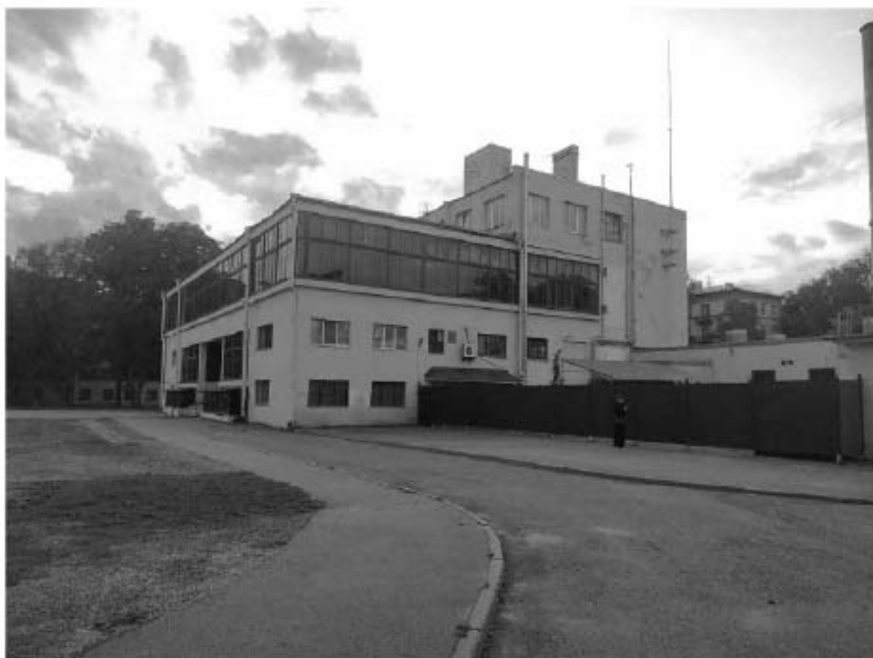
2. Общий вид здания – восточный и южный фасады.
