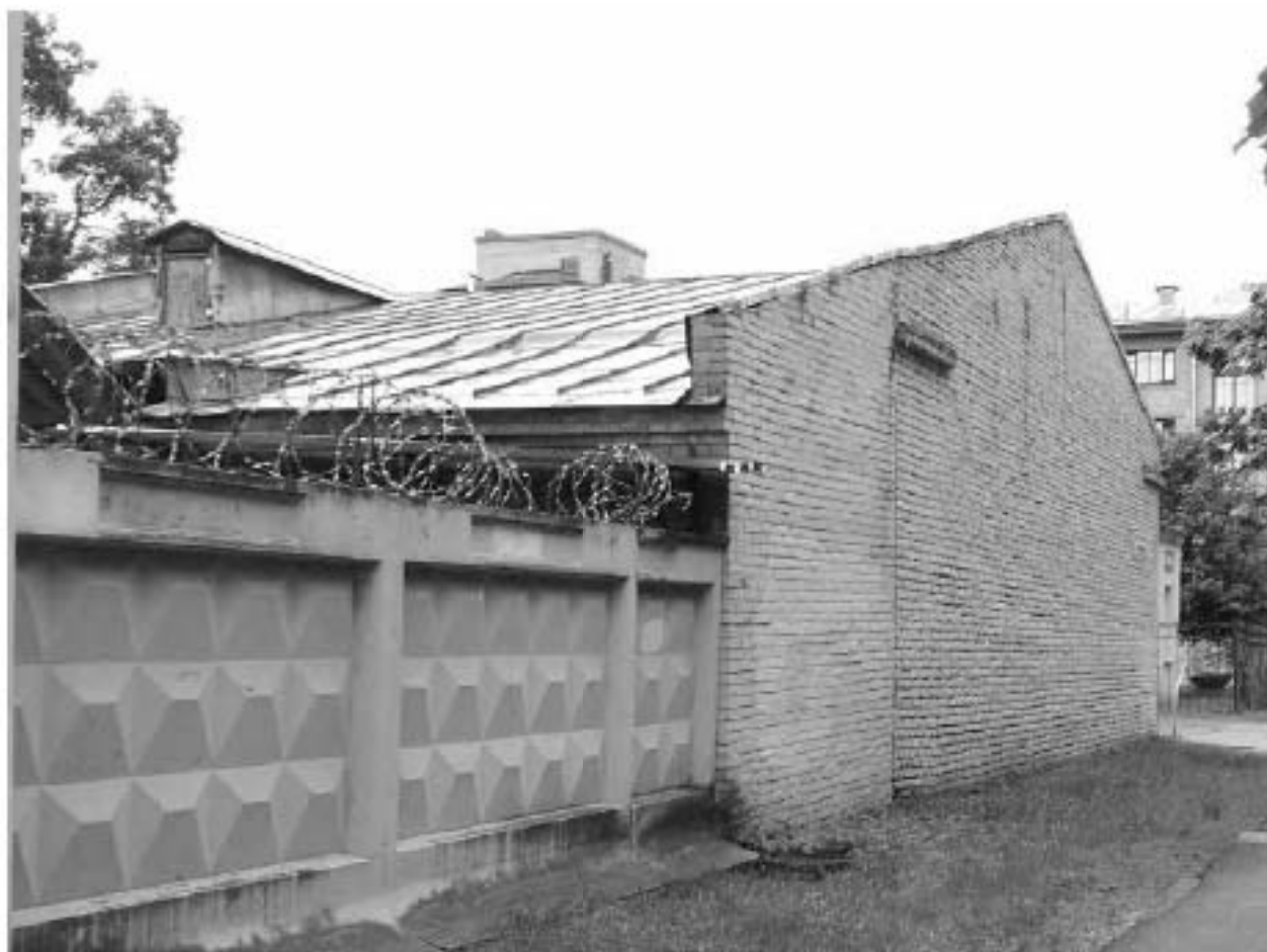
7. Северный фасад, вид с востока. Вертикальная линия – стык исторического объема и поздней пристройки.
