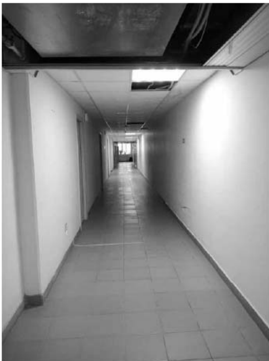
27. Коридор южного объёма в уровне 1 этажа, вид на север.
