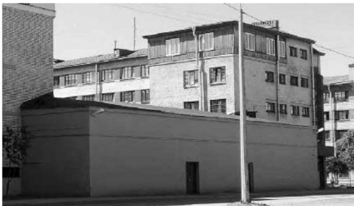
1. Общий вид здания с северо-востока (на первом плане – клуб). В уровне 5 этажа - надстройка на месте исторически существовавшей террасы.
