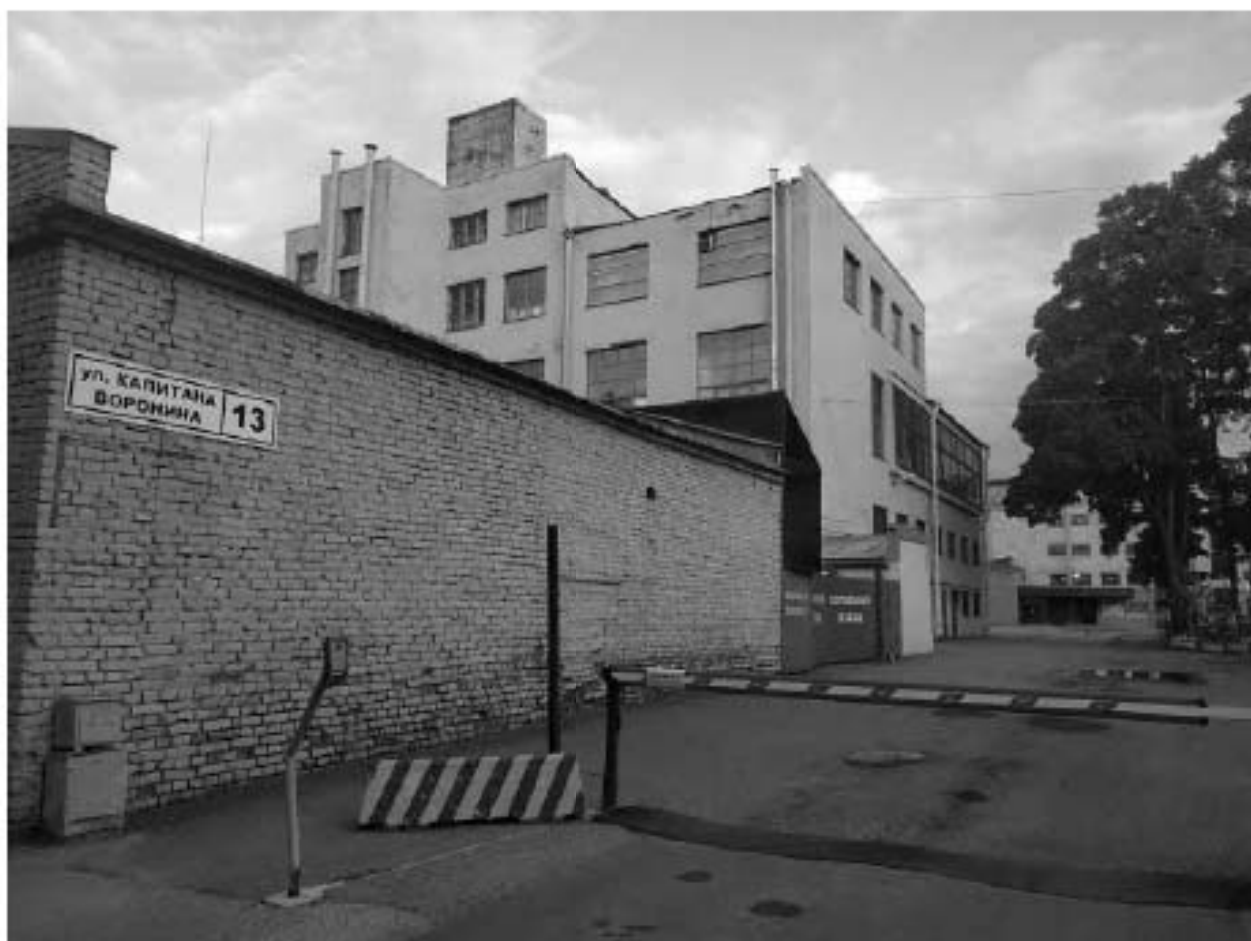
7. Общій вид здания с ул. Капитана Воронина.
