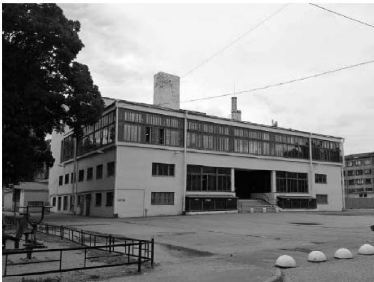
1. Общий вид здания – западный и южный фасады.
