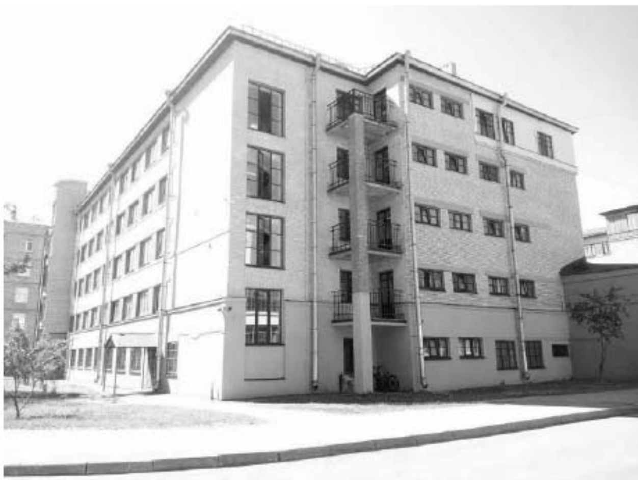
1. Общий вид с северо-востока.
