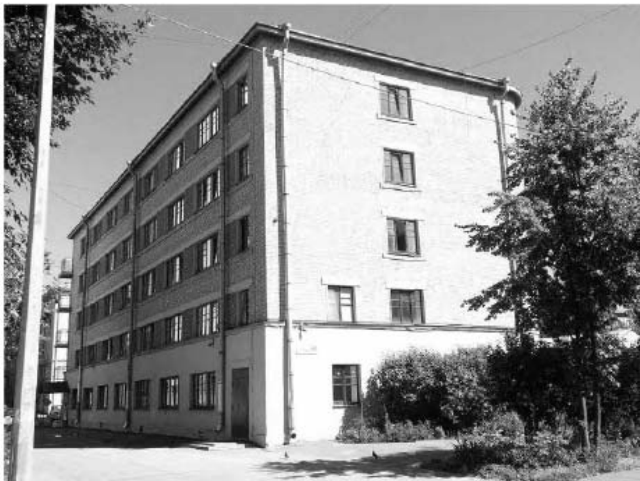
4. Западный и южный торцевой фасады. Вид с юго-запада.
