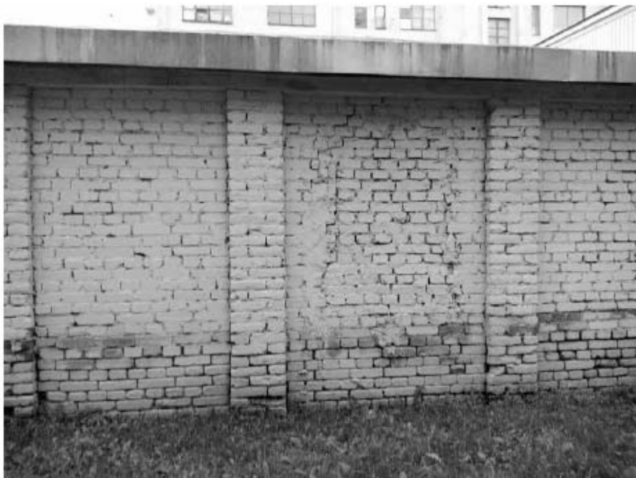
5. Северный фасад, следы закладки проёма.
