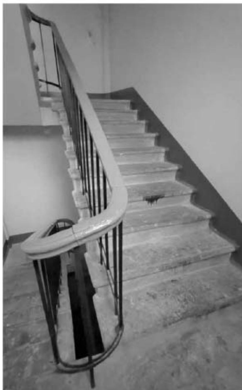
12. Лестница в южной части здания.
