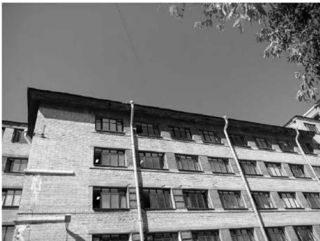
6. Фрагмент восточного фасада. Свес кровли оштукатурен по дранке, отделка имеет существенные утраты.
