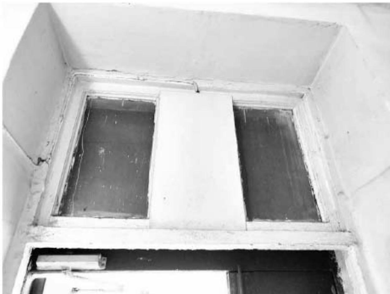
7. Стеклопанная рама фиксирует исторические габариты проёма.
