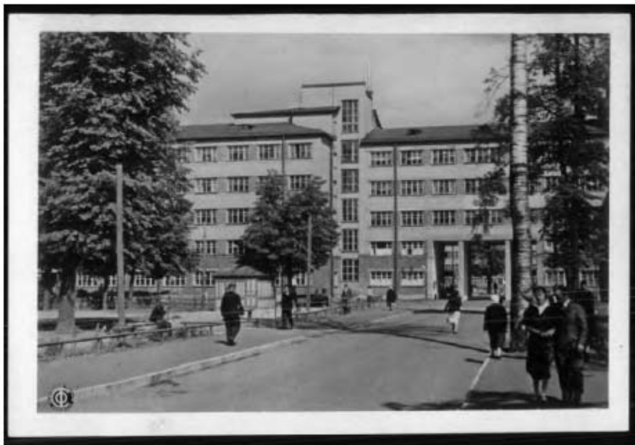
40. Ленинград. Студенческий городок Индустриального института. Автор фото – Величко Е. Дворовый корпус городка. 1930-е. ГМИ СПб. 432817/434. (Вид на корпус по Парголовской ул. с запада).
