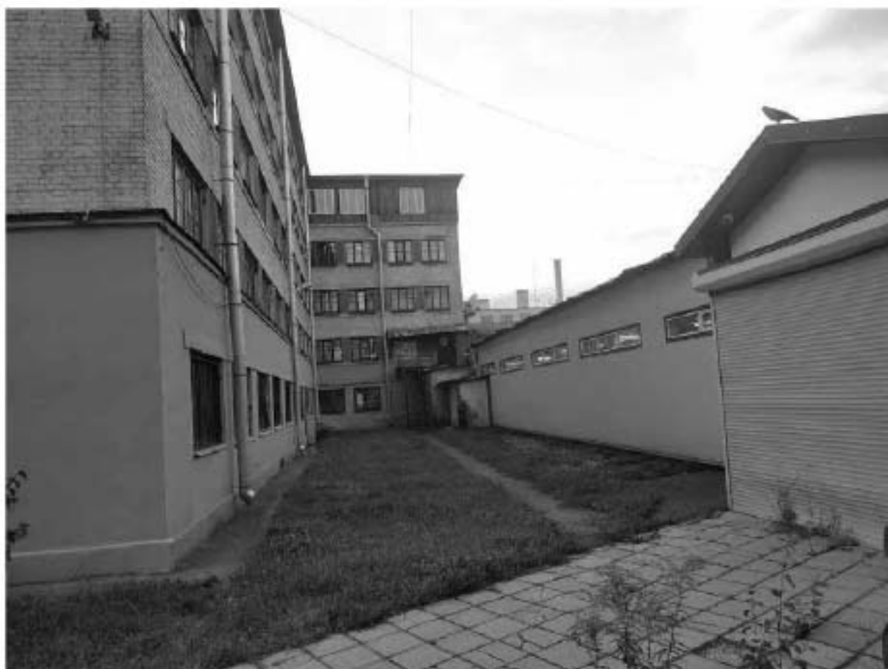
4. Вид поздней пристройки с юго-западной стороны.
