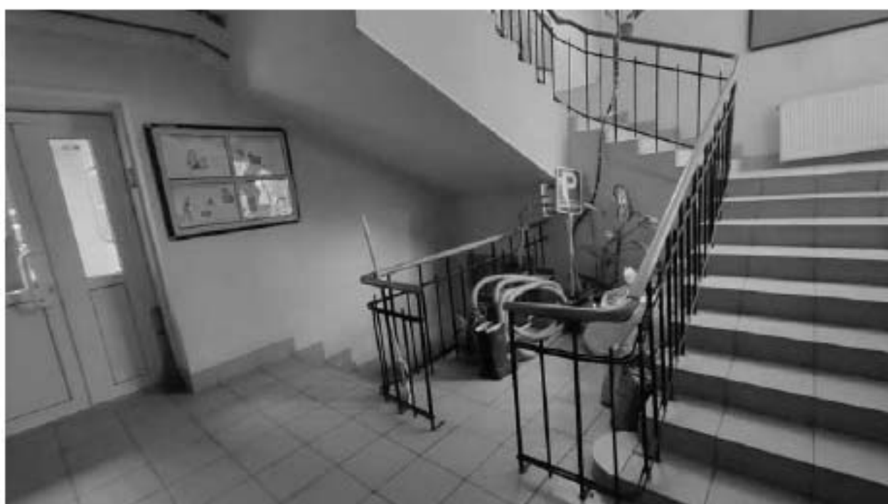
6. Общий вид центральной лестничной клетки в уровне первого этажа.
