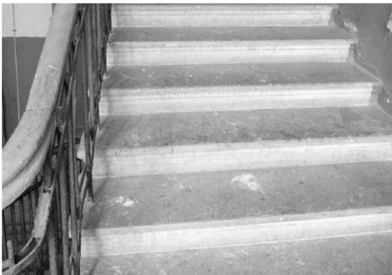
13. Южная лестница (ЛЖ). Ступени в уровне 5 этажа.
