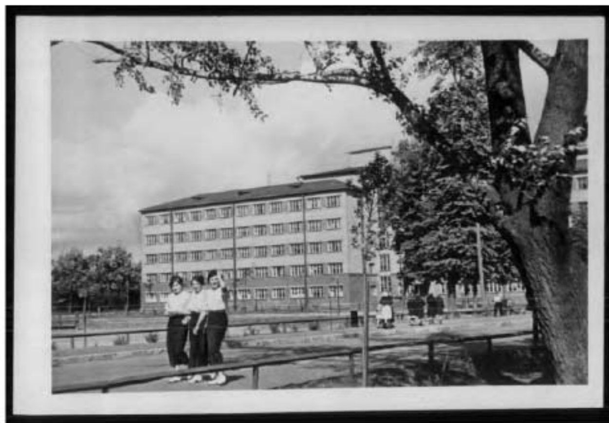
41. Ленинград. Студенческий городок Индустриального института. Автор фото – Величко Е. 1930-е. ГМИ СПб. 432817/433. (Вид на корпус по Парголовской ул. с запада).
