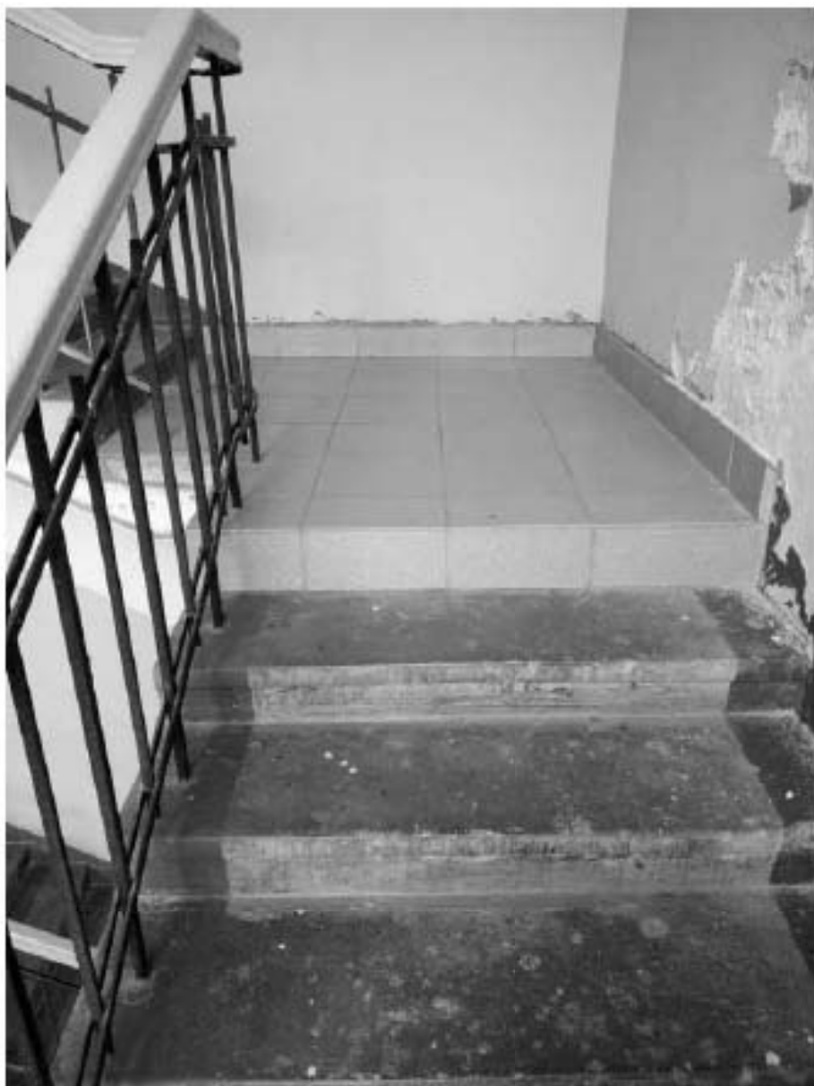
17. Южная часть корпуса, промежуточная площадка в уровне чердака (2ЛК). Бетонные ступени (характерны для всех лестниц корпуса выше 5 этажа).
