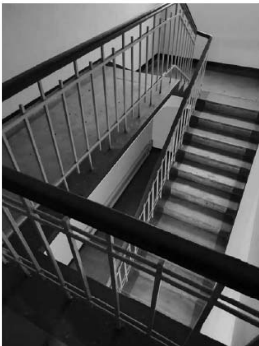
16. Лестничная клетка в центральной части здания.
