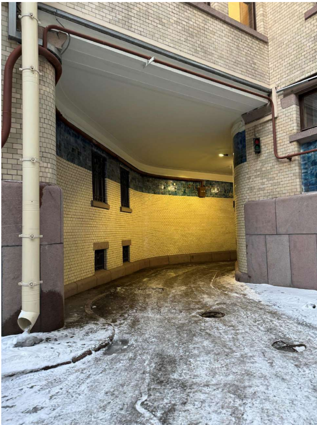
Фото 4. Проезд с лицевого фасада во двор объекта культурного наследия.
