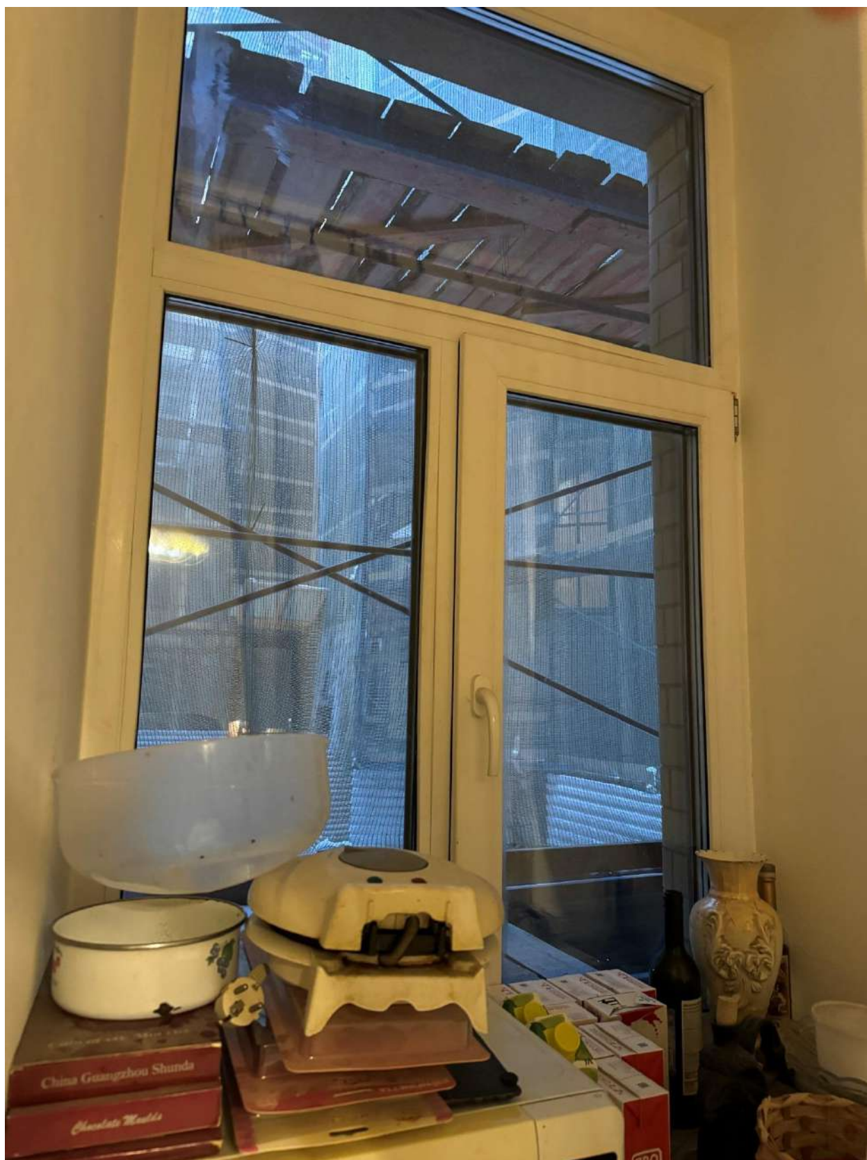
Фото 27. Вид на оконное заполнение квартиры № 63 объекта культурного наследия.
