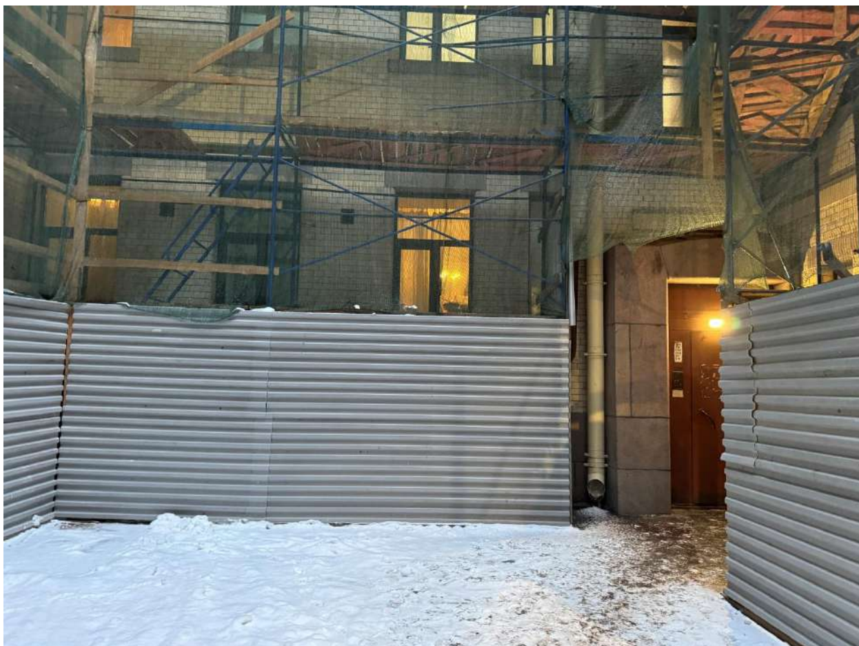
Фото 9. Фрагмент западного фасада третьего двора объекта культурного наследия.
