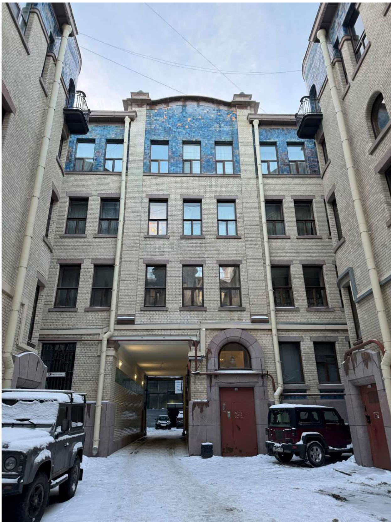
Фото 5. Общий вид дворового фасада объекта культурного наследия.
