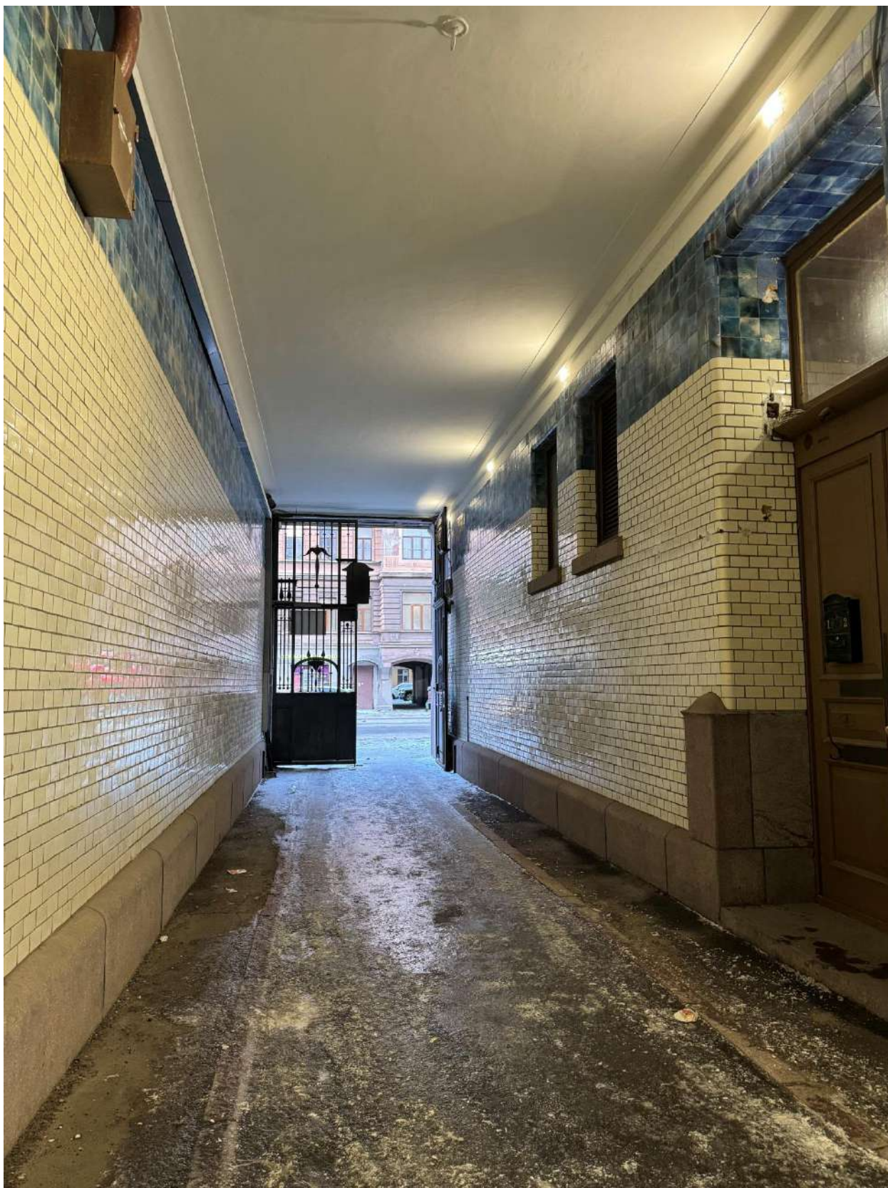
Фото 3. Проезд с лицевого фасада во двор объекта культурного наследия.
