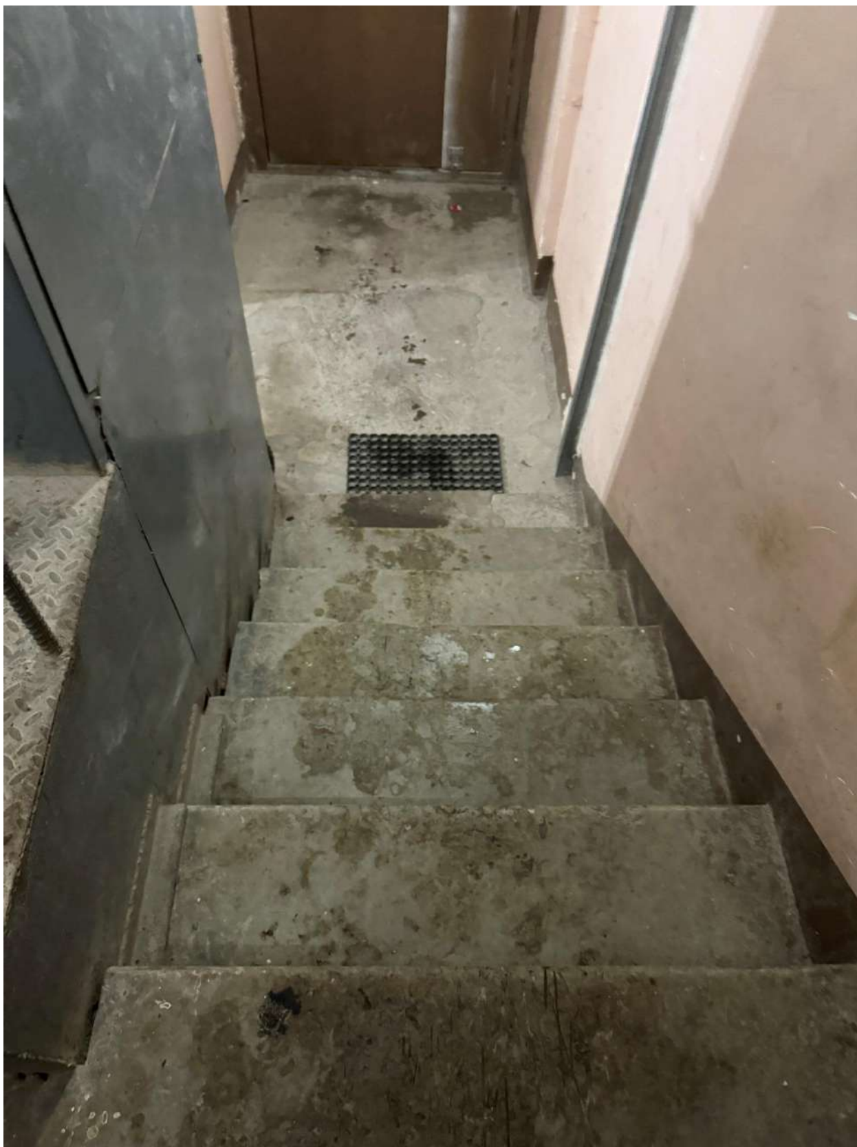
Фото 13. Общий вид лестницы, ведущей в квартиру 63, объекта культурного наследия.
