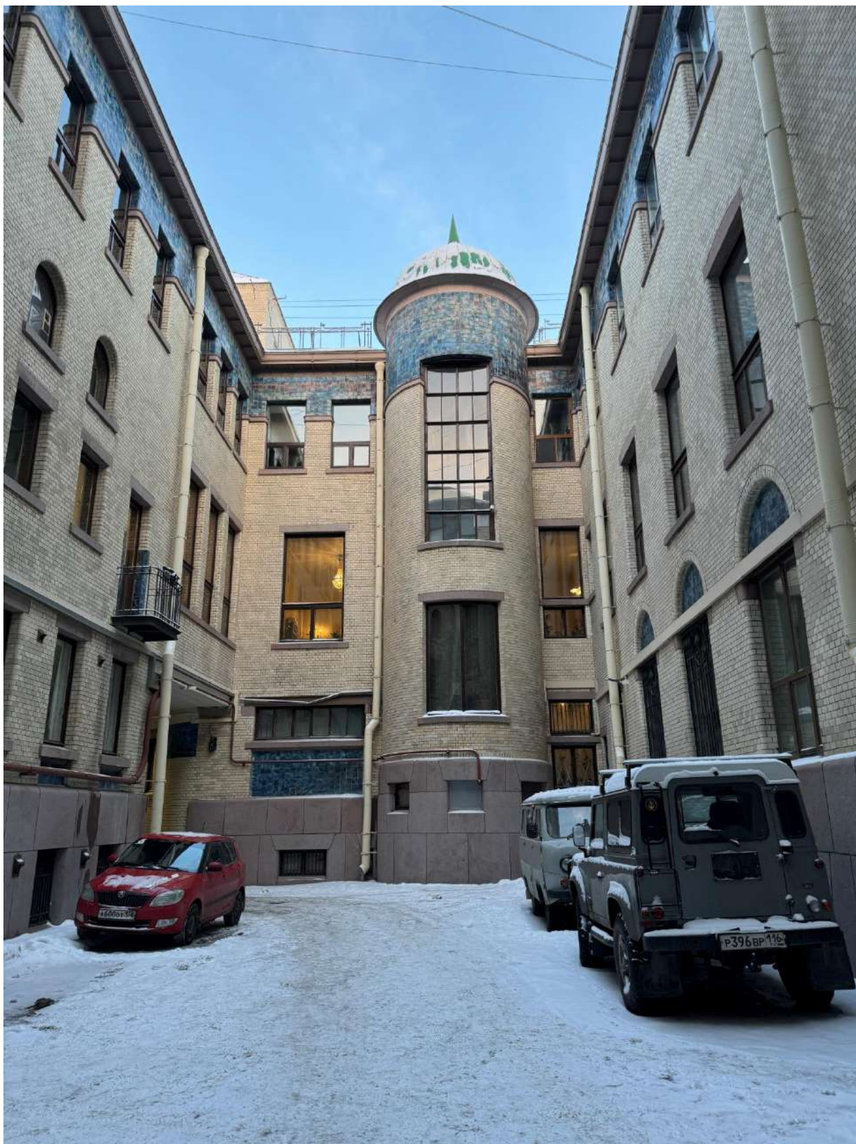
Фото 6. Общий вид дворового фасада объекта культурного наследия.
