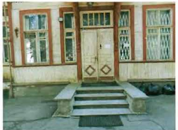
4. Вход со стороны западного фасада здания.
