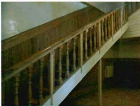
7. Интерьер здания. Лестница.
