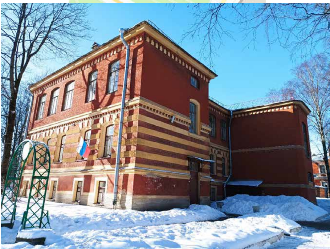
9. Выявленный объект культурного наследия «Мужское городское училище», по адресу: Санкт-Петербург, г. Пушкин, Октябрьский бульвар, 18; Оранжерейная ул., 40. Общий вид объекта. Дата съемки: 21.02.2024 г.
