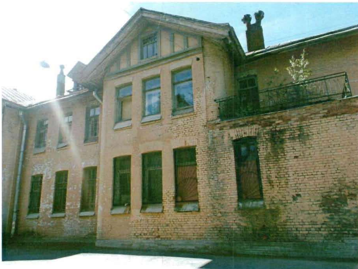
2. Вид со стороны северного фасада здания.
