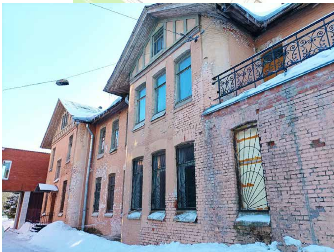
25. Объект культурного наследия регионального значения «Царкосельская община сестер милосердия Красного Креста», по адресу: Санкт-Петербург, г.Пушкин, Леонтьевская ул., д. 33/14, лит. А, д. 35, лит. А. Главное здание (общежитие сестер и церковь). Фасад северо-восточный. Дата съемки: 21.02.2024 г.
