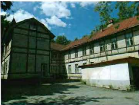
3. Вид с северо-восточной стороны фасада.
