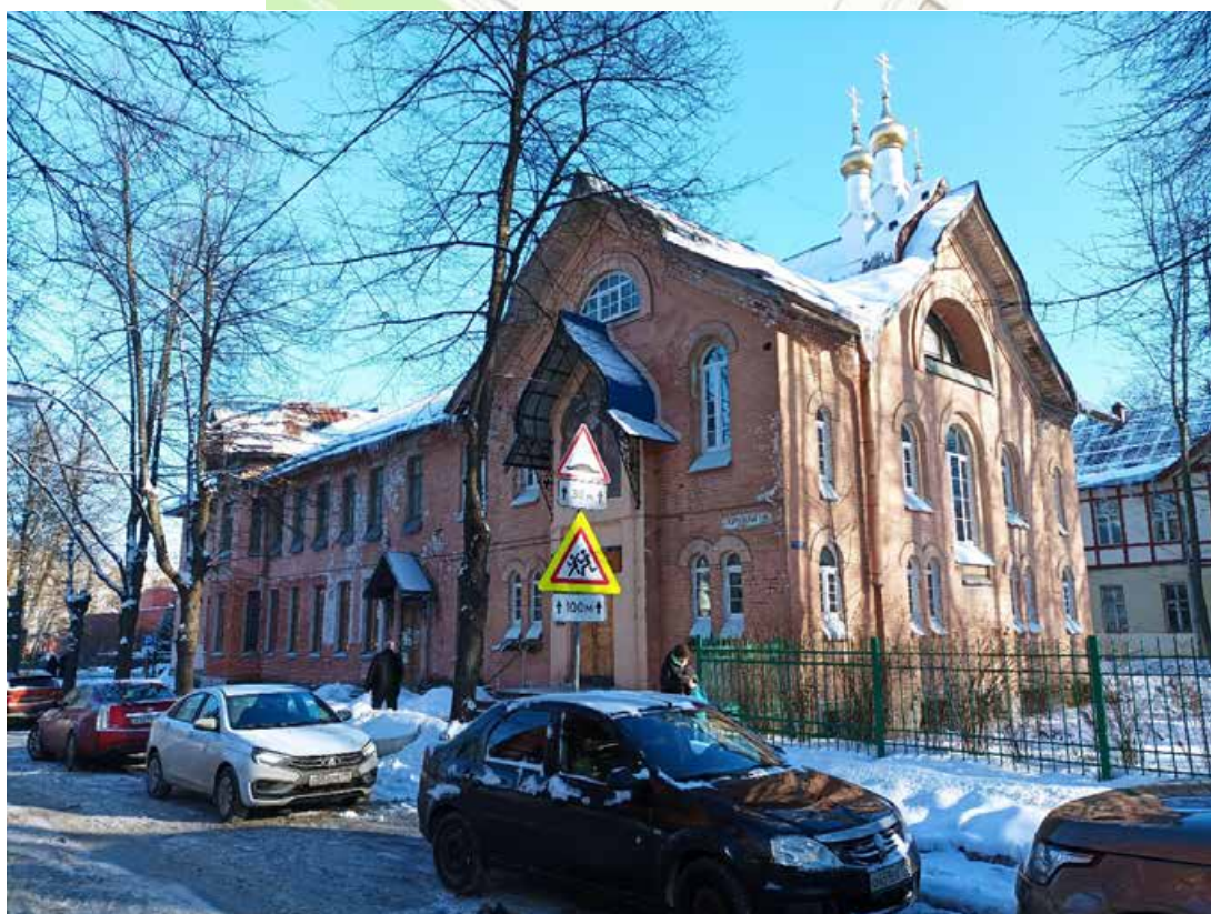
22. Объект культурного наследия регионального значения «Царскосельская община сестер милосердия Красного Креста», по адресу: Санкт-Петербург, г.Пушкин, Леонтьевская ул., д. 33/14, лит. А, д. 35, лит. А. Главное здание (общежитие сестер и церковь). Общий вид. Дата съемки: 21.02.2024 г.
