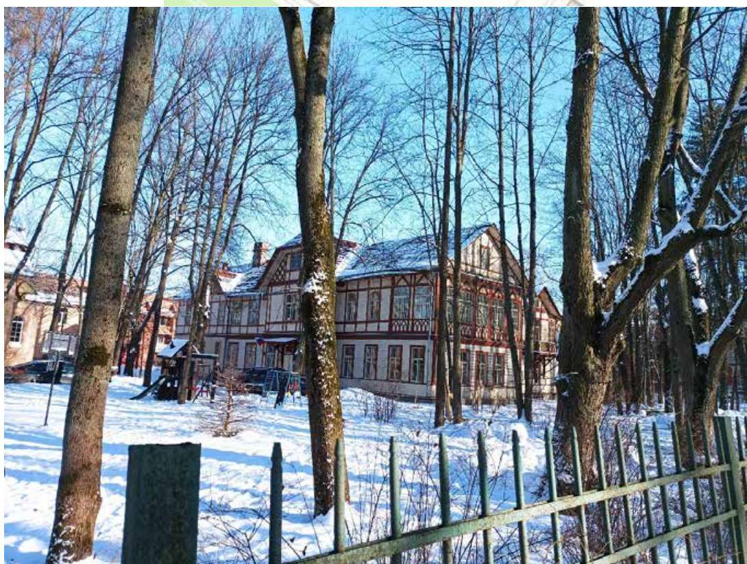
19. Объект культурного наследия регионального значения «Царскосельская община сестер милосердия Красного Креста», по адресу: Санкт-Петербург, г.Пушкин, Леонтьевская ул., д. 33/14, лит. А, д. 35, лит. А. Здание амбулатории. Общий вид объекта. Дата съемки: 21.02.2024 г.
