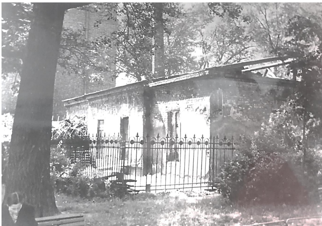
46. Фрагмент сада в юго-западной части участка Суворовского музея. В глубине участка ремонтируемое здание служб, отделенное от сада исторической оградой. На переднем плане видны фрагменты садовых скамеек («ленинградские диваны») и металлического ограждения газона. Фото 1971 г. – Коренцвит В.А. Историческая справка. Музей Суворова. Л. 1971 г. б/л. (Архив КГИОП. П-485, Н-1617/1).
