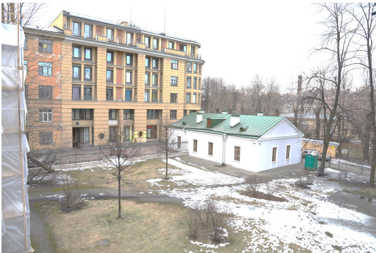
60. Музей А.В.Суворова. Фотосъемка сада музея со строительных лесов (юго-западная часть). 2010-е гг. – Из архива Музея А.В. Суворова.
