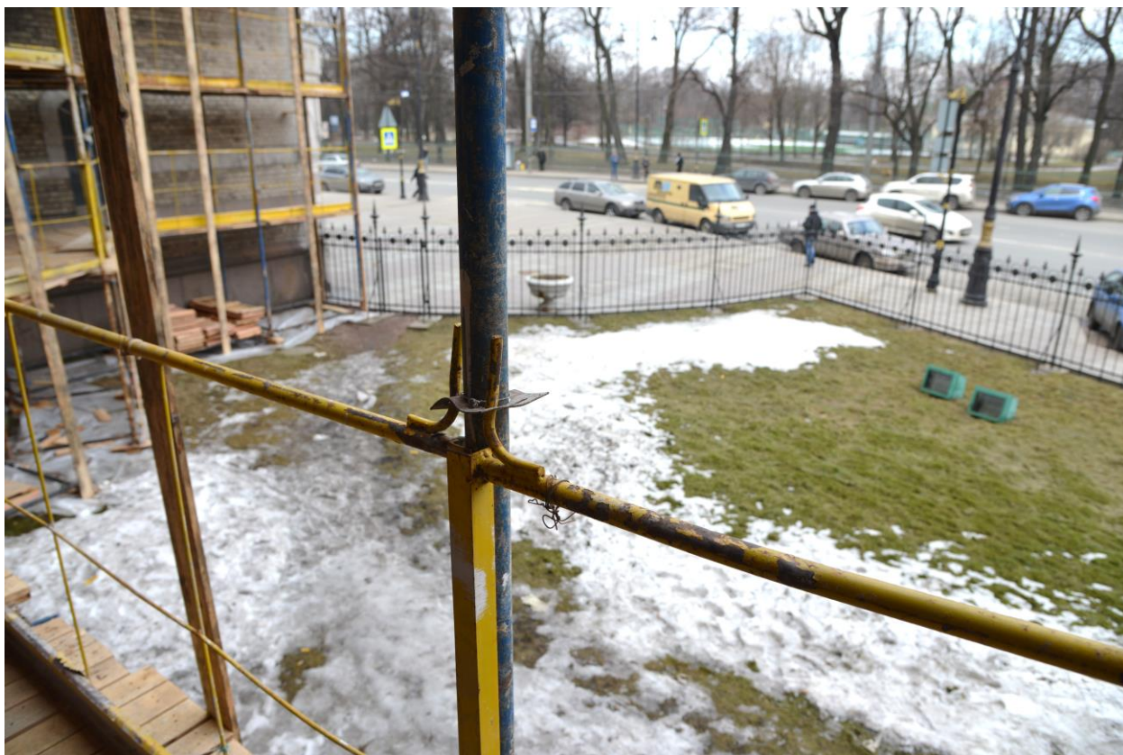
55. Музей А.В.Суворова. Фотосъемка сада музея со строительных лесов (северная часть). 2010-е гг. – Из архива Музея А.В. Суворова.
