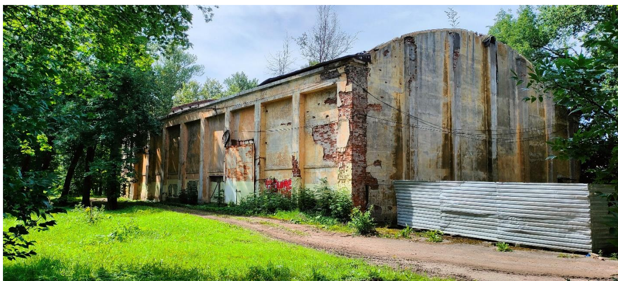
Фото 17. Здание в северной части парка.
