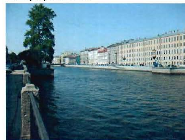
12. Вид со стороны Измайловского моста (по течению реки)
