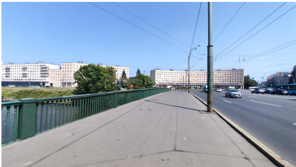
Фото 3. Общий вид на Комаровский мост и правобережную часть Красногвардейской площади с запада.
