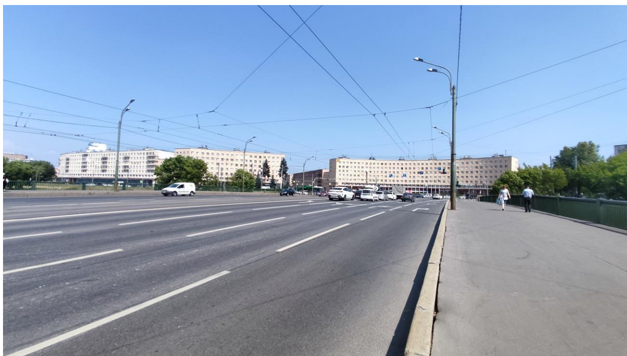
Фото 8. Общий вид на участок планируемых работ по ремонту трамвайных путей с Комаровского моста, с юга.
