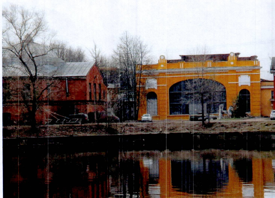
2. Вид со стороны нижнего бьефа
