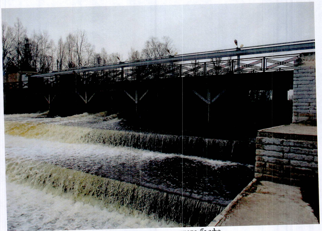
4. Вид со стороны нижнего бьефа
