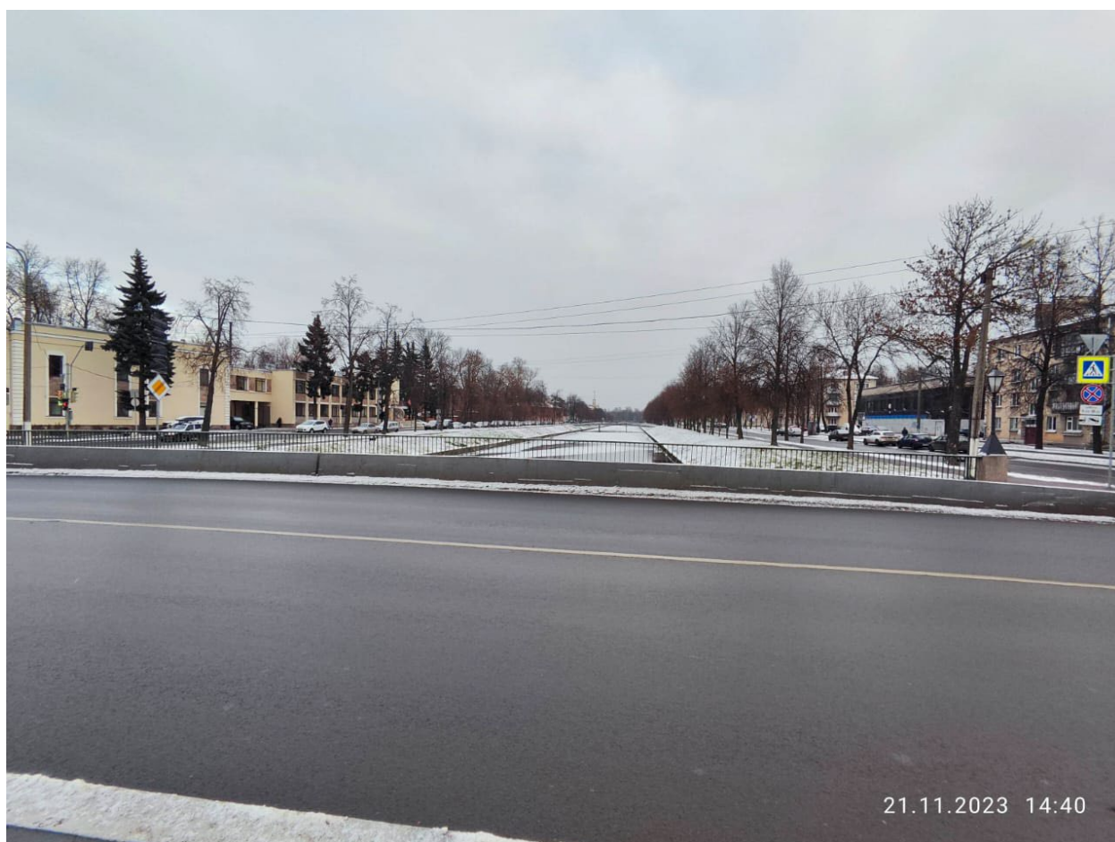
9. Вид на объект культурного наследия федерального значения «Заводы Ижорские Адмиралтейские. Канал водоотводный (прямолинейный) с мостом-плотиной №3». 21.11.2023
