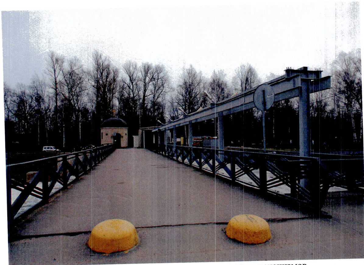
5. Дорожное покрытие. Эстакада для подъемных механизмов
