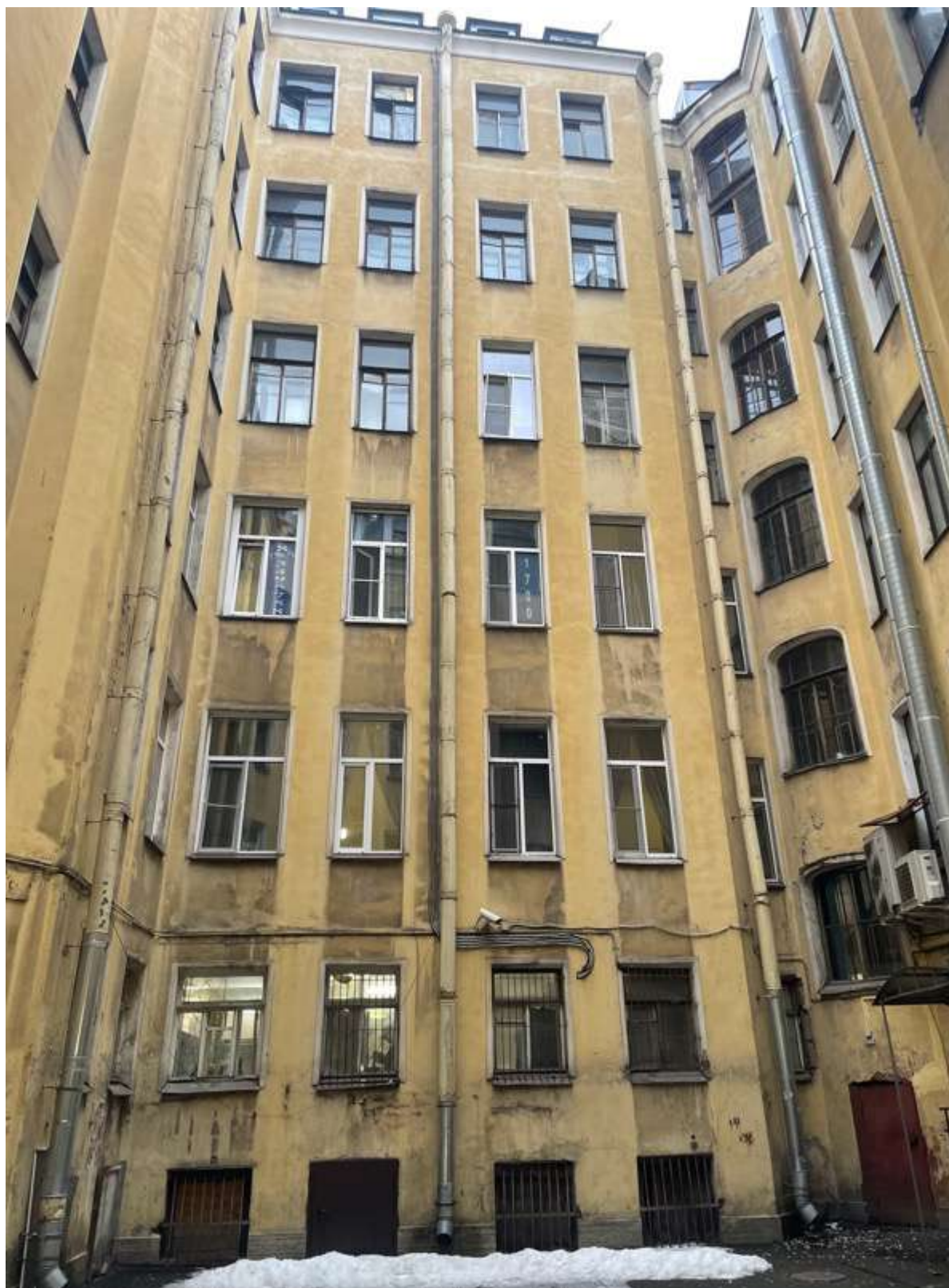
10. Фрагмент дворового фасада
