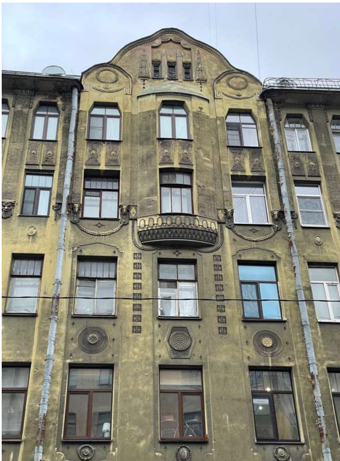
5. Фрагмент фасада по Подольской улице
