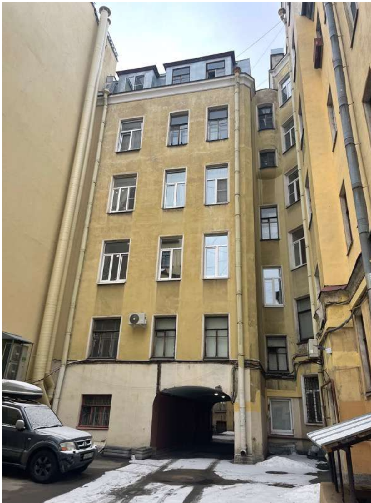
7. Фрагмент дворового фасада
