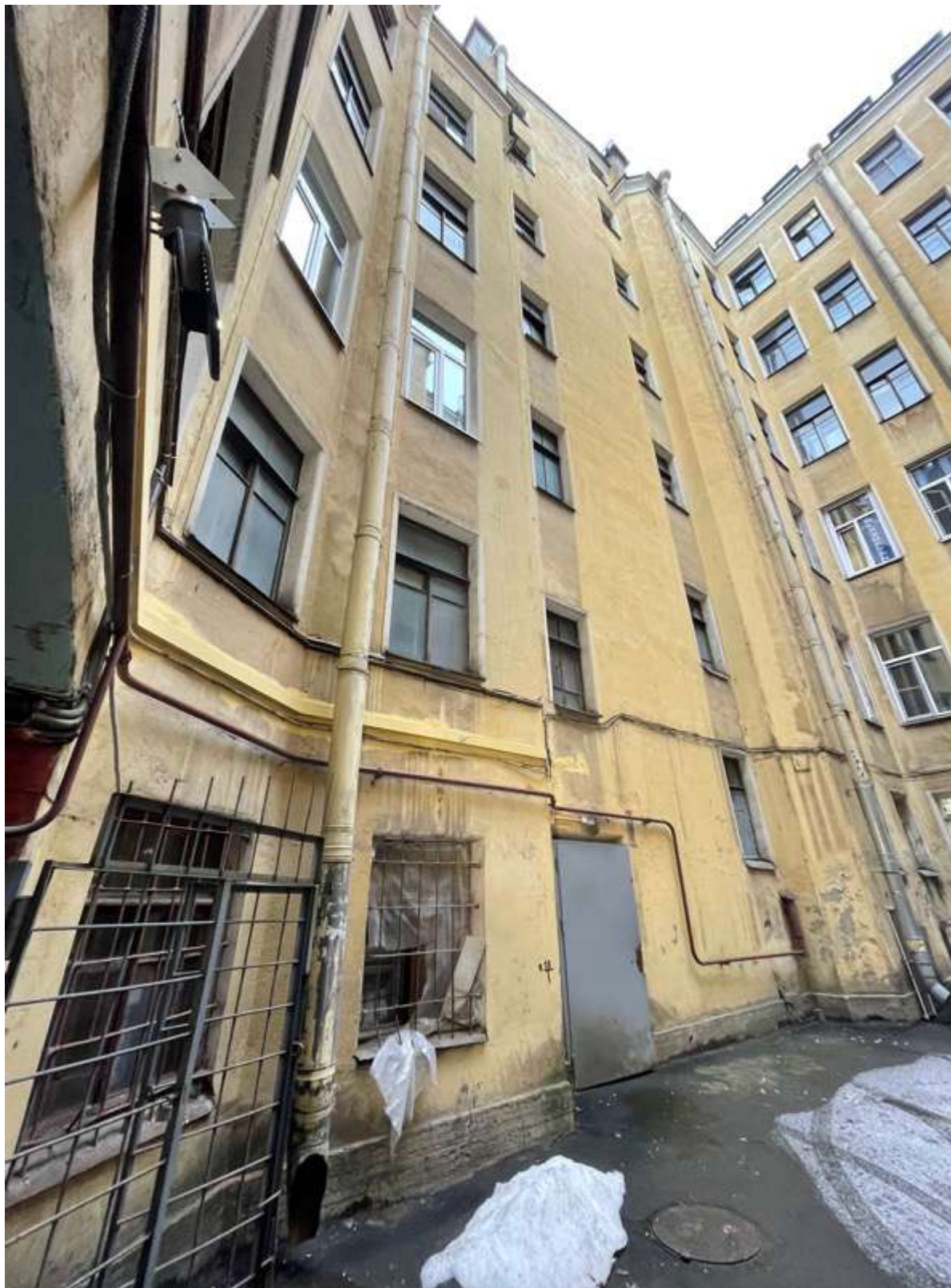
11. Фрагмент дворового фасада
