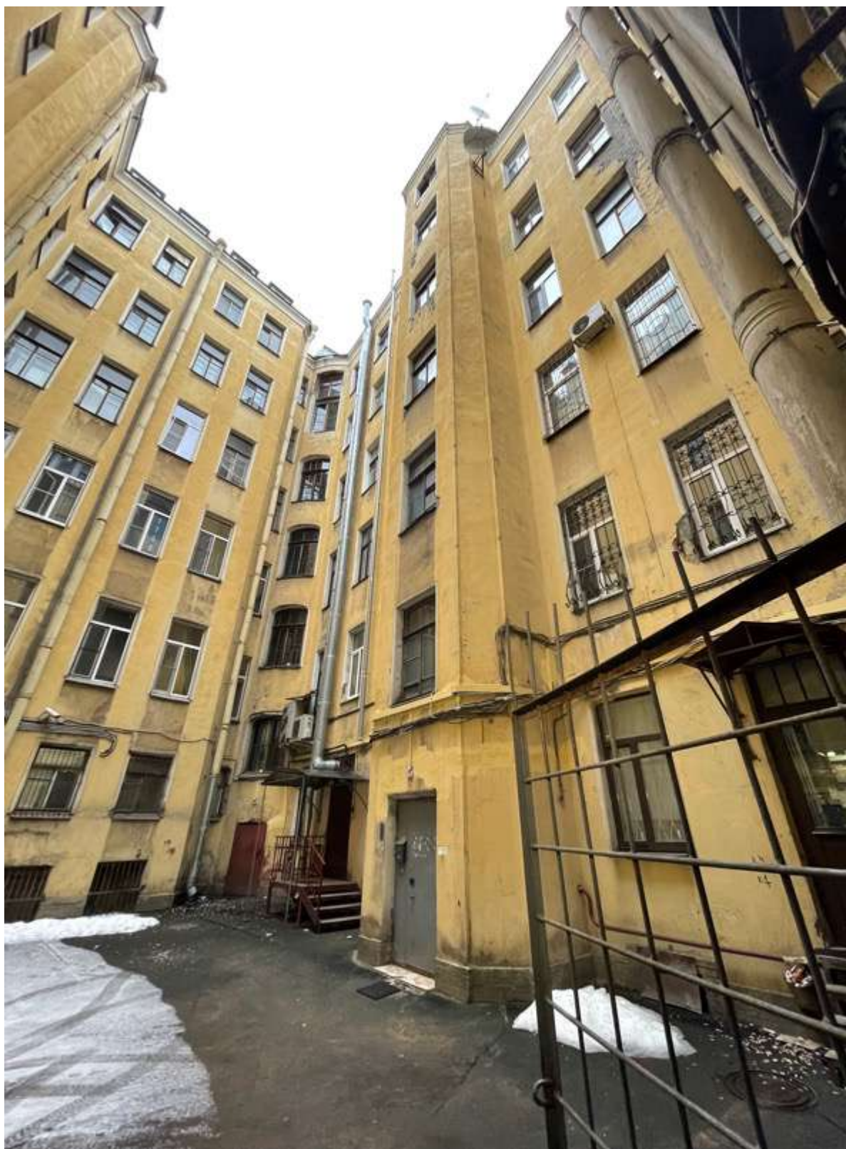
12. Фрагмент дворового фасада
