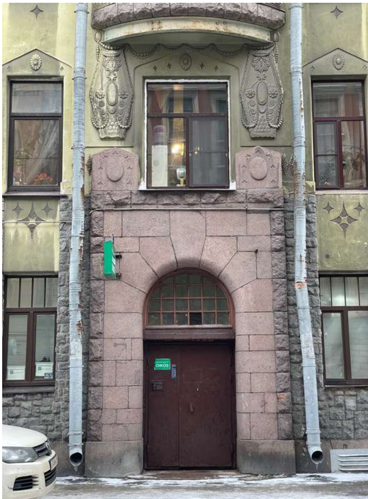
6. Фрагмент фасада по Подольской улице
