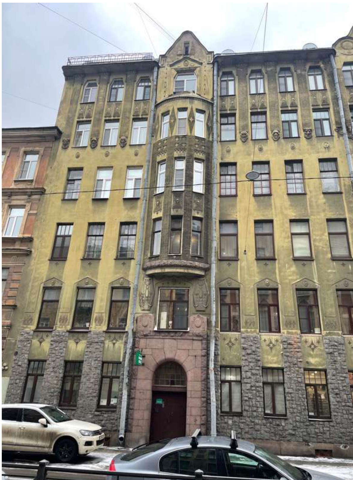
4. Фрагмент фасада по Подольской улице
