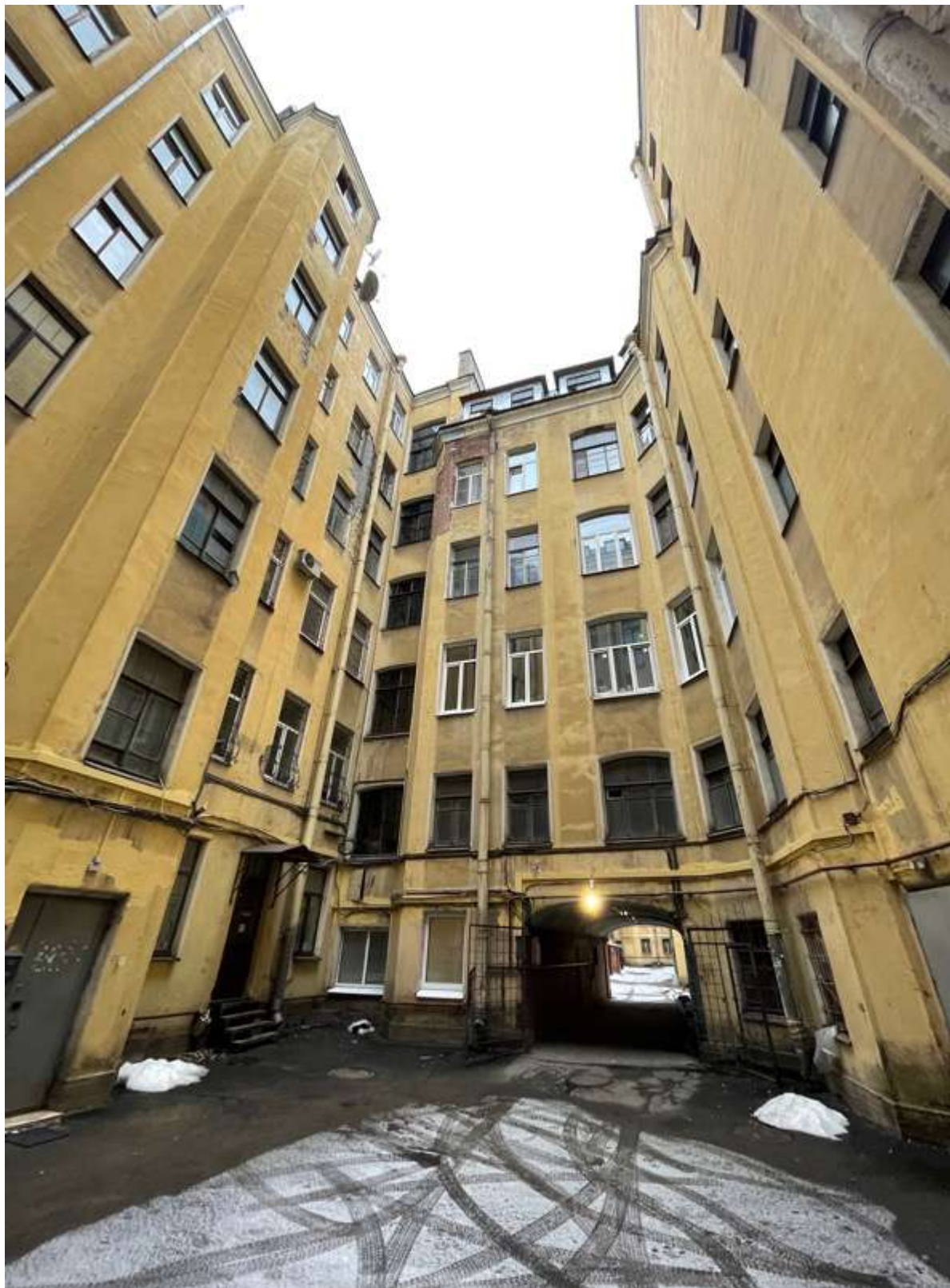
13. Фрагмент дворового фасада
