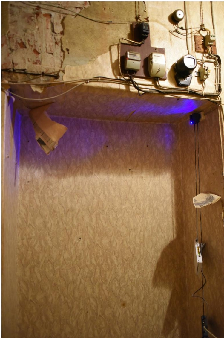
8. Выявленный объект культурного наследия «Дом Н.В. Безобразовой». Фрагмент интерьера квартиры № 29. Раскрываемый существующий проем в кирпичной стене в осях «9» – «10» / «Д» с сохранением существующей перемычки.
