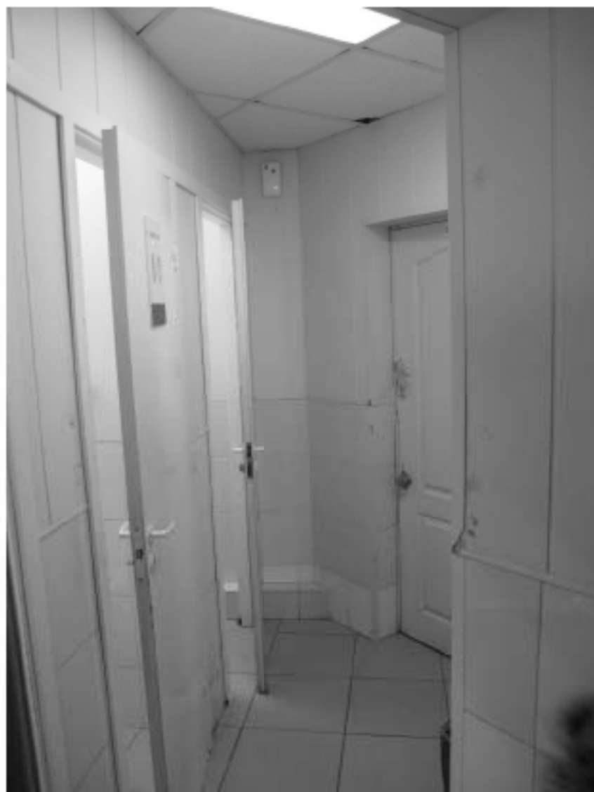
3. Помещение № 318 объекта культурного наследия федерального значения «Академия художеств. Главное здание», расположенного по адресу: г. Санкт-Петербург, Университетская набережная, д. 17, литера Ц. 23.05.2024
