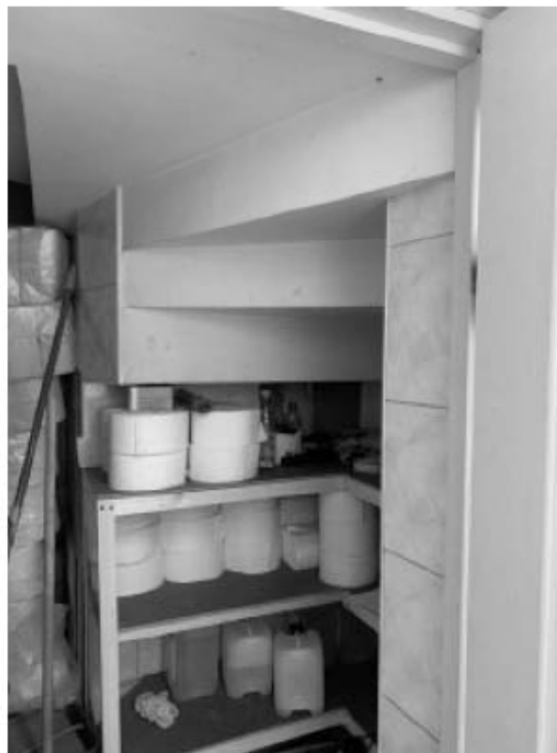
9. Помещение № 322 объекта культурного наследия федерального значения «Академия художеств. Главное здание», расположенного по адресу: г. Санкт-Петербург, Университетская набережная, д. 17, литера Ц. 23.05.2024
