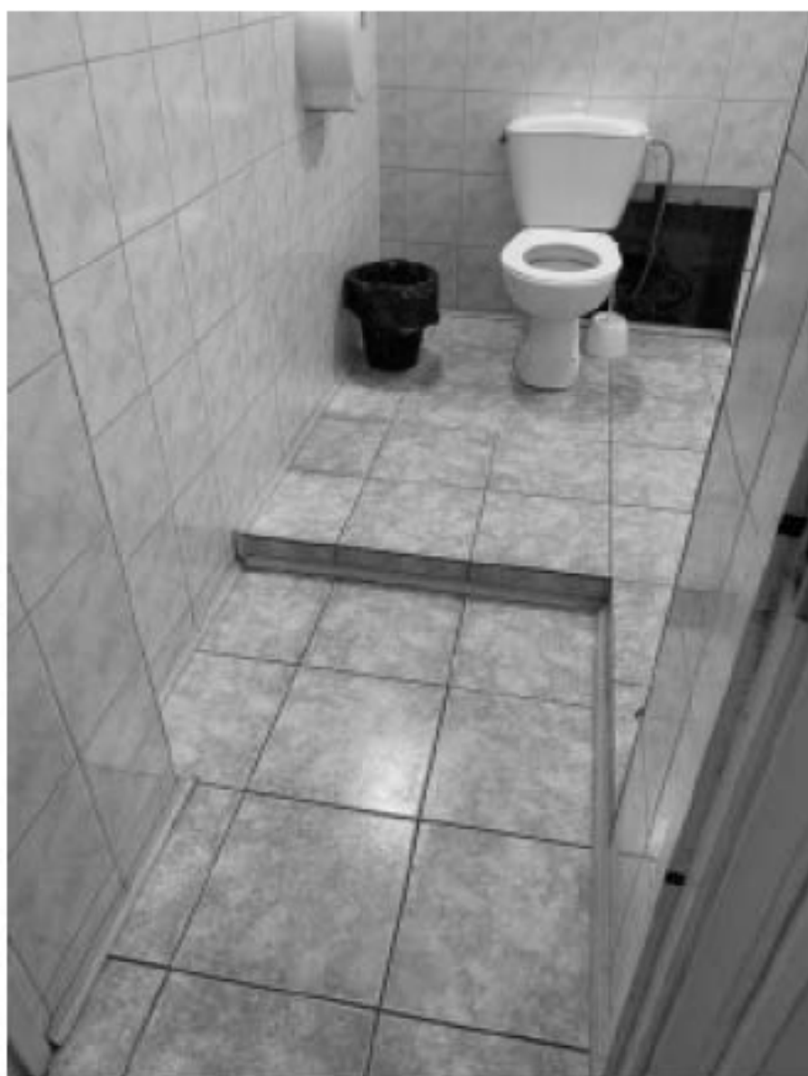
11. Помещение № 598 объекта культурного наследия федерального значения «Академия художеств. Главное здание», расположенного по адресу: г. Санкт-Петербург, Университетская набережная, д. 17, литера Ц. 23.05.2024
