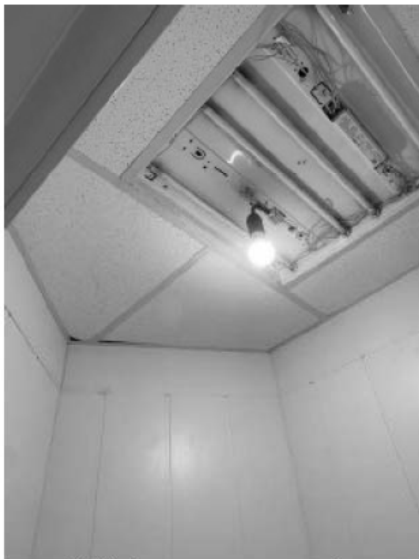
6. Помещение № 319 объекта культурного наследия федерального значения «Академия художеств. Главное здание», расположенного по адресу: г. Санкт-Петербург, Университетская набережная, д. 17, литера Ц. 23.05.2024
