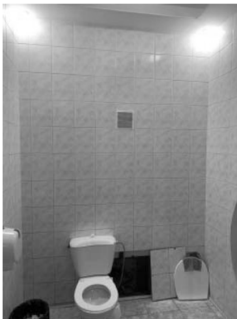
12. Помещение № 598 объекта культурного наследия федерального значения «Академия художеств. Главное здание», расположенного по адресу: г. Санкт-Петербург, Университетская набережная, д. 17, литера Ц. 23.05.2024
