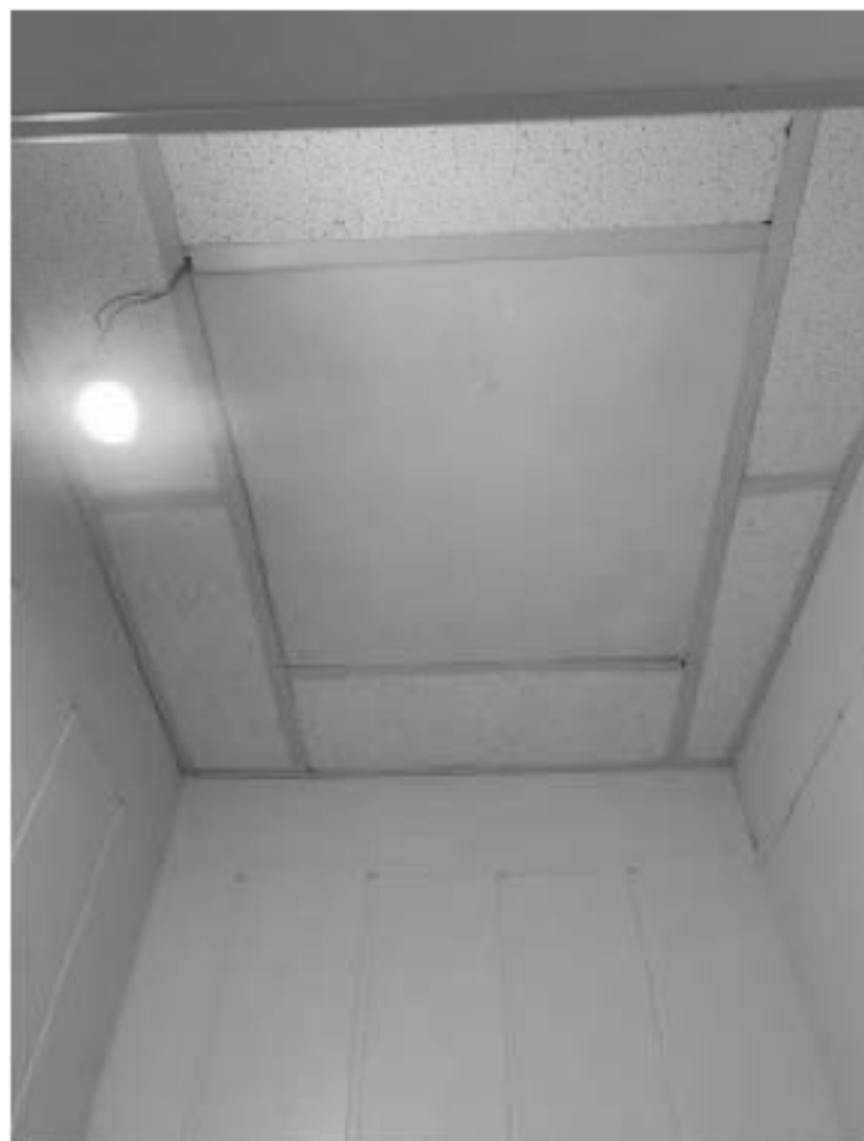
8. Помещение № 321 объекта культурного наследия федерального значения «Академия художеств. Главное здание», расположенного по адресу: г. Санкт-Петербург, Университетская набережная, д. 17, литера Ц. 23.05.2024
