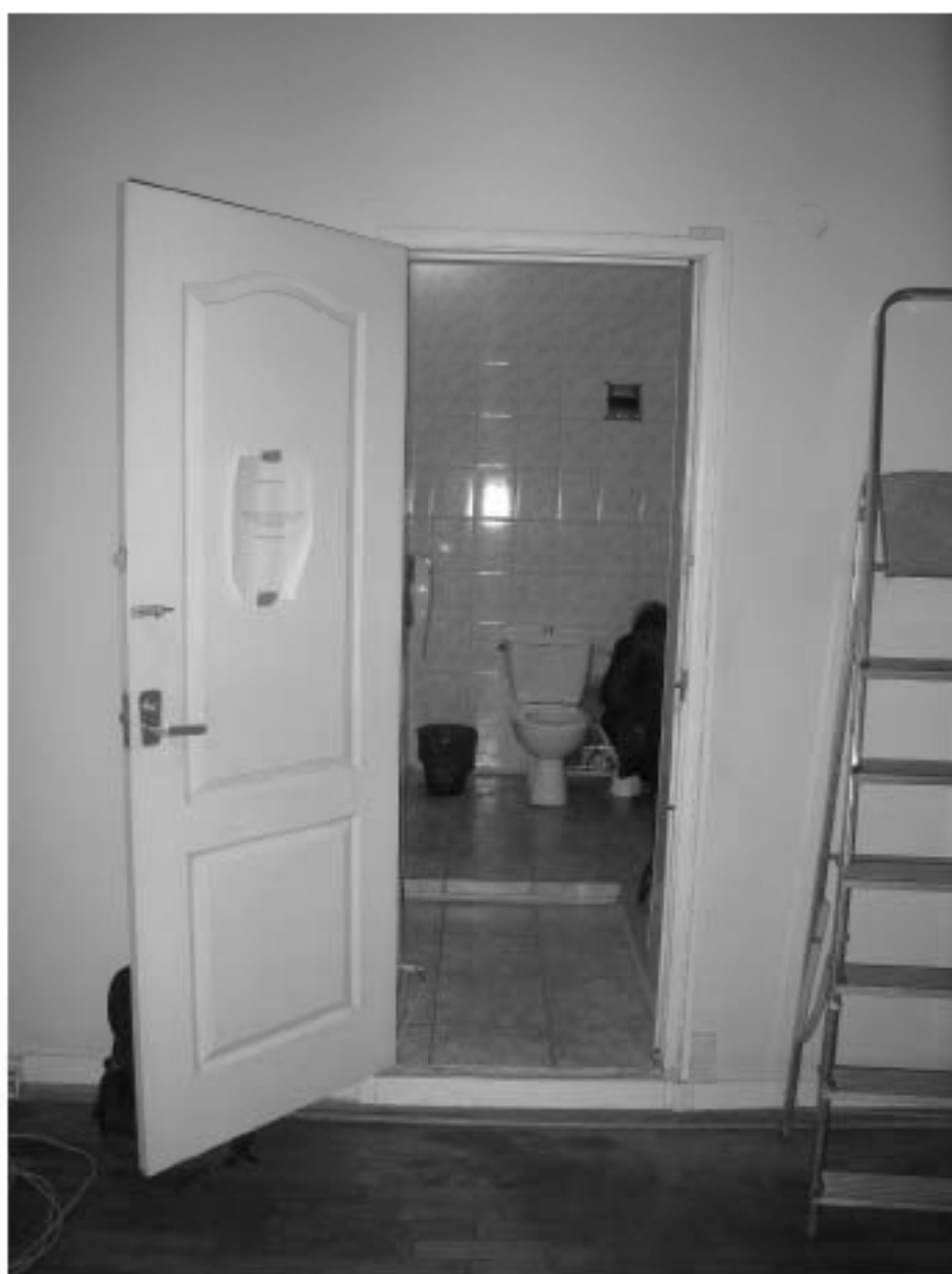
10. Входной проем в помещение № 598 объекта культурного наследия федерального значения «Академия художеств. Главное здание», расположенного по адресу: г. Санкт-Петербург, Университетская набережная, д. 17, литера Ц. 23.05.2024
