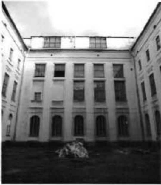
9. Фасады юго-западного двора
