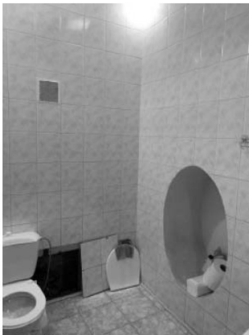
13. Помещение № 598 объекта культурного наследия федерального значения «Академия художеств. Главное здание», расположенного по адресу: г. Санкт-Петербург, Университетская набережная, д. 17, литера Ц. 23.05.2024
