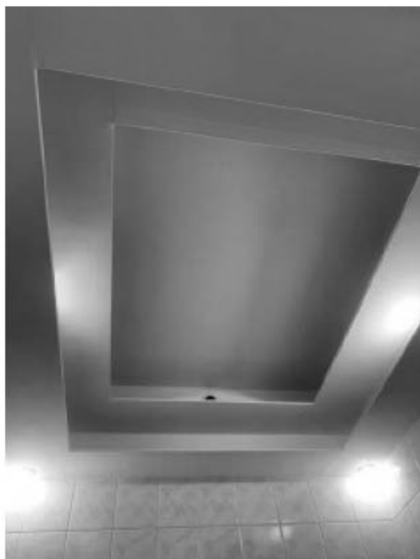
14. Помещение № 598 объекта культурного наследия федерального значения «Академия художеств. Главное здание», расположенного по адресу: г. Санкт-Петербург, Университетская набережная, д. 17, литера Ц. 23.05.2024
