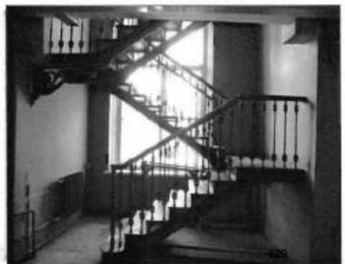
20. Межэтажная лестница с 1 на 2 эт.
