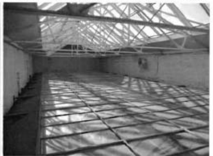
28. Конструкция светового фонаря в чердачном помещении
