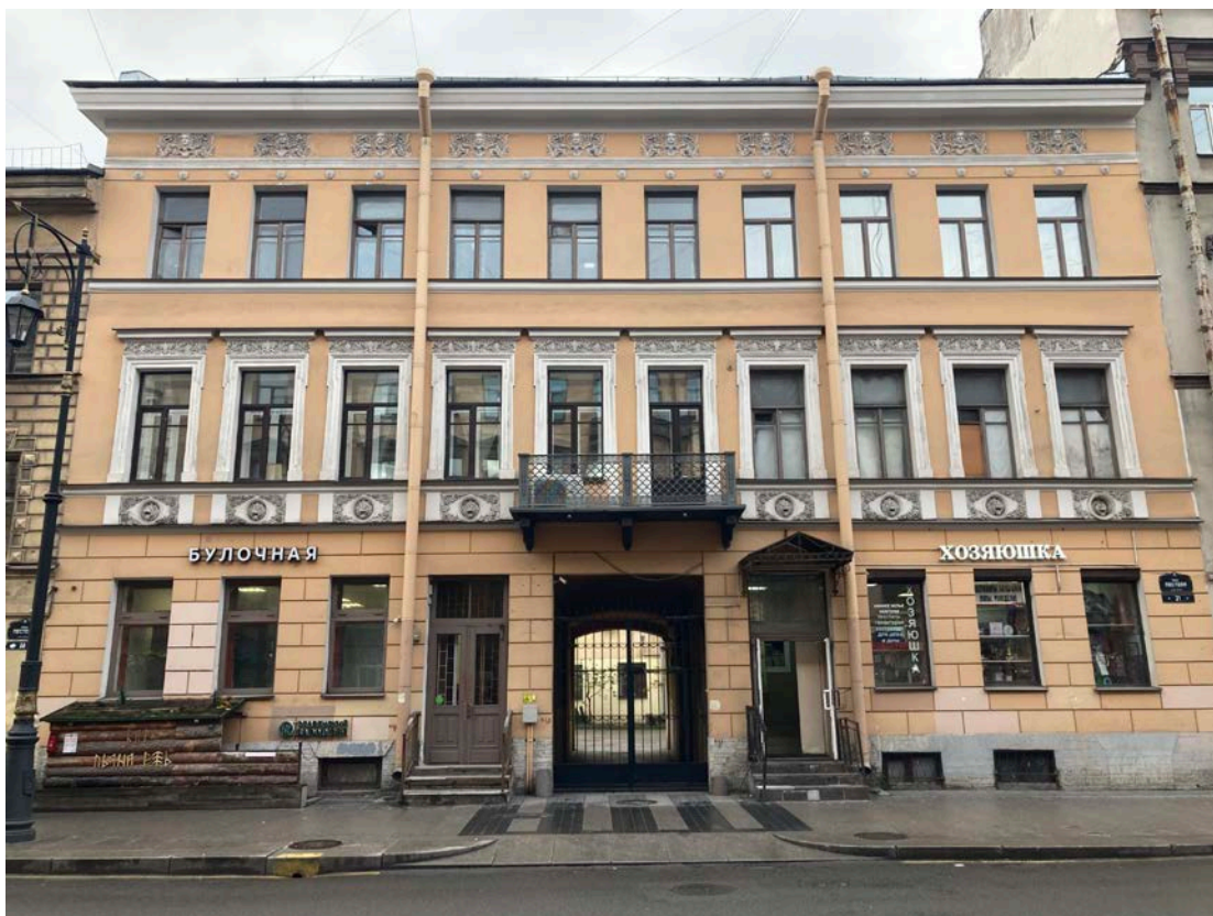
Фото 1. Лицевой фасад выявленного объекта культурного наследия «Дом Л. Брунса»
