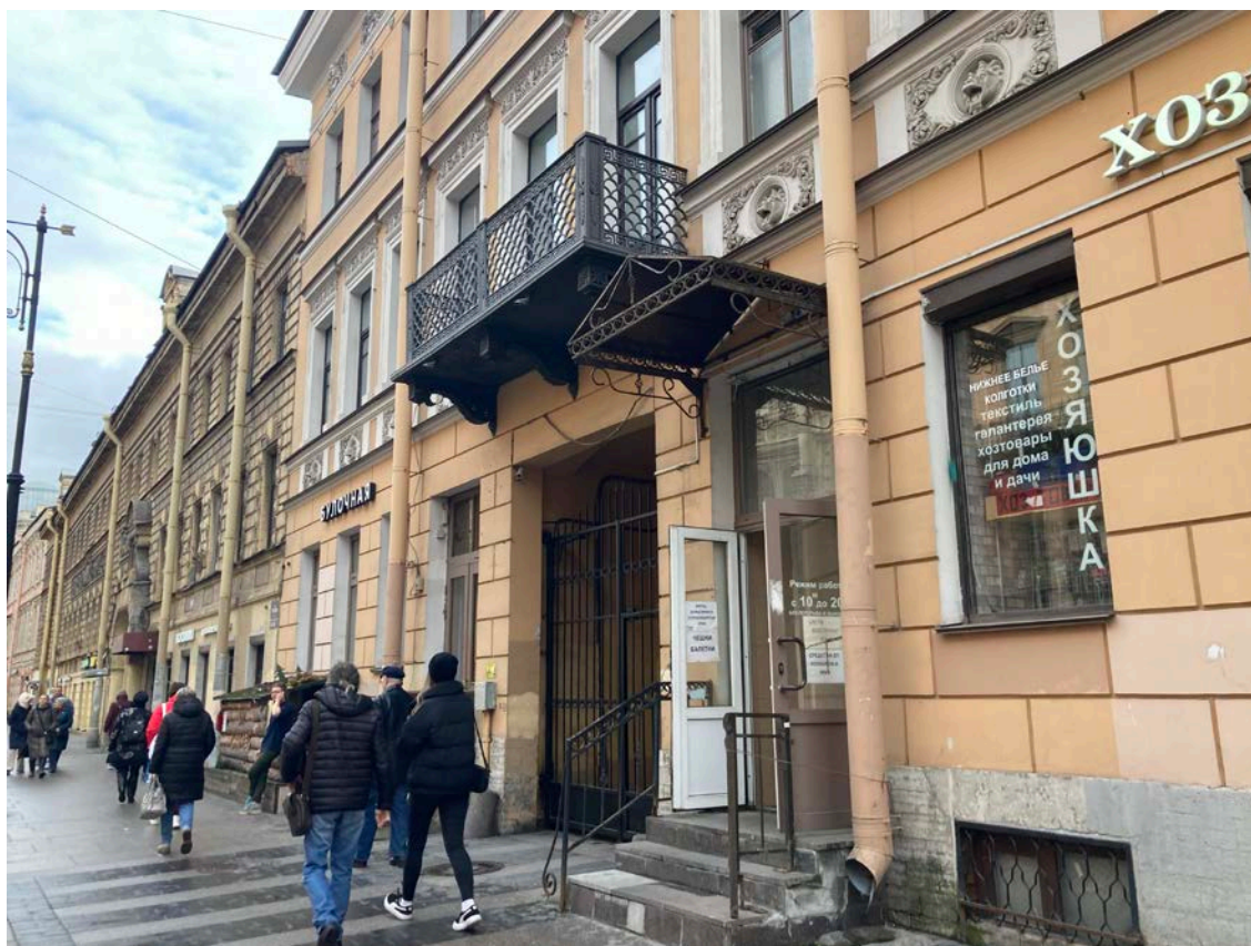
Фото 2. Фрагмент лицевого фасада выявленного объекта культурного наследия «Дом Л. Брунса»
