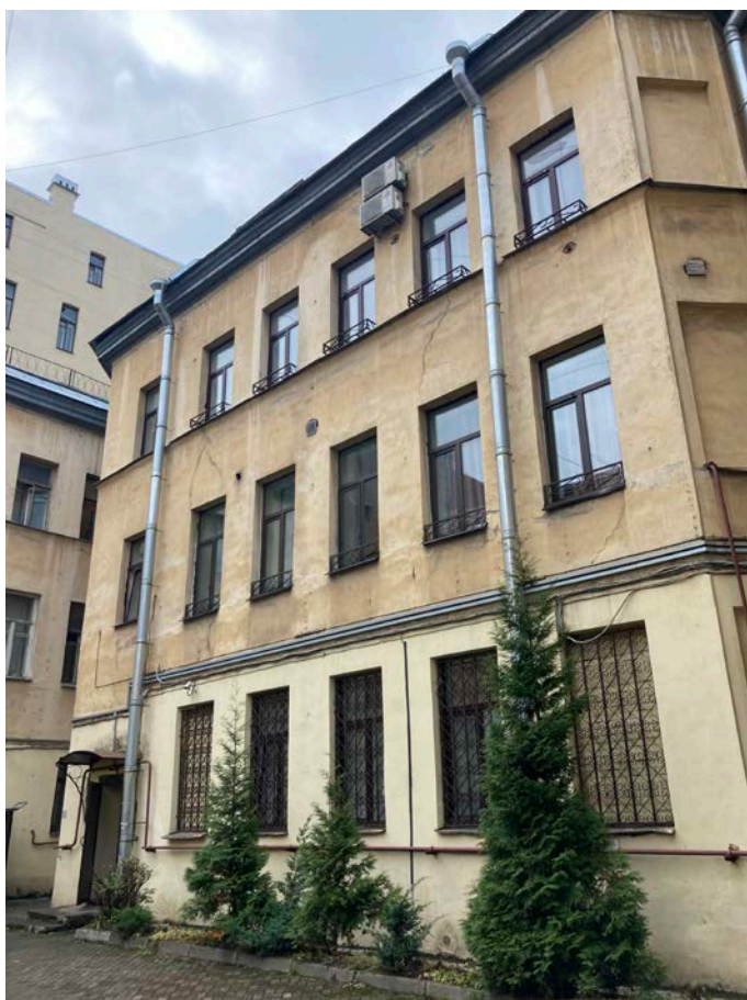
Фото 5. Фрагмент дворового фасада выявленного объекта культурного наследия «Дом Л. Брунса»
