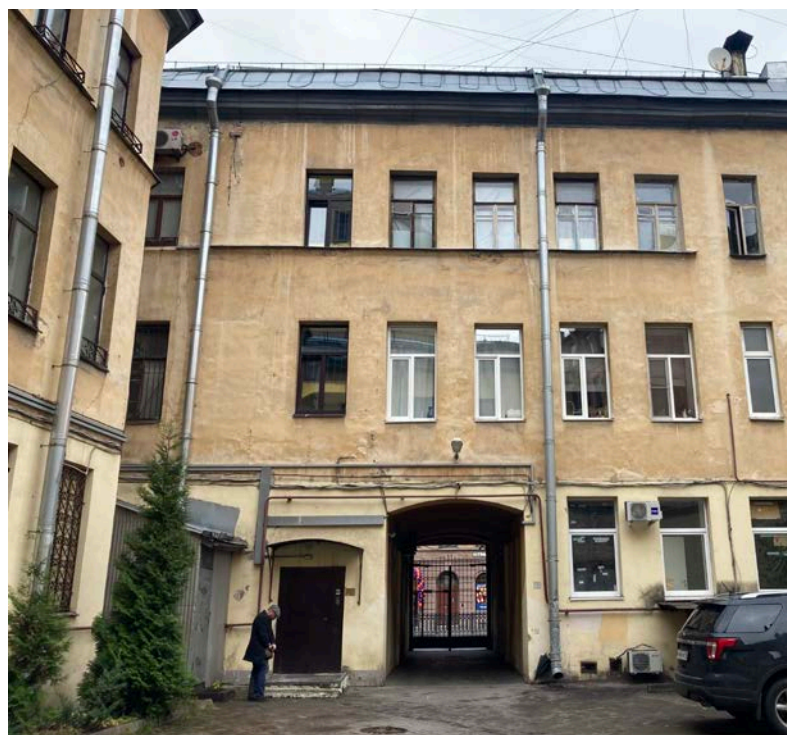
Фото 4. Фрагмент дворового фасада выявленного объекта культурного наследия «Дом Л. Брунса»
