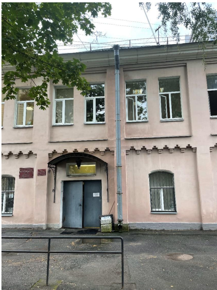
Фото 3. Фрагмент северного (дворового фасада) здания.
