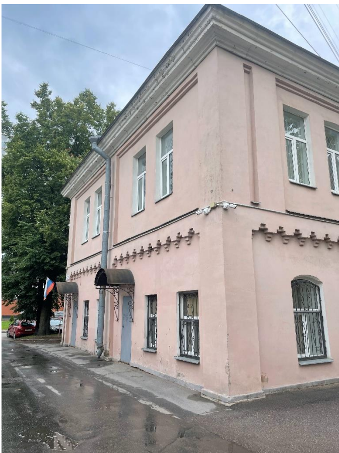
Фото 7. Торцевой фасад здания (восточный).
