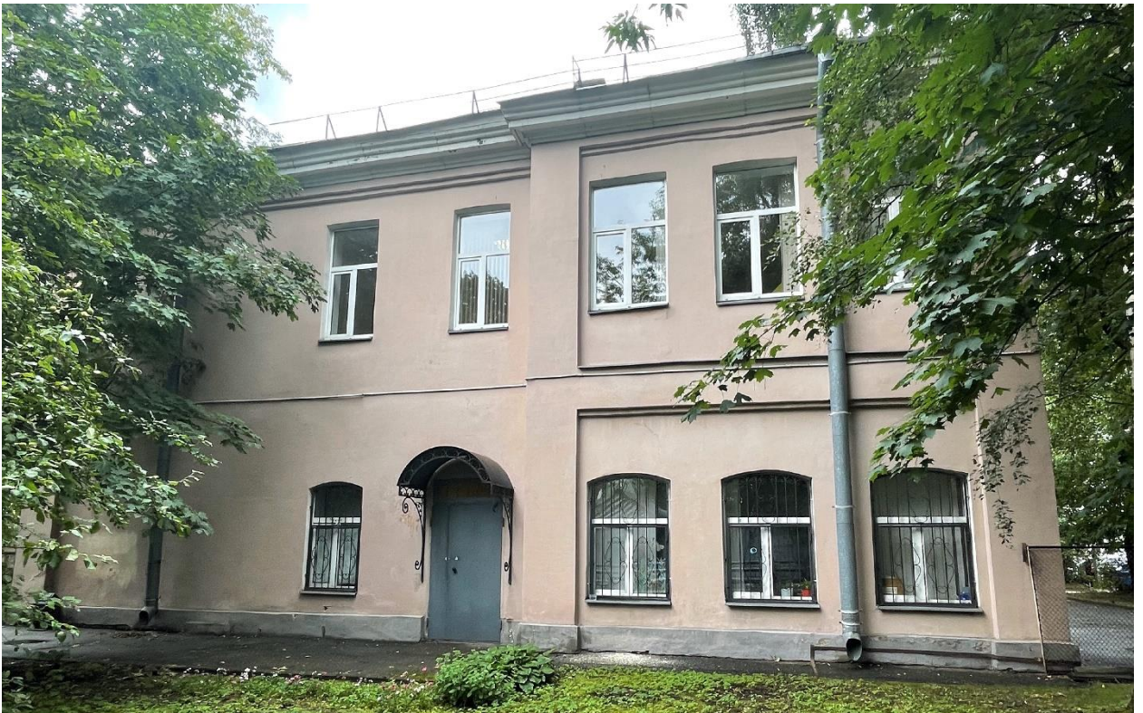
Фото 6. Торцевой фасад (западный).
