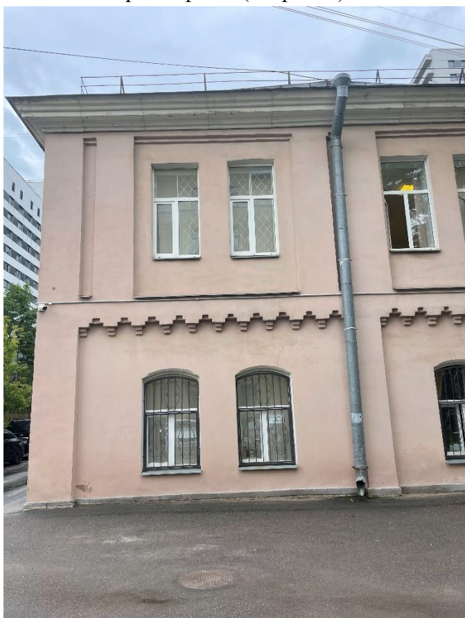
Фото 2. Фрагмент северного (дворового фасада) здания.
