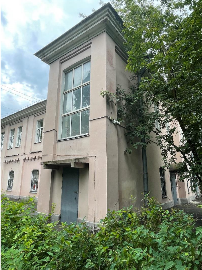
Фото 5. Фрагмент северного (дворового фасада) здания.
