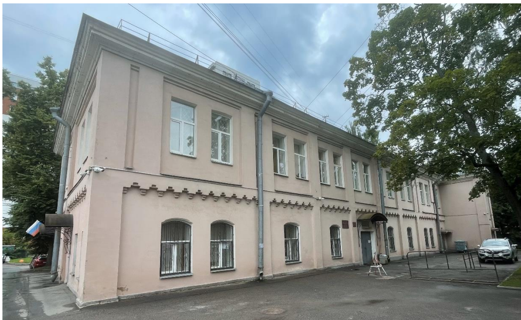
Фото 1. Северный фасад (дворовой) здания.
