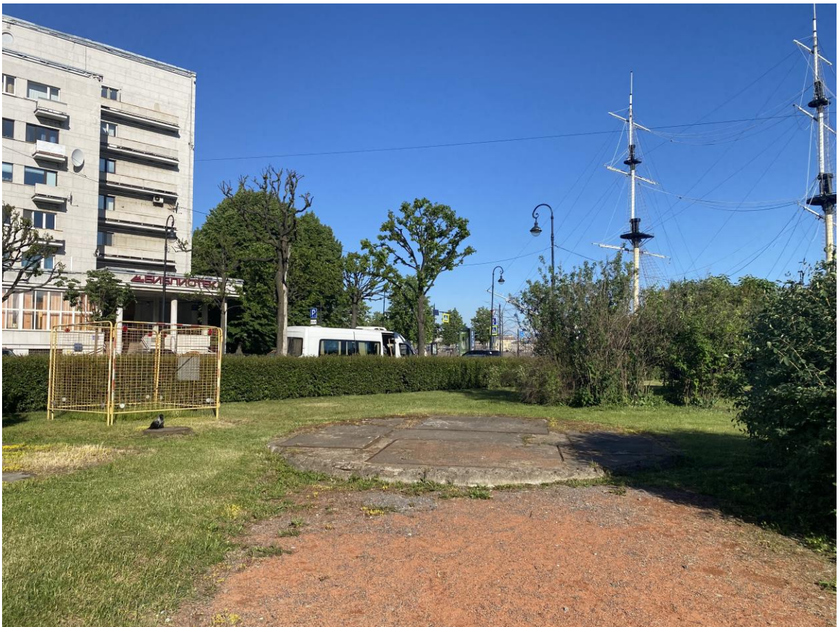
Фот. 3 Вид на участок производства работ в границах территории объекта культурного наследия «Сквер на пл. Революции» и верхнюю крышку шахты № 474а, подлежащей капитальному ремонту
