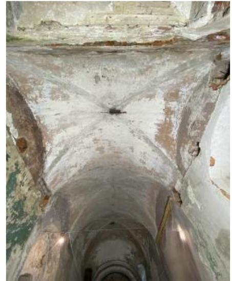
исторические (на период 1912-1918 гг.) бетонные перекрытия по металлическим балкам;
