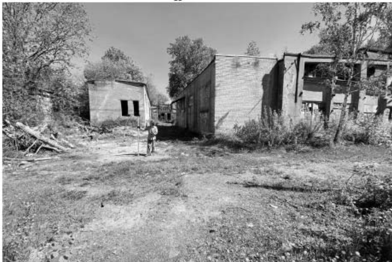
Рис. 15. СПБ-2024. Василеостровский р-н. Средний пр. 77. Общий вид обследуемой территории. ТФ 2. Вид с юго-запада
