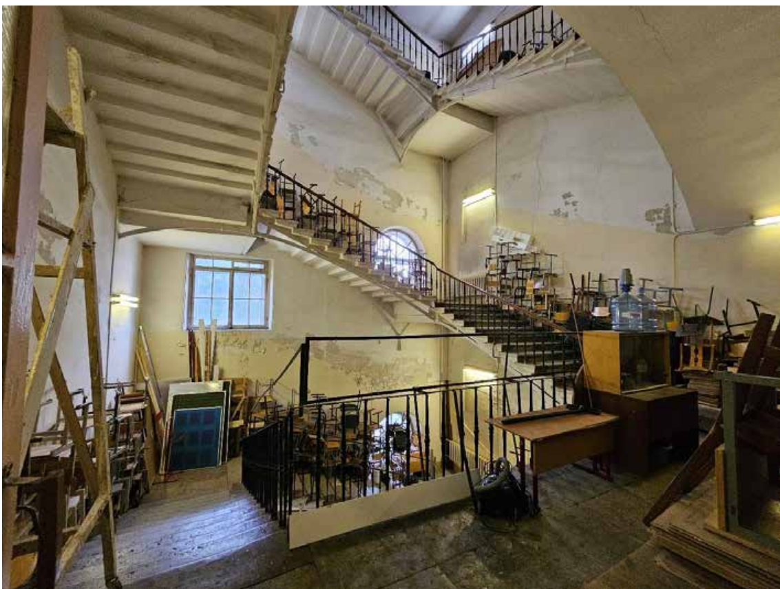
144. Объект культурного наследия регионального значения «Павловский институт с территорией, садом и оградой», по адресу: г. Санкт-Петербург, ул. Восстания, д. 8, лит. А. Общий вид четырехмаршевой лестницы в пом. 2ЛК (3) в уровне 2-го этажа.
