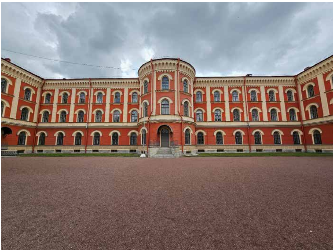
11. Объект культурного наследия регионального значения «Павловский институт с территорией, садом и оградой», по адресу: г. Санкт-Петербург, ул. Восстания, д. 8, лит. А. Общий вид центральной части западного лицевого фасада.
