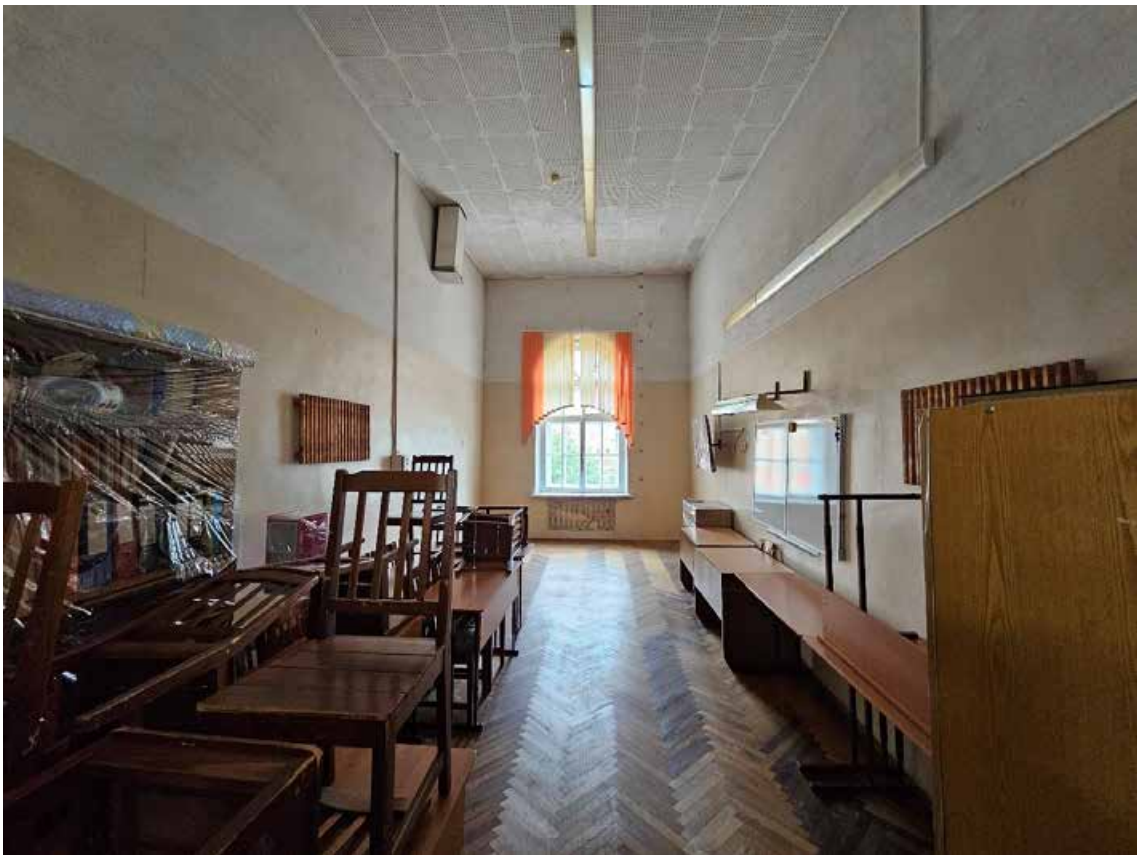
194. Объект культурного наследия регионального значения «Павловский институт с территорией, садом и оградой», по адресу: г. Санкт-Петербург, ул. Восстания, д. 8, лит. А. Общий вид пом. 11-Н (16) в уровне 3-го этажа.
