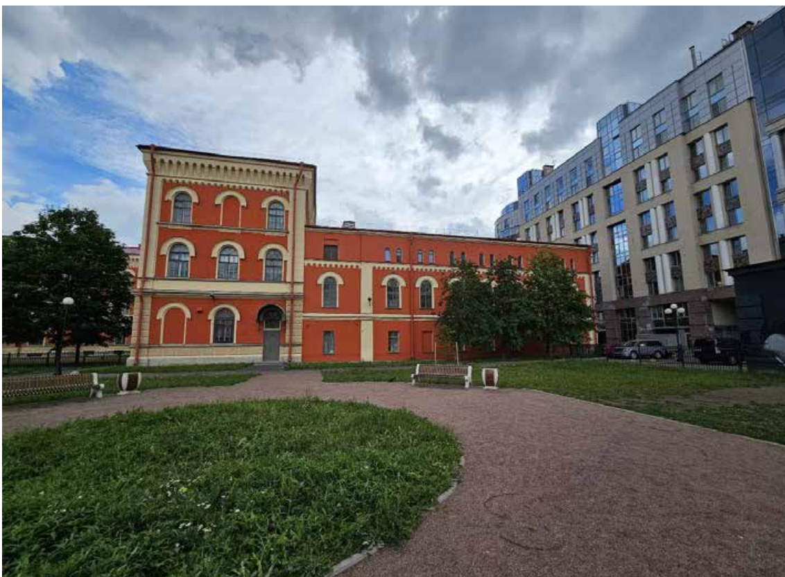
13. Объект культурного наследия регионального значения «Павловский институт с территорией, садом и оградой», по адресу: г. Санкт-Петербург, ул. Восстания, д. 8, лит. А. Общий вид западного торцевого фасада южного корпуса и западного лицевого фасада юго-западного флигеля.
