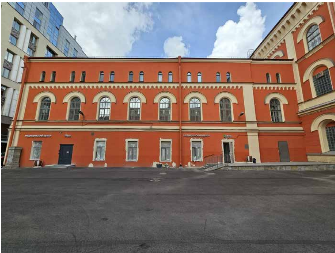
15. Объект культурного наследия регионального значения «Павловский институт с территорией, садом и оградой», по адресу: г. Санкт-Петербург, ул. Восстания, д. 8, лит. А. Общий вид восточного дворового фасада юго-западного флигеля.
