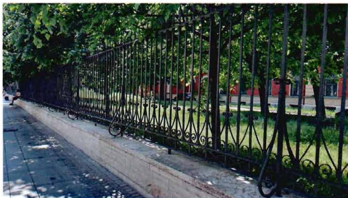
15. Ограда. Общий вид
