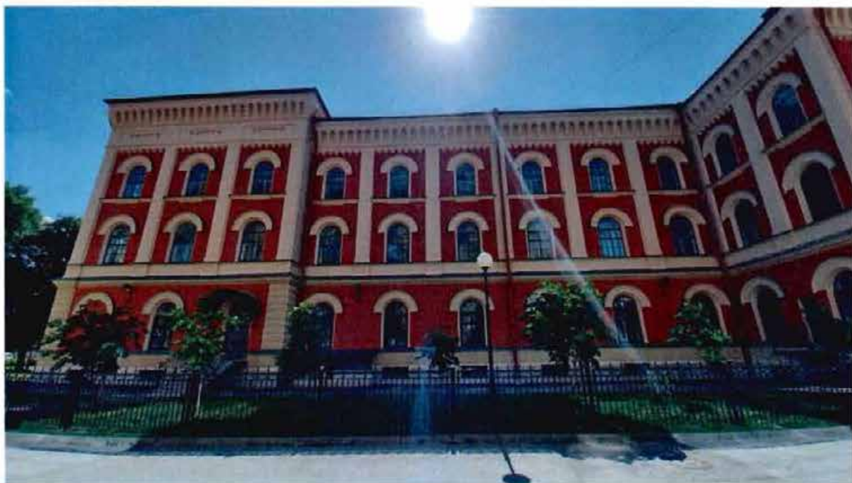
4. Здание института. Фрагмент северного фасада
