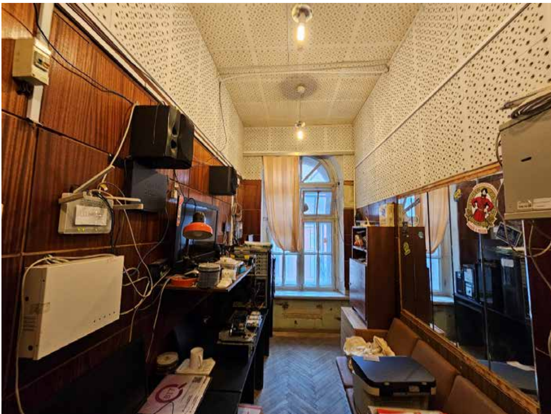
80. Объект культурного наследия регионального значения «Павловский институт с территорией, садом и оградой», по адресу: г. Санкт-Петербург, ул. Восстания, д. 8, лит. А. Общий вид пом. 5-Н (4) в уровне 1-го этажа.
