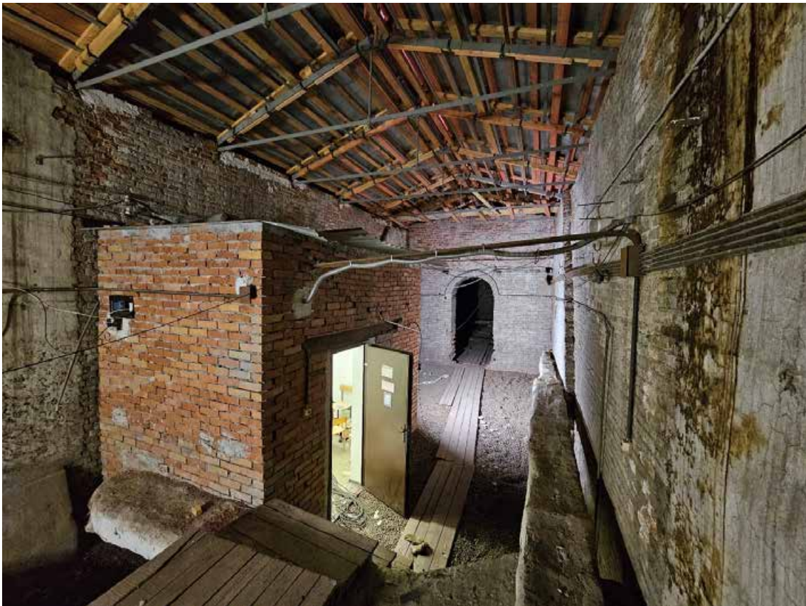
211. Объект культурного наследия регионального значения «Павловский институт с территорией, садом и оградой», по адресу: г. Санкт-Петербург, ул. Восстания, д. 8, лит. А. Фрагмент пространства чердака лицевого корпуса.
