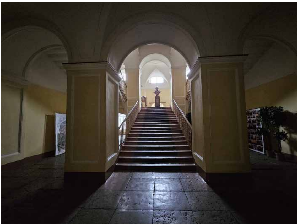
33. Объект культурного наследия регионального значения «Павловский институт с территорией, садом и оградой», по адресу: г. Санкт-Петербург, ул. Восстания, д. 8, лит. А. Общий вид парадной лестницы в уровне 1-го этажа.
