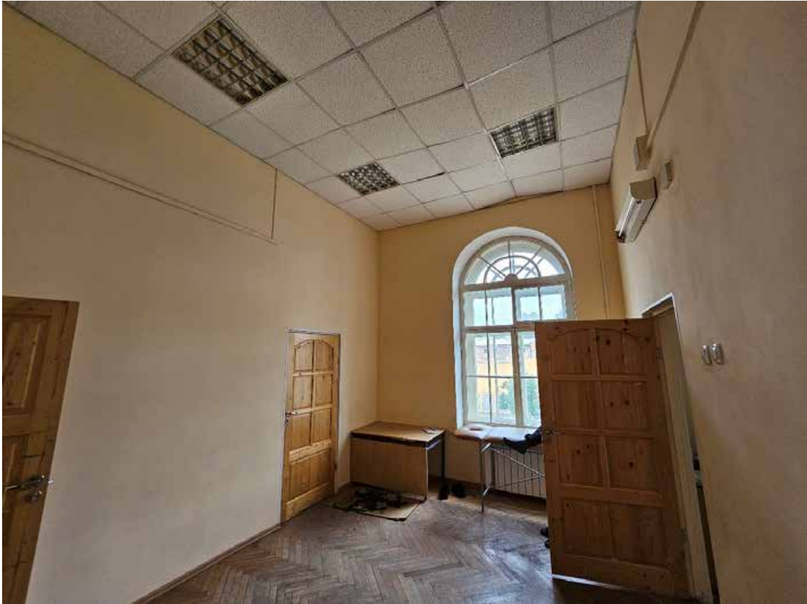
185. Объект культурного наследия регионального значения «Павловский институт с территорией, садом и оградой», по адресу: г. Санкт-Петербург, ул. Восстания, д. 8, лит. А. Общий вид пом. 14-Н (27) в уровне 3-го этажа.
