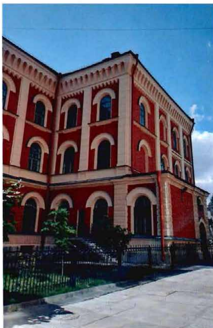
5. Здание института. Фрагмент северного фасада
