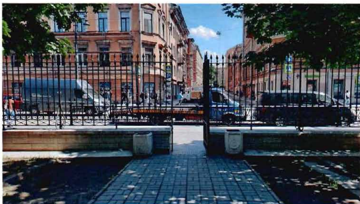
17. Ограда. Вид со стороны здания института.
