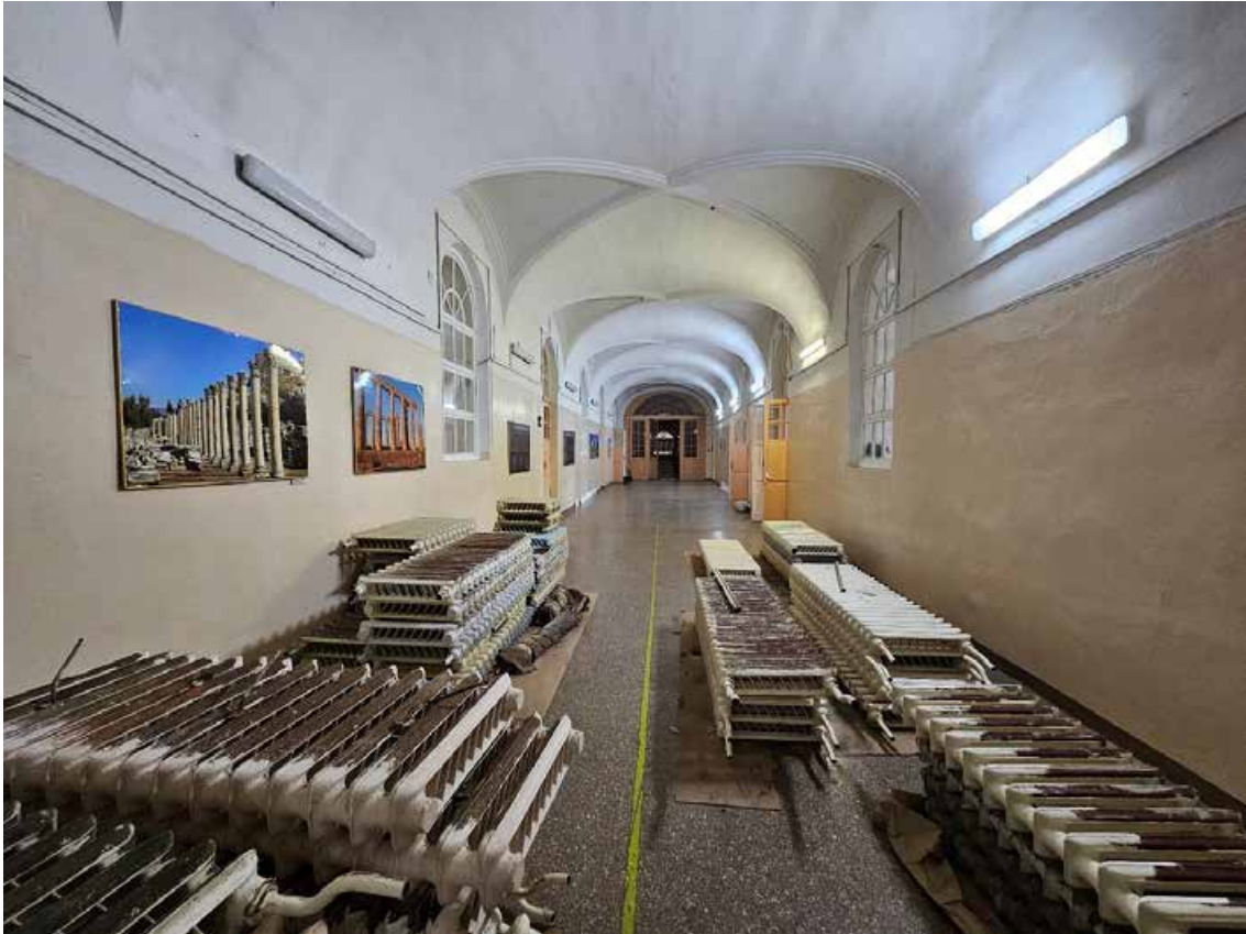
116. Объект культурного наследия регионального значения «Павловский институт с территорией, садом и оградой», по адресу: г. Санкт-Петербург, ул. Восстания, д. 8, лит. А. Общий вид пом. 7-Н (35) в уровне 2-го этажа.
