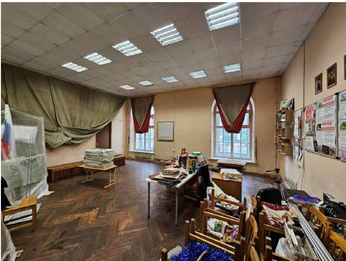
47. Объект культурного наследия регионального значения «Павловский институт с территорией, садом и оградой», по адресу: г. Санкт-Петербург, ул. Восстания, д. 8, лит. А. Общий вид пом. 12-Н (41) в уровне 1-го этажа.
