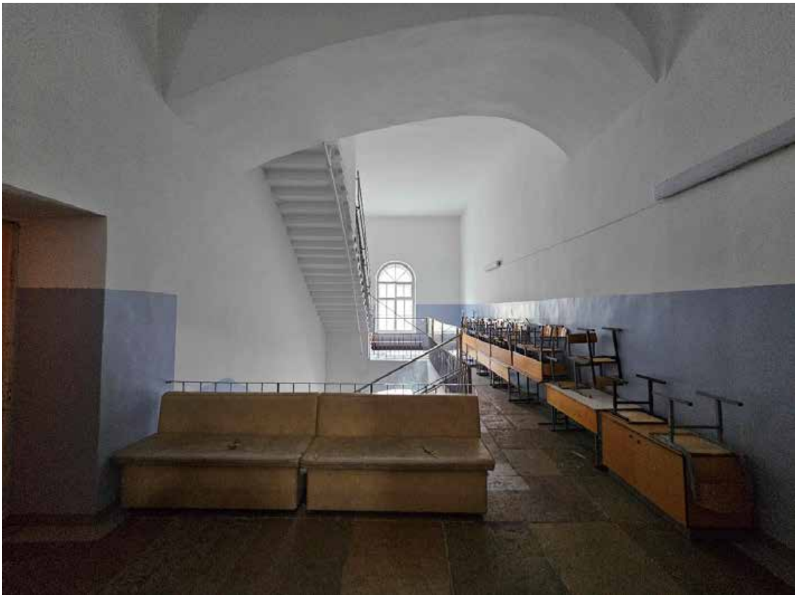
171. Объект культурного наследия регионального значения «Павловский институт с территорией, садом и оградой», по адресу: г. Санкт-Петербург, ул. Восстания, д. 8, лит. А. Общий вид трехмаршевой лестницы в пом. 6ЛК (4) в уровне 3-го этажа.
