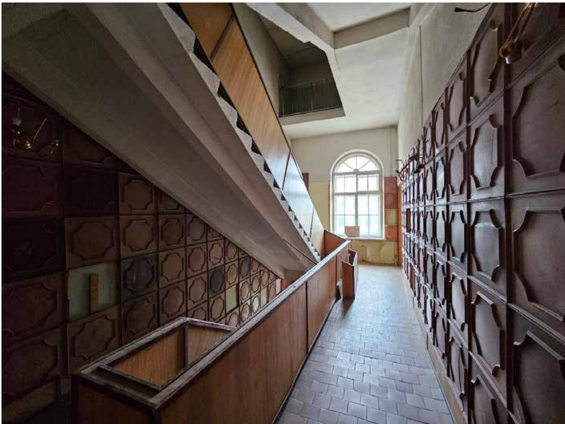
208. Объект культурного наследия регионального значения «Павловский институт с территорией, садом и оградой», по адресу: г. Санкт-Петербург, ул. Восстания, д. 8, лит. А. Общий вид двухмаршевой лестницы в пом. 4ЛК (4) в уровне 3-го этажа.
