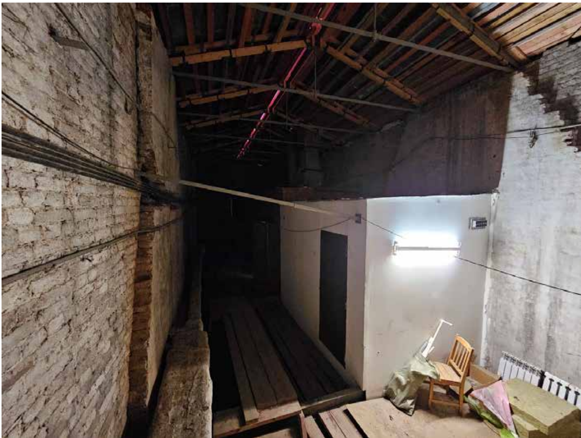
212. Объект культурного наследия регионального значения «Павловский институт с территорией, садом и оградой», по адресу: г. Санкт-Петербург, ул. Восстания, д. 8, лит. А. Фрагмент пространства чердака лицевого корпуса.
