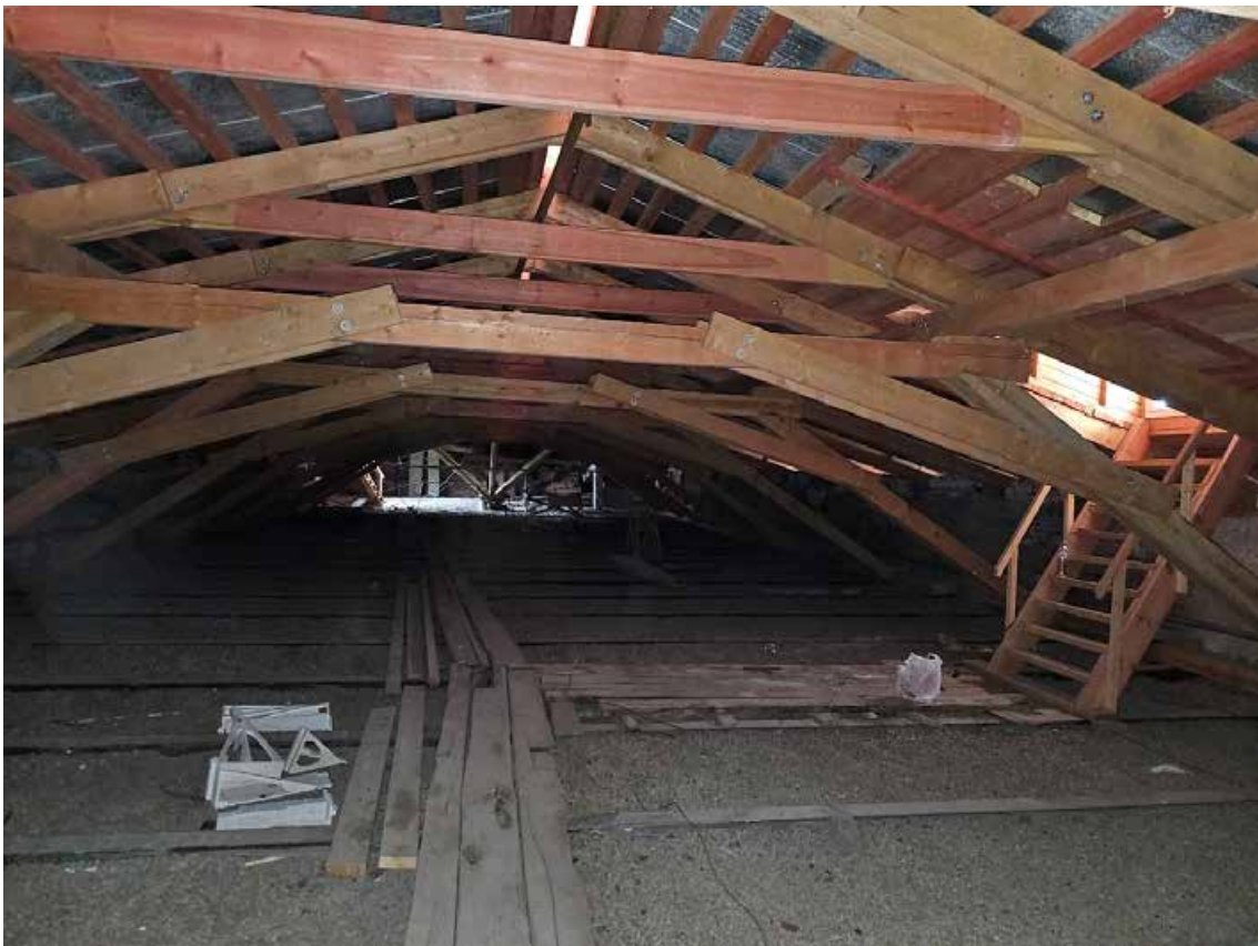
209. Объект культурного наследия регионального значения «Павловский институт с территорией, садом и оградой», по адресу: г. Санкт-Петербург, ул. Восстания, д. 8, лит. А. Фрагмент конструкции крыши южного корпуса.
