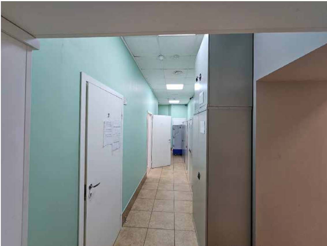
98. Объект культурного наследия регионального значения «Павловский институт с территорией, садом и оградой», по адресу: г. Санкт-Петербург, ул. Восстания, д. 8, лит. А. Общий вид пом. 1-Н (5) в уровне 1-го этажа.
