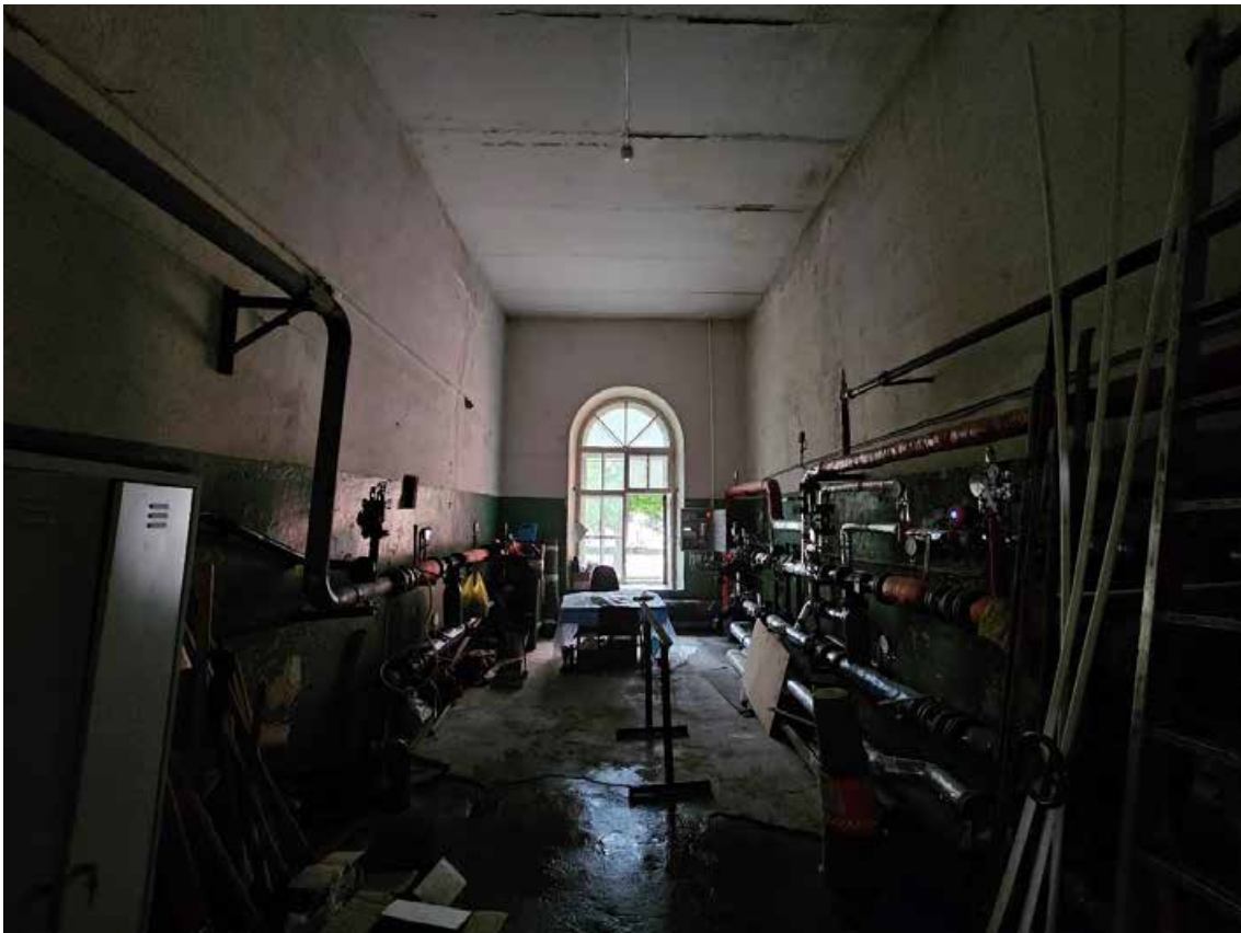
36. Объект культурного наследия регионального значения «Павловский институт с территорией, садом и оградой», по адресу: г. Санкт-Петербург, ул. Восстания, д. 8, лит. А. Общий вид пом. 5-Н (79) в уровне 1-го этажа.
