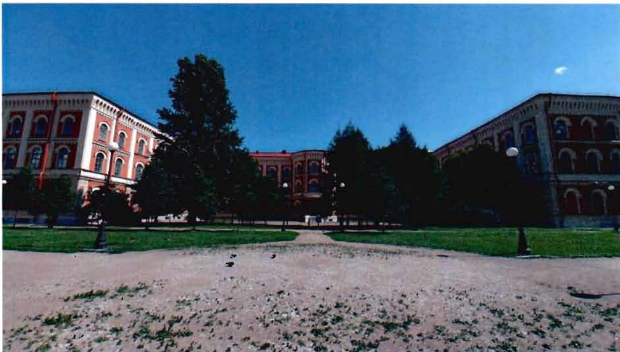
2. Здание института. Западный фасад
