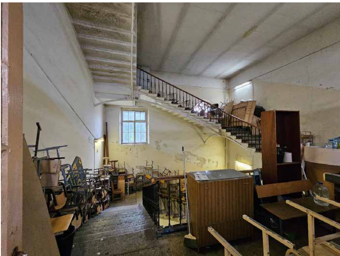
197. Объект культурного наследия регионального значения «Павловский институт с территорией, садом и оградой», по адресу: г. Санкт-Петербург, ул. Восстания, д. 8, лит. А. Общий вид четырехмаршевой лестницы в пом. 2ЛК (4) в уровне 3-го этажа.
