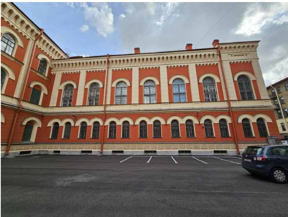
17. Объект культурного наследия регионального значения «Павловский институт с территорией, садом и оградой», по адресу: г. Санкт-Петербург, ул. Восстания, д. 8, лит. А. Общий вид западного дворового фасада юго-восточного флигеля.
