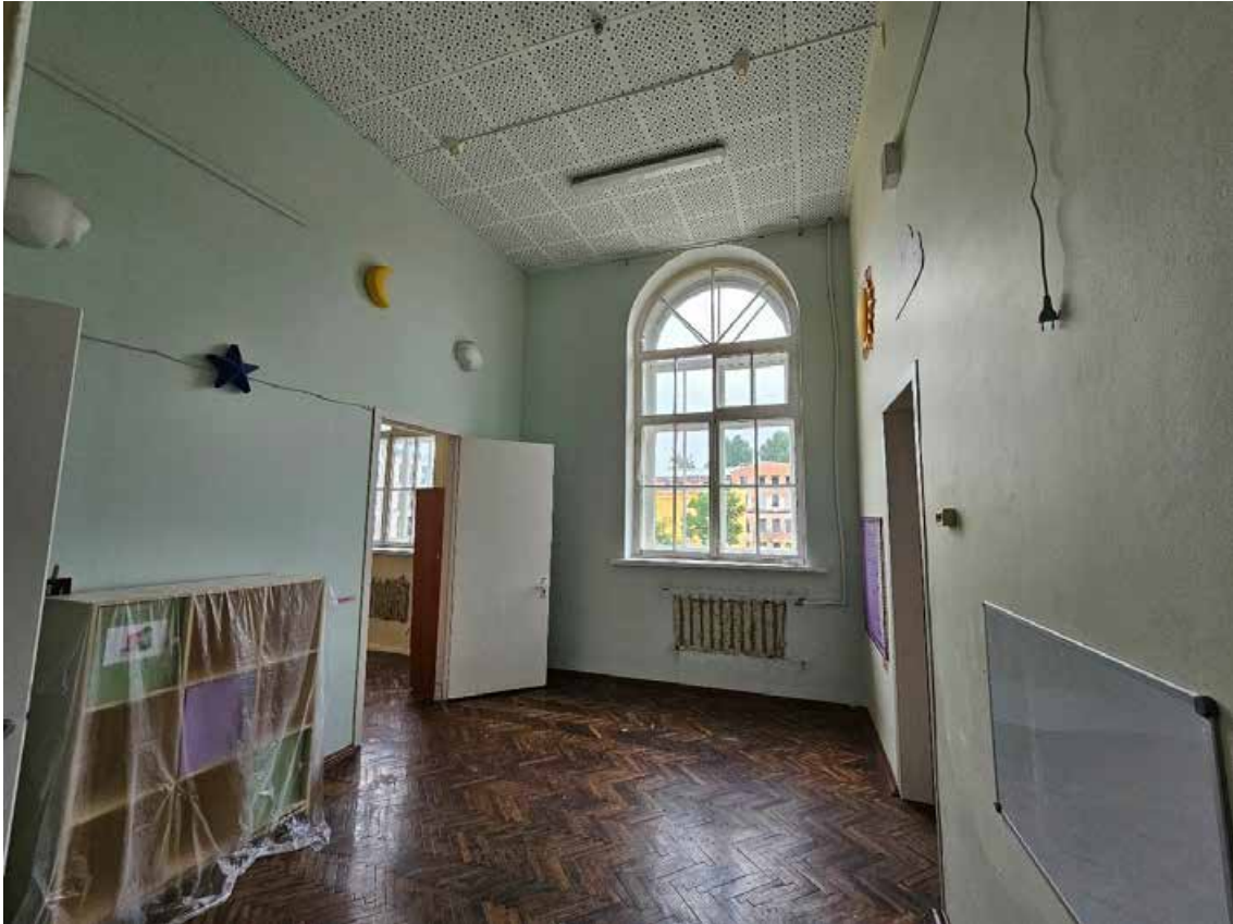
134. Объект культурного наследия регионального значения «Павловский институт с территорией, садом и оградой», по адресу: г. Санкт-Петербург, ул. Восстания, д. 8, лит. А. Общий вид пом. 13-Н (27) в уровне 2-го этажа.
