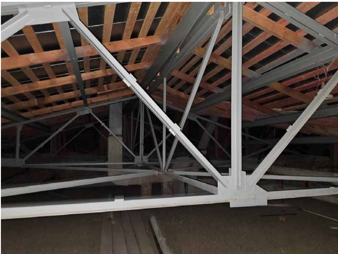
218. Объект культурного наследия регионального значения «Павловский институт с территорией, садом и оградой», по адресу: г. Санкт-Петербург, ул. Восстания, д. 8, лит. А. Фрагмент конструкции крыши северного корпуса.
