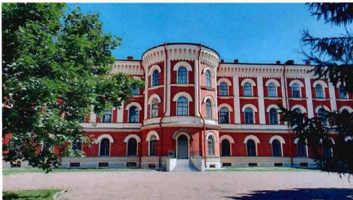
1. Здание института. Полуциркульный ризалит западного фасада
