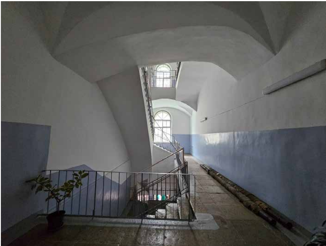
117. Объект культурного наследия регионального значения «Павловский институт с территорией, садом и оградой», по адресу: г. Санкт-Петербург, ул. Восстания, д. 8, лит. А. Общий вид трехмаршевой лестницы в пом. 6ЛК (3) в уровне 2-го этажа.
