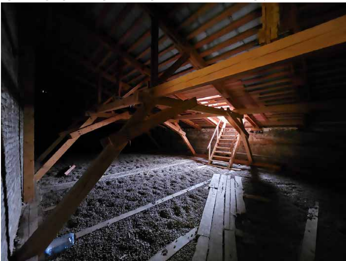
216. Объект культурного наследия регионального значения «Павловский институт с территорией, садом и оградой», по адресу: г. Санкт-Петербург, ул. Восстания, д. 8, лит. А. Фрагмент конструкции крыши в северной части лицевого корпуса.
