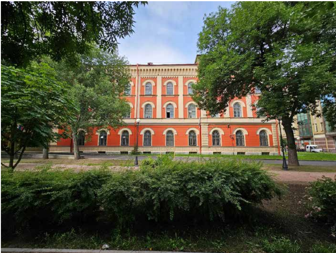
4. Объект культурного наследия регионального значения «Павловский институт с территорией, садом и оградой», по адресу: г. Санкт-Петербург, ул. Восстания, д. 8, лит. А. Фрагмент северной части восточного лицевого фасада.
