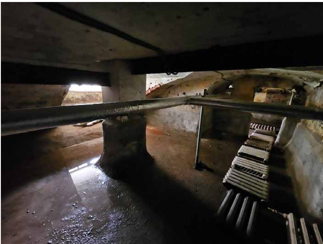
22. Объект культурного наследия регионального значения «Павловский институт с территорией, садом и оградой», по адресу: г. Санкт-Петербург, ул. Восстания, д. 8, лит. А. Общий вид пом. 4-Н (13) в уровне подвала.
