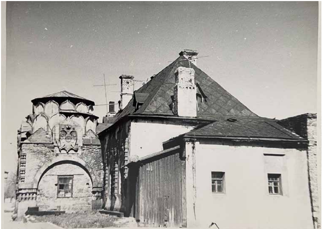
Илл. 49. Восточный фасад Царского вокзала. Фото 1970 г. Архив КГИОП. Фото из тома 1 Историко-архивные и библиографические изыскания. Проекта 1989 г. К. 2 Иллюстрации. Негатив Быкова И.А. 1970 г.
