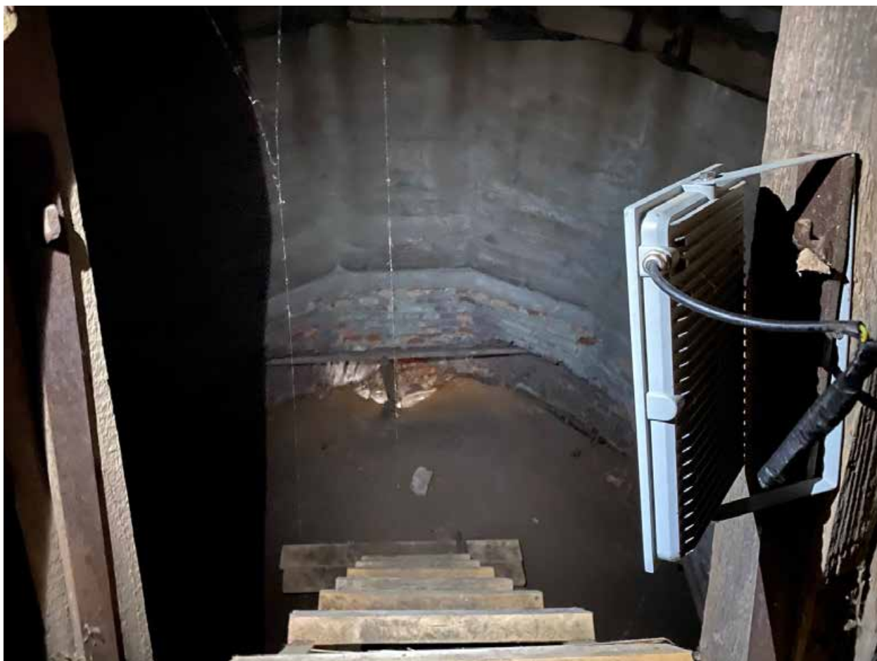
Фото 107. Сводчатое перекрытие над крыльцом парадного входа.
