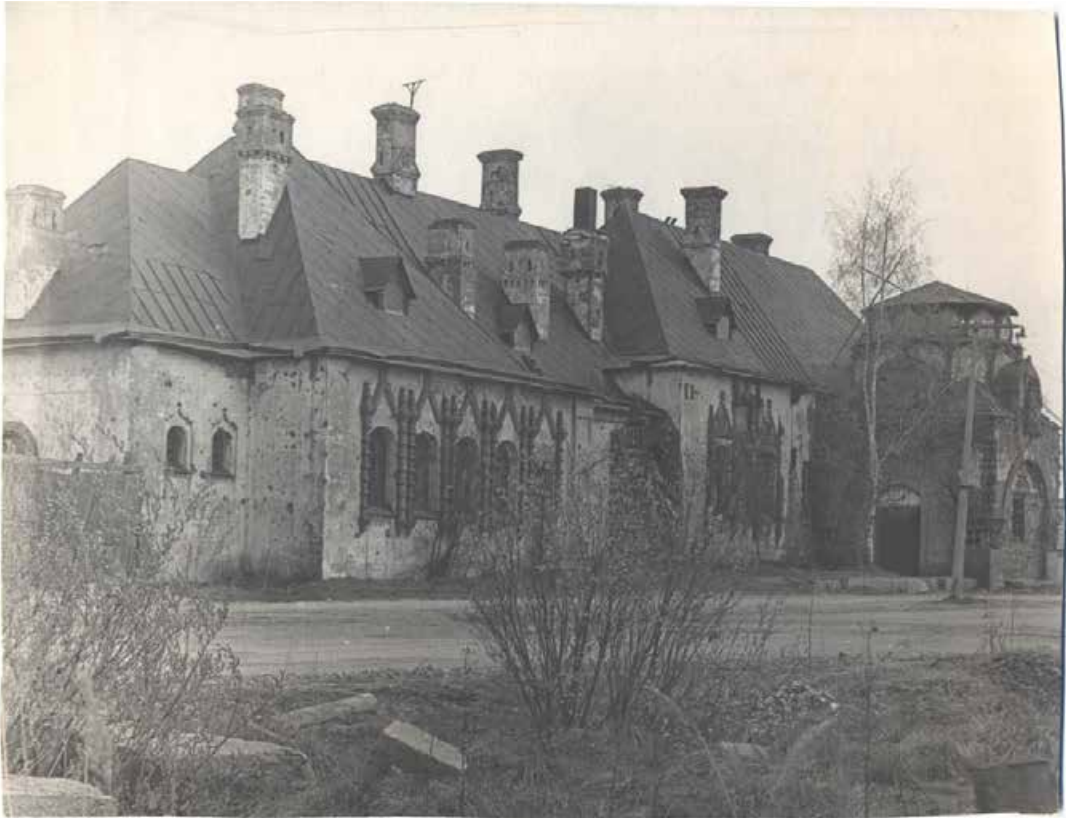
Илл. 45. Императорский вокзал. Главный фасад. Фото 1960-1970-х гг. СПб ГБУК «Историко-литературный музей города Пушкина». 6594-4. Царскосельский вокзал 60-70 гг. 20 в.
