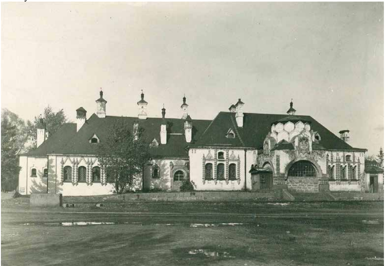
Илл. 40. Здание бывшего Царского вокзала (Императорского павильона). 1935-1940 гг. Retro View of Mankind's Habitat [Электронный ресурс] URL: https://pastvu.com/p/1617788
